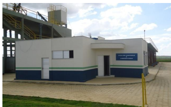
Figura 4.9 – Laboratório da ETE Fonte: COBRAPE (2014)
