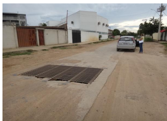
Figura 4.19 – Córrego Chico Silveira canalizado na Avenida Isabel de Castro
