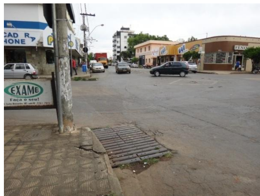
Figura 4.21 – Boca de Lobo com grelha, Rua Luís de Guadalupe – Sede
