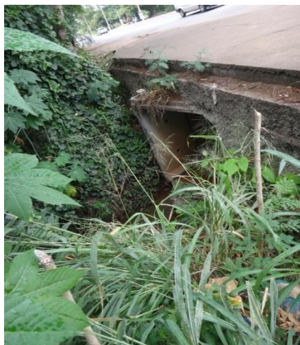
Figura 4.22 – Bueiro – Travessia Córrego Chico Messias, Av. José Bernardes Maciel – Sede
