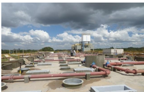
Figura 4.6 – Reatores Anaeróbios de Fluxo Ascendente Fonte: COBRAPE (2014)
