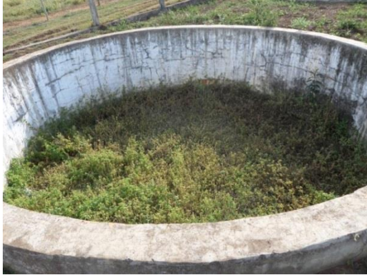
Figura 4.11 – Leito de secagem da ETE Engenho do Ribeiro III com vegetação Fonte: COBRAPE (2014)
