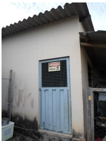
Figura 4.30 - Abrigo para armazenamento de resíduos de agrotóxicos
