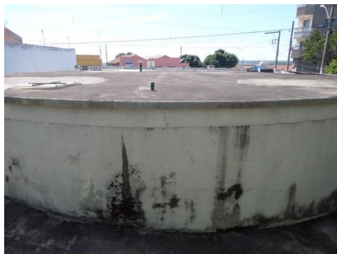
Figura 4.3 – Reservatório apoiado (RAP 2) Fonte: COBRAPE (2014)
