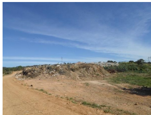
Figura 4.22 – Nível do terreno acima do nível da via – local sem cercamento nas laterais Foto: COBRAPE (2014)
