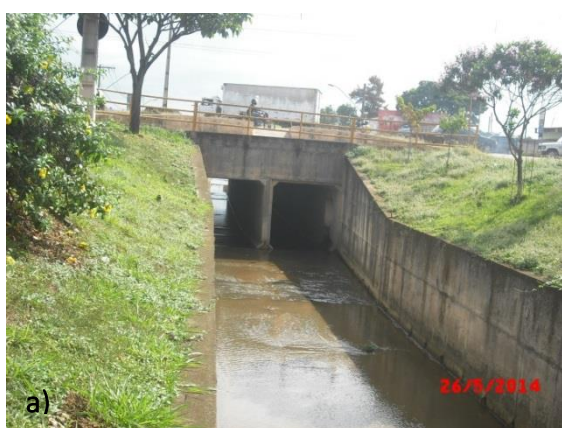
a) Travessia do córrego dos Machados sob a rua do Rosário
