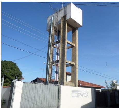
Figura 4.4 – Reservatório elevado (REL 3) Fonte: COBRAPE (2014)
