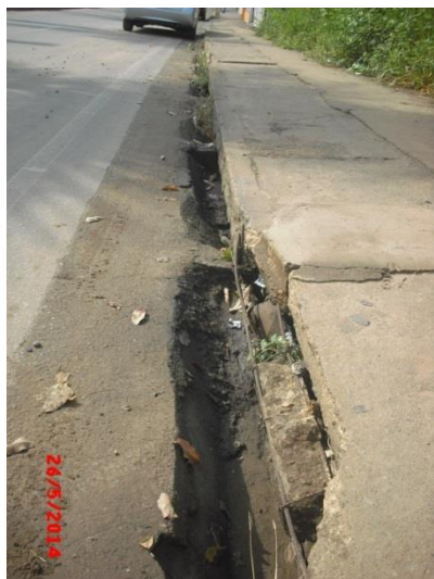
Figura 4.35 – Bocas de lobo em série, Rua do Rosário Foto: COBRAPE (2014)
