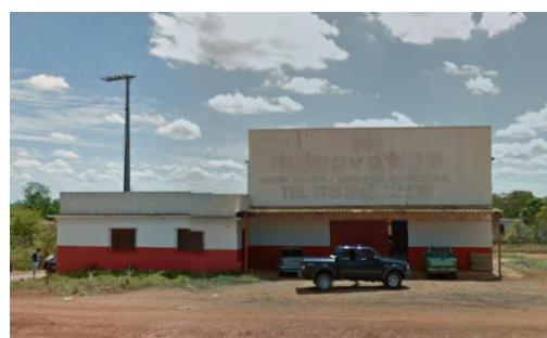
Figura 4.29 - Galpão para armazenamento de pneus
