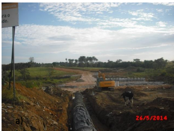
Obras de drenagem no córrego da Areia (ao fundo)
