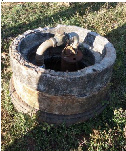
Figura 4.13 - Poço tubular de Veredas Fonte: COBRAPE (2014)
