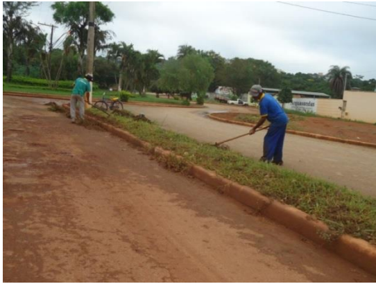
Figura 4.30 – Funcionários realizando capina Fonte: COBRAPE (2014)
