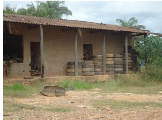
Figura 4.31 - Área de armazenamento de pneus inservíveis Fonte: COBRAPE (2014)
