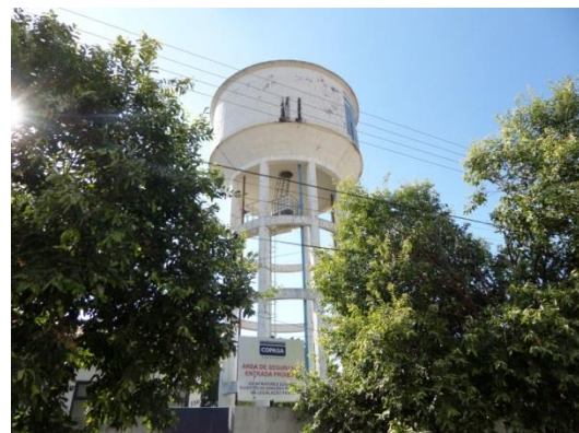
Figura 4.5 - Reservatório elevado (REL1) Fonte: COBRAPE (2014)
