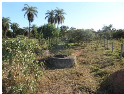
Figura 4.20 – Vista geral da ETE Veredas Fonte: COBRAPE (2014)
