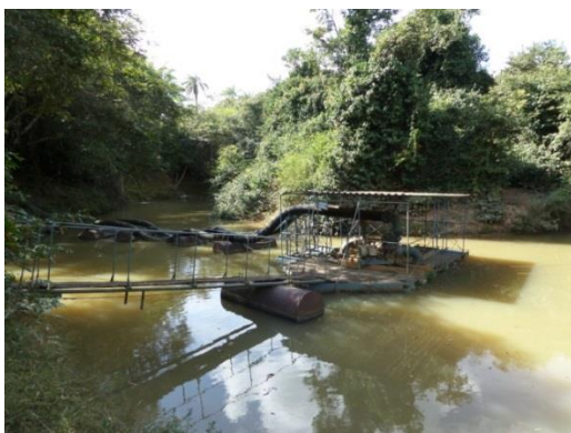
Figura 4.3 – Balsa para captação e água no rio Marmelada Fonte: COBRAPE (2014)
