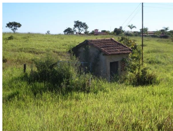
Figura 4.14 - Poço tubular do Balneário Porto Mangaba Fonte: COBRAPE (2014)
