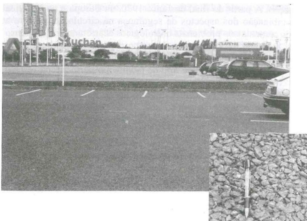
Figura 10.7 – Utilização de pavimento poroso em estacionamento
