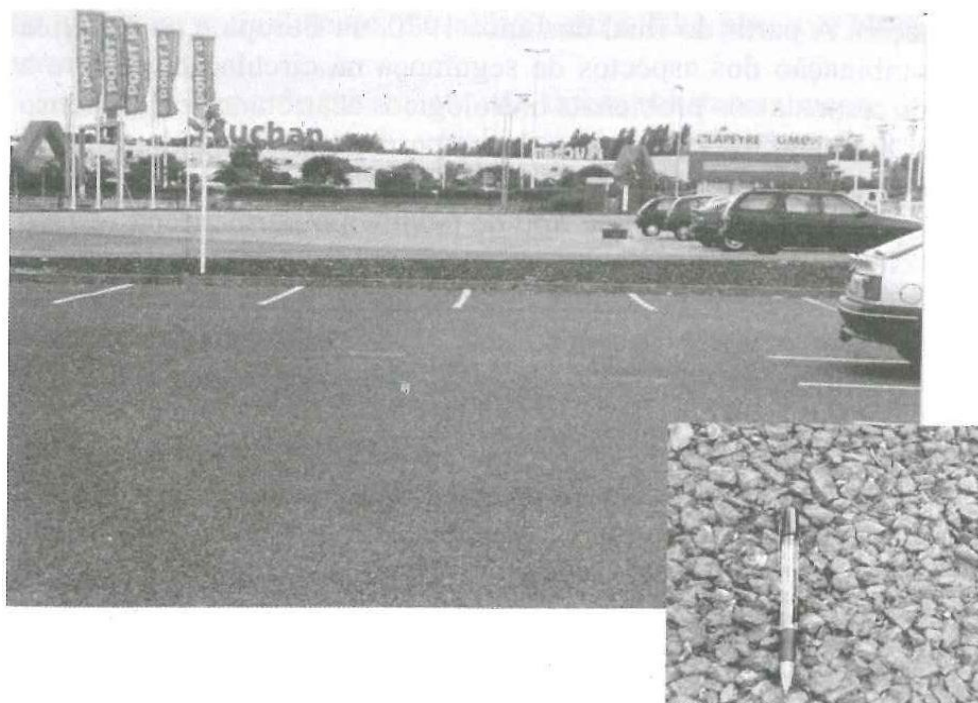
Figura 11.7 – Utilização de pavimento poroso em estacionamento
