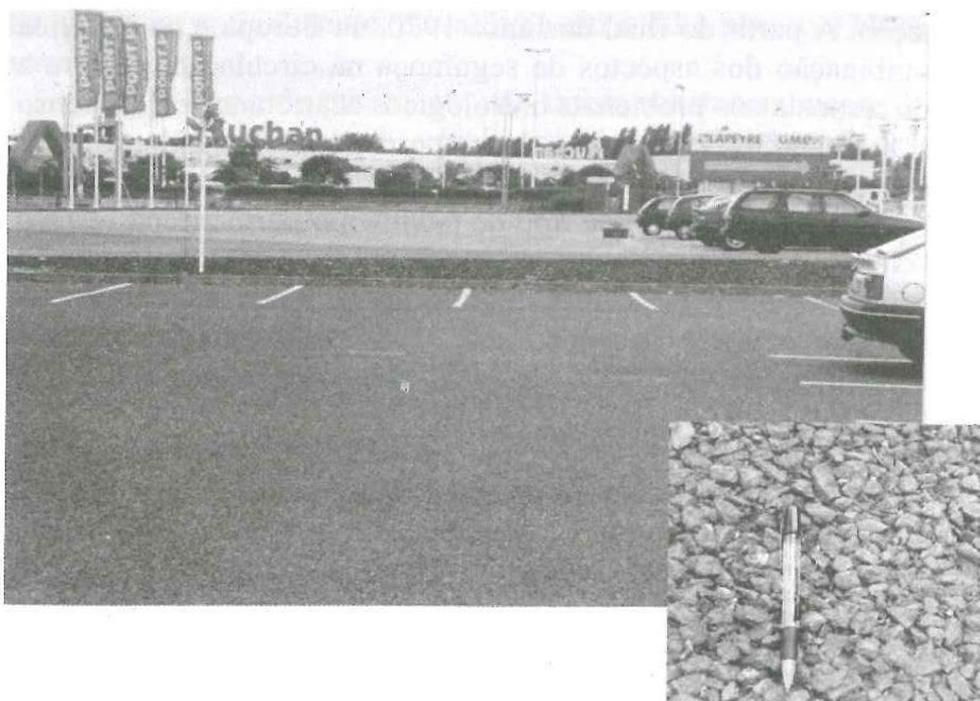
**Figura 11.7 – Utilização de pavimento poroso em estacionamento**
