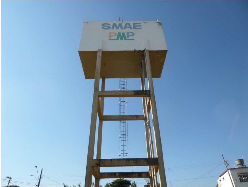
Figura 7.71 – Reservatório COJAN operado pelo SMAE
