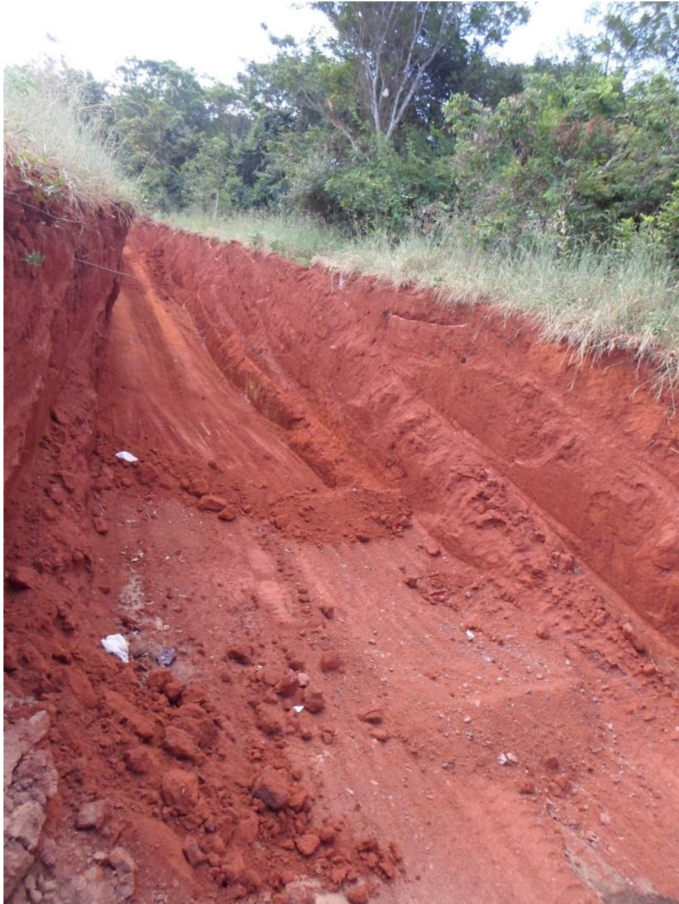
Figura 7.178 – Abertura de nova vala no aterro controlado de Papagaios
