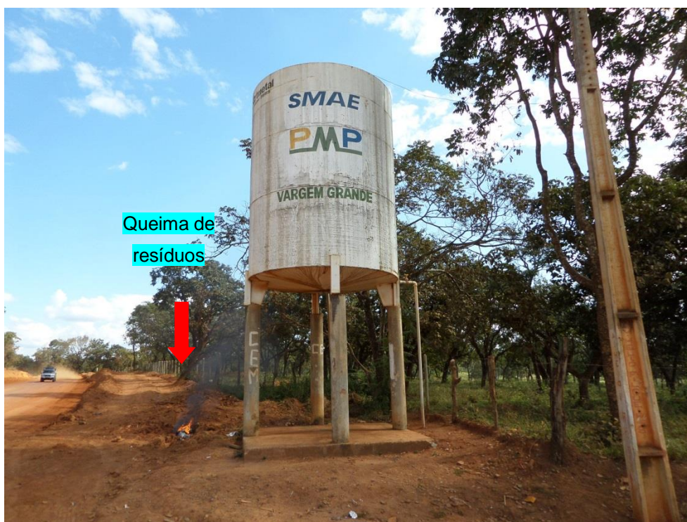
Figura 7.89 – Reservatório de Vargem Grande operado pelo SMAE. Detalhe para queima de resíduos no entorno
