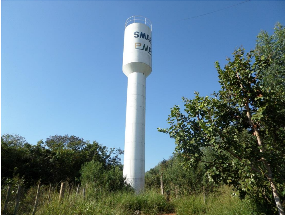
Figura 7.72 – Reservatório Vasco Lopes operado pelo SMAE
