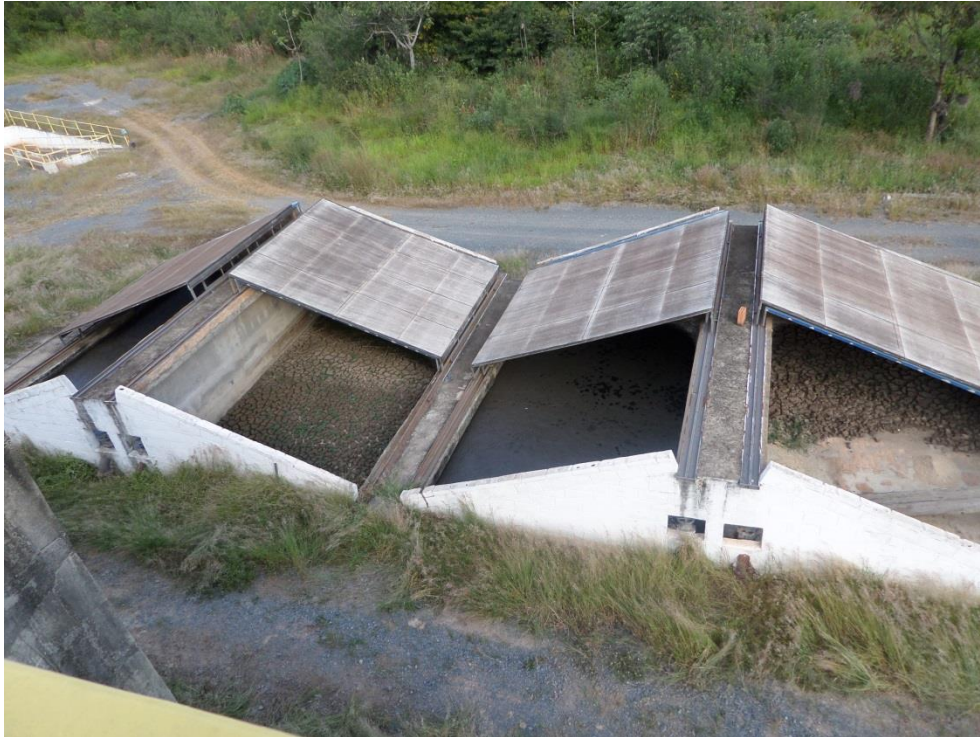
Figura 7.102 – Leitos de secagem na ETE operada pelo SMAE
