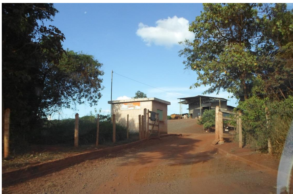
Figura 7.155 – Entrada principal da ASCAMRRP
