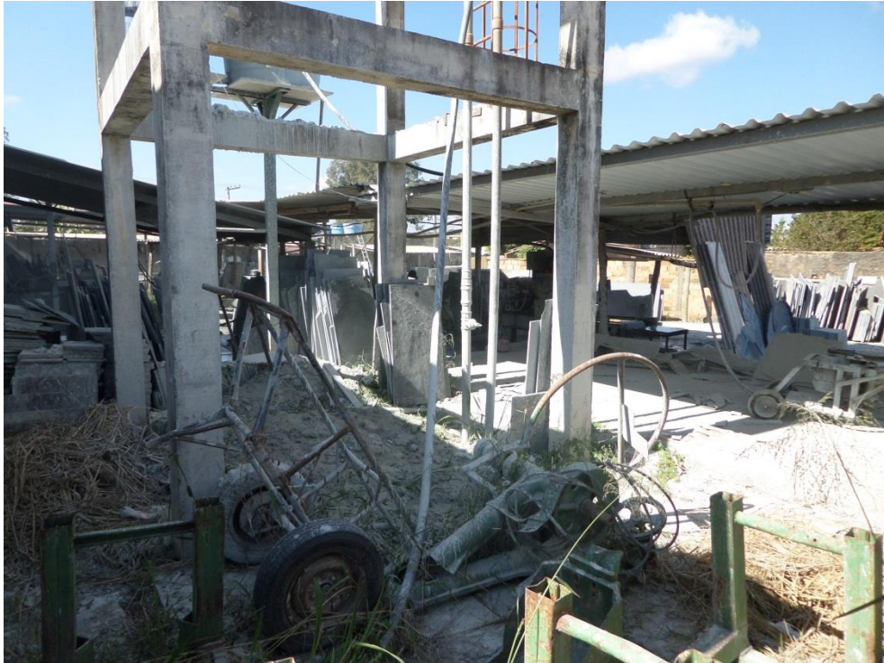
Figura 7.80 – Entulho do terreno da fábrica onde está localizado o reservatório Caixa Quadrada ou da Chapada
