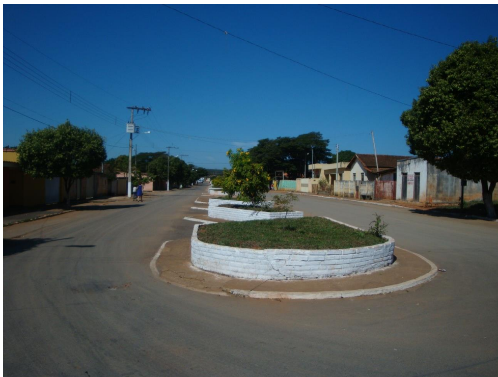
Figura 7.33 – Asfaltamento da Avenida Luis Lobato, Papagaios
