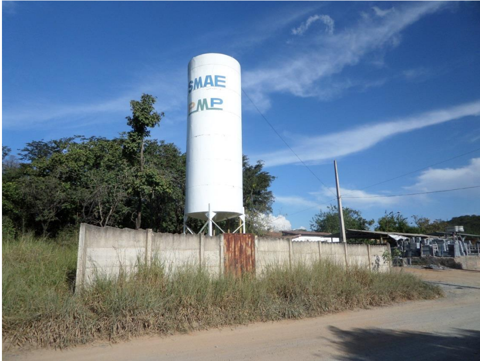
Figura 7.76 – Reservatório Cidade Industrial operado pelo SMAE
