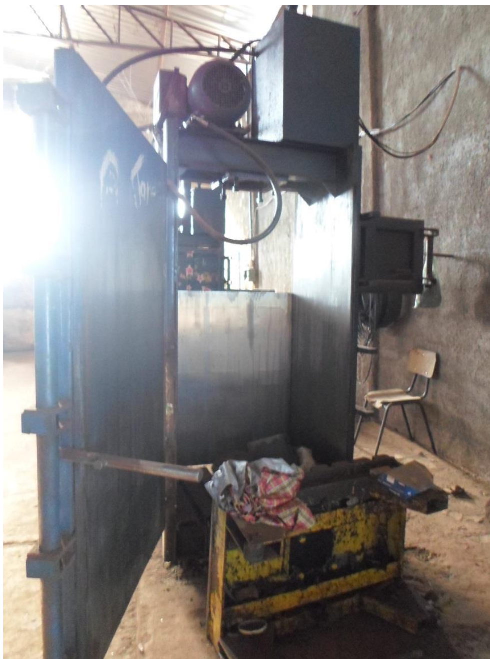
Figura 7.164 – Prensa mecânica (em manutenção) da ASCAMRRP
