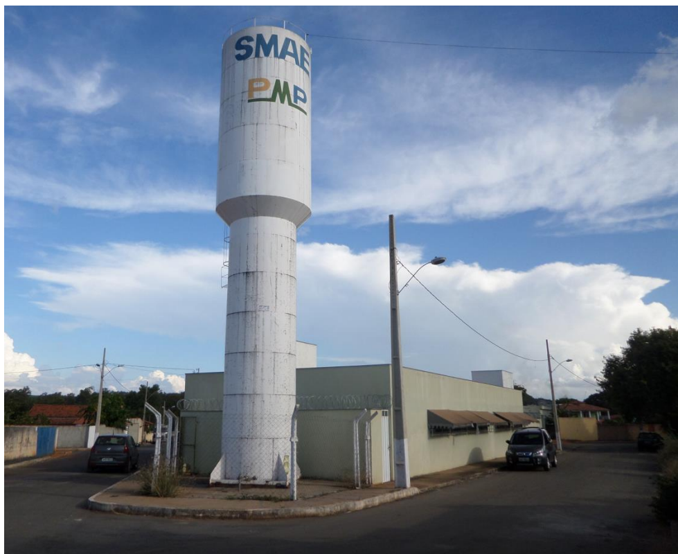
Figura 7.75 – Reservatório Santo Antônio operado pelo SMAE
