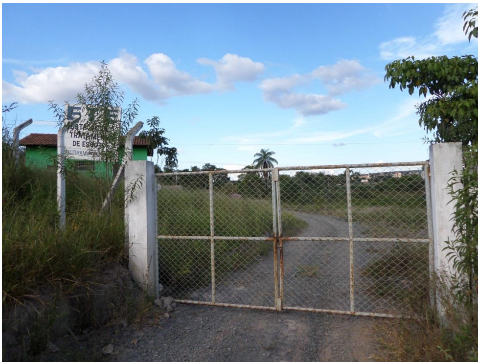
Figura 7.96 – Vista da entrada da ETE operada pelo SMAE. Detalhe para placa de identificação que estava coberta pela vegetação
