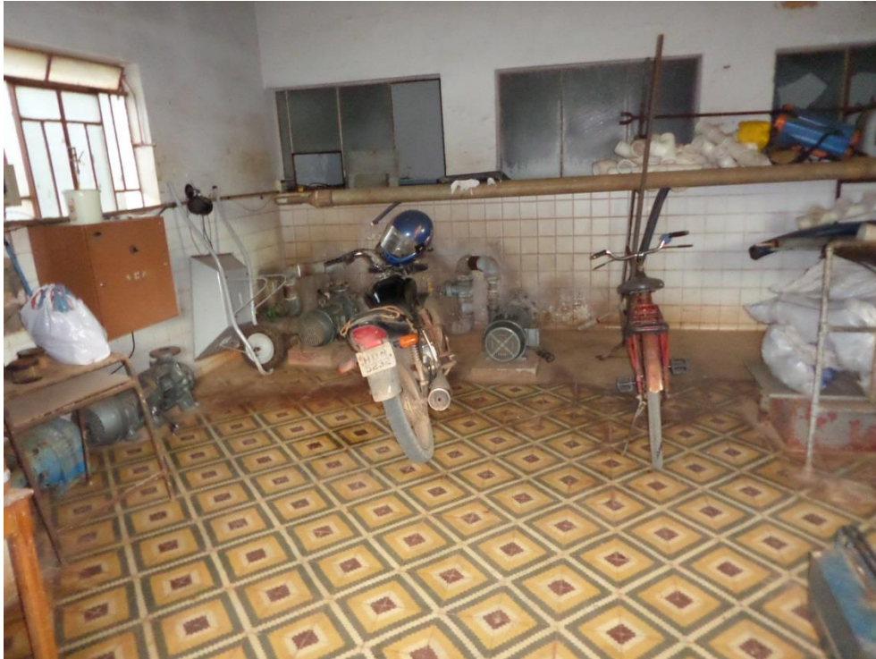
Figura 7.67 – Local onde está o reservatório do Depósito também é utilizado para armazenamento de materiais do SMAE
