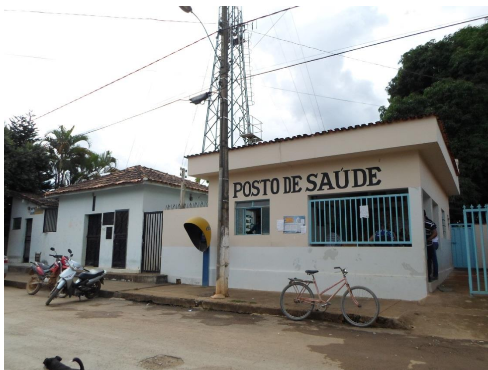
Figura 7.131 – Posto de Saúde (Localidade de Vargem Grande)
