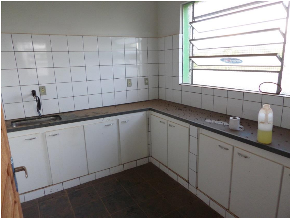
Figura 7.105 – Casa de apoio para análises de rotina de ETE
