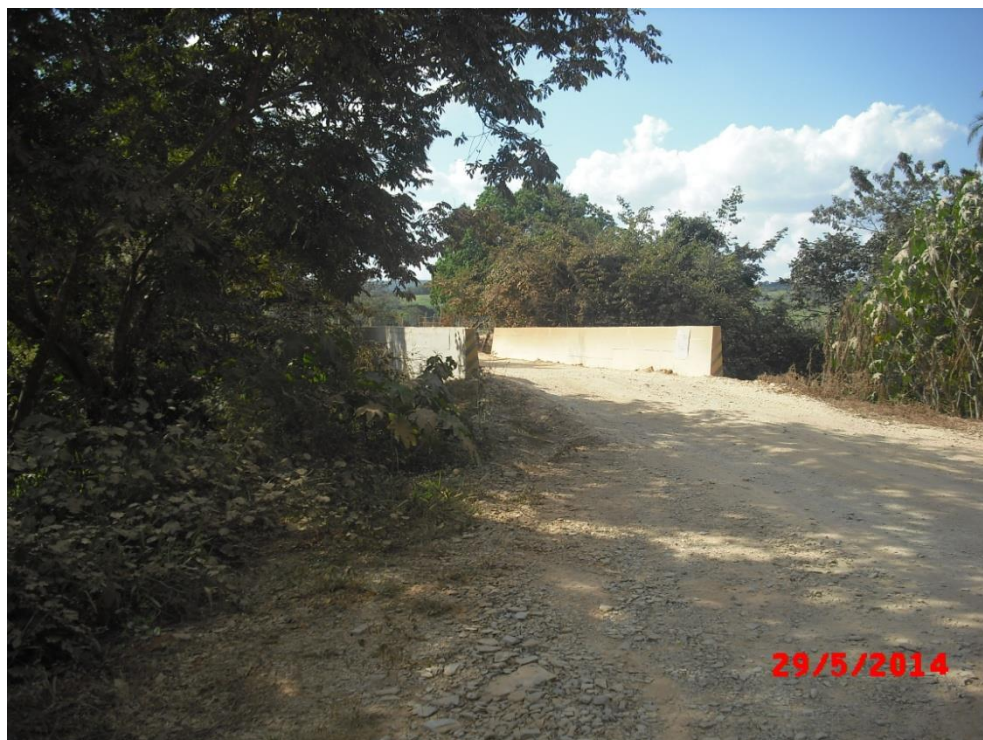
Ponto de inundação, Rua José Belizário – Vargem Grande
