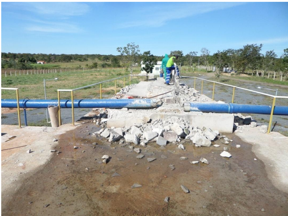
Figura 8.87–Desarenador da ETE de Moema
