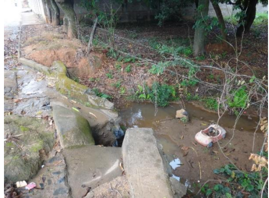
Travessia do Córrego do Brejinho na Rua Caetés
