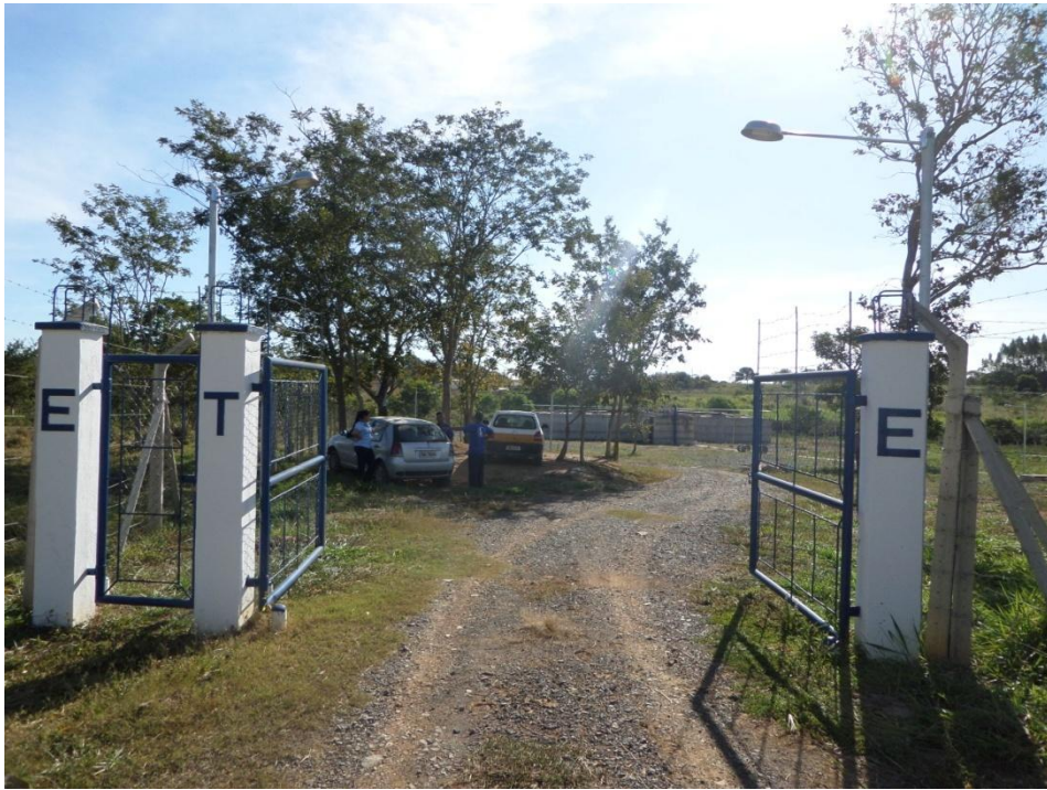
Figura 8.86– Vista geral da ETE de Moema
