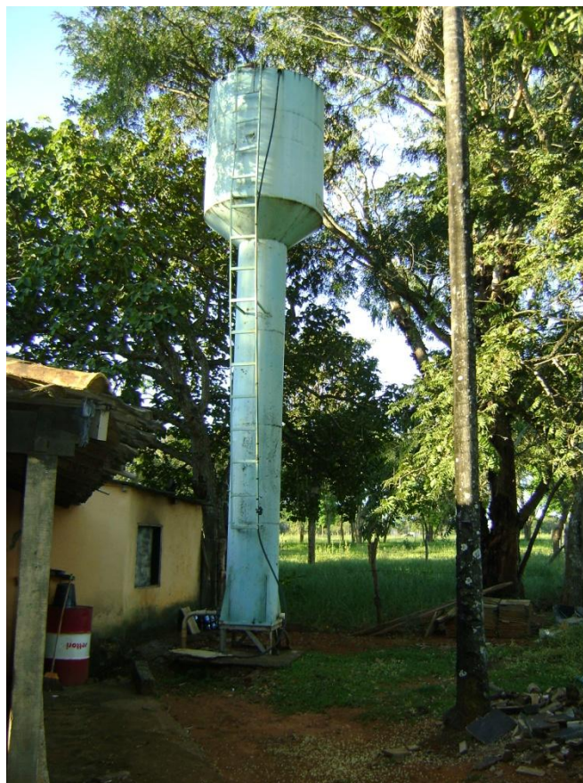
Figura 8.66–Reservatório do sistema do distrito de Caiçara
