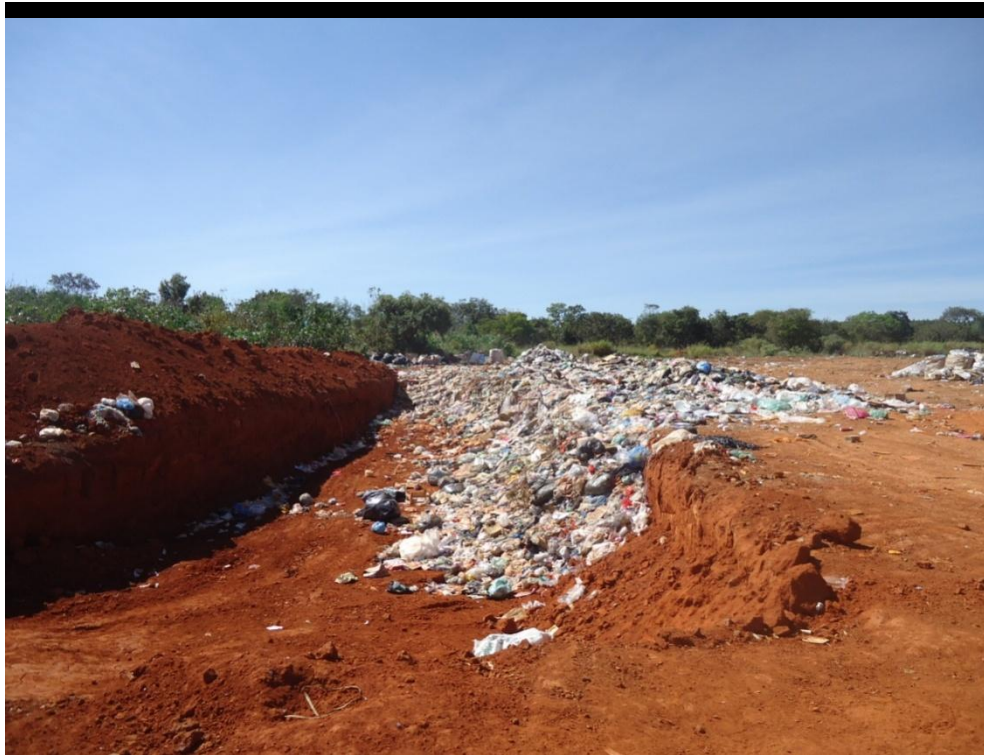
Figura 8.157 – Vala para disposição de RSD no aterro controlado
