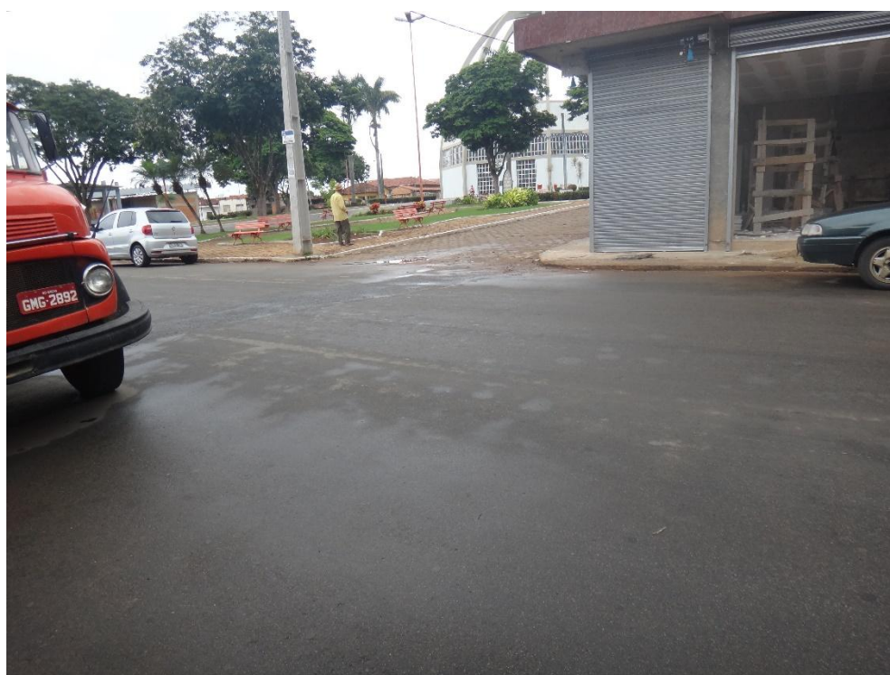
Figura 8.178 – Guias e Sarjetas na Rua Tupis – Centro
