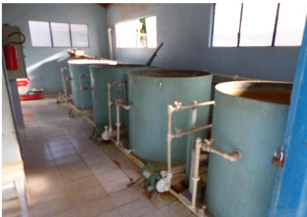
Figura 8.74–Casa de química da ETA
