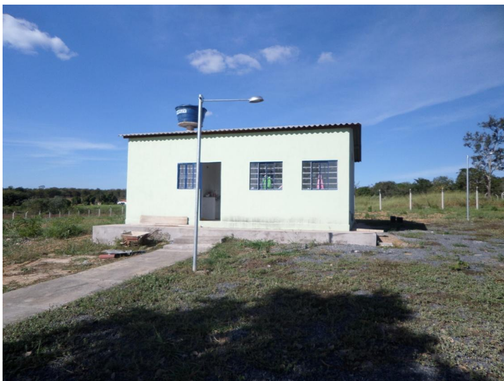
Figura 8.92–Estrutura física para as futuras instalações do laboratório, copa e banheiros da ETE de Moema
