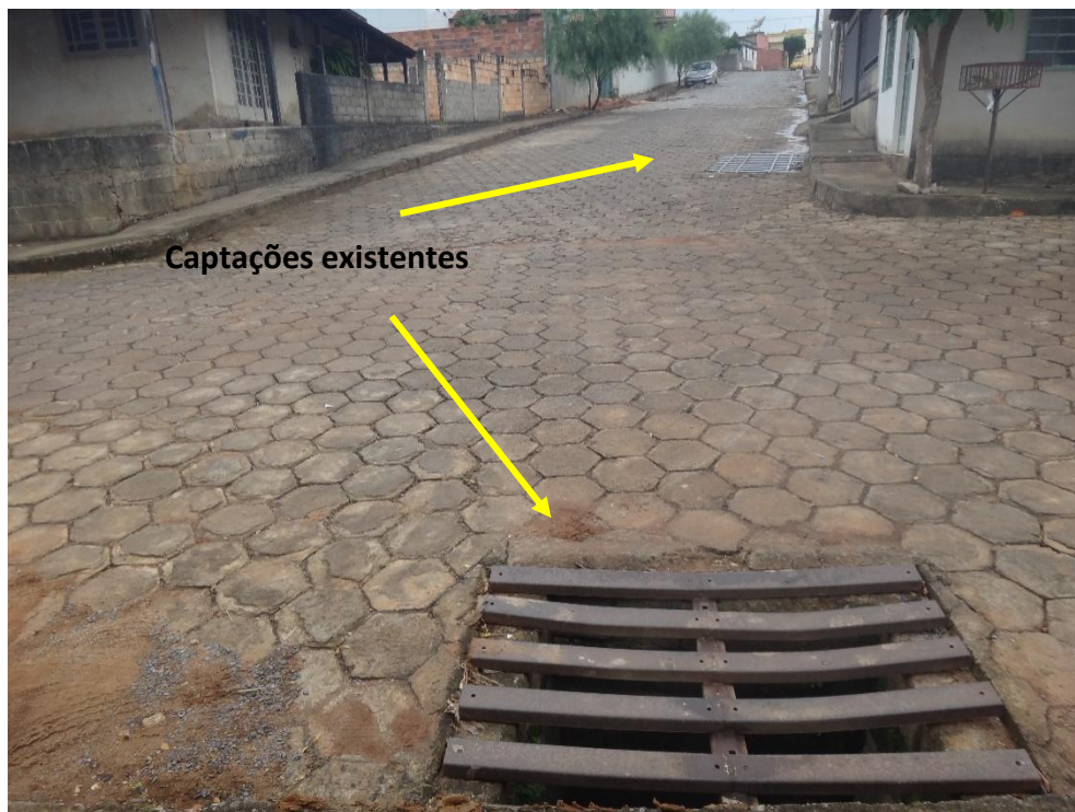
Captações de águas pluviais existentes, rua Paraguaçu
