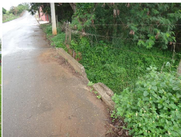
Travessia do Ribeirão do Doce sob a Rua Guaraciaba
