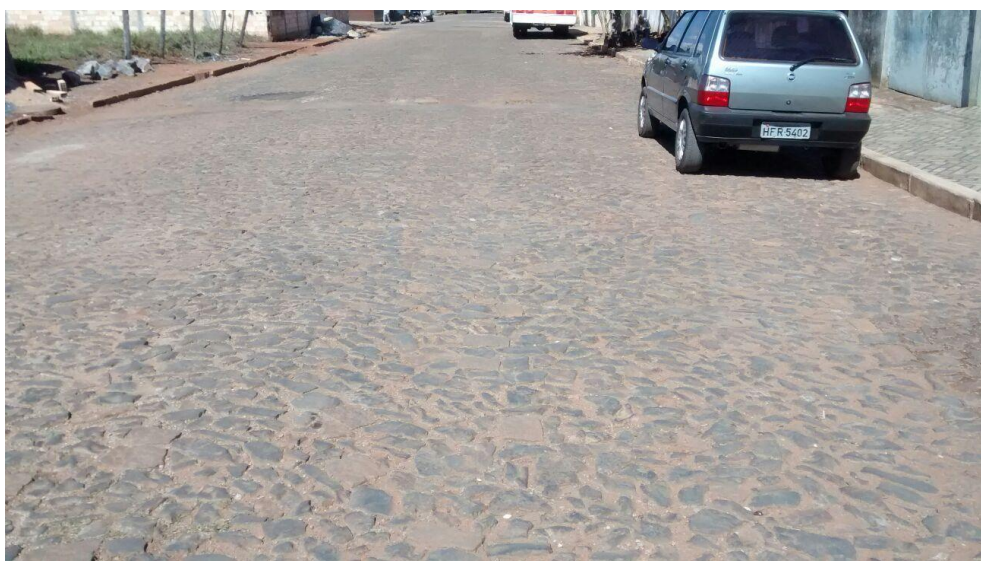
Figura 8.37 –Calçamento de Pedra, Moema
