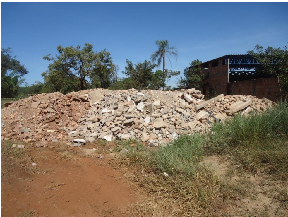
Figura 8.123 – RCC depositados em lotes vagos
