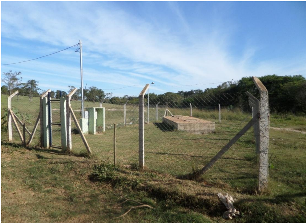
Figura 8.84 – Terceira estação elevatória de esgoto de Moema
