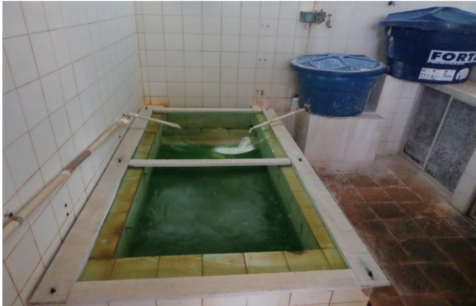
Figura 8.47– Adição de cloro e flúor
