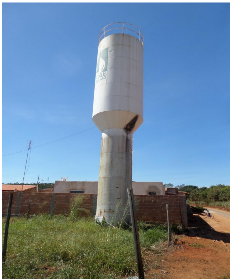
Figura 8.55–Reservatório desativado sistema bairro Palmeiras
