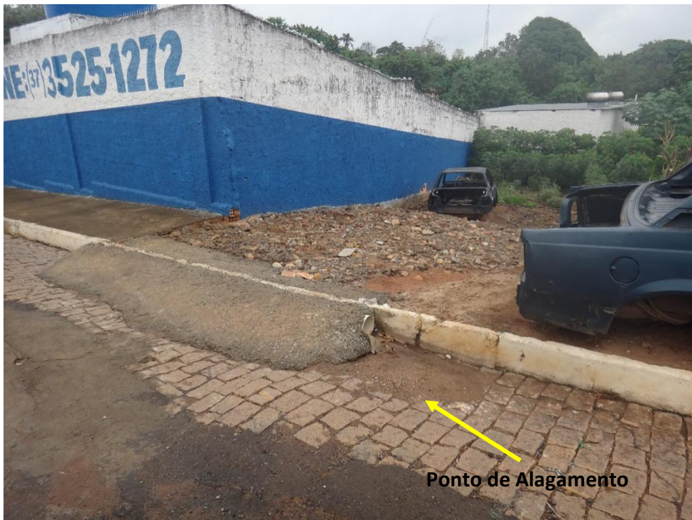
Alagamento na rua Guarani Fonte: COBRAPE (2014)
