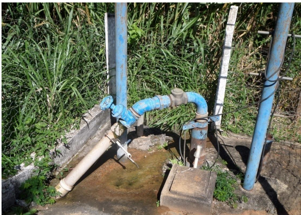
Figura 8.49– Poço tubular Rua Montezuma
