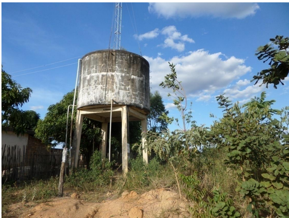
Figura 8.77–Reservatório do sistema de abastecimento do distrito de Chapada
