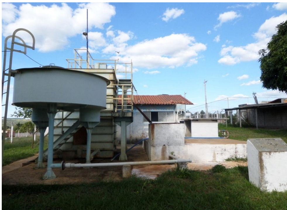
Figura 8.73–Vista geral da ETA
