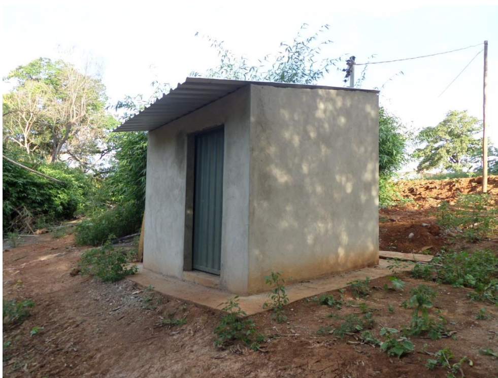
Figura 8.63–Poço tubular sistema do loteamento Recanto do Sabiá
