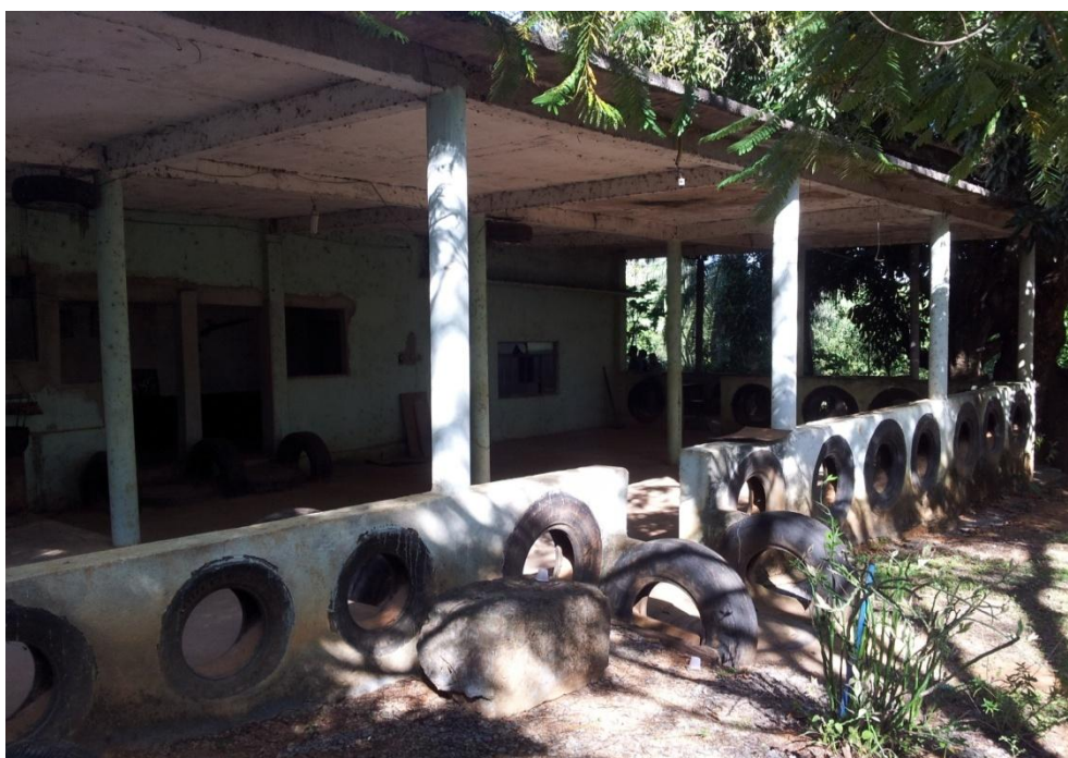
Figura 8.139 – Área de armazenamento de pneus inservíveis
