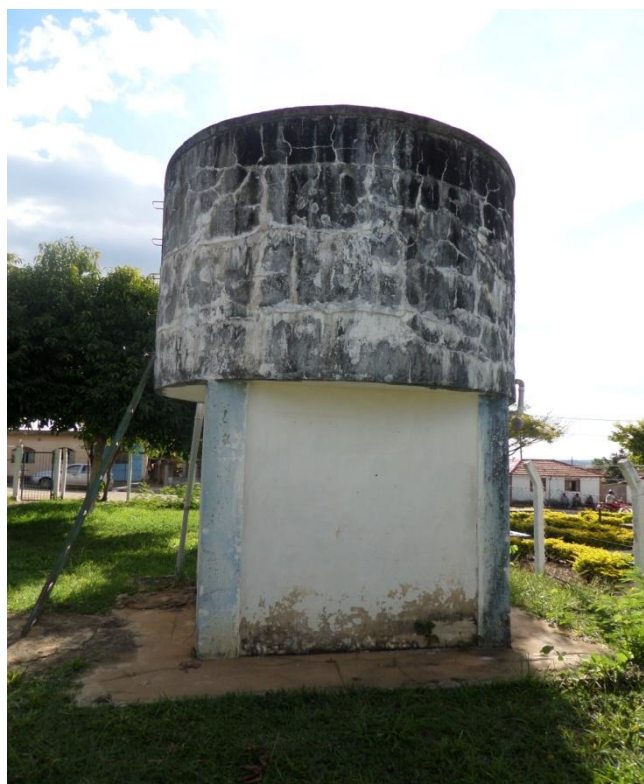
Figura 8.76–Reservatório de água bruta
