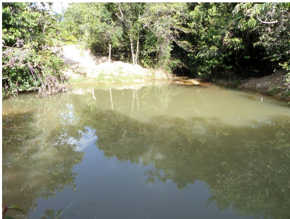
Figura 8.68—Reservatório artificial de captação do sistema do distrito da Chapada
