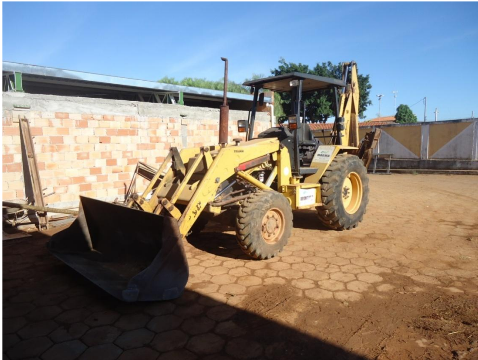
Figura 8.115– Trator retroescavadeira utilizado para a coleta dos resíduos derivados da capina, capina e RCC
