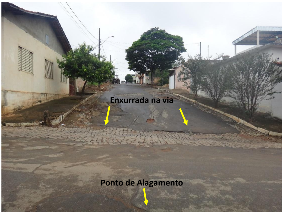
Enxurrada na rua Tapajós, alaga a rua Guarani Fonte: COBRAPE (2014)
