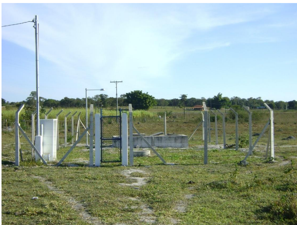
Figura 8.82 - Primeira estação elevatória de esgoto de Moema
