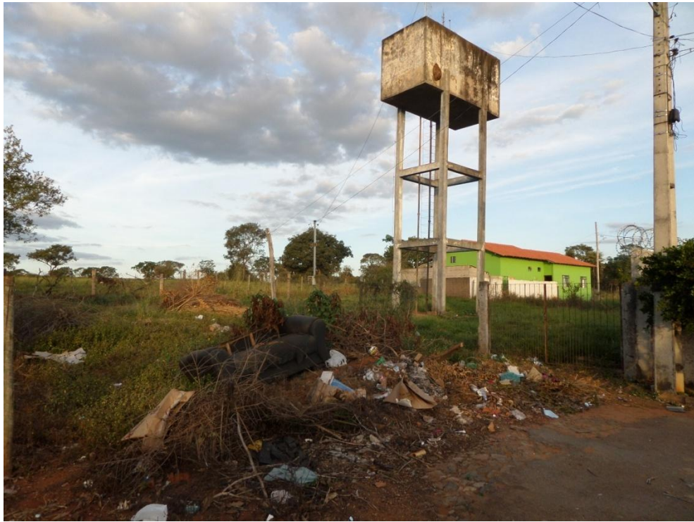
Figura 8.62–Bota fora ao lado do reservatório do sistema Alvorada
