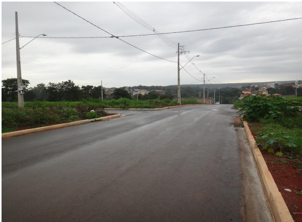
Figura 8.180 – Captações e galerias de águas pluviais no Loteamento dos Ipês
