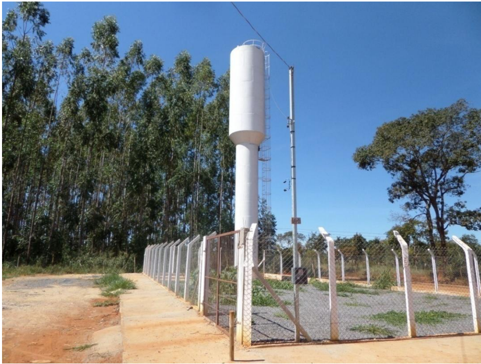
Figura 8.56–Reservatório ativado sistema bairro Palmeiras
