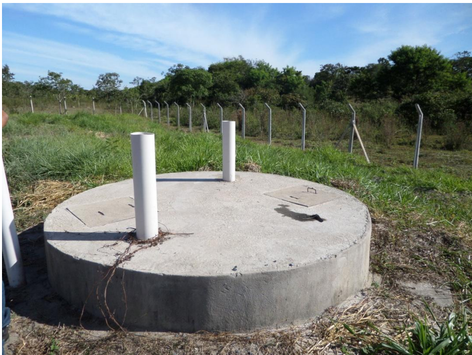
Figura 8.91–Filtro de polimento da ETE de Moema
