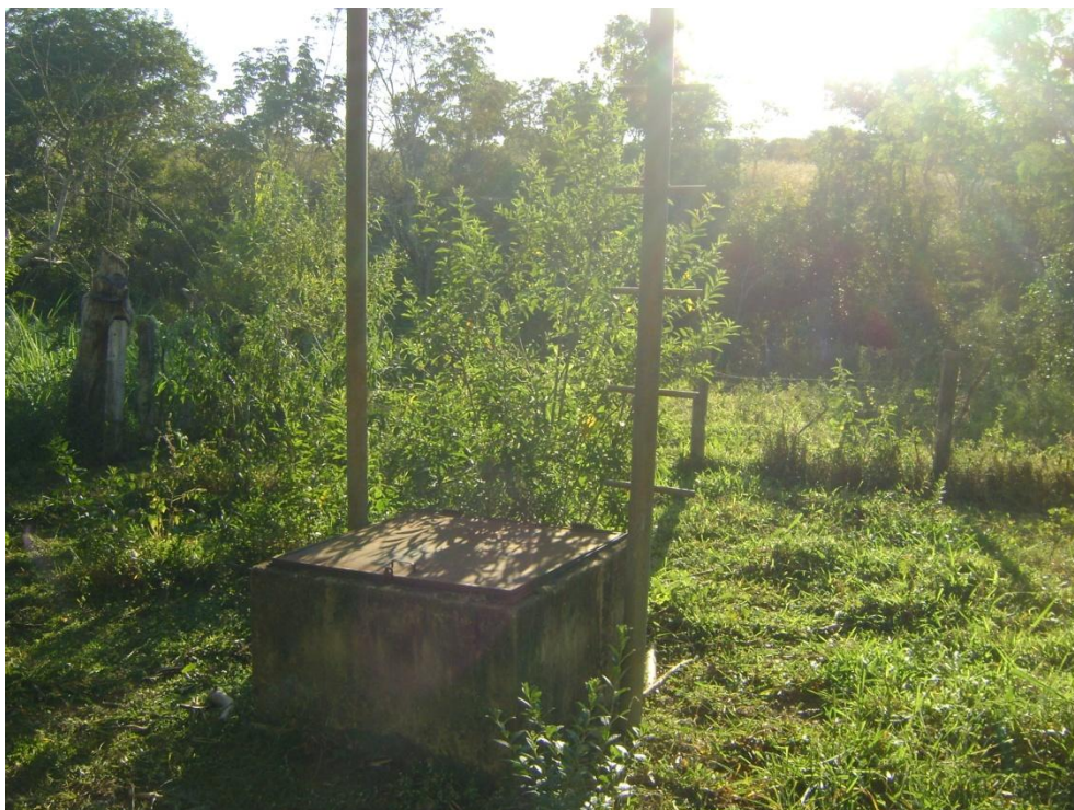
Figura 8.65–Poço tubular sistema do distrito de Caiçara
