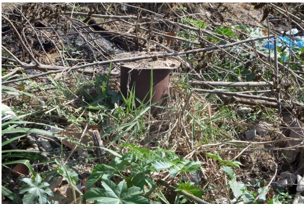
Figura 8.81– Poço tubular nº 27
