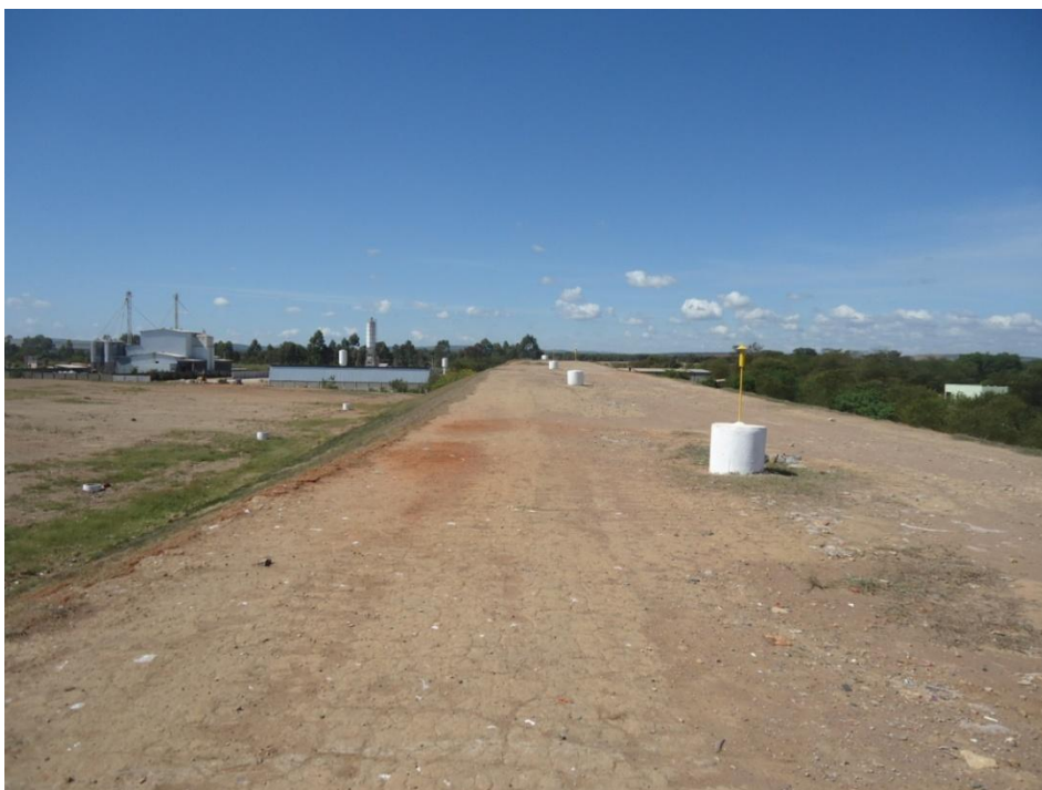
Figura 8.220 – Célula encerrada com drenos de gases
