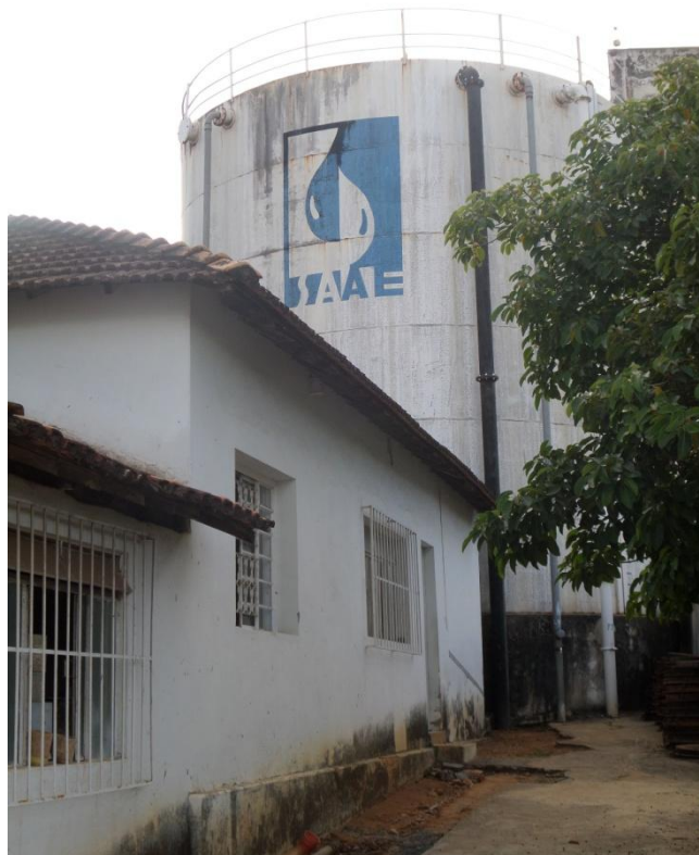
Figura 8.58– Reservatório da Rua Jacinto Ribeiro
