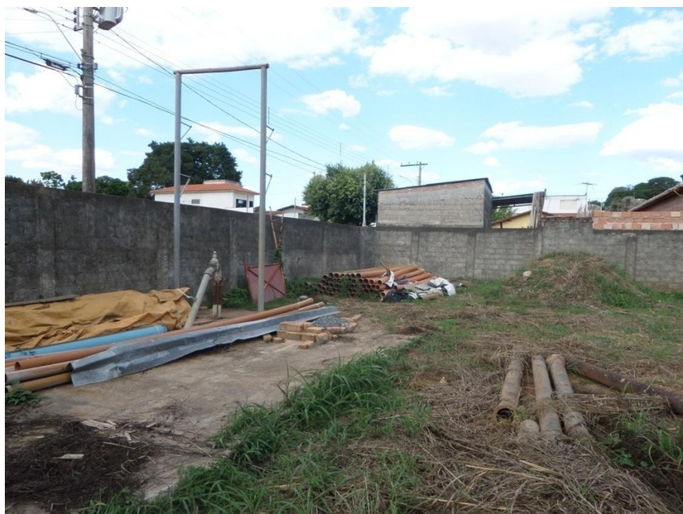
Figura 8.66– Poço tubular n° 5
