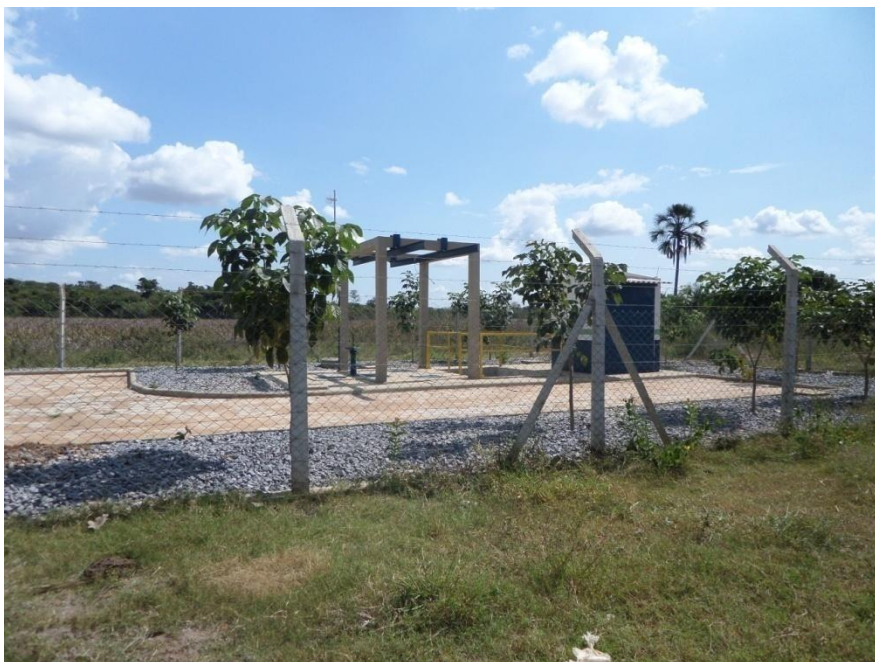
Figura 8.109 - Primeira estação elevatória de esgoto de Lagoa da Prata
