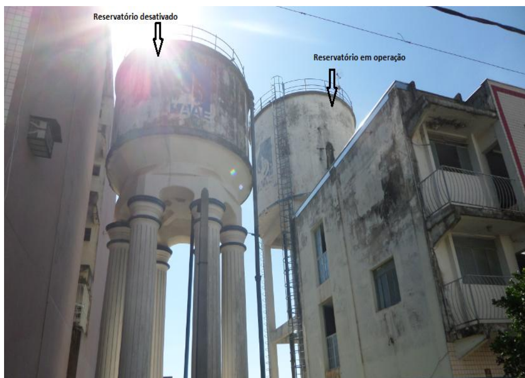
Figura 8.59– Reservatórios da Rua Cirilo Maciel
