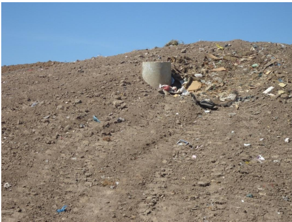
Figura 8.218 – Dreno de gases
