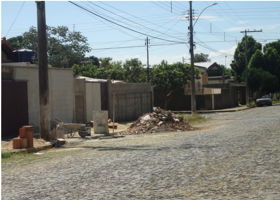
Figura 8.177 – RCC depositados em lotes vagos
