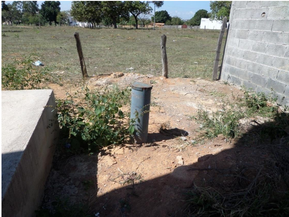
Figura 8.56– Poço tubular nº 31
