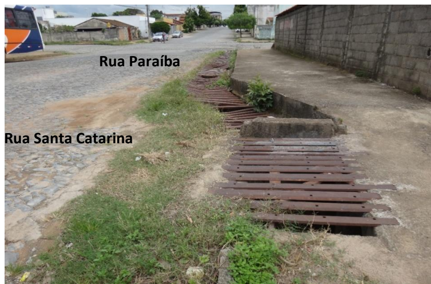
Captações existentes na Rua Santa Catarina, travessa com a Rua Paraíba
