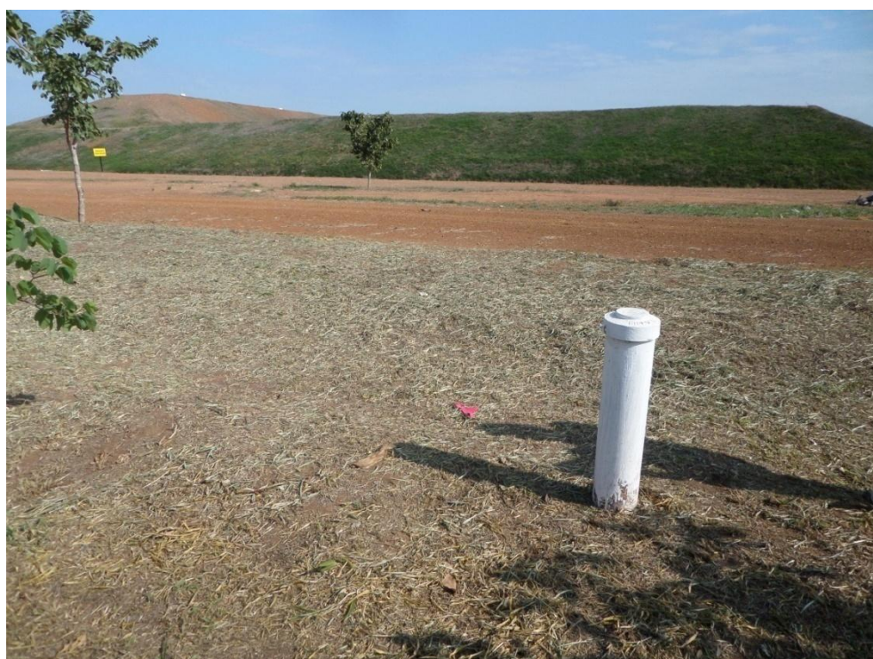
Figura 8.99– Poço tubular n° 22
