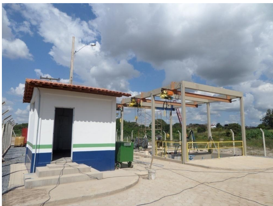
Figura 8.110 - Segunda estação elevatória de esgoto de Lagoa da Prata
