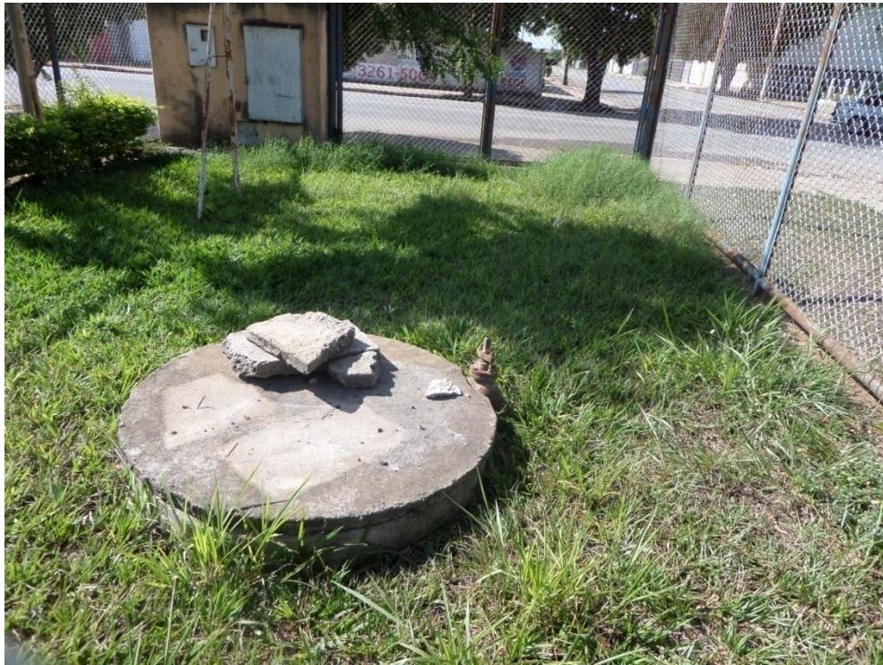
Figura 8.69– Poço tubular nº 14
