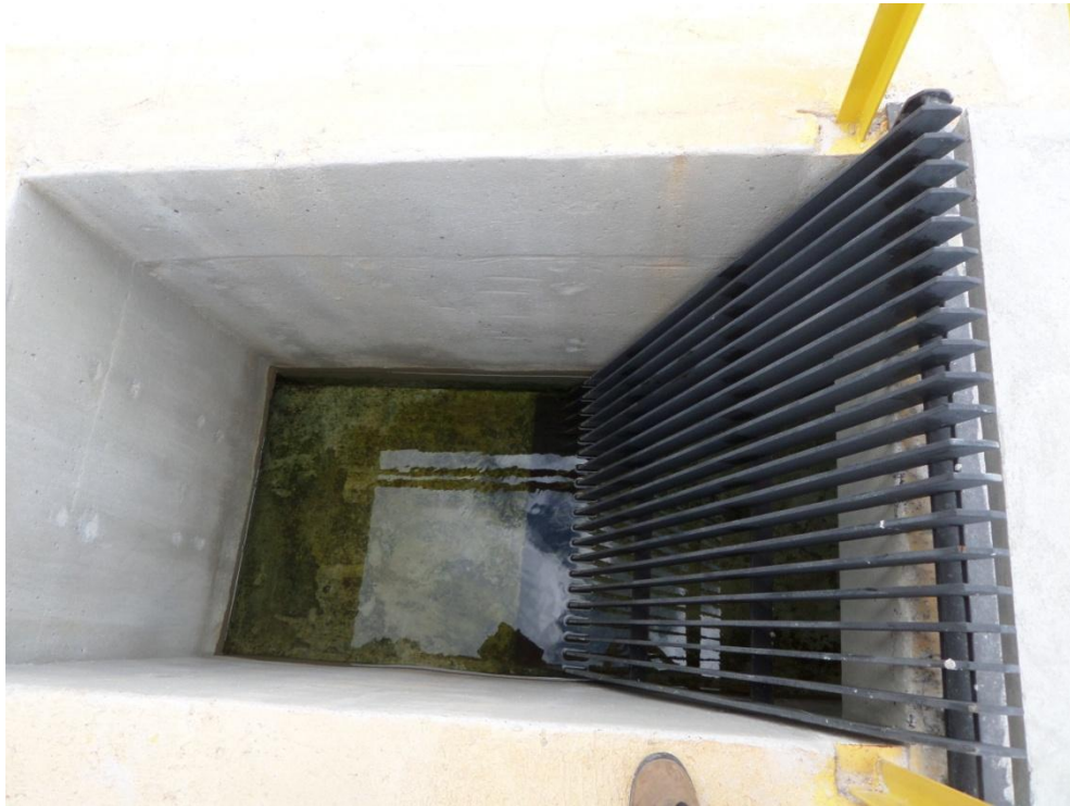
Figura 8.114–Gradeamento grosseiro
