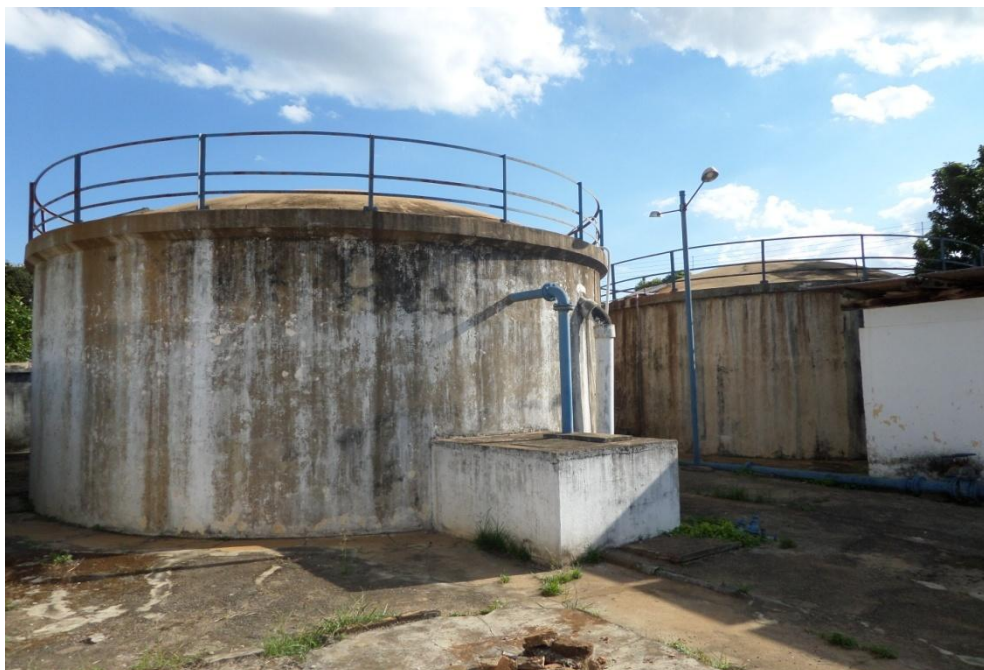
Figura 8.83– Reservatório da Rua Pará
