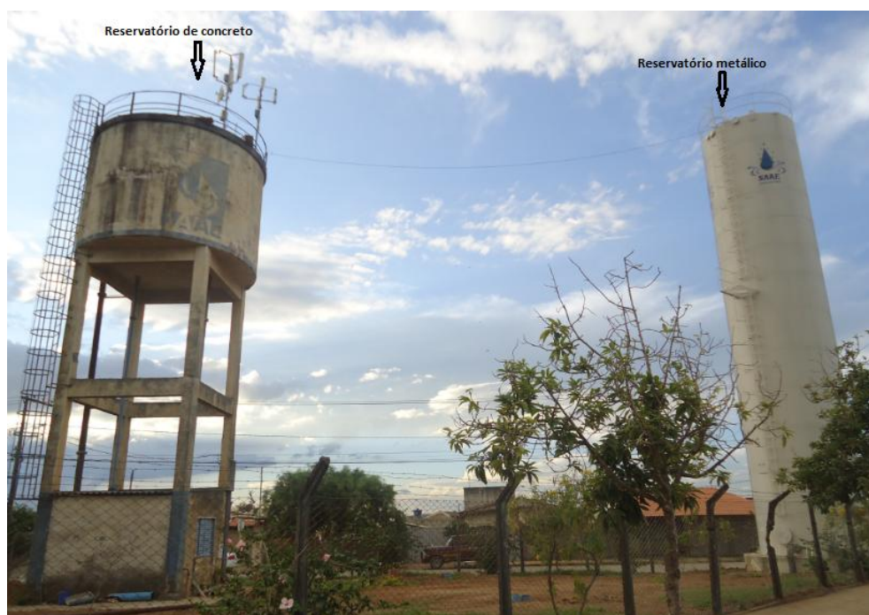
Figura 8.96– Reservatórios da Rua Joaquim Gomes Bernardes
