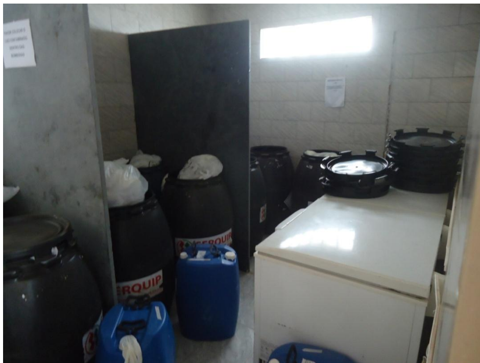
Figura 8.193– Abrigo para armazenamento de RSS – Hospital São Carlos
