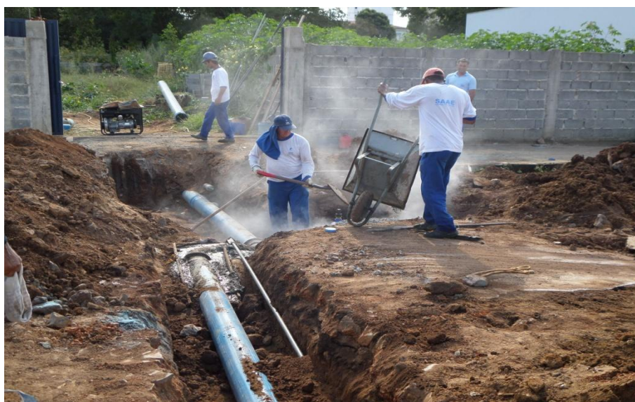
Figura 8.54– Obras de ligação do poço tubular n° 29
