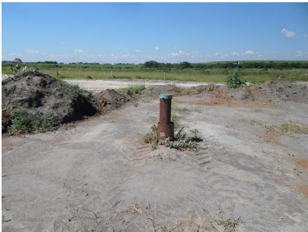
Figura 8.55– Poço tubular n° 30
