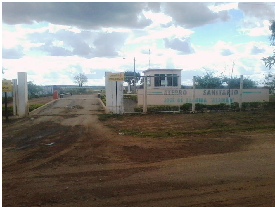
Figura 8.213 – Entrada do aterrosanitário de Lagoa da Prata
