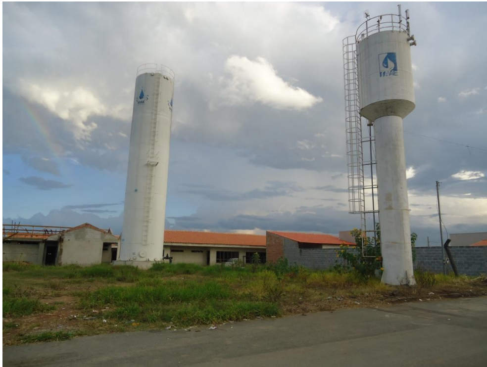
Figura 8.97– Reservatórios da Rua Travessa Santa Maria
