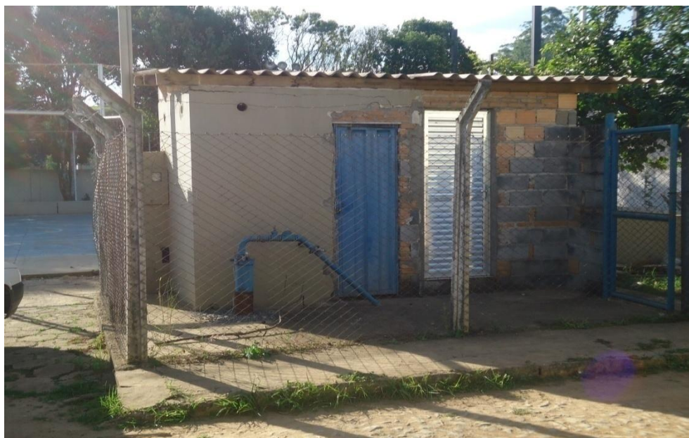
Figura 8.102– Poço tubular nº 13
