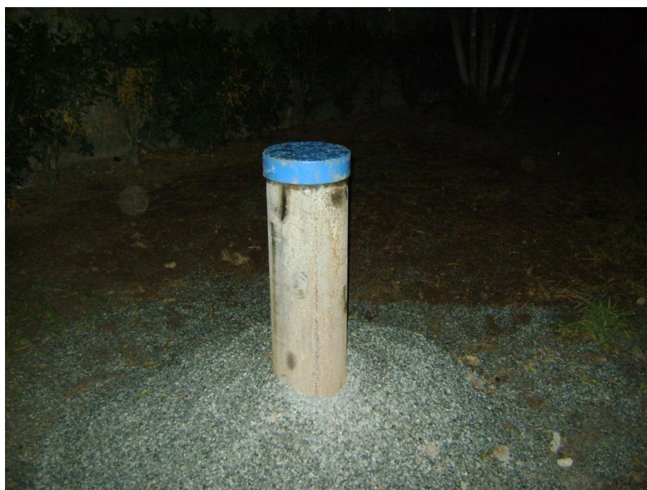
Figura 8.93– Poço tubular n° 33
