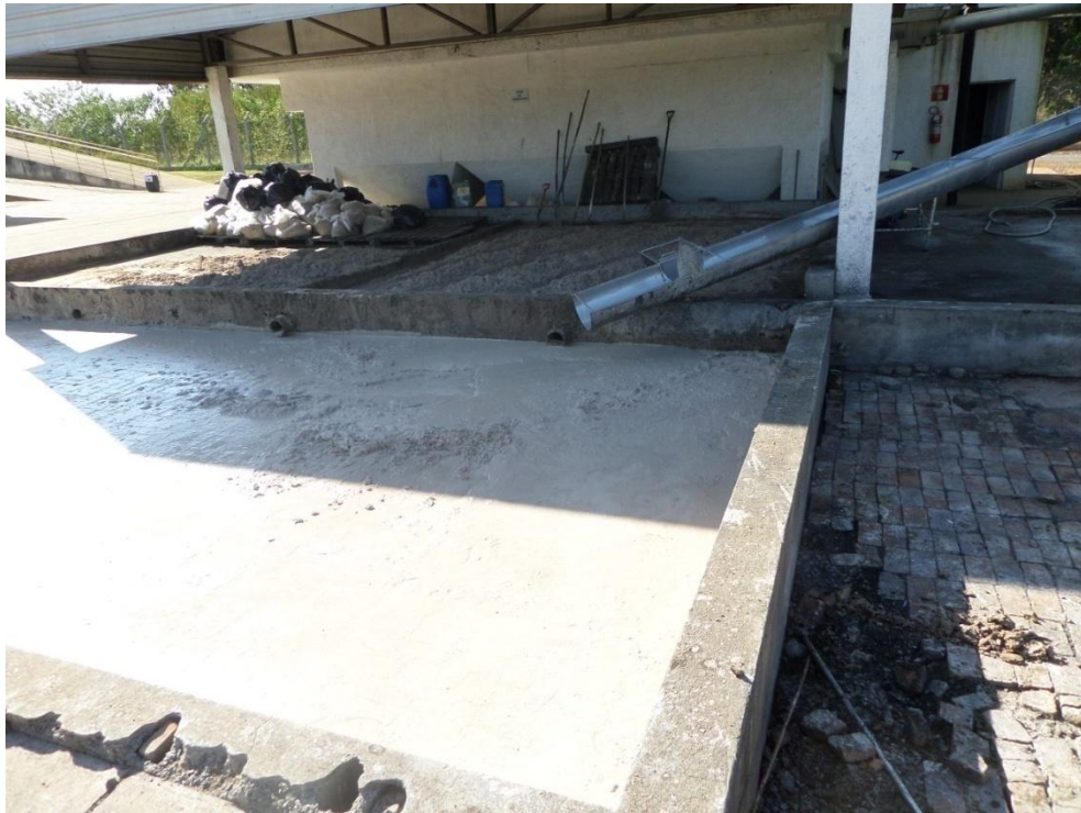
Figura 8.135 – Leito de secagem de gordura
