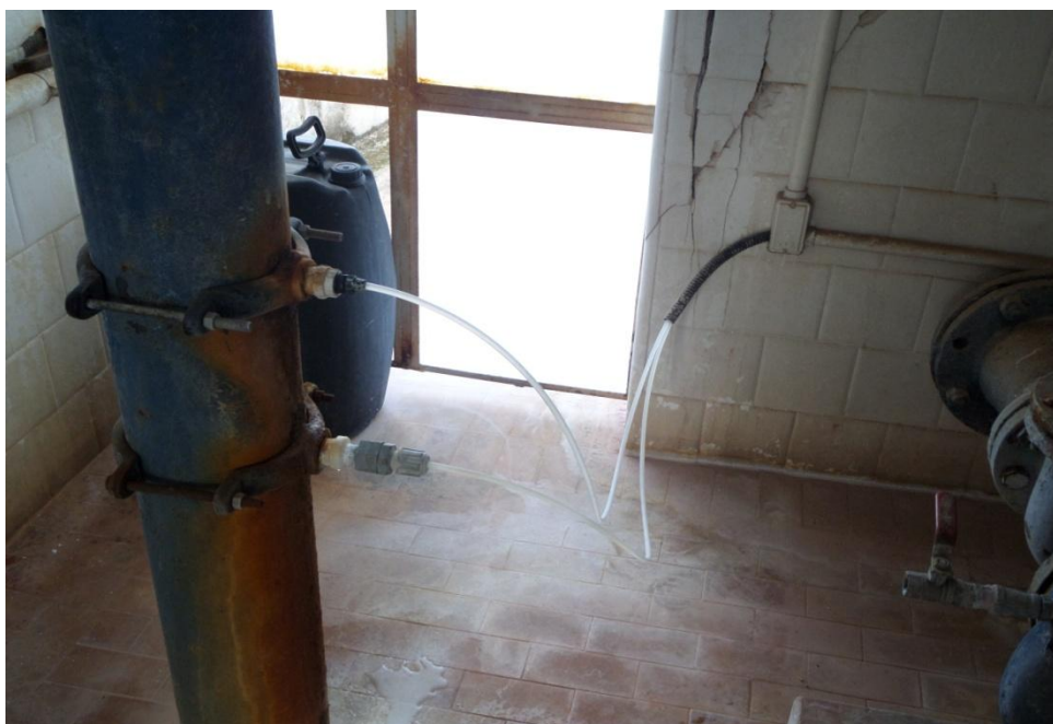
Figura 8.47– Sistema de adição de cloro e flúor
