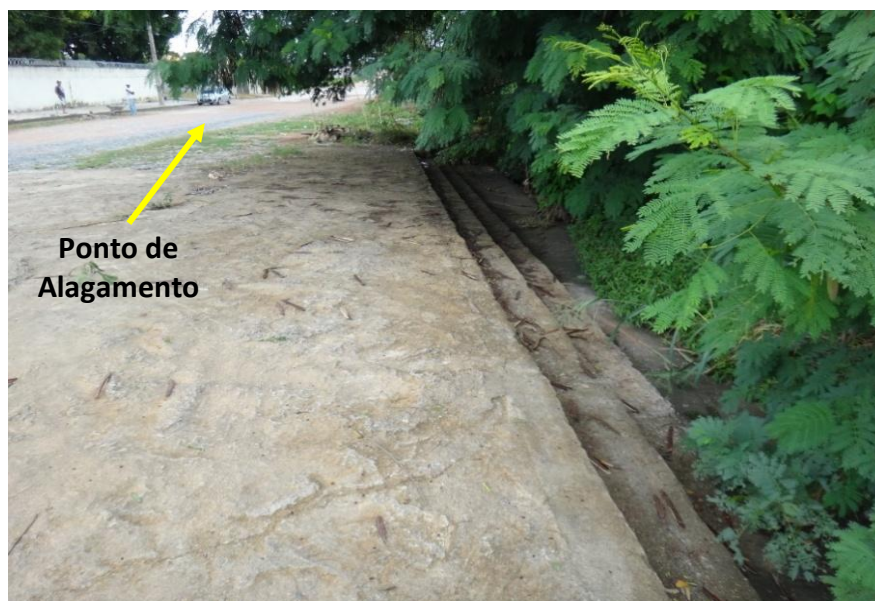
Escada hidráulica a montante do ponto de alagamento
