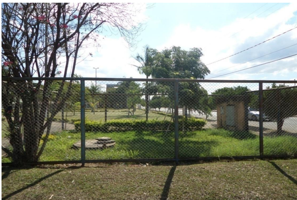
Figura 8.79– Poço tubular nº 20
