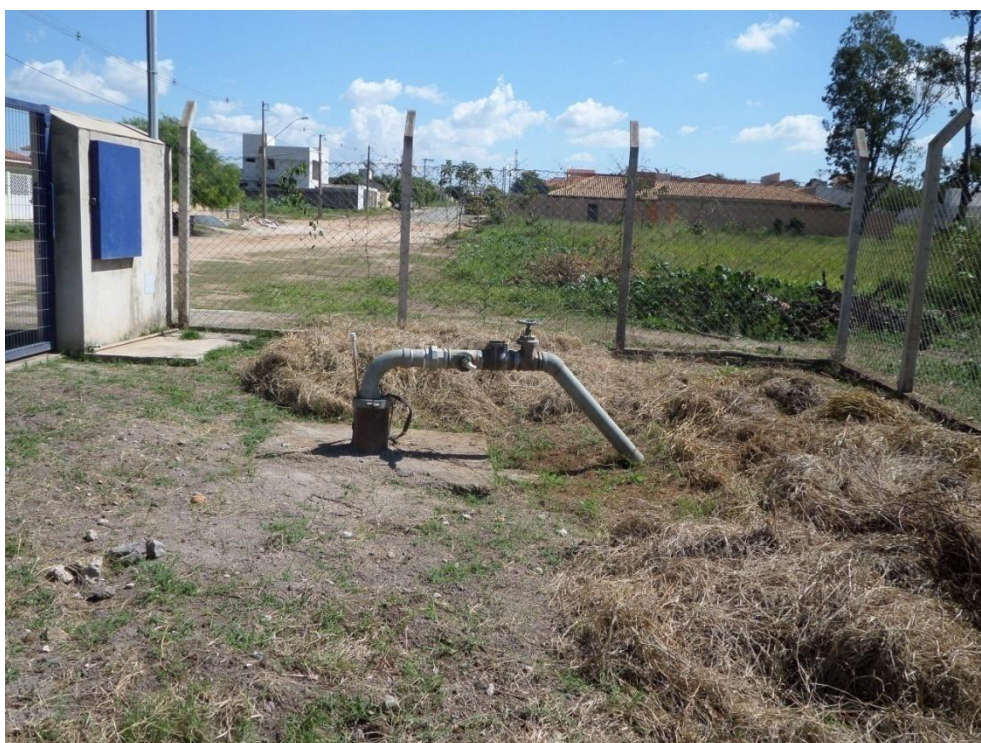
Figura 8.74– Poço tubular nº 28
