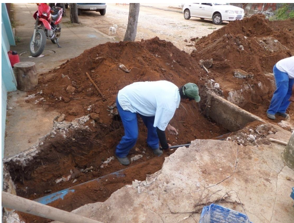
Figura 8.61– Manutenção na rede de distribuição de água do SAAE
