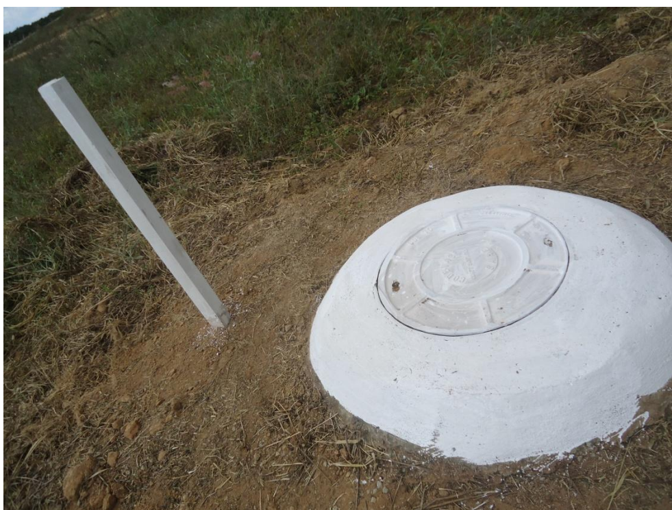
Figura 8.123–Poço de monitoramento ETE de Lagoa da Prata
