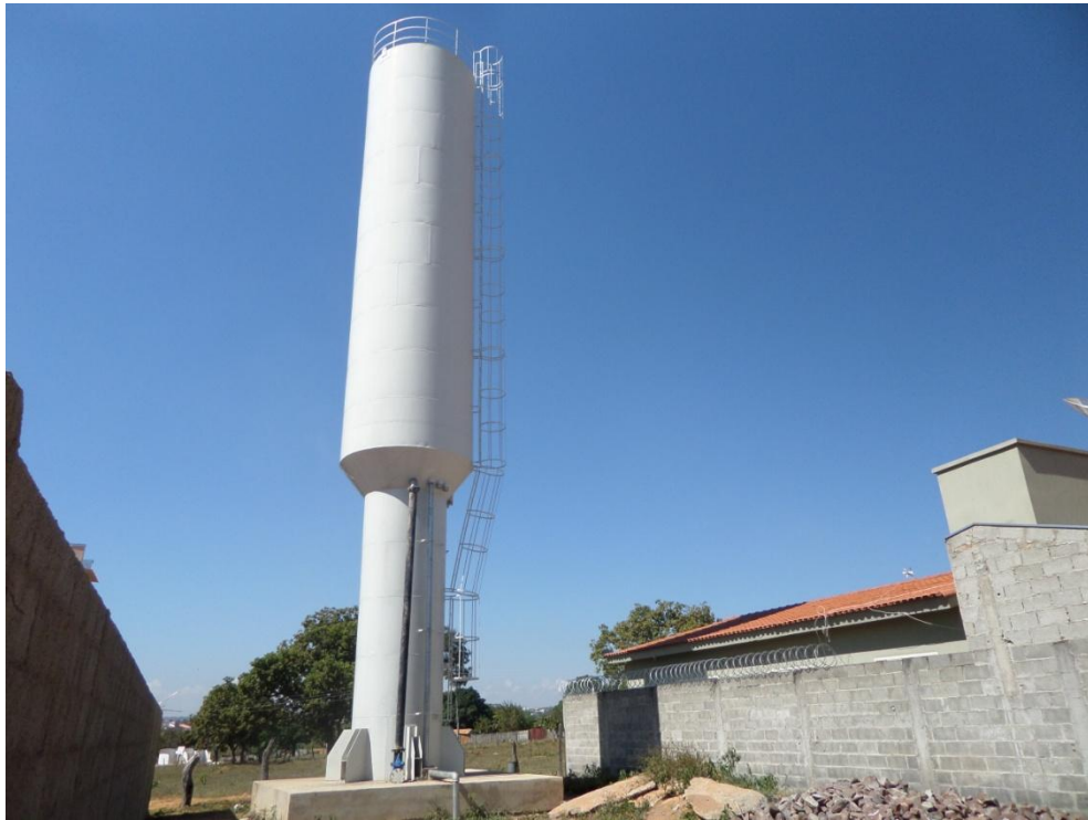
Figura 8.60– Reservatório da Rua Acácio Mendes
