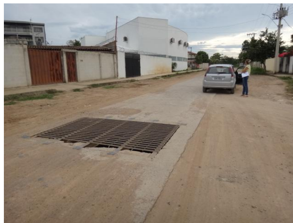
Córrego Chico Silveira canalizado na Avenida Isabel de Castro
