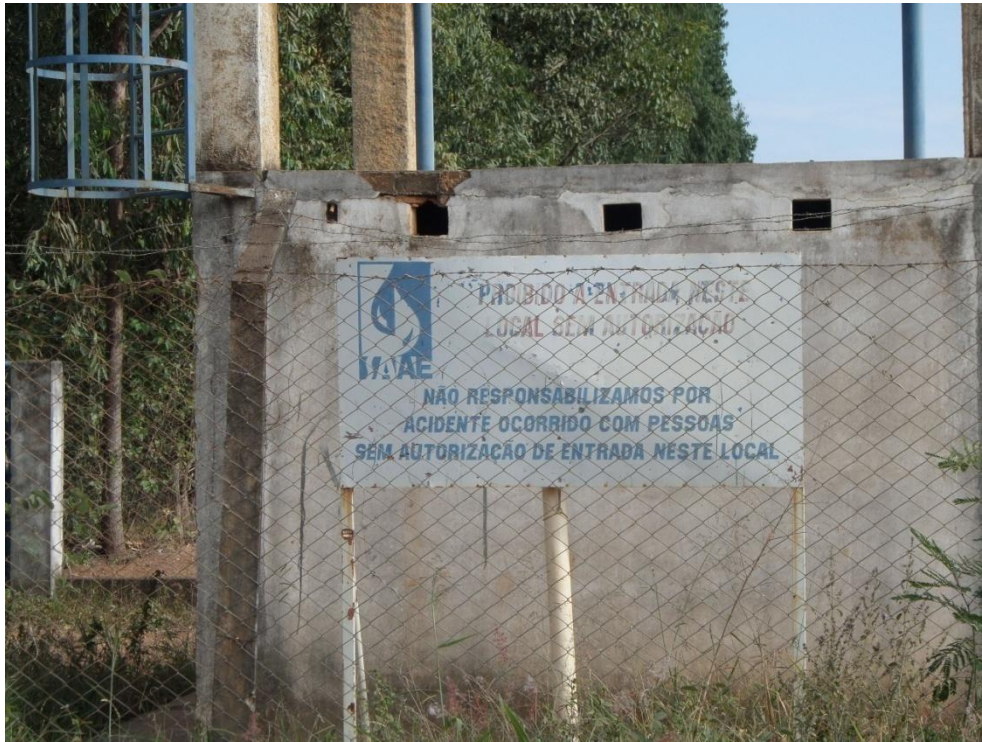
Figura 8.100– Poço tubular n° 19
