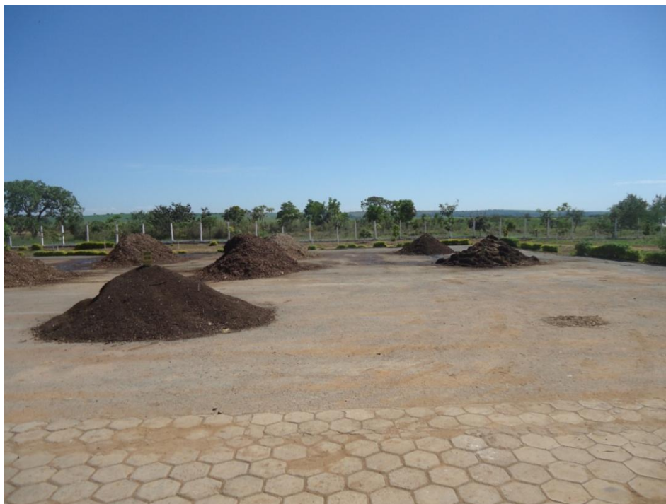
Figura 8.175– Pátio da Usina de Compostagem
