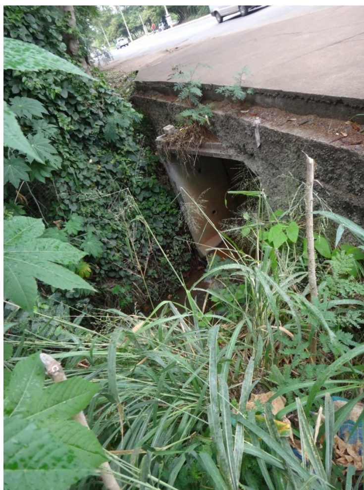
Figura 8.235– Bueiro – Travessia Córrego Chico Messias, Av. José Bernardes Maciel – Sede
