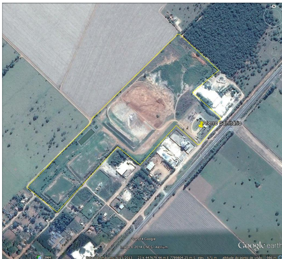
Figura 8.221– Perímetro do aterro sanitário
