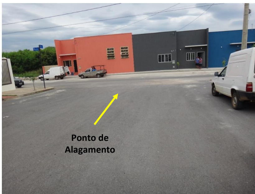
Ponto de alagamento em lote Rua Hércio de Castro
