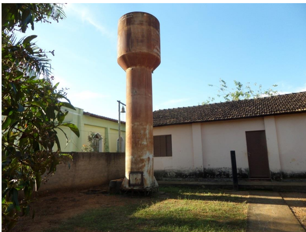
Figura 8.78 – Reservatório de Capivari do Marçal
