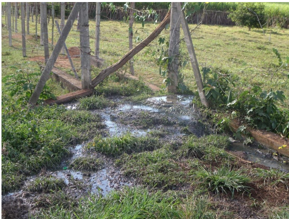
Figura 8.139 – Transbordamento do afluente
