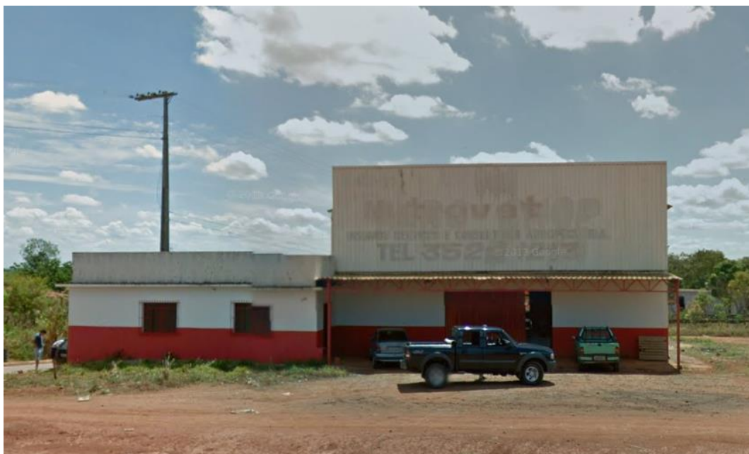
Figura 8.205 – Galpão para armazenamento de pneus
