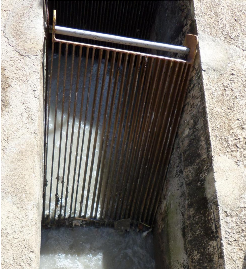
Figura 8.95 – Detalhe do gradeamento
