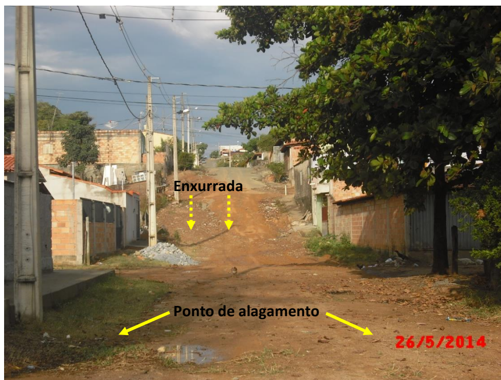
Ponto de alagamento e enxurrada, Rua Monsenhor Otaviano
