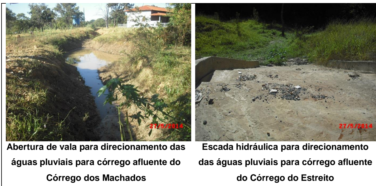
Figura 8.228 – Dispositivos de drenagem no trecho urbano – sede
