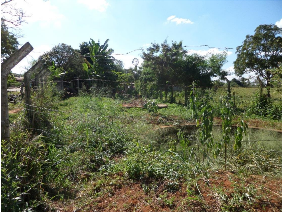
Figura 8.133 – Entrada da ETE Engenho do Ribeiro I
