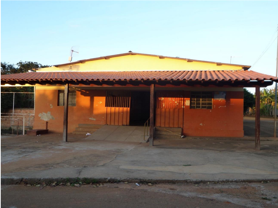
Figura 8.42 – Vista geral ACMS em Bom Despacho/MG
