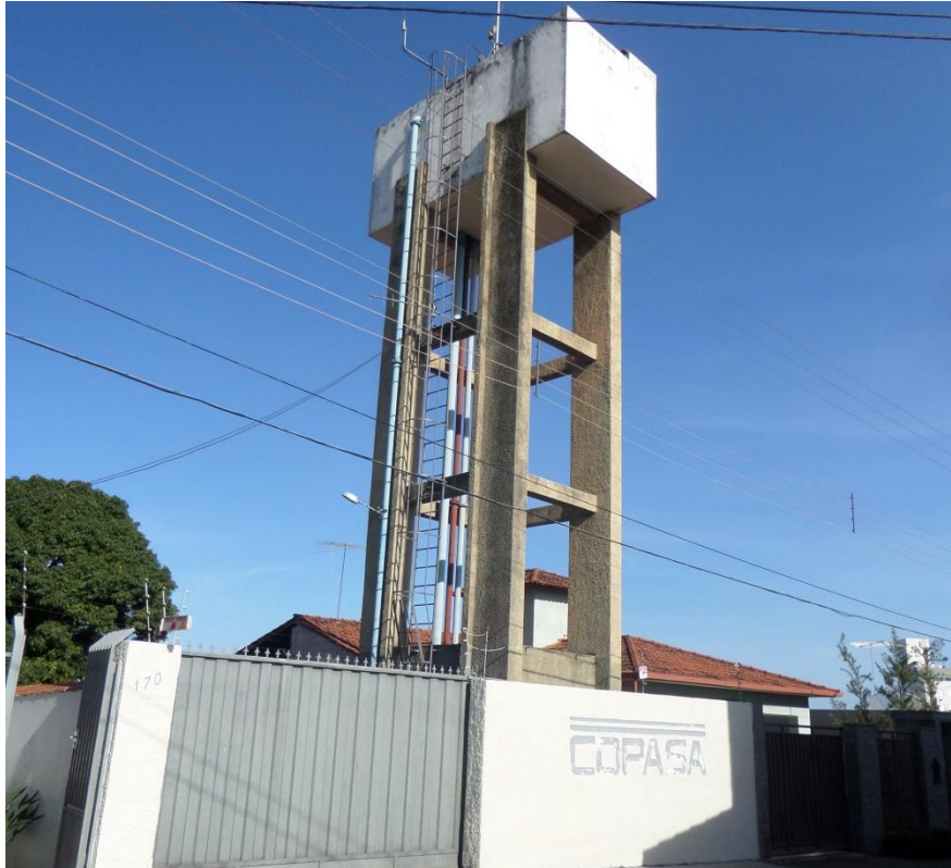
Figura 8.62 – Reservatório elevado (REL 3)
