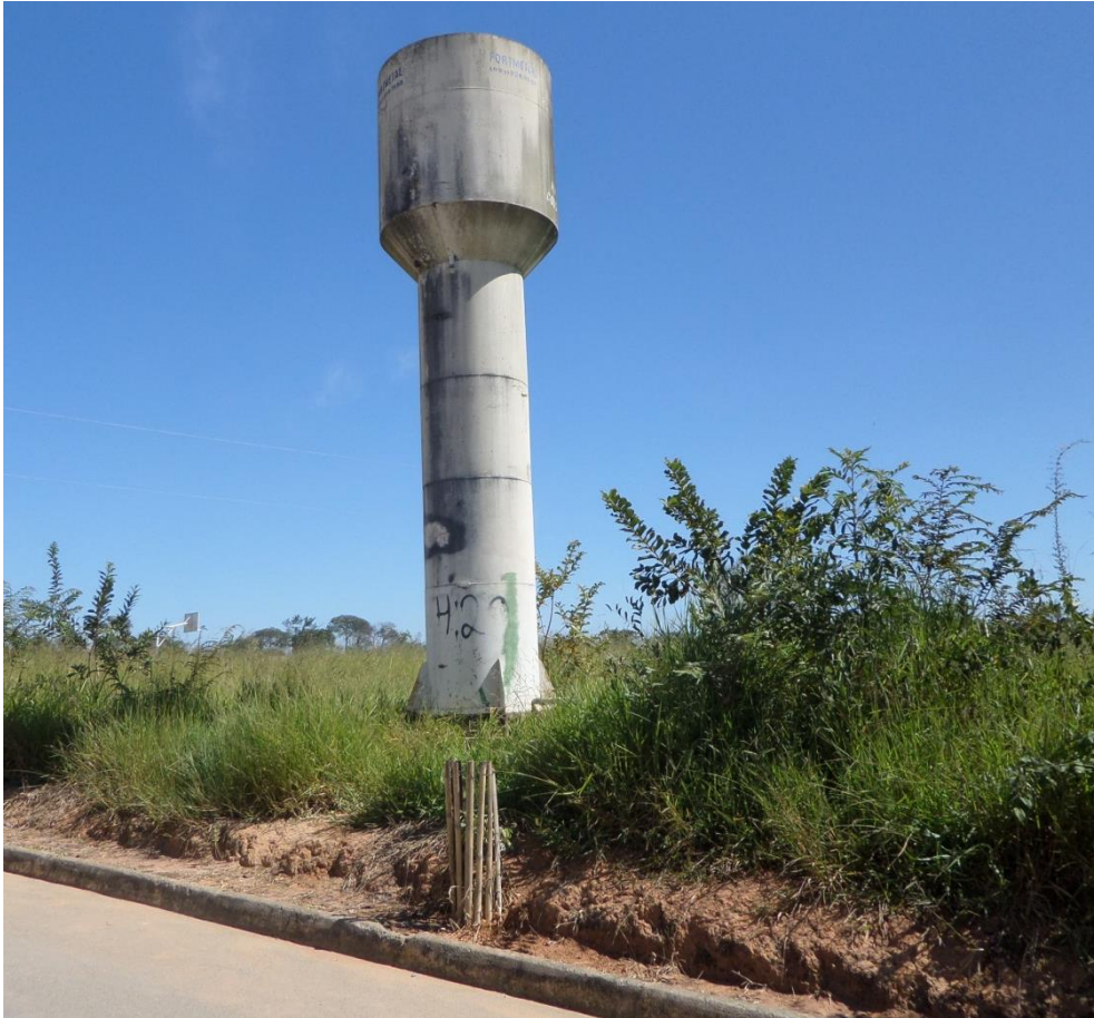
Figura 8.85 – Reservatório de Passagem
