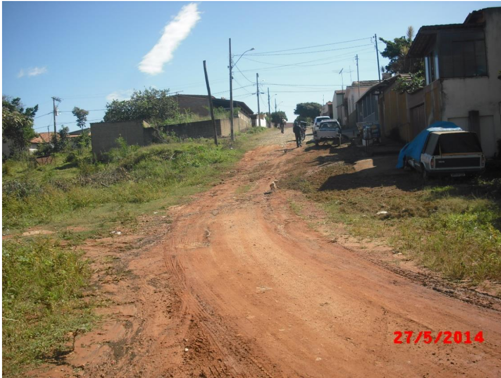
Ponto de enxurrada, Rua João Amador Pontes
