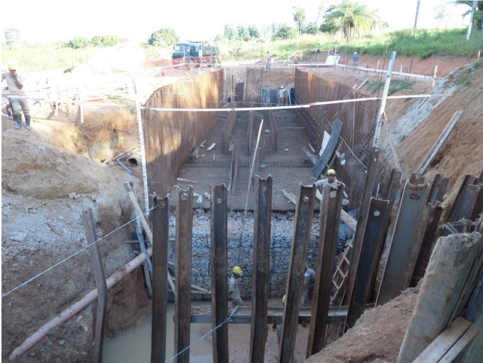
Figura 8.107 – Obras em execução das unidades de tratamento preliminar e do tanque de armazenamento
