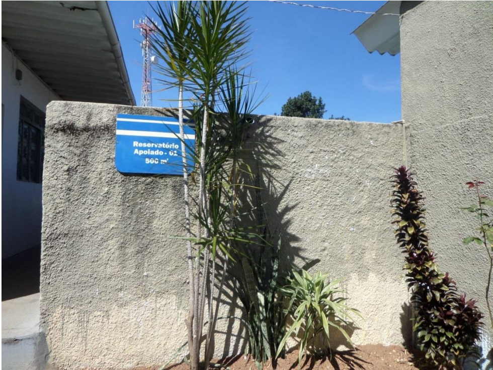
Figura 8.60 – Módulo 1 do Reservatório apoiado (RAP 1)
