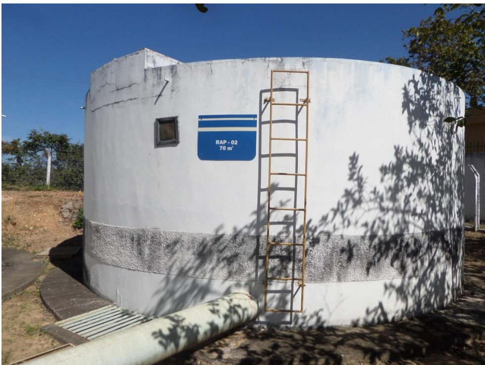
Figura 8.67 – Reservatório apoiado ETA (REL 2)
