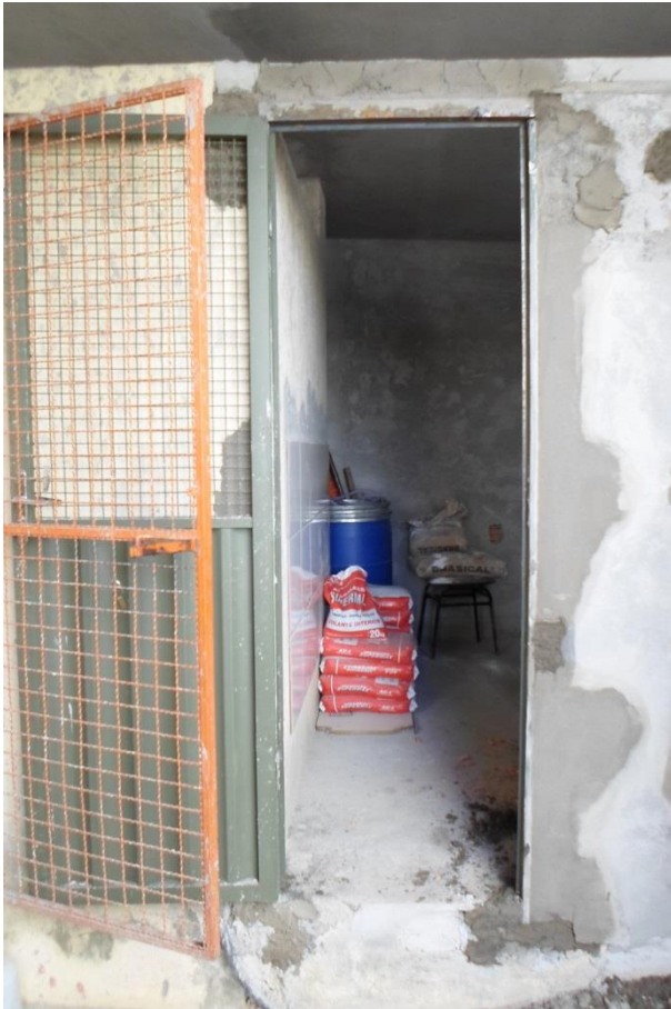
Figura 8.200 – Abrigo para armazenamento de resíduos –em construção–Centro de Especialidades Odontológicas
