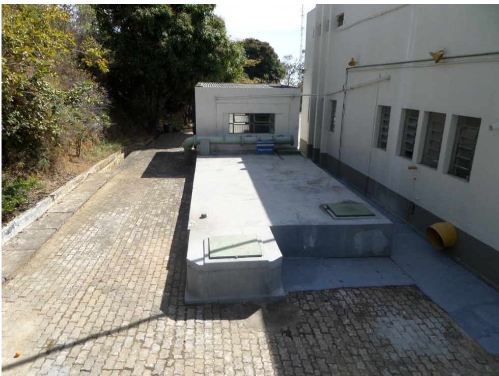
Figura 8.55 – Detalhe do tanque de contato da ETA
