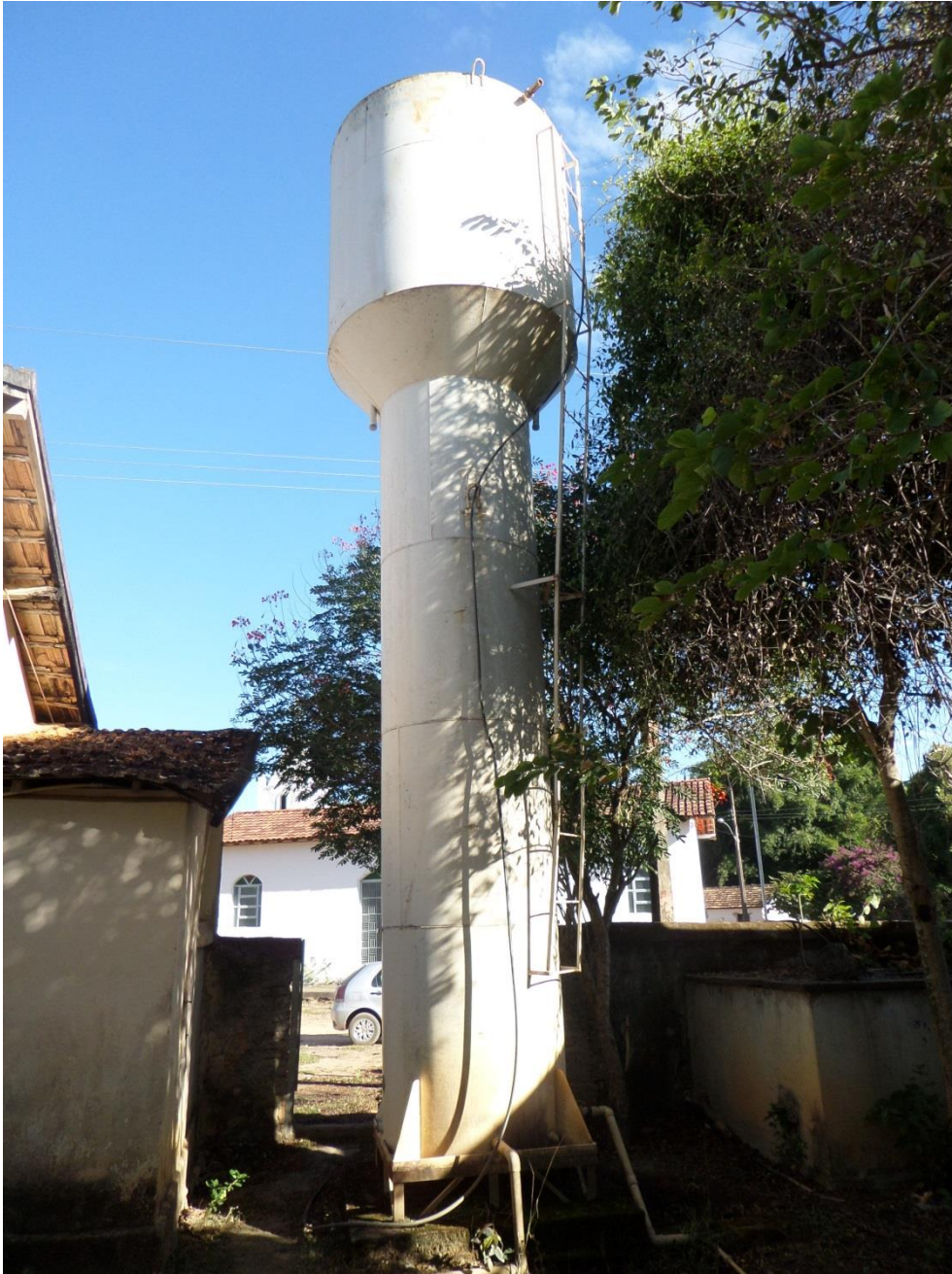
Figura 8.76 – Reservatório de Capivari do Macedo
