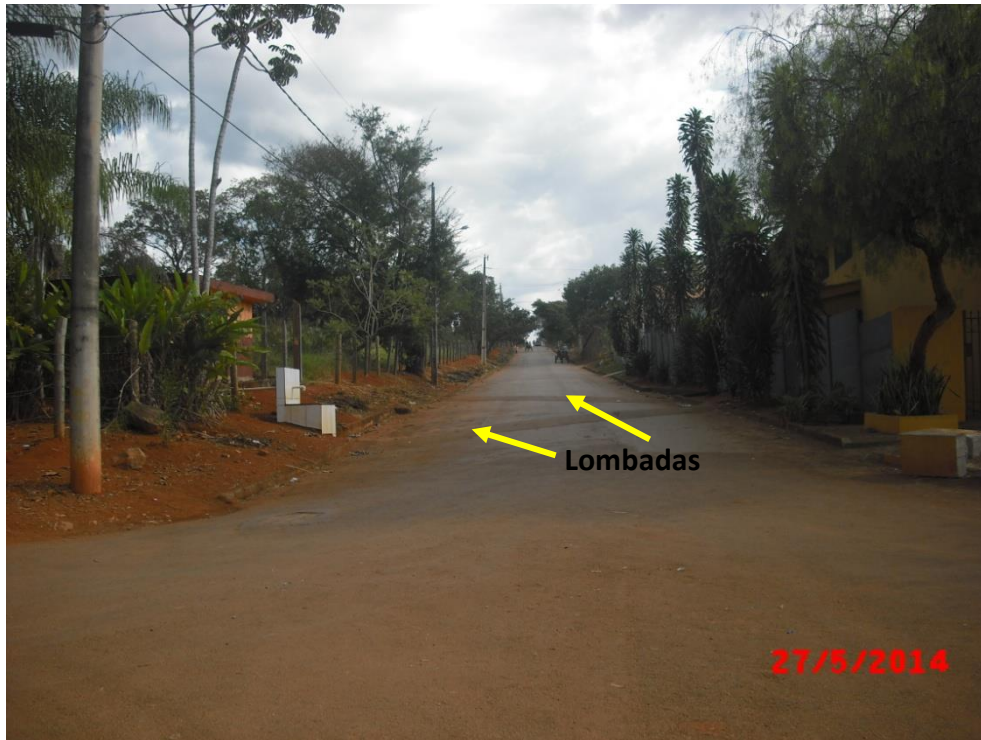
Ponto de enxurrada, Distrito Engenho do Ribeiro
