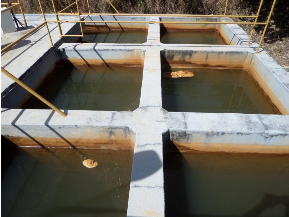
Figura 8.52 – Detalhe das câmaras do floculador da ETA
