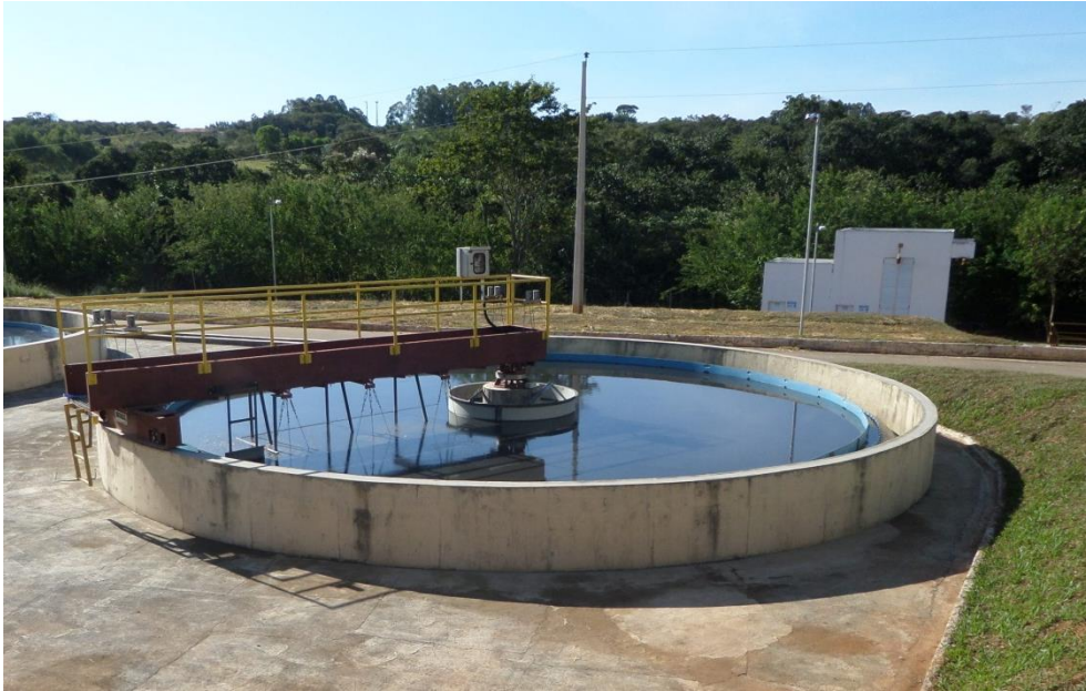
Figura 8.100 – Decantador secundário
