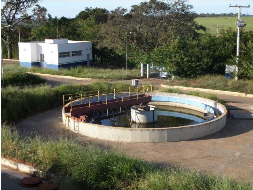
Figura 8.111 – Decantador secundário
