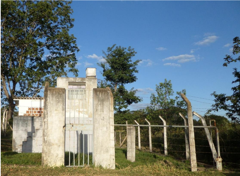
Figura 8.90 – Poço tubular de Mato Seco
