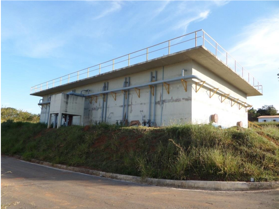
Figura 8.109 – Reatores UASB da ETE Matadouro
