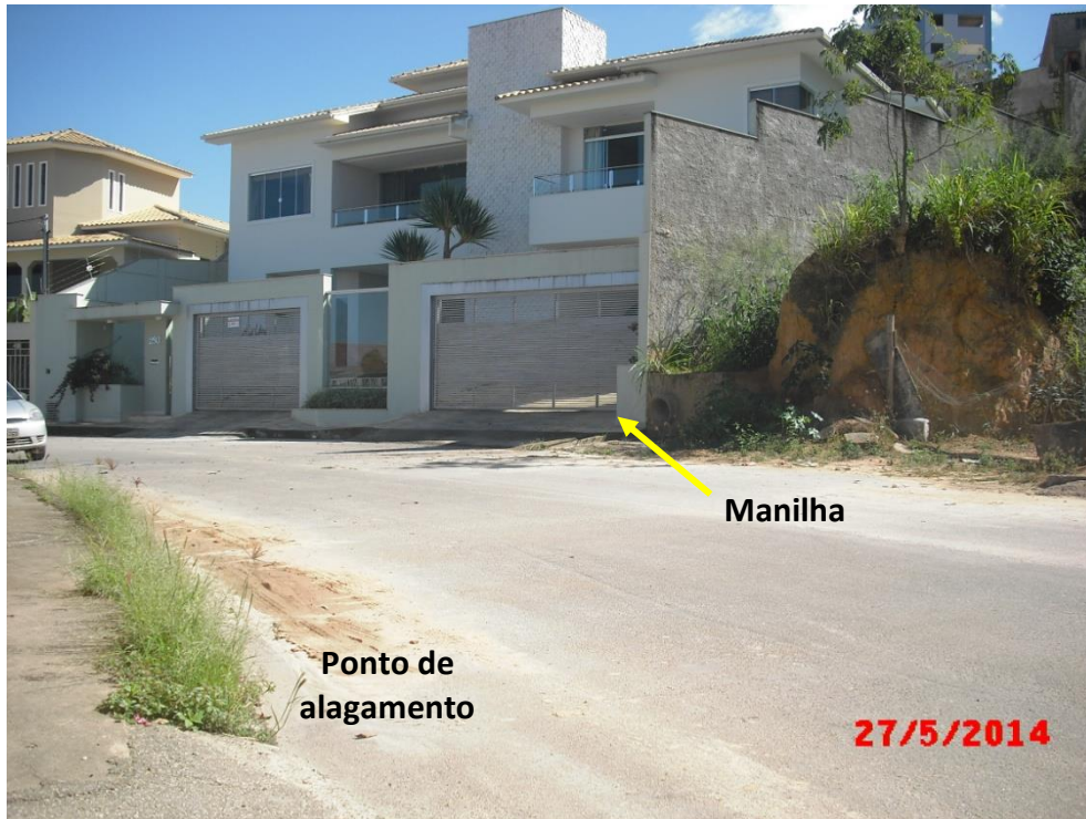
Ponto de alagamento, Rua Juca Rufino
