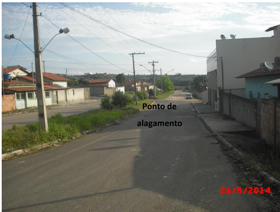
Ponto de alagamento, Avenida Hugo M. Gontijo FONTE: COBRAPE (2014)
