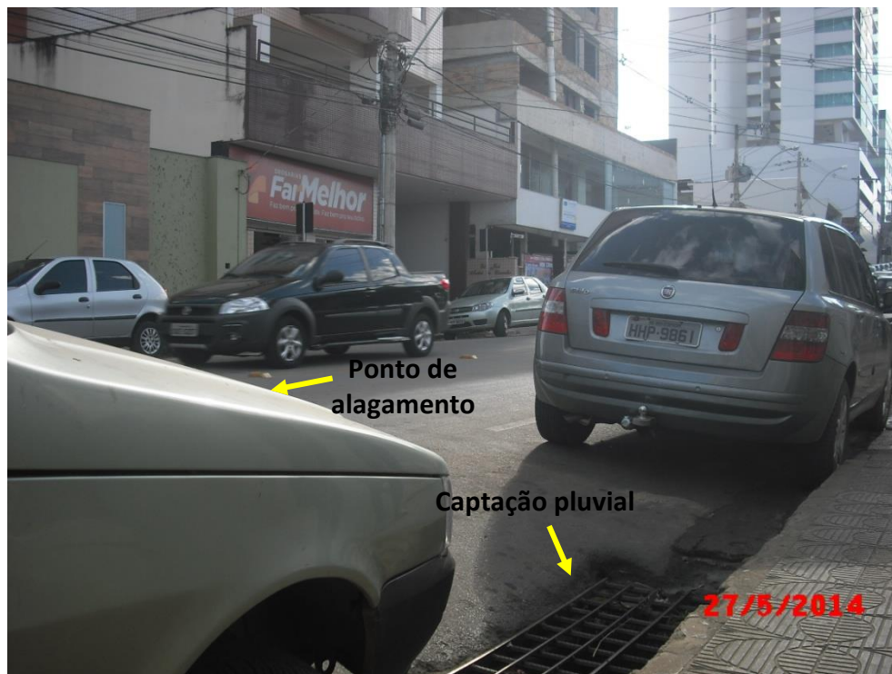
Ponto de alagamento, Rua Dr. José Gonçalves
