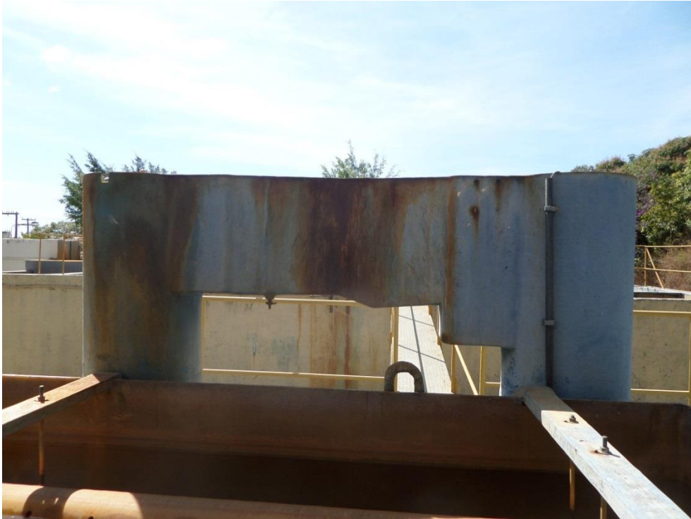
Figura 8.56 – Calha Parshall do módulo auxiliar da ETA
