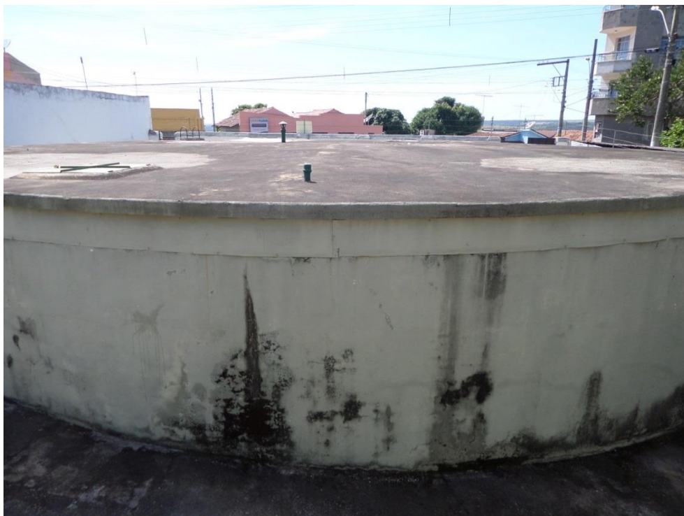
Figura 8.64 – Reservatório apoiado (RAP 2)
