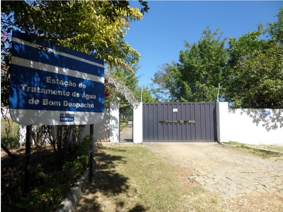
Figura 8.50 – Acesso a ETA Bom Despacho
