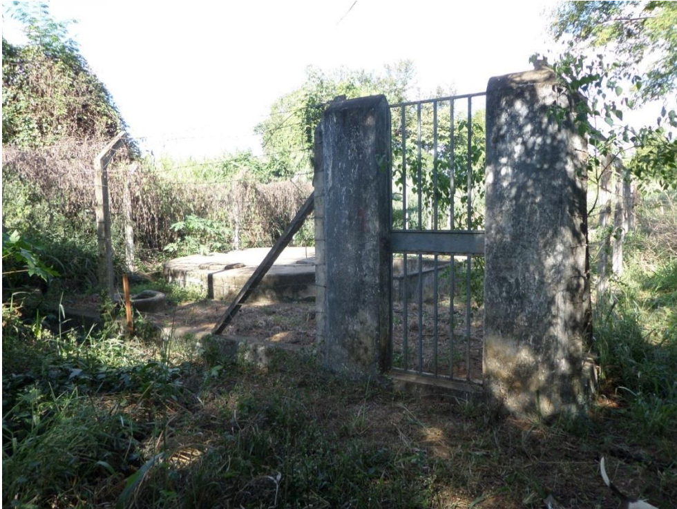
Figura 8.125 – Entrada da ETE Engenho do Ribeiro I
