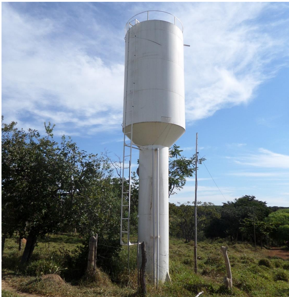
Figura 8.88 – Reservatório de Vilaça
