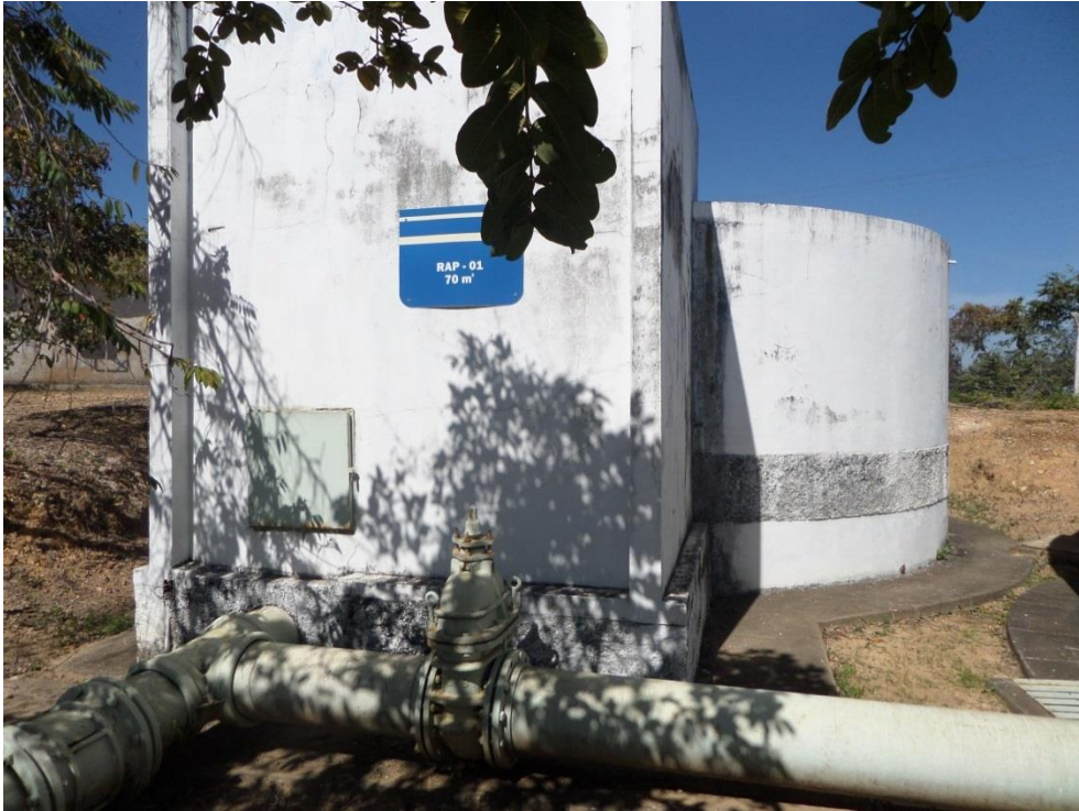
Figura 8.66 – Reservatório Apoiado ETA (REL 1)
