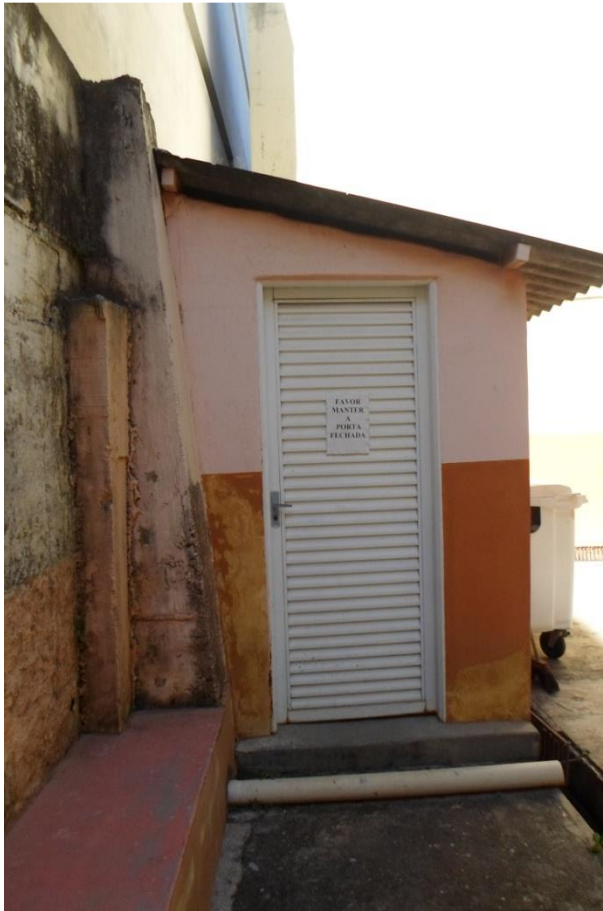
Figura 8.198 – Abrigo para armazenamento de resíduos – Policlínica Dr. Gê
