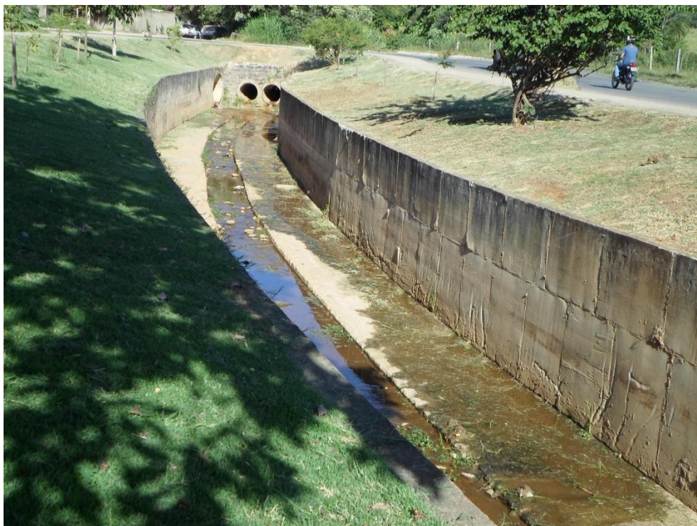
Figura 8.12 – Ribeirão dos Machados – Trecho canalizado na Sede do município de Bom Despacho
