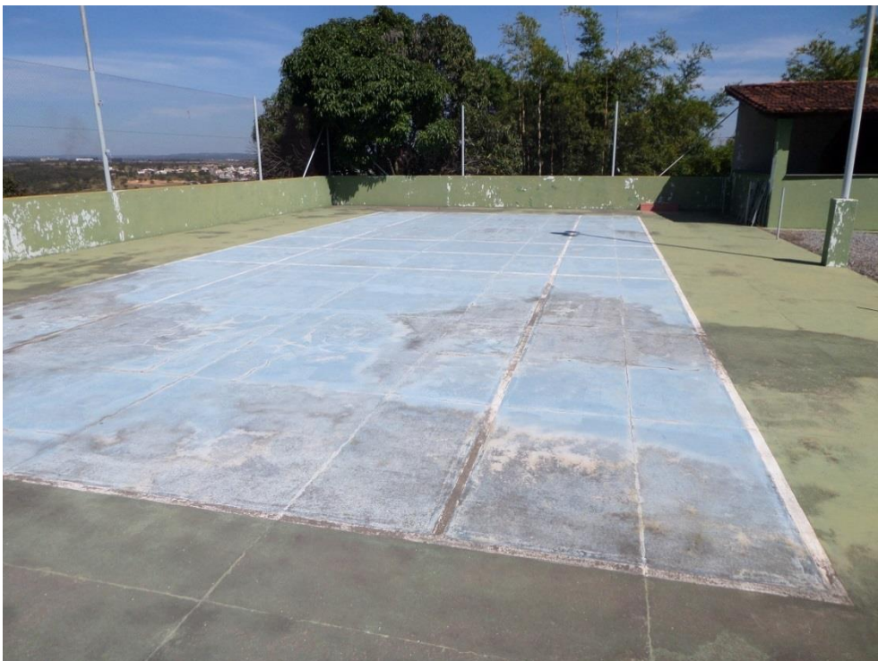
Figura 8.61 – Área de convivência sobre o Módulo 1B do Reservatório apoiado (RAP 1)
