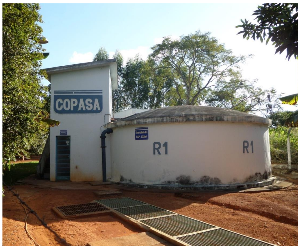
Figura 8.71 – Casa de química ao lado do reservatório (RAP 1) do distrito de Engenho do Ribeiro
