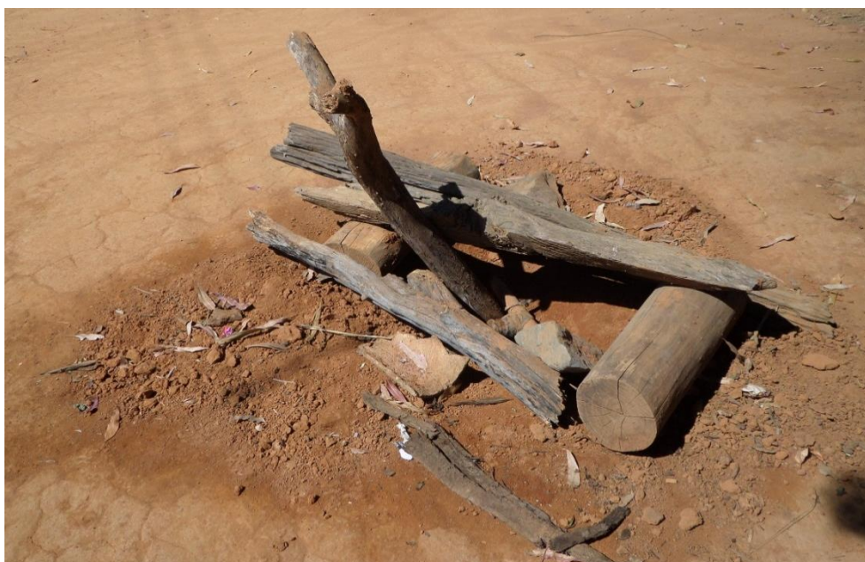
Figura 8.83 – Detalhe do ponto de rompimento da rede em Garça Fonte: COBRAPE (2014)
