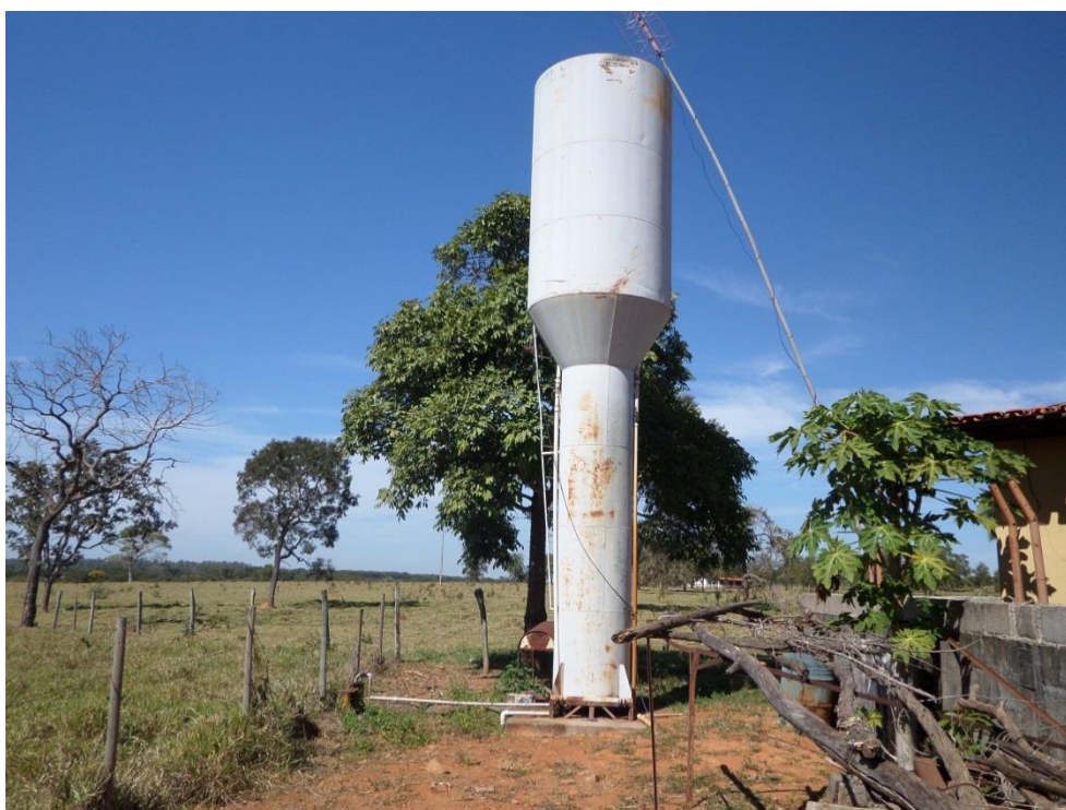
Figura 8.82 – Reservatório de Garça
