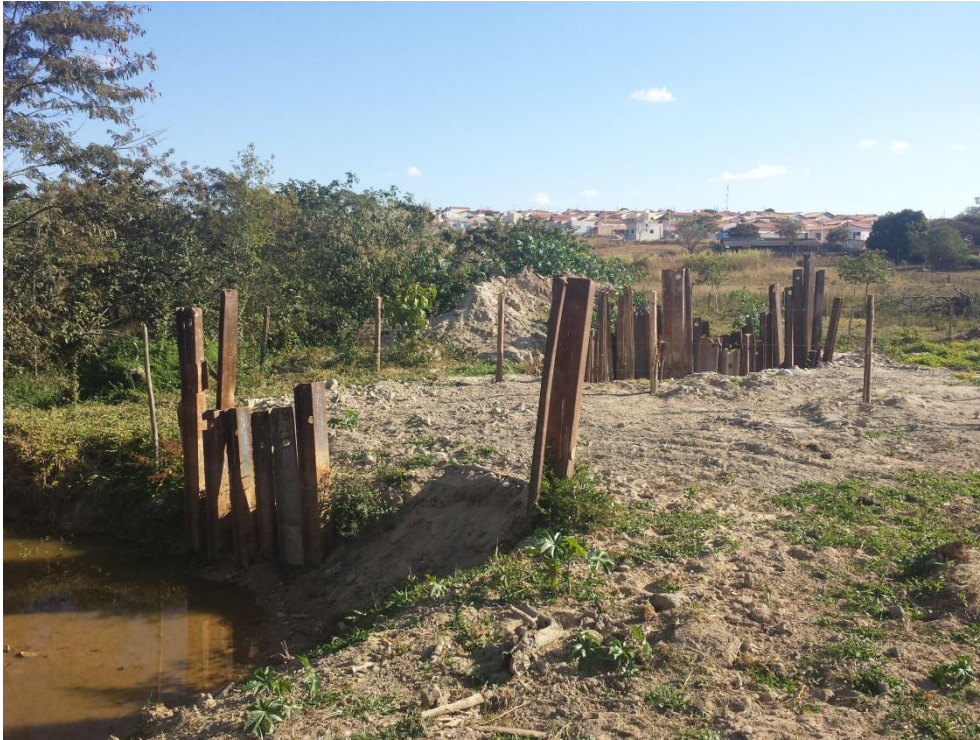
Figura 8.118 – Local da futura estação elevatória de esgotos em Bom Despacho
