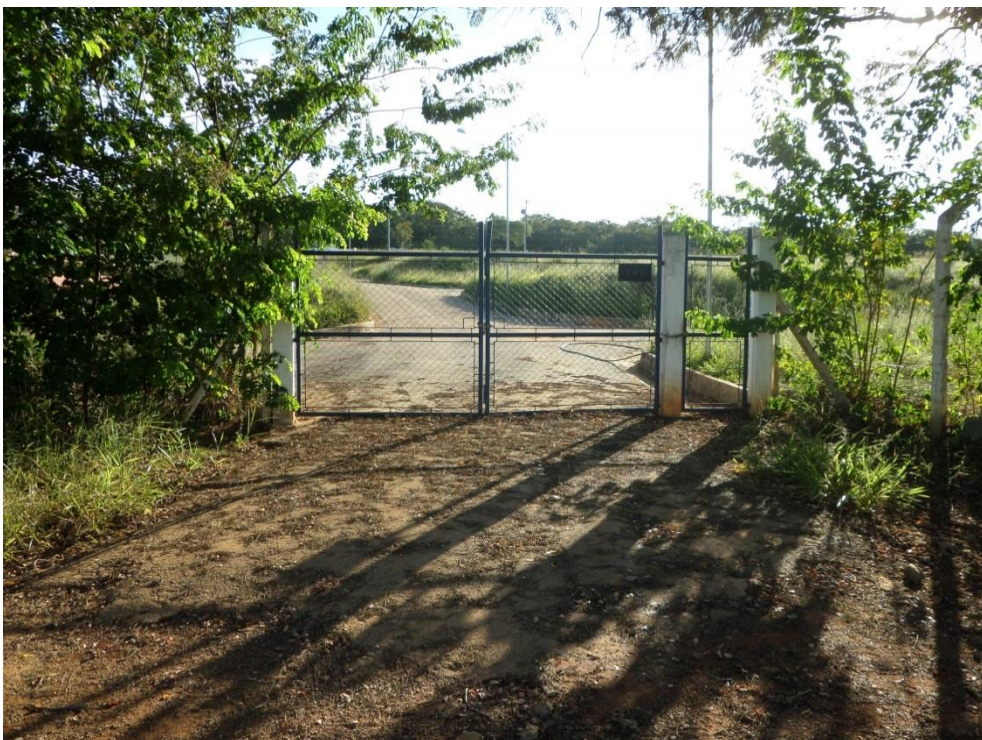
Figura 8.108 – Portão de acesso da ETE Chácara
