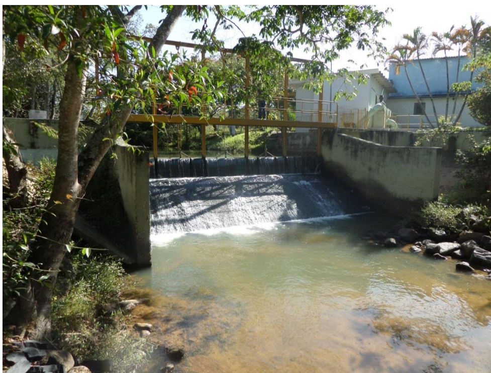
Figura 8.48 – Barragem para captação da água no rio Capivari
