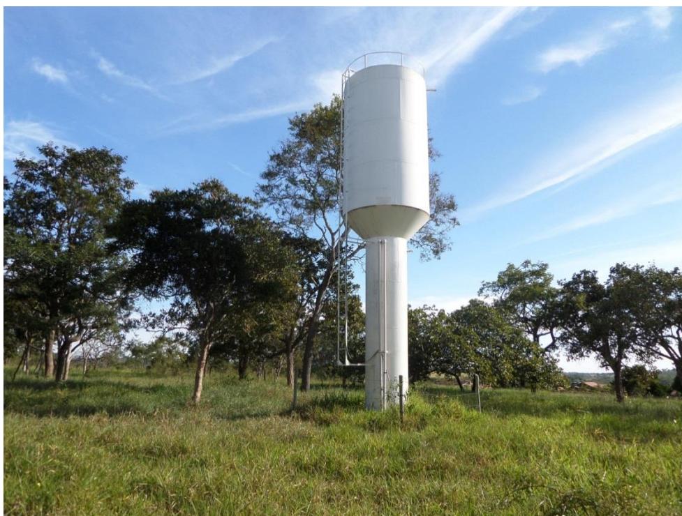
Figura 8.80 – Reservatório de Córrego Areado
