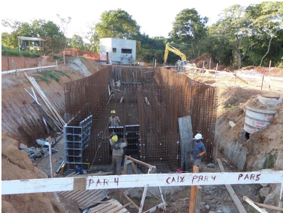
Figura 8.106 – Obras em execução das unidades de tratamento preliminar
