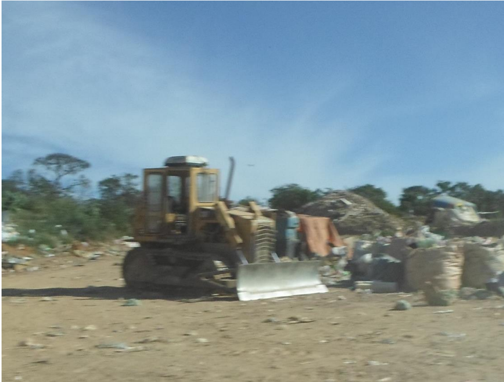
Figura 8.214 – Trator esteira que realiza a compactação e recobrimento dos resíduos no lixão
