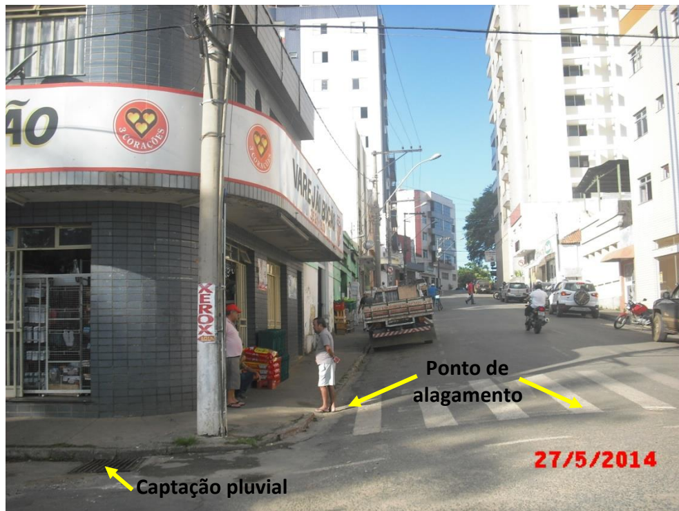
Ponto de alagamento, intersecção da Rua São Vicente com a Rua Marechal Floriano Peixoto
