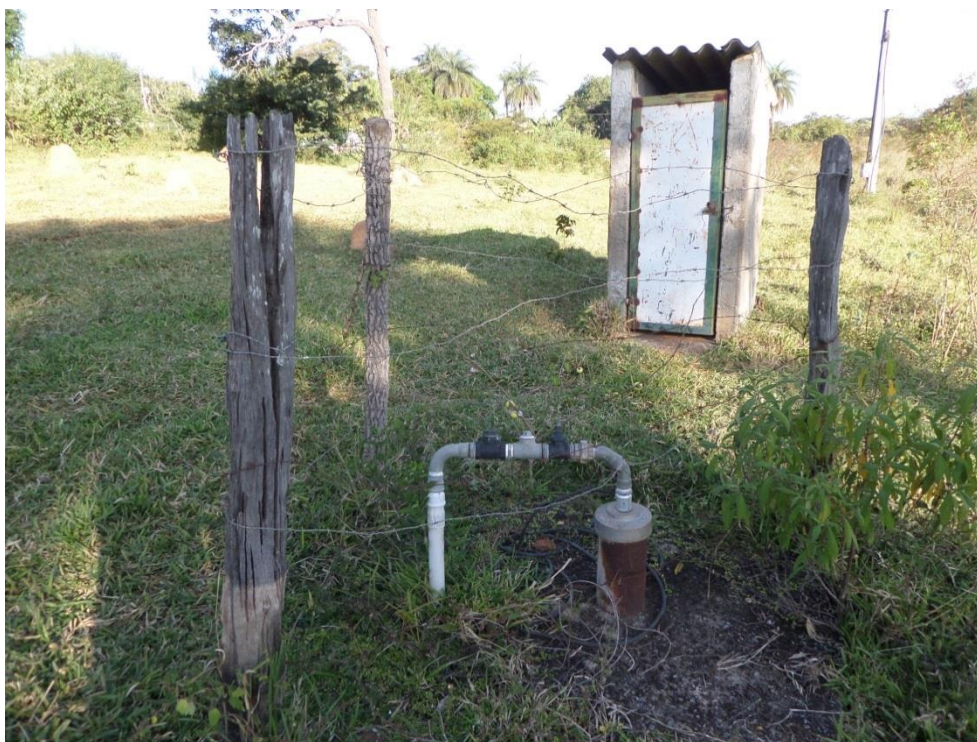
Figura 8.77 – Poço tubular de Capivari do Marçal
