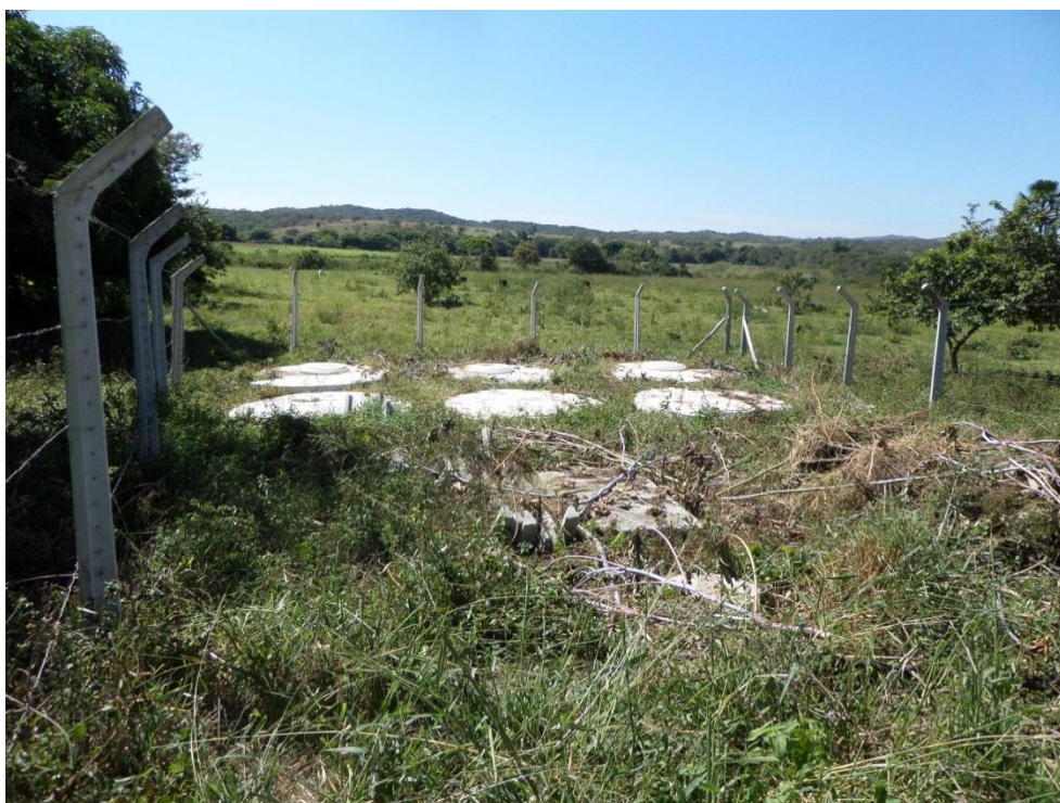
Figura 8.142 – Vista geral da ETE Passagem
