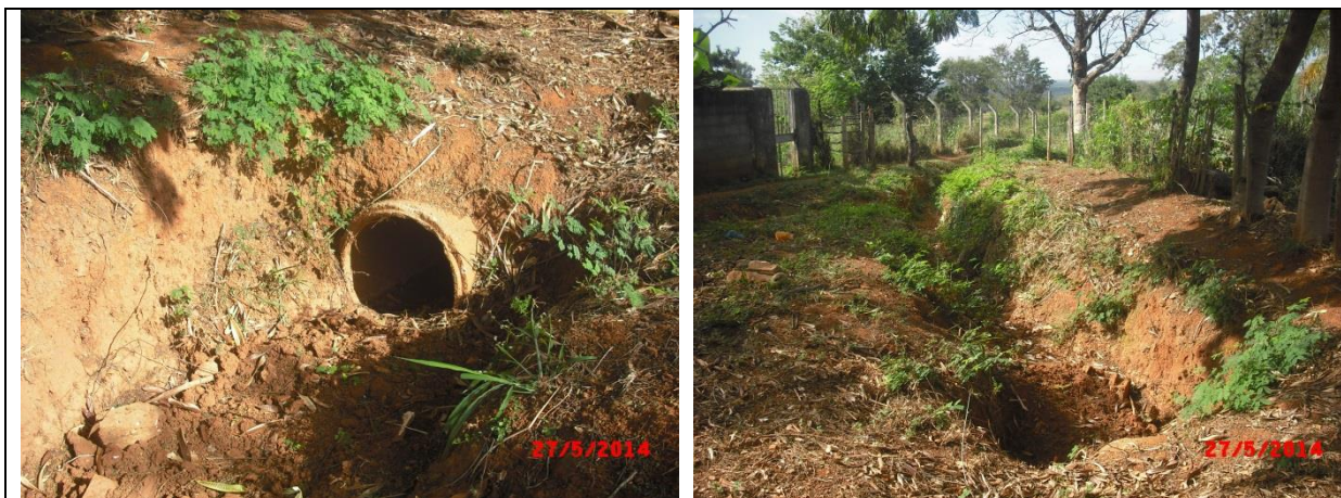
Figura 8.229 – Abertura de vala para direcionamento das águas pluviais para o córrego Descarga, afluente do rio do Picão – Engenho do Ribeiro
