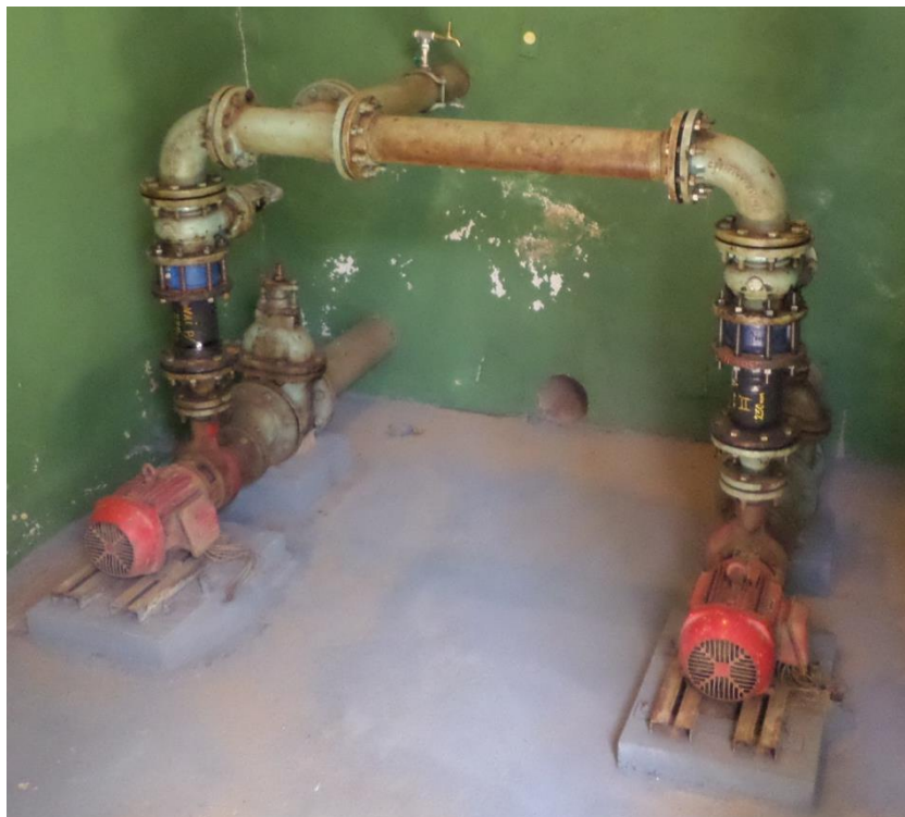
Figura 8.63 – Reservatório elevado (REL 3)
