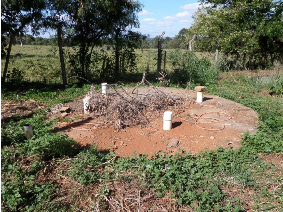
Figura 8.130 – Filtro anaeróbio da ETE Engenho do Ribeiro II
