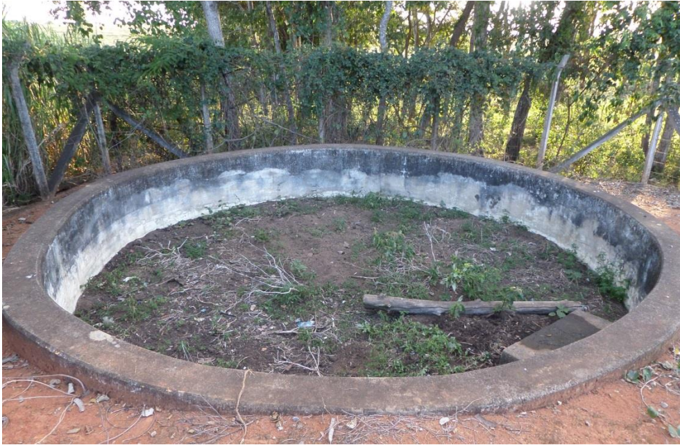
Figura 8.147 – Leito de secagem da ETE Mato Seco
