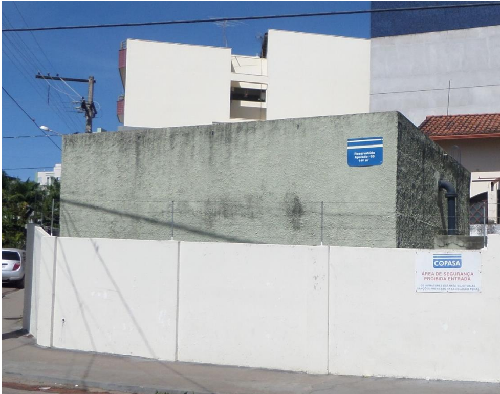
Figura 8.65 – Reservatório apoiado (RAP 3)
