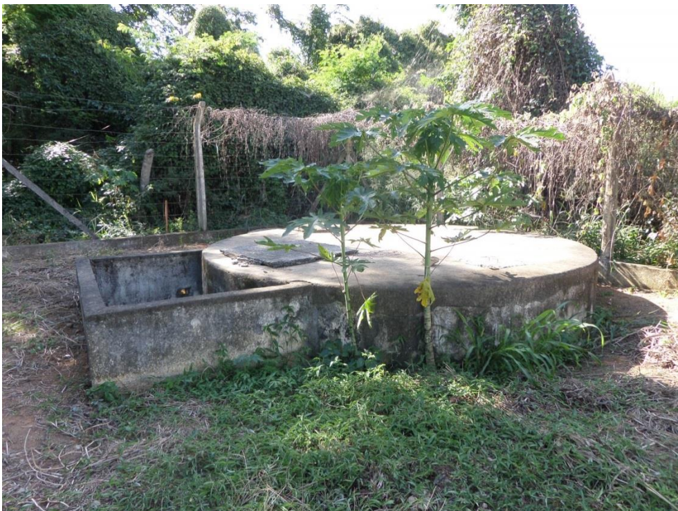
Figura 8.121 – Tanque séptico da ETE Engenho do Ribeiro I
