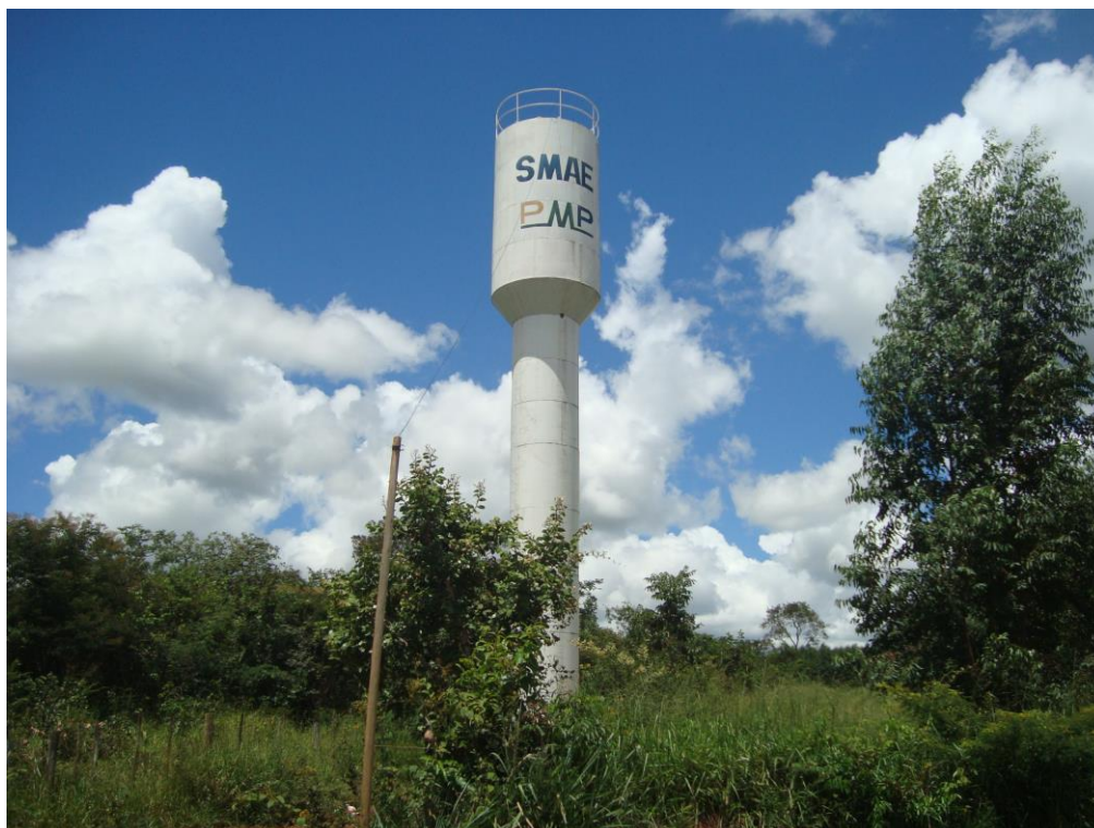
Figura 5.5 – Reservatório de água em Papagaios
