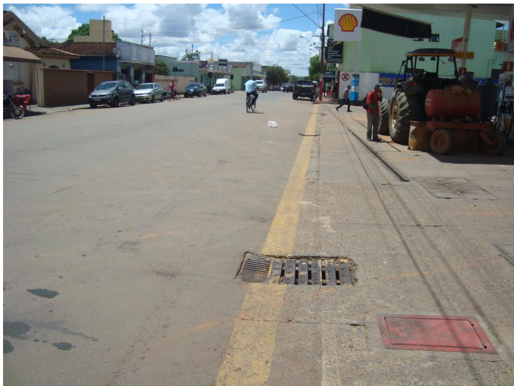
Figura 5.10 – Estrutura de Drenagem em Papagaios
