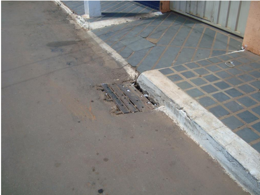
Figura 5.7 – Estrutura de Drenagem em Papagaios
