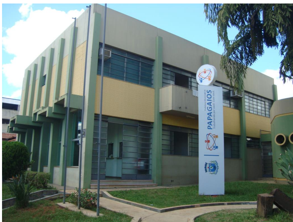
Figura 5.4 – Sede da Diretoria de Água e Esgoto de Papagaios
