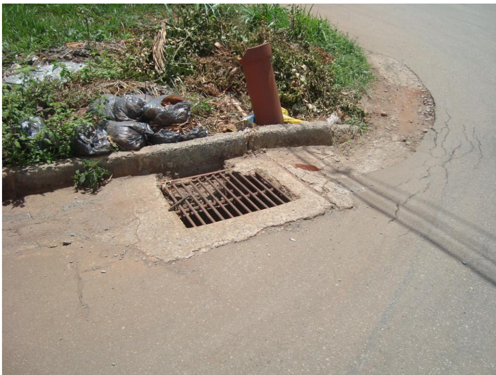
Figura 5.8 – Estrutura de Drenagem em Papagaios
