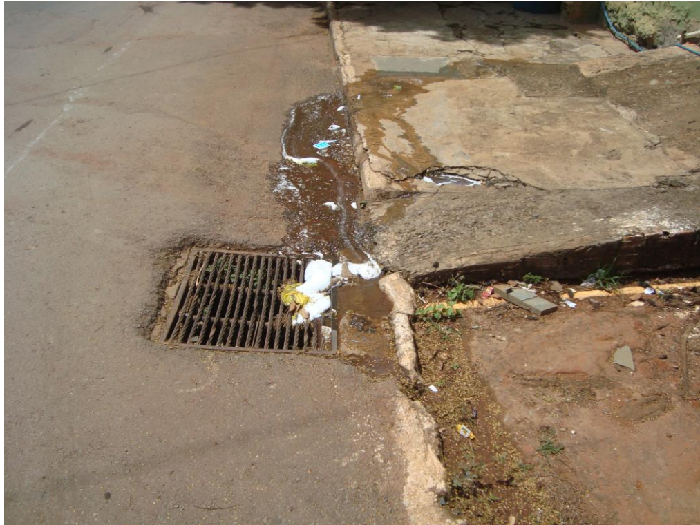
Figura 5.9 – Estrutura de Drenagem em Papagaios
