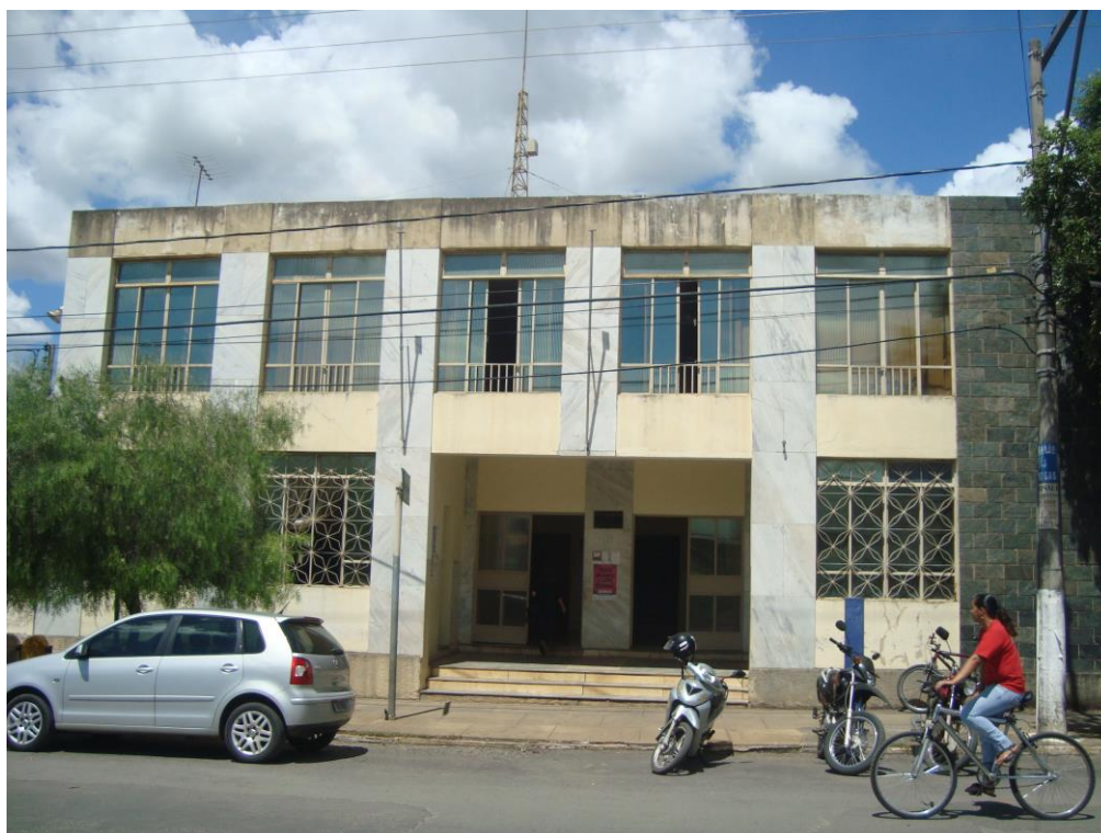
Figura 5.5 – Instalações da Prefeitura Municipal de Lagoa da Prata
