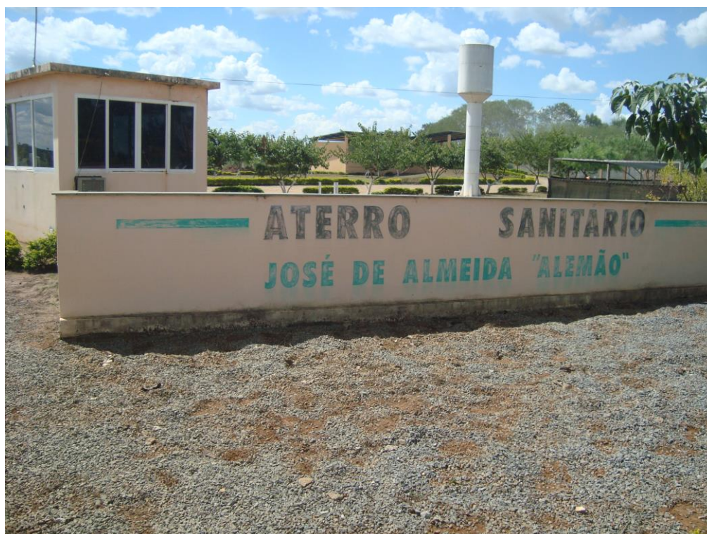
Figura 5.9 – Entrada do Aterro Sanitário de Lagoa da Prata
