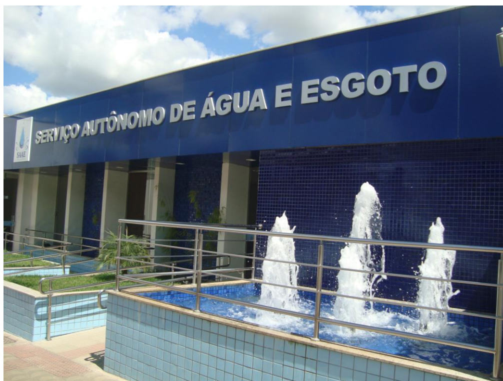
Figura 5.6 – Instalações do SAAE de Lagoa da Prata
