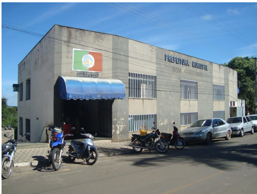
Figura 5.3 – Instalações da Prefeitura Municipal de Bom Despacho
