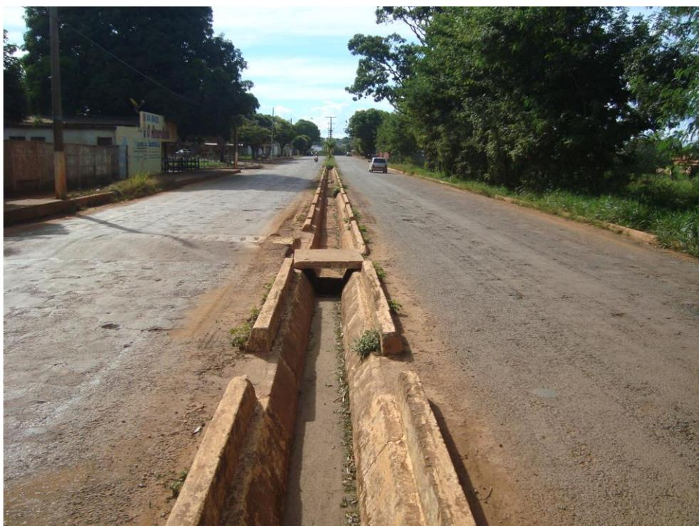
**Figura 5.9 – Coletor central de água pluvial em Abaeté**
