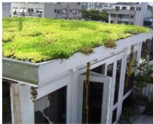
Figura 89: Exemplo de telhado verde
