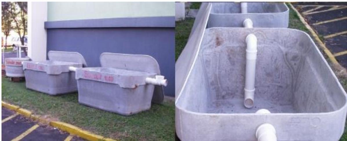
Figura 65: Biodigestor montado: vista lateral e vista superior.
