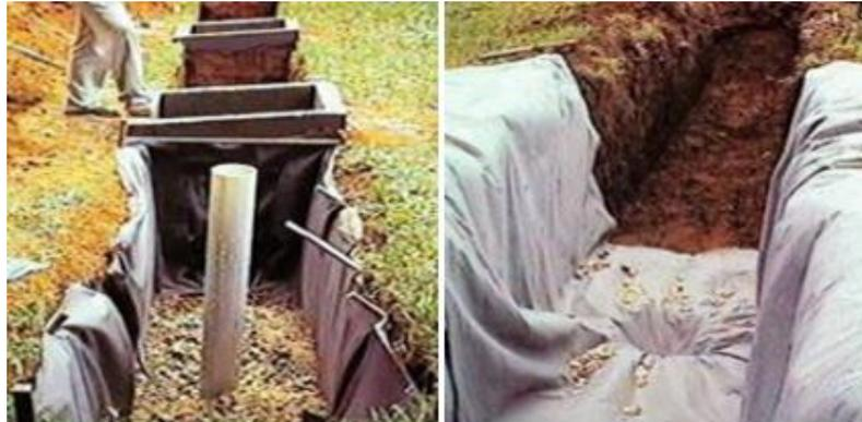
Figura 80: Exemplos de trincheira de infiltração
