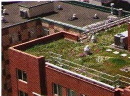
Figura 88: Telhado reservatório / telhado verde
