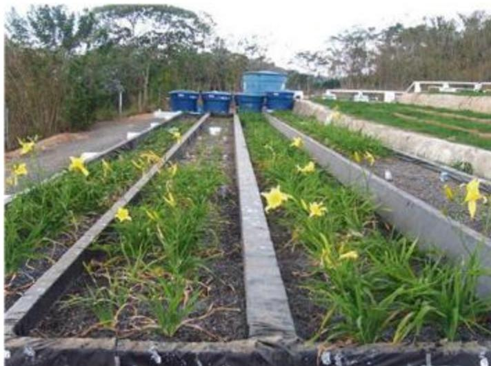
Figura 62: Tratamento de esgoto sanitário em sistemas alagados construídos cultivados com lírio amarelo
