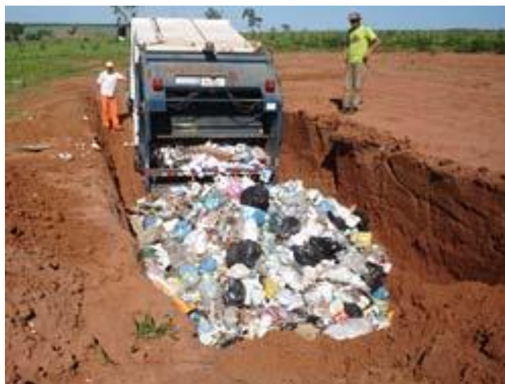
Figura 250: Aterro controlado Fonte: Gesois, 2014.
