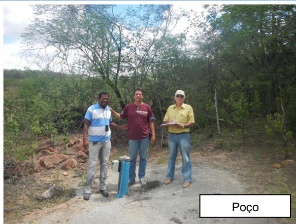
Figura 153: Unidade de captação subterrânea do SAA Nazaré.
