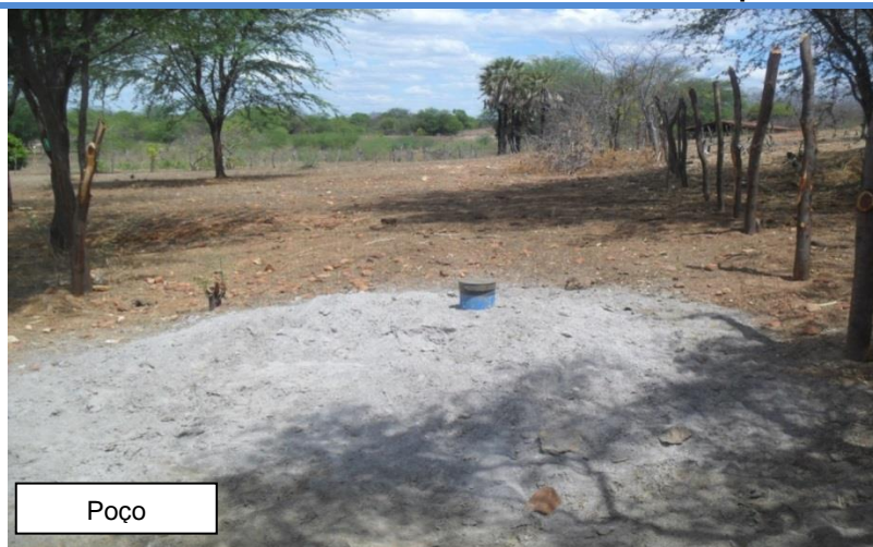
Figura 152: Poço artesiano do SAA Jati. Fonte: Gesois, 2015.
