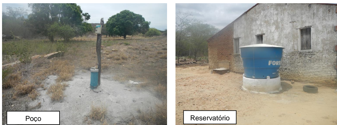
Figura 143: Poço e Reservatório em Fundões.
