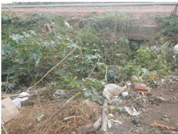
Figura 262: Dispositivos de Drenagem Obstruídas
