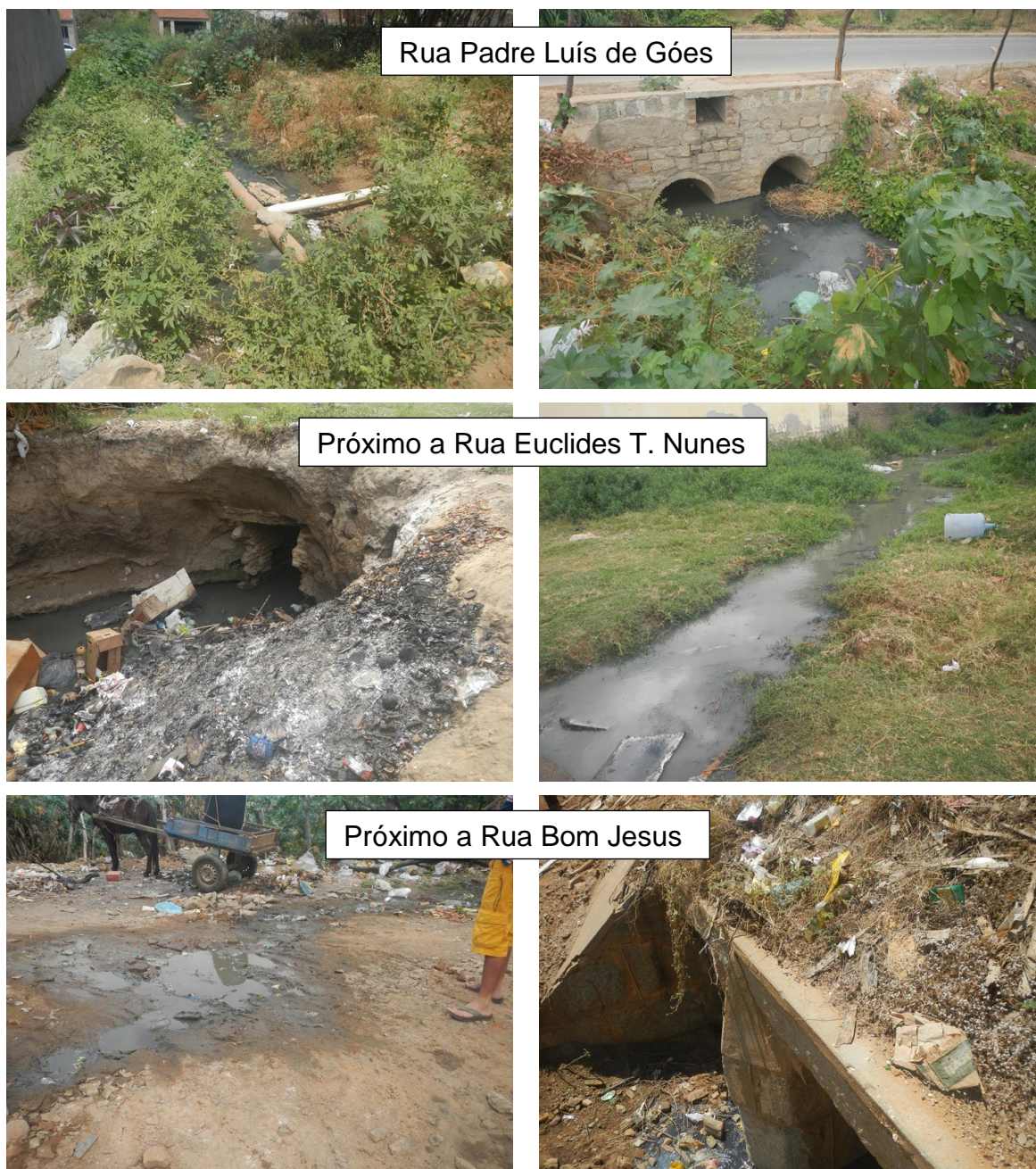
Figura 230: Esgoto a céu aberto na cidade de Afogados da Ingazeira – Parte 02/02.
