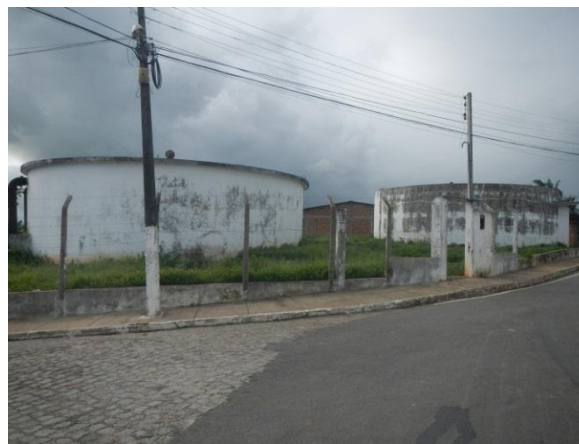
Figura 8: Reservatório Fonte: Gesois, 2014
