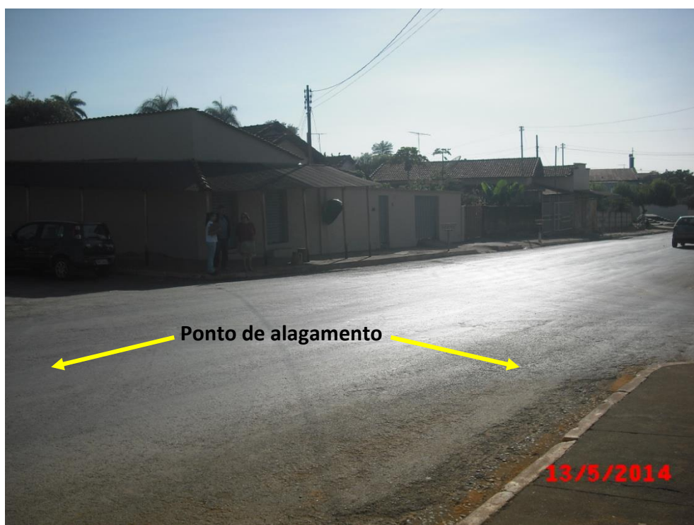
Intersecção da Avenida Joaquina de Pompéu com a Rua Deusdedit Alves de Souza
