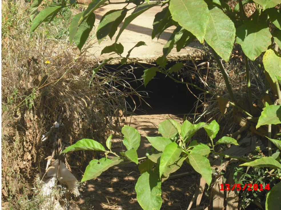
Figura 8.190 – Galeria de águas pluviais - GAP existente, Rua Antônio Amador
