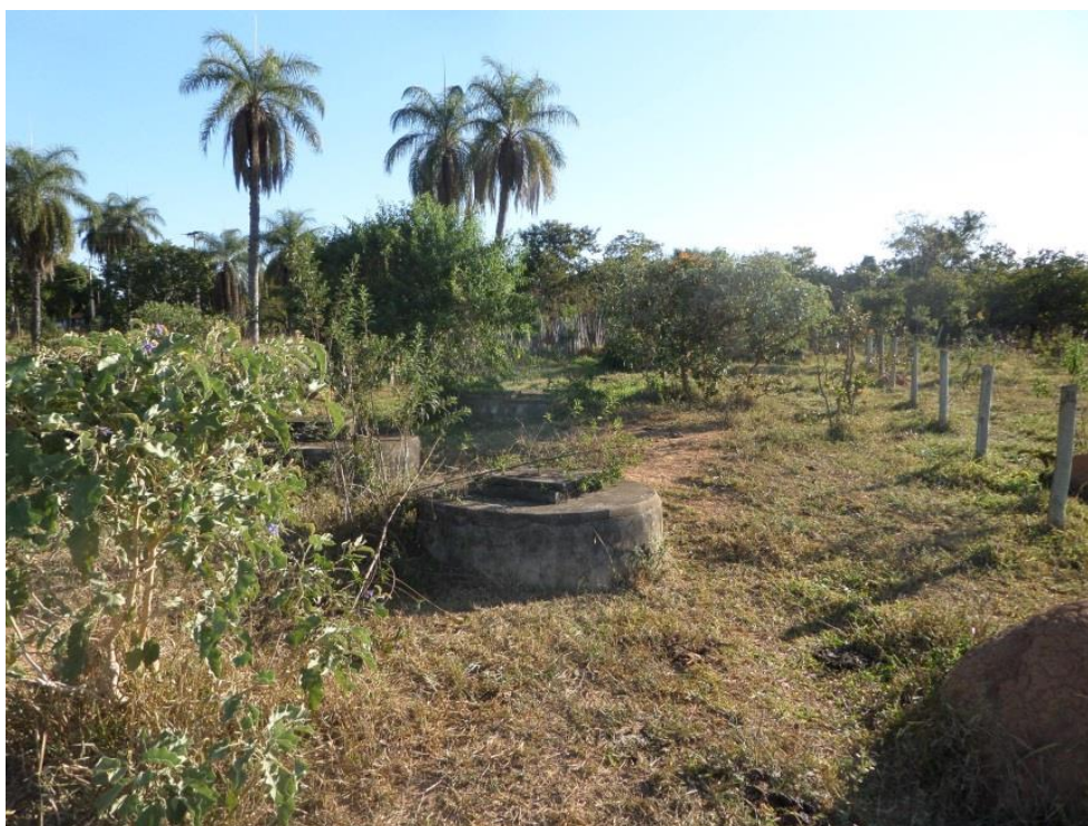
Figura 8.102 – Vista geral da ETE Veredas
