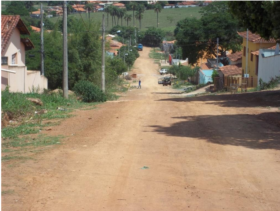
Figura 8.33 – Estrada de Terra, rua Antônio Manuel de Sousa, Abaeté.
