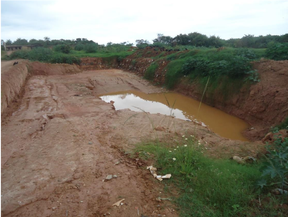
Figura 8.167 – Vala para disposição de RSD
