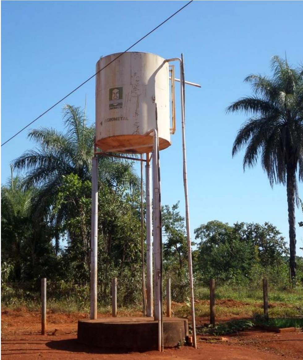
Figura 8.64 – Reservatório de Lagoa de Santa Maria
