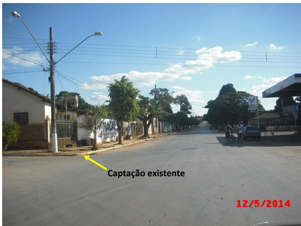
Ponto de Alagamento na Rua Joaquina do Pompéu
