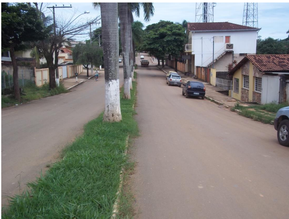
Figura 8.34 – Asfaltamento da área central do município, Avenida Doutor Guido.
