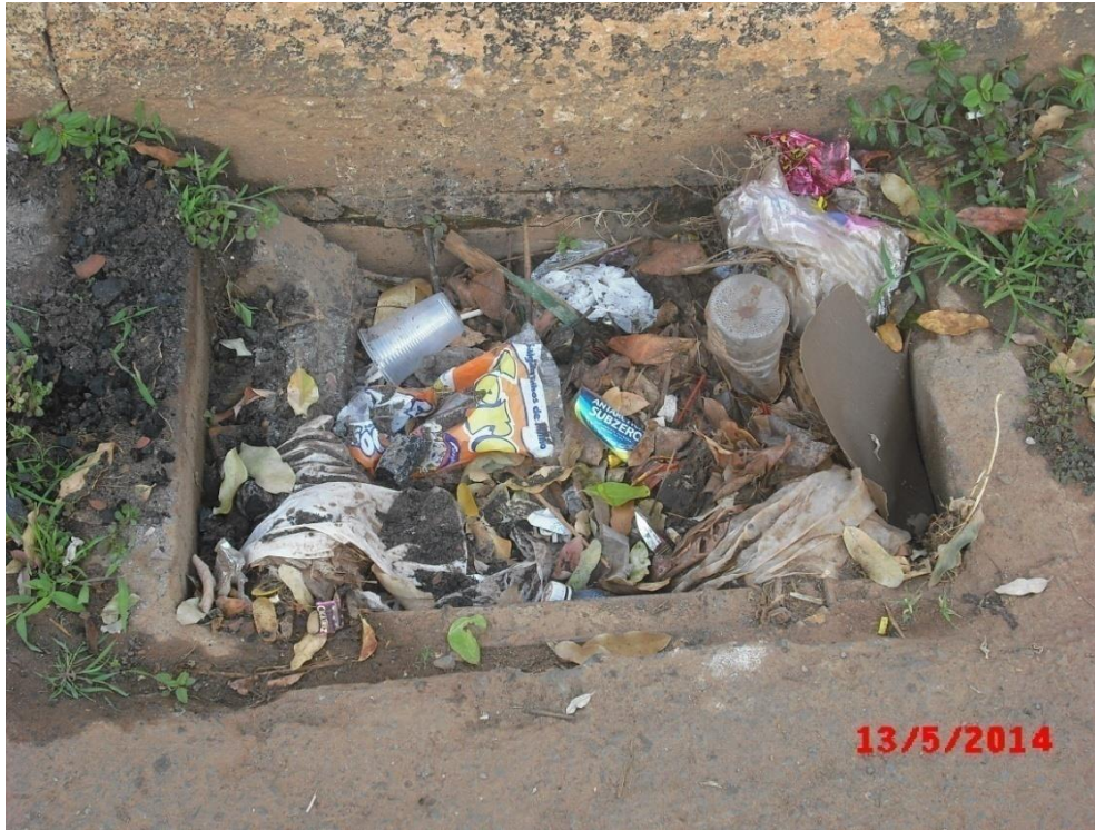
Captação existente da Rua Deusdedit Alves de Souza
