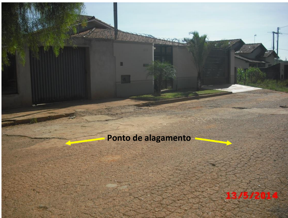
Ponto de Alagamento na Rua Antônio Amador
