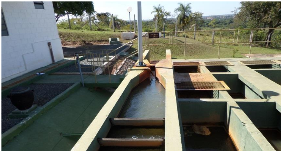
Figura 8.47 – Vista da calha Parshall da ETA
