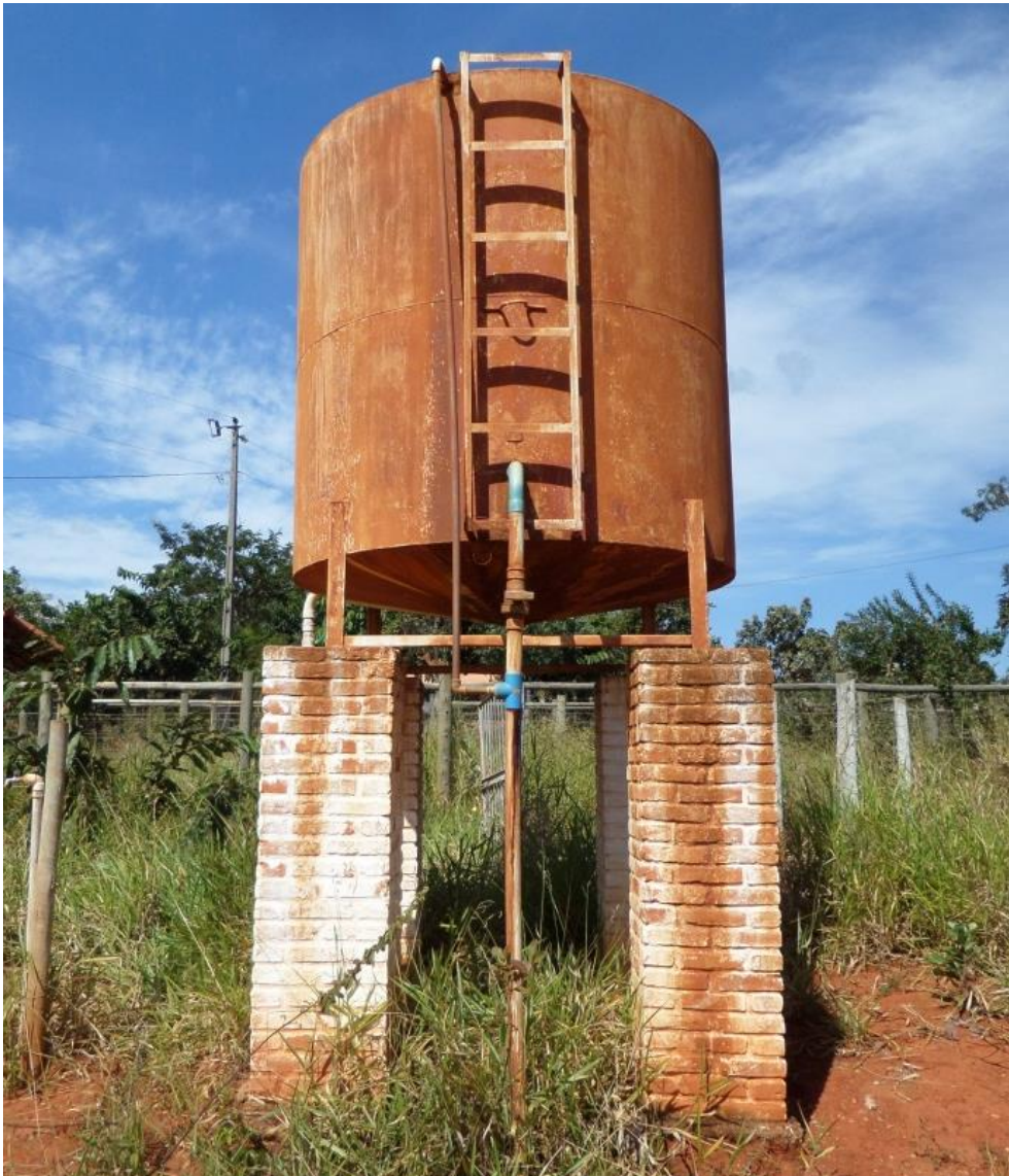
Figura 8.77 – Reservatório 1 de Tabocas
