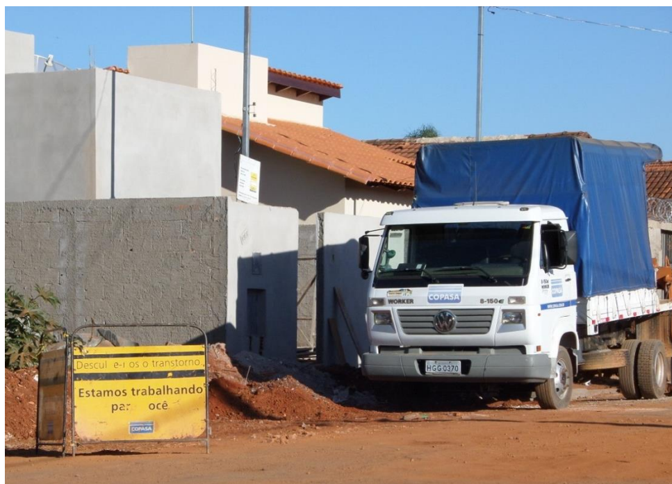
Figura 8.54 – Obra de reparação da rede de água
