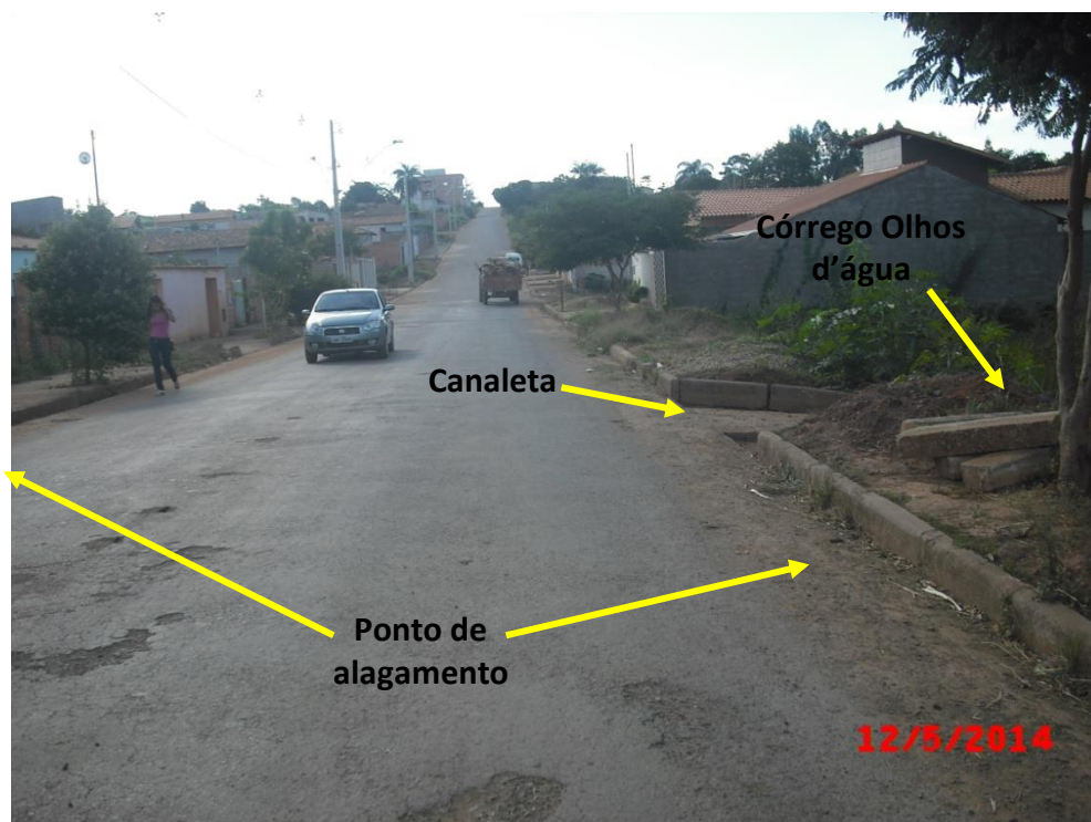
Ponto de Alagamento na Rua Antônio José Pereira
