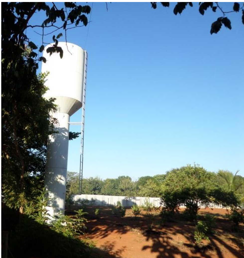
Figura 8.80 – Reservatório de Veredas
