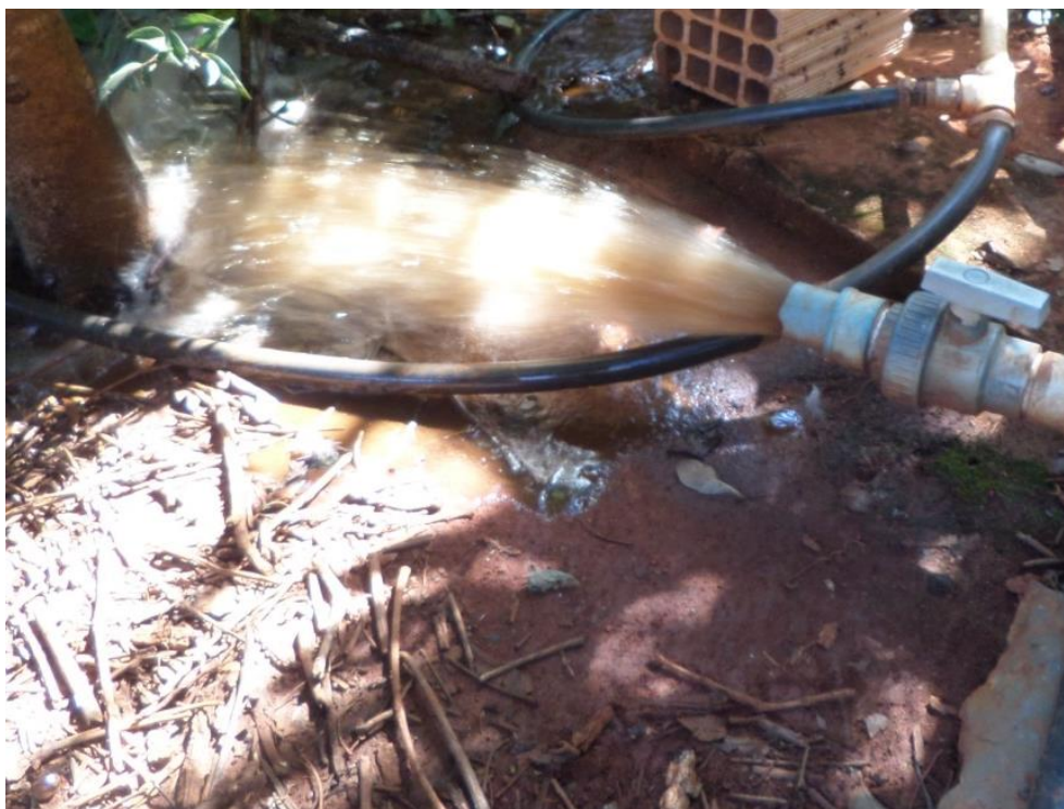
Figura 8.75 – Detalhe da água distribuída na localidade
