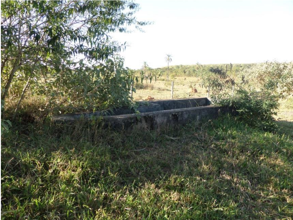
Figura 8.103 – Detalhe do desanador da ETE Veredas
