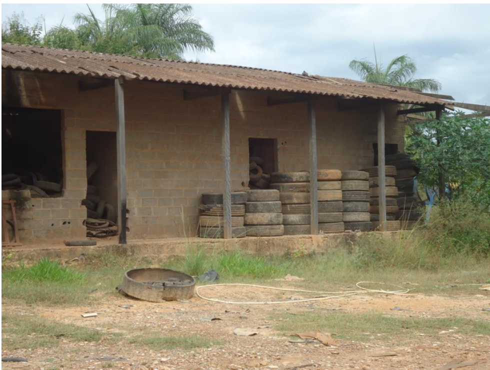
Figura 8.155 – Área de armazenamento de pneus inservíveis
