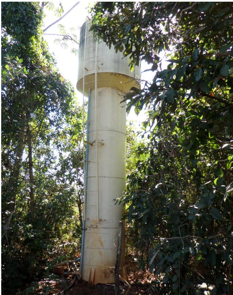
Figura 8.78 – Reservatório 1 de Tabocas
