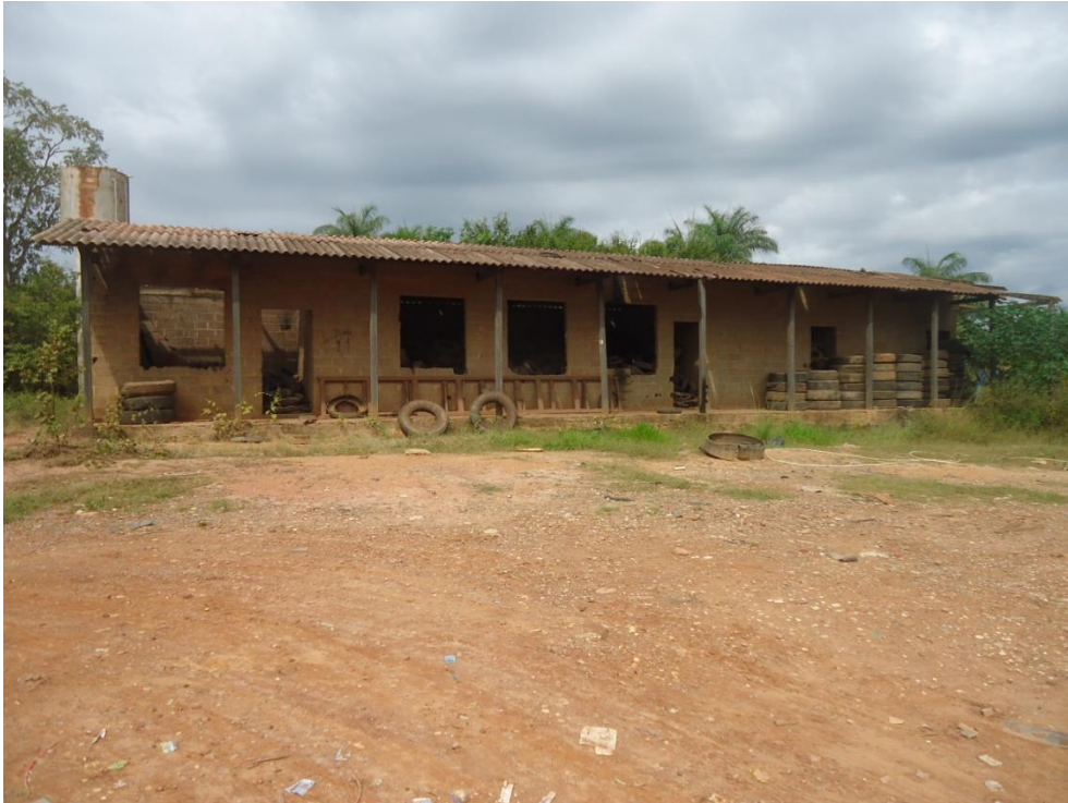
Figura 8.154 – Área de armazenamento de pneus inservíveis
