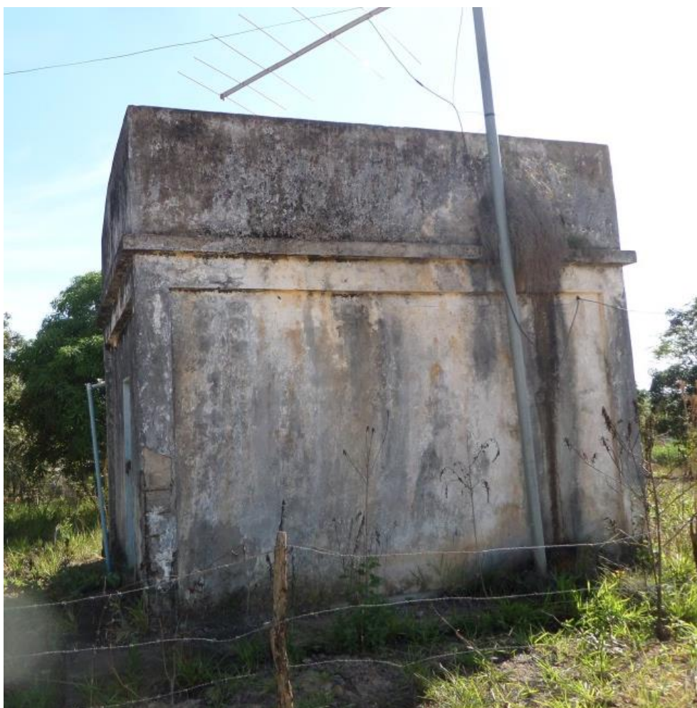
Figura 8.66 – Reservatório de Paredão
