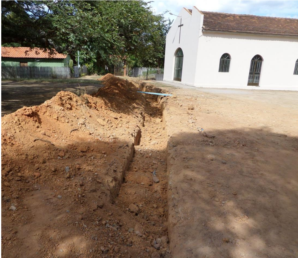
Figura 8.72 – Ampliação da rede de abastecimento em Porto das Andorinhas
