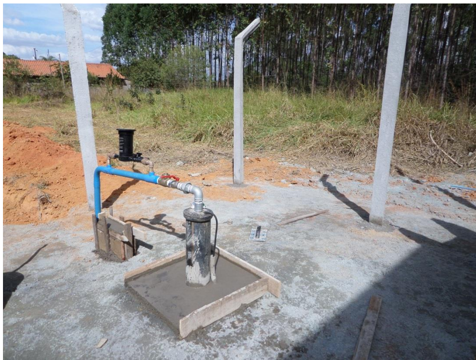
Figura 8.71 – Poço tubular em obras em Porto das Andorinhas
