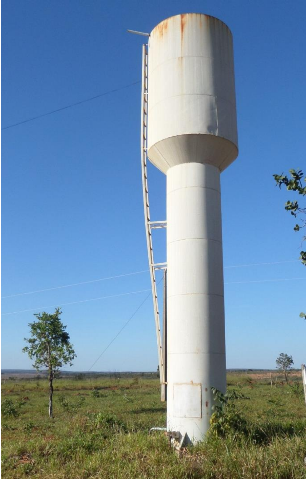
Figura 8.83 – Reservatório 1 do Balneário Vitória Porto Mangaba Fonte: COBRAPE (2014)
