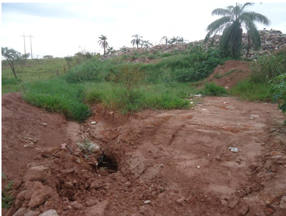
Figura 8.177 – Canaletas para captação de águas pluviais
