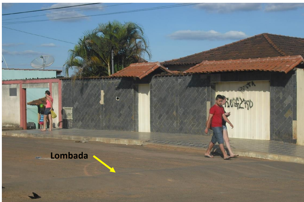
Lombada para desviar a água – Rua Jáder Moura
