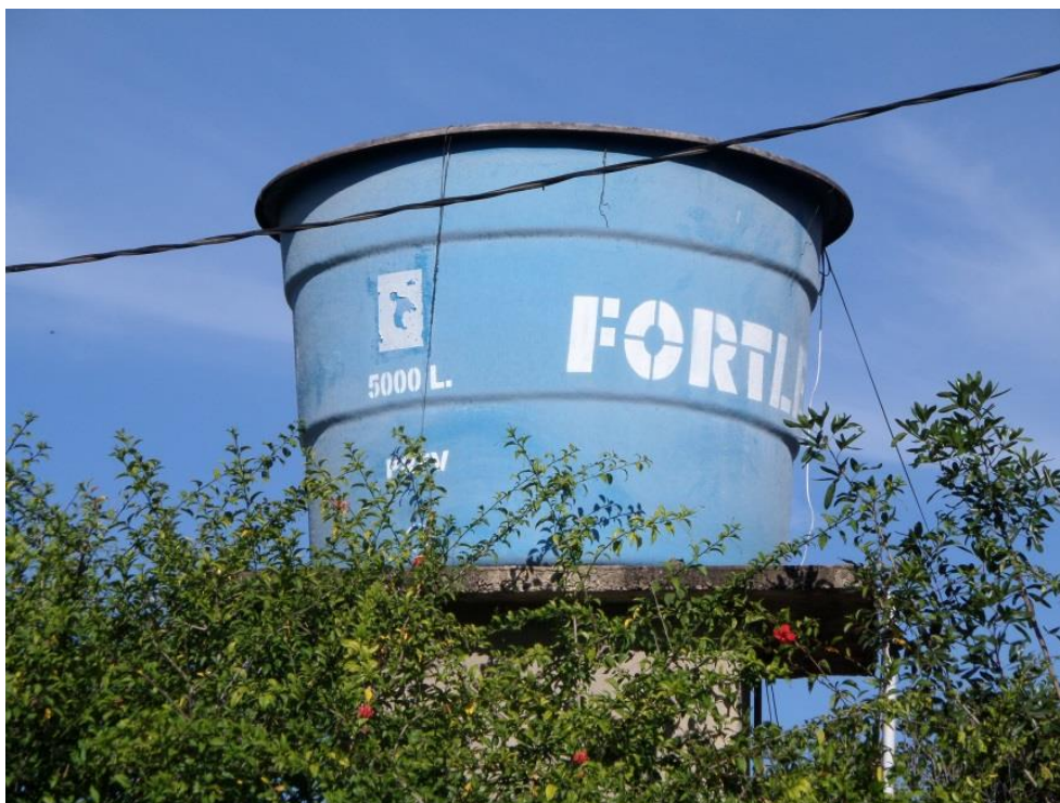
Figura 8.70 – Reservatório de Porto das Andorinhas
