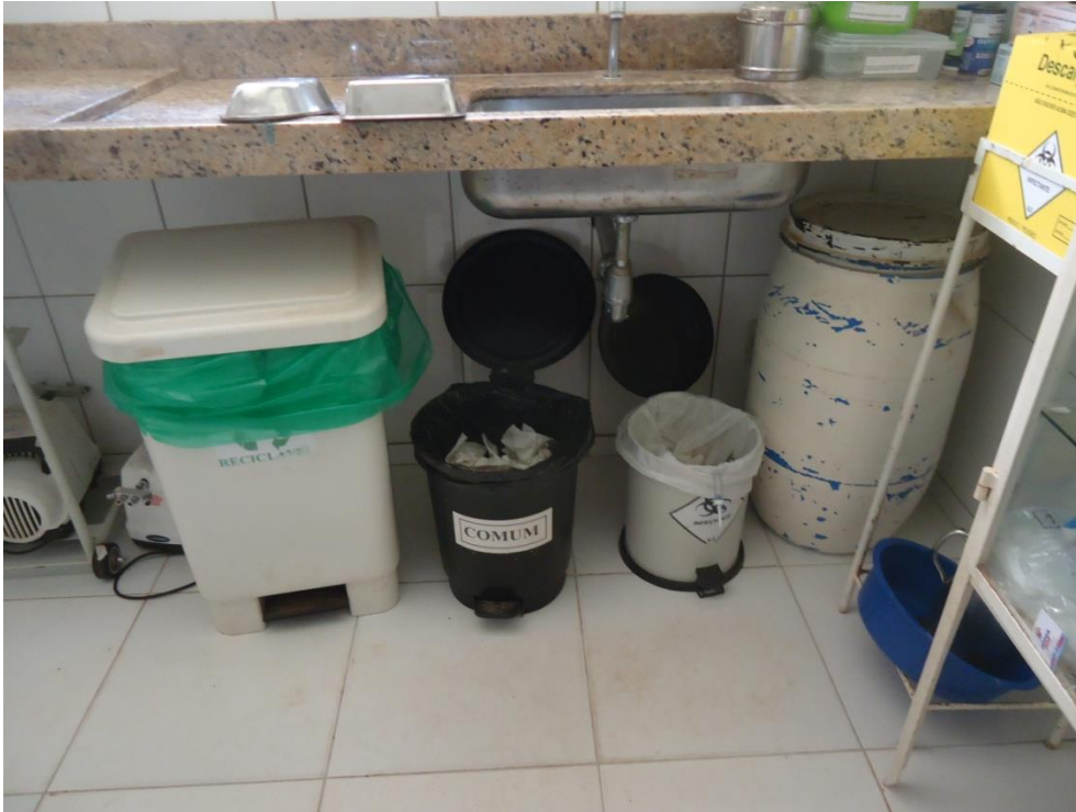
Figura 8.142 – Recipientes para acondicionamento de resíduos recicláveis, resíduos comuns, resíduos infectantes e perfurocortantes
