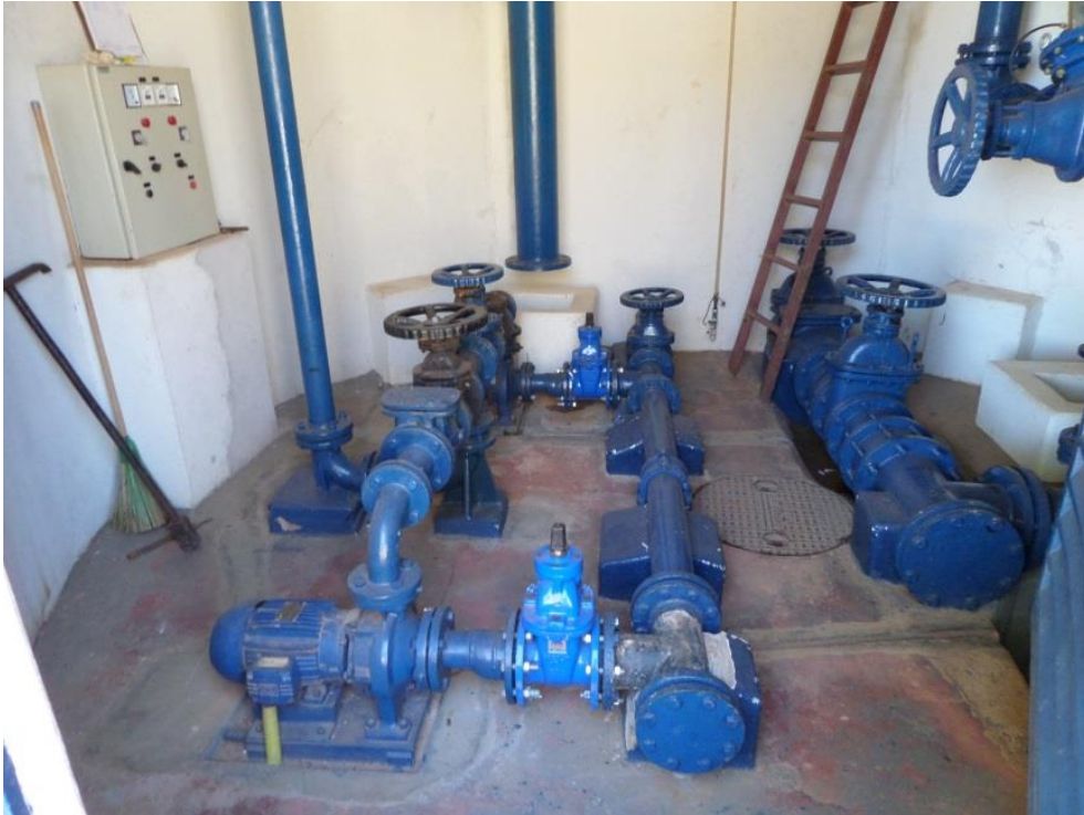
Figura 8.57 – Conjunto motobomba para abastecimento do REL 3
