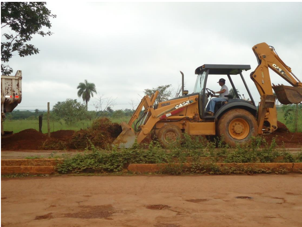
Figura 8.130 – Trator retroescavadeira realizando a coleta dos resíduos derivados da capina
