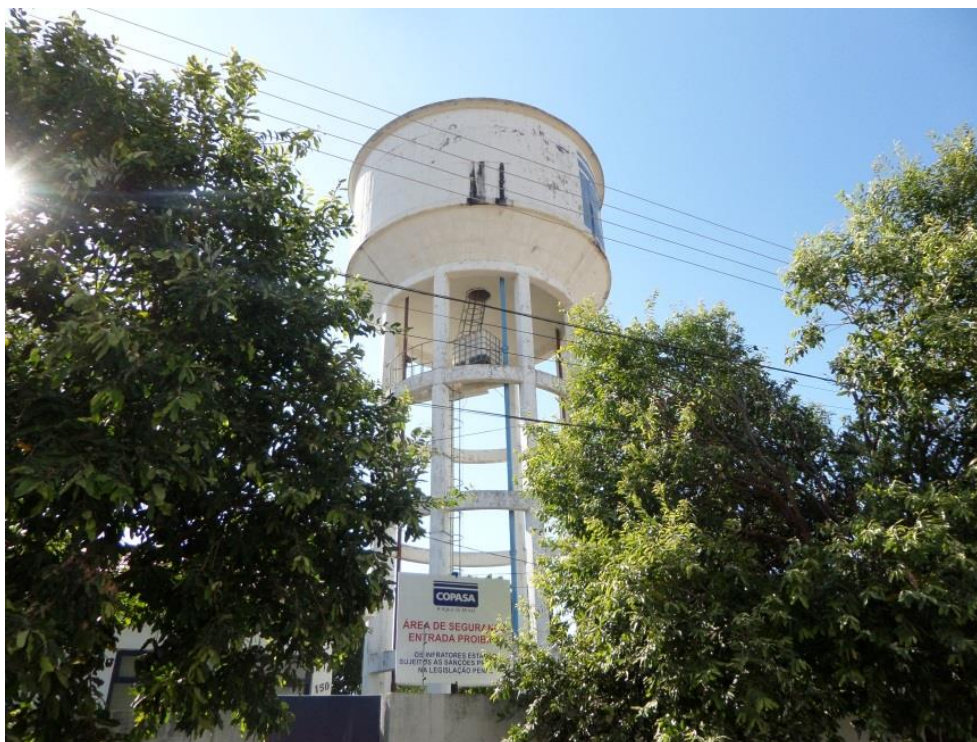
Figura 8.55 – Reservatório elevado (REL 1)
