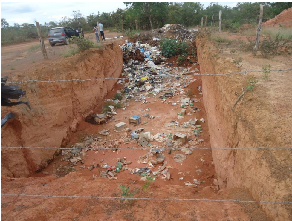
Figura 8.116 – Vala para disposição de resíduos sólidos na área rural
