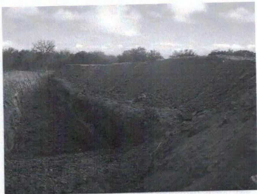
**Figura 6 - Barreiro trincheira construído em propriedade do Sr. Luiz Dias.**
