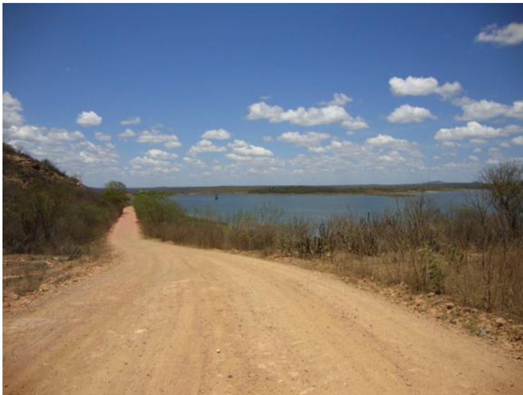
Foto 1: Estrada de acesso ao barramento do Açude Poco da Cruz sobre Neossolo Quartzarênico e sem medidas de controle de águas pluviais.
