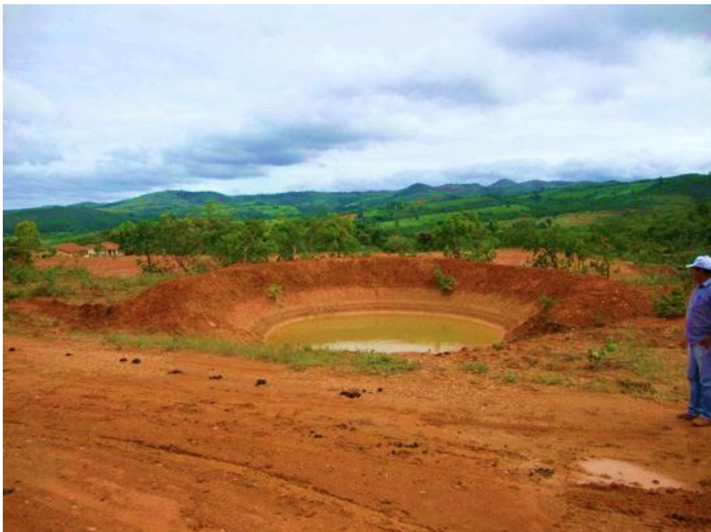
Foto 6: Exemplo de barraginha implantada no município de Guaraciama-MG.
