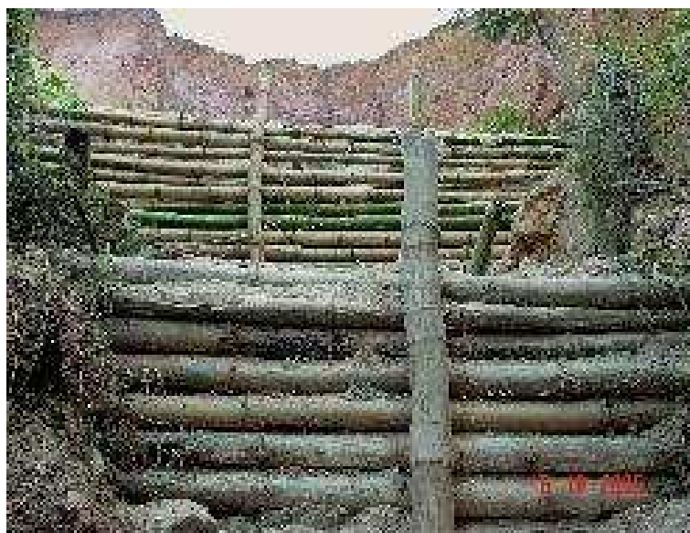
Fotografia 14: Exemplo de paliçada construída com bambu
