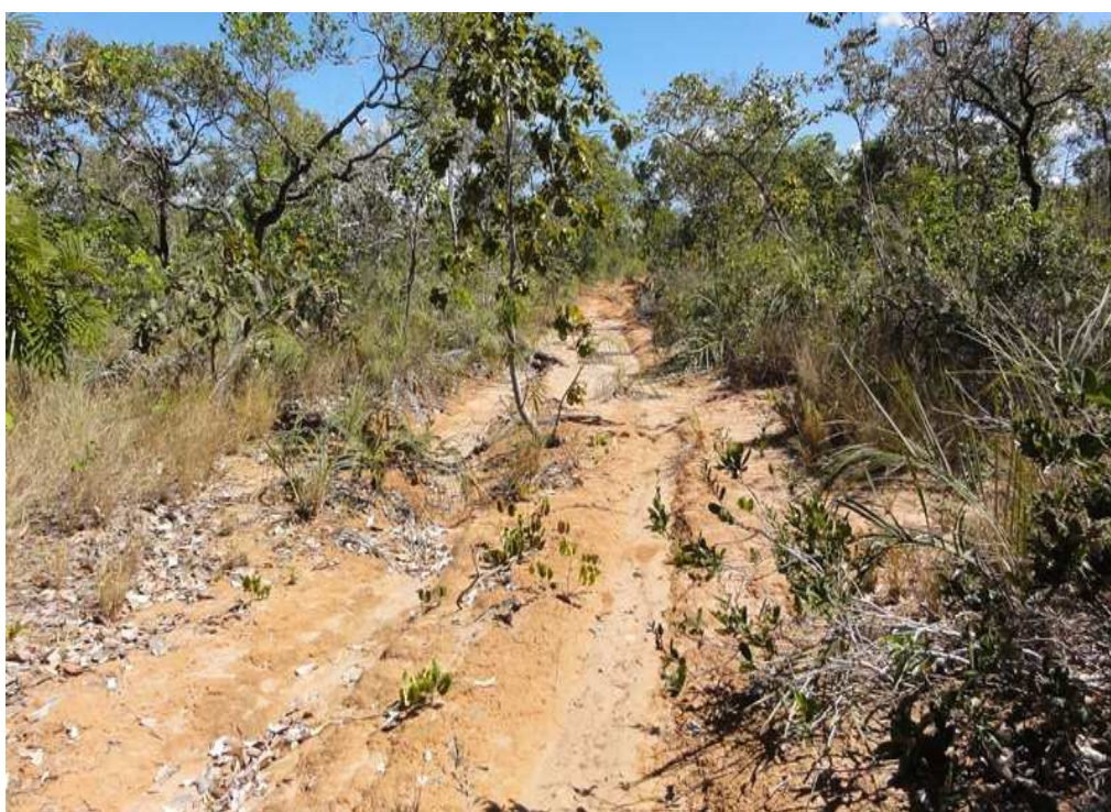
Fotografia 3 - Estrada de acesso à voçoroca formando caminhos preferenciais de escoamento.
