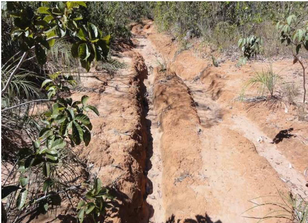
Fotografia 4 - Estrada apresentando processos erosivos com a formação de sulcos.
