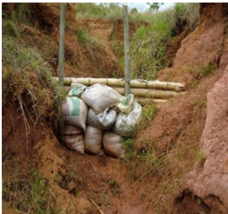
Fotografia 13: Representação de uma paliçada feita de bambu e sacos com terra servindo de escora
