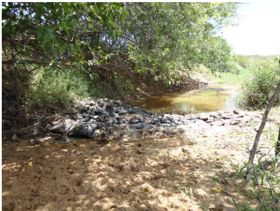
Figura 7 - Barragem construída com sacos de areia e seixos mostrando retenção de sedimento a montante e surgência de água a jusante.
