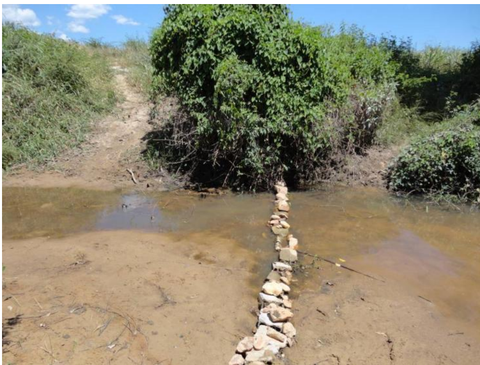
Figura 6 - Detalhe das barreiras de pedras para retenção de água no leito do rio.
