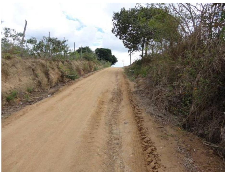
Fotografia 6 – Erosão nas margens das estradas devido ao escoamento.
