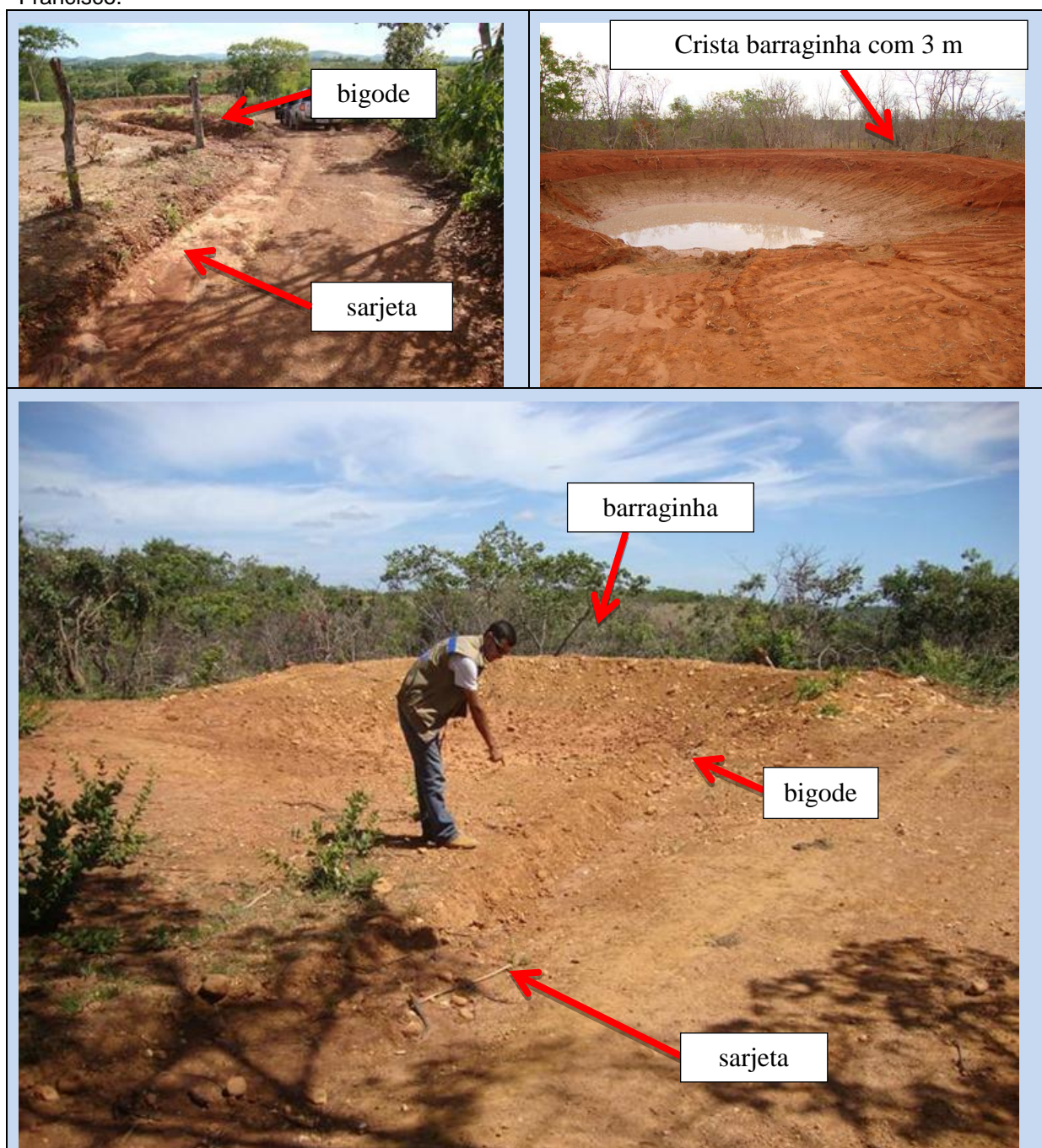
Figura 7.25 - Estradas rurais adequadas em obras hidroambientais da bacia do rio São Francisco.
