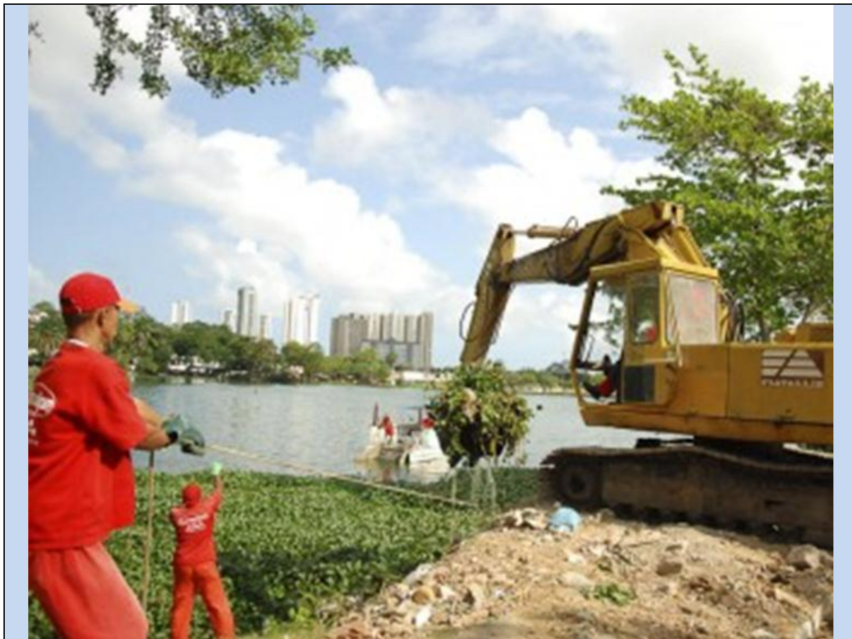
Figura 7.30 - Máquinas escavadeiras realizando limpeza.
