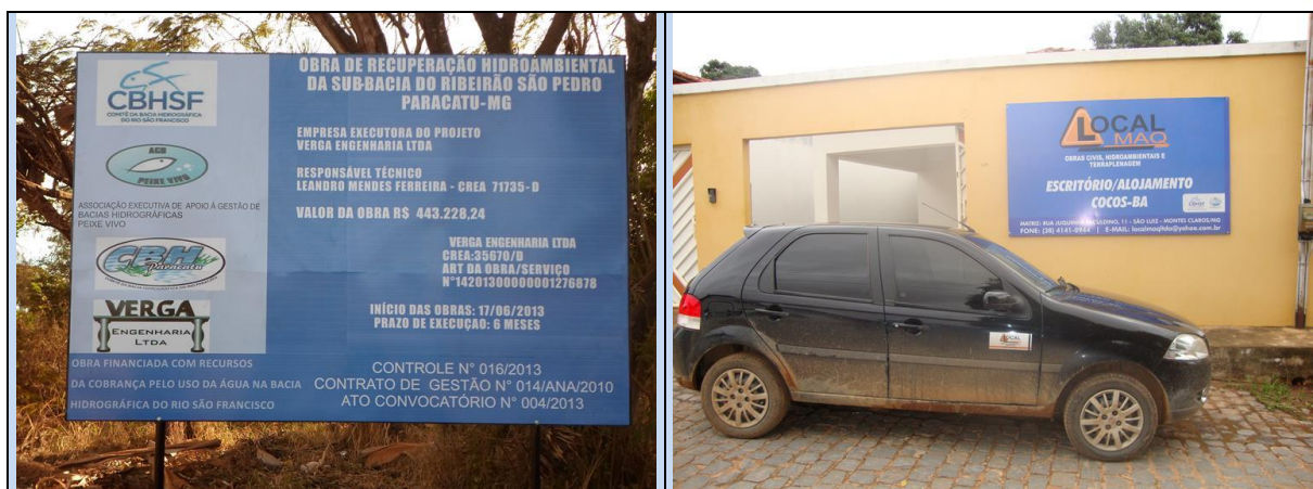
Figura 7.1 - Placa da Obra e Canteiro/Escritório de obras hidroambientais contratados pela AGB Peixe Vivo.
