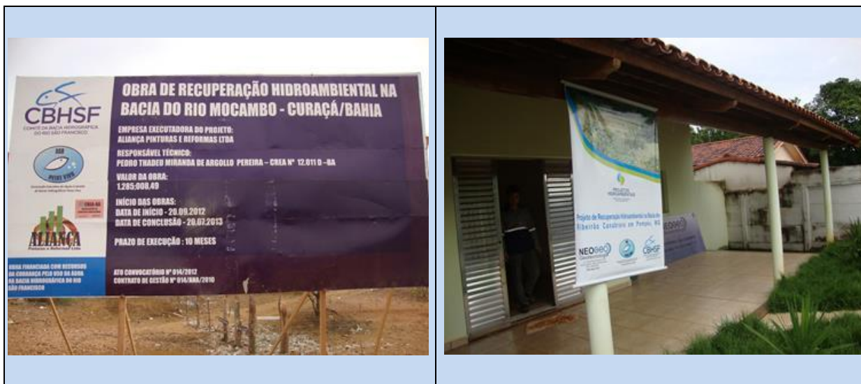
Figura 7.1 - Placa da Obra e Canteiro/Escritório de projetos hidroambientais contratados pela AGB Peixe Vivo.
