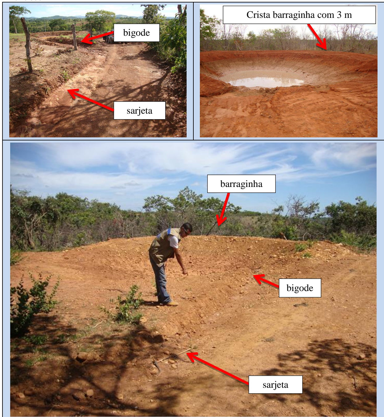
Figura 7.5 - Estradas rurais adequadas em projetos hidroambientais da bacia do rio São Francisco.
