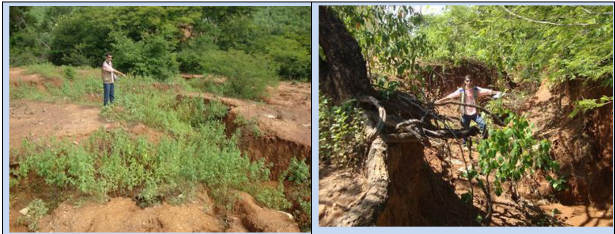
Figura 6.11 - Fotos de voçorocas onde serão construídas paliçadas.
