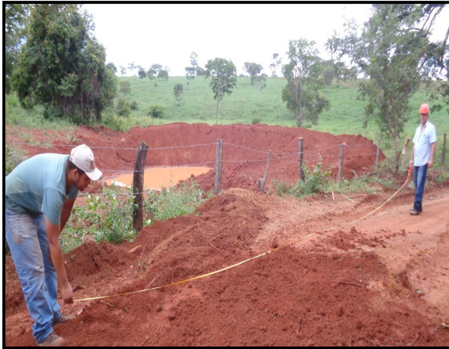
Figura 8 - Local de Construção das Lombada Cascalhada. Fonte: LOCALMAQ, 2015.
