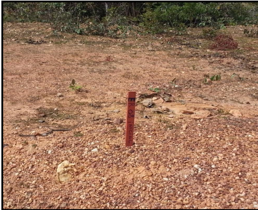
Figura 3 –Trabalho de Topografia – Estaqueamento. Fonte: LOCALMAQ, 2015.
