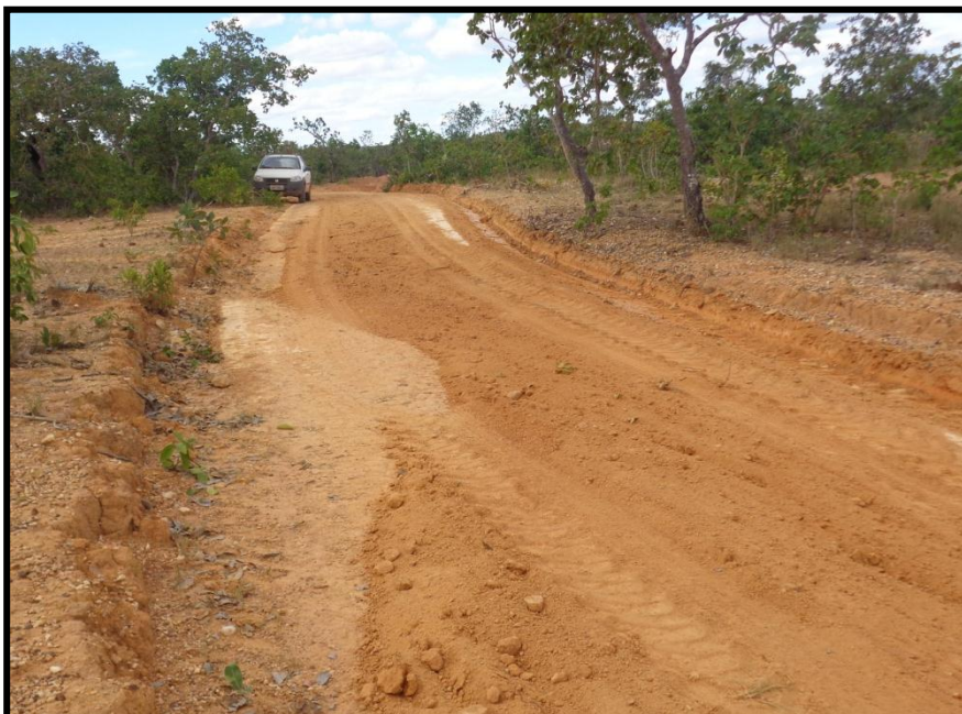
Figura 7 - Adequação da faixa de drenagem. Fonte: LOCALMAQ, 2015.
