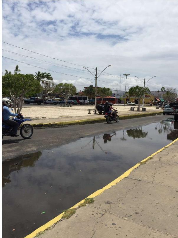
Figura 4-173 - Ponto de alagamento na via principal da Praça Central
