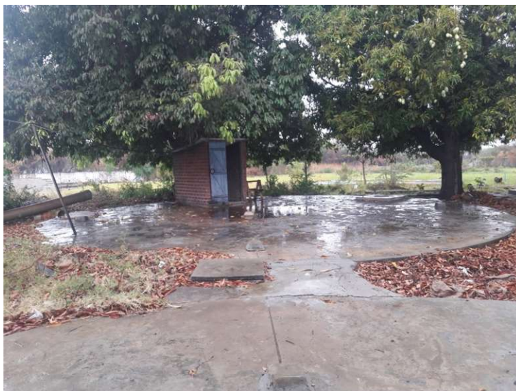
Figura 4-32 - Reservatório de água tratada Fonte: Projeta Engenharia (2017)
