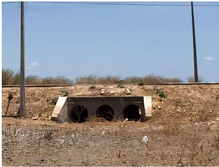
Figura 4-159 - Bueiro para passagem de água – Sede
