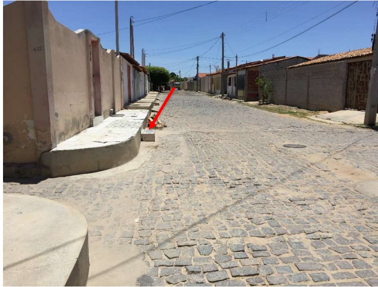
Figura 4-177 - Ponto de alagamento – Quadra 17, na Avenida 15 de Novembro
