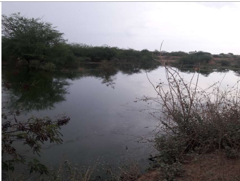
Figura 4-91 - Lagoa secundária com efluentes sanitários
