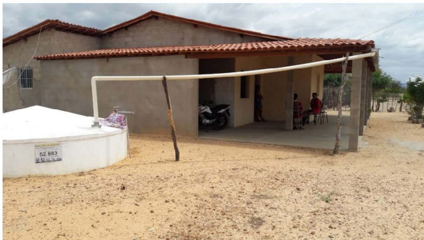
Figura 4-63 - Cisterna de armazenamento de água de chuva
