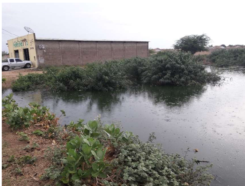
Figura 4-86 - Lagoa formada devido entupimento da rede que vem da Vila Santana
