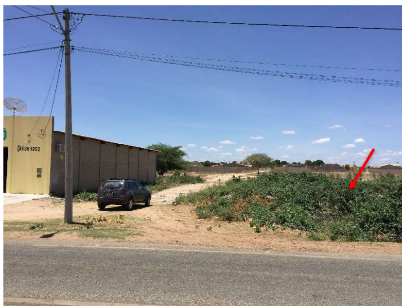
Figura 4-176 - Ponto de alagamento ao lado da marmoraria, destaque para área com esgoto a céu aberto
