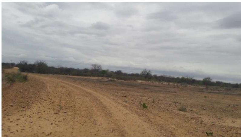
Figura 4-189 - Ponto de alagamento na localidade de Lagoinha, perímetro inteiro da via.
