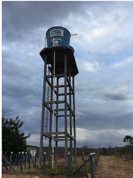
Figura 4-51 - Reservatórios na área elevada da localidade de Tamboril Fonte: Projeta Engenharia (2017)
