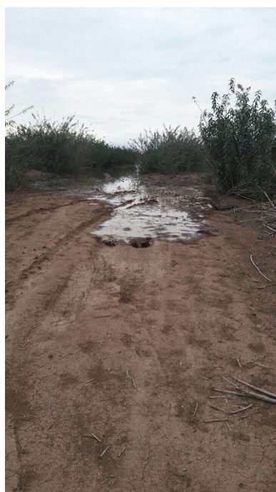
Figura 4-50 - Vazamento na adutora de água bruta de Malhadinha
