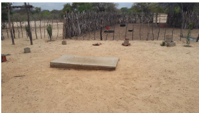
Figura 4-95 - Fossa rudimentar em moradia de Lagoinha
