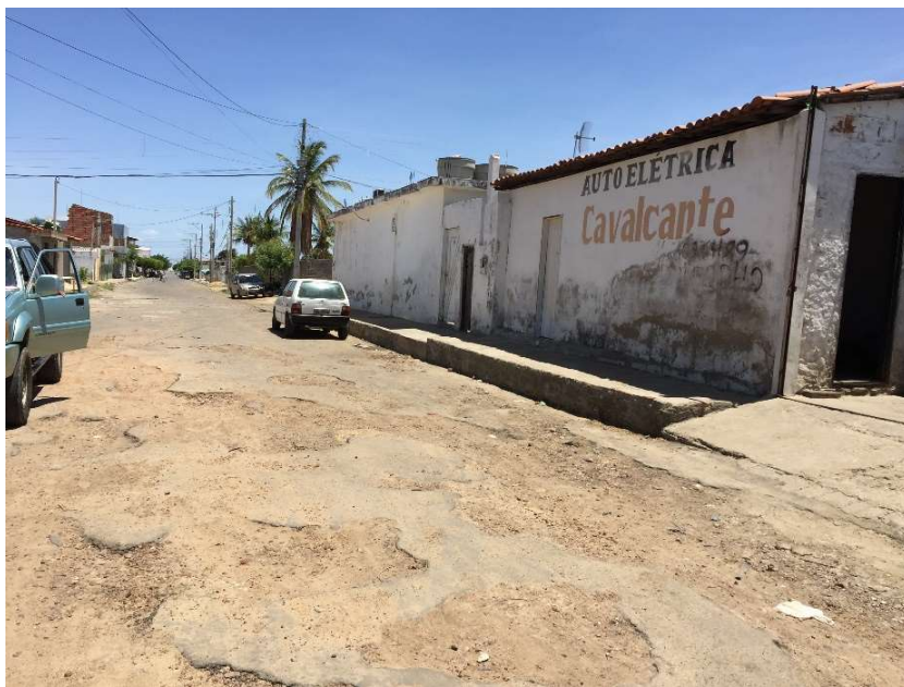
Figura 4-168 - Ponto crítico de alagamento na rua Coronel Francisco Leobas
