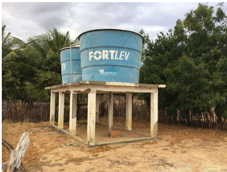
Figura 4-52 - Reservatórios na área elevada da localidade de Tamboril Fonte: Projeta Engenharia (2017)
