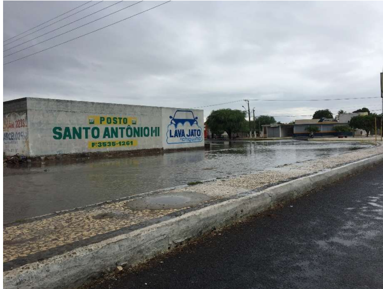
Figura 4-188 - Ponto de alagamento na Avenida Piauí próximo a rotatória que dá acesso à rodoviária
