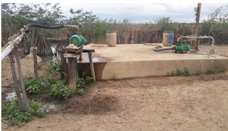
Figura 4-47 - Reservatório semienterrado em Malhadinha
