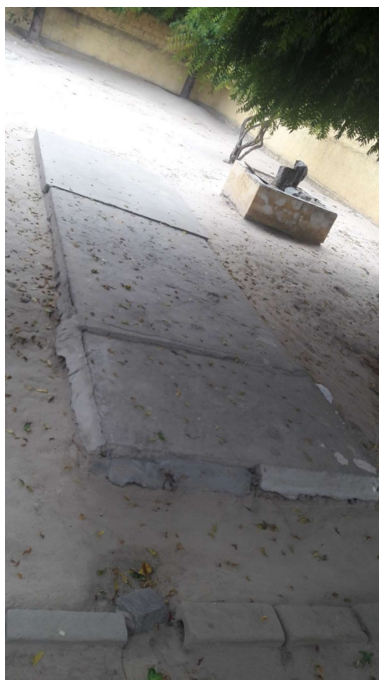
Figura 4-97 - Fossa rudimentar do colégio municipal em Novo Marcos
