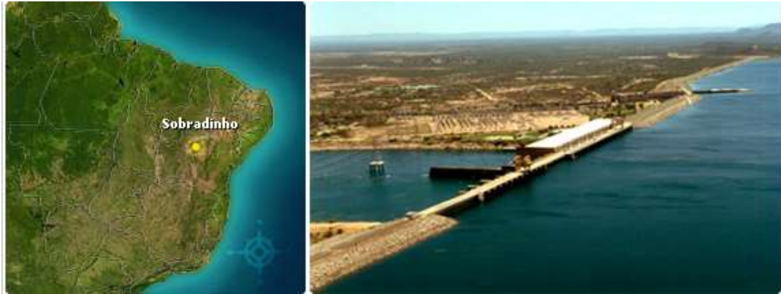
Figura 4-162 - Barragem de Sobradinho
