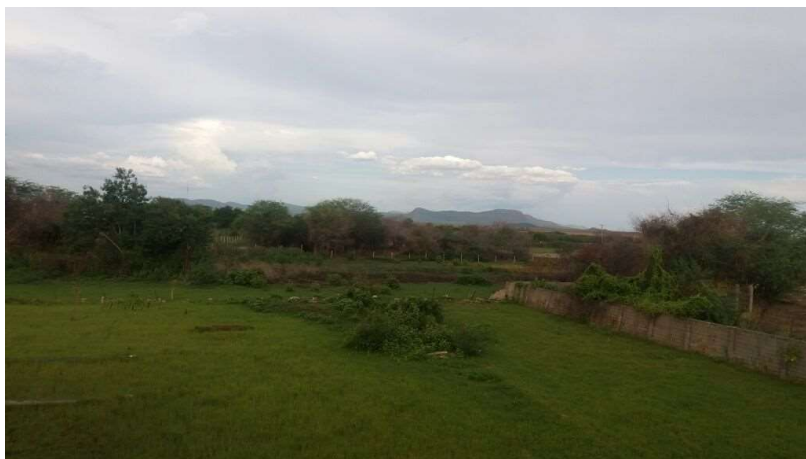
Figura 4-26 - Local onde é lançada a água de lavagem dos filtros
