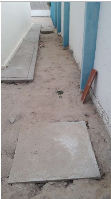
Figura 4-98 - Fossas rudimentares no posto de saúde de malhadinha
