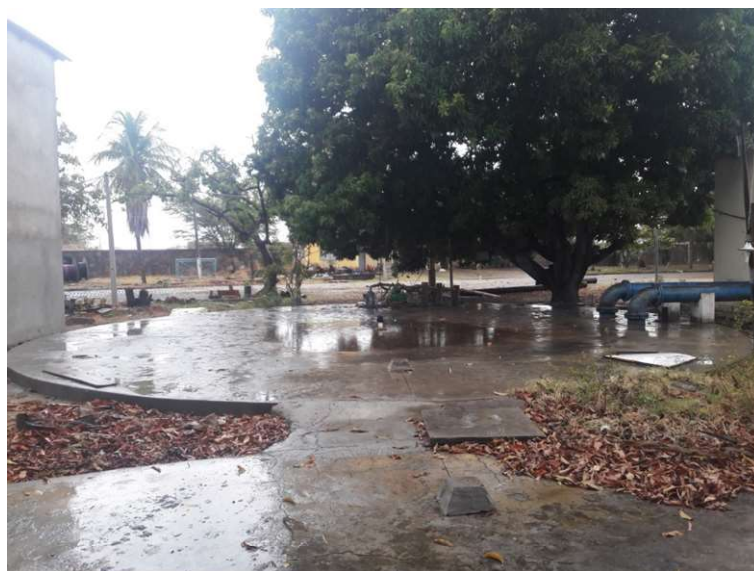
Figura 4-31 - Reservatório de água tratada
