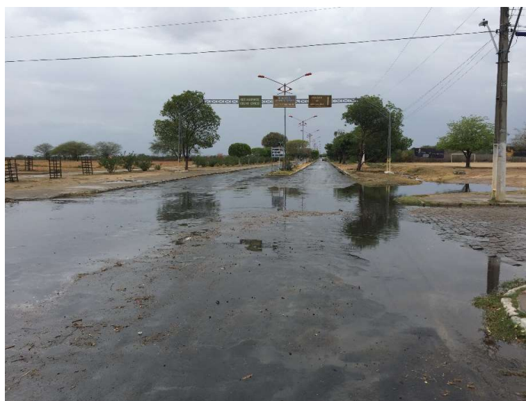
Figura 4-181 - Ponto de alagamento entre as vias Av. Beira Lago e Av. Manoel Amâncio Coelho
