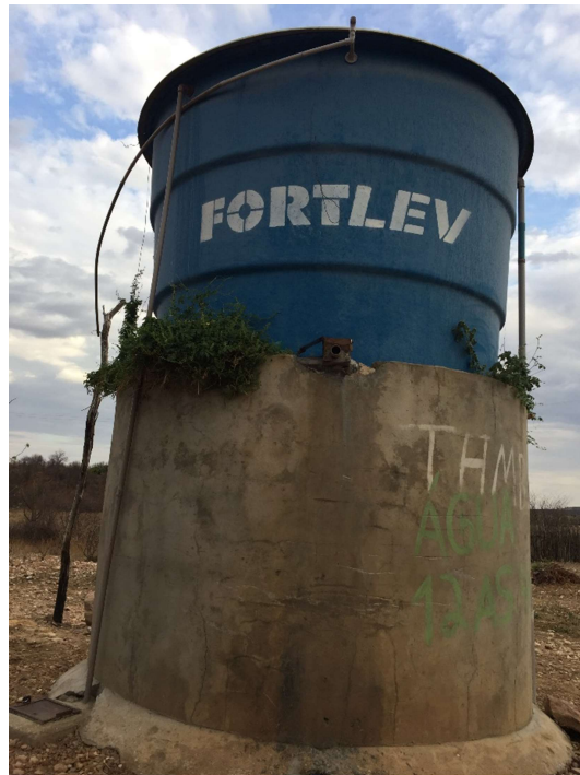
Figura 4-53 - Reservatório na parte baixa da localidade de Tamboril
