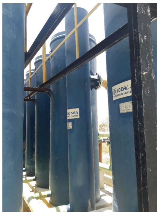
Figura 4-72 - Vertedor Fonte: Projeta Engenharia (2017)
