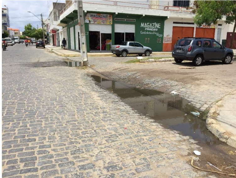
Figura 4-178 - Ponto de alagamento na Rua Dr. Severino F. dos Santos, ao lado da Secretaria de Educação
