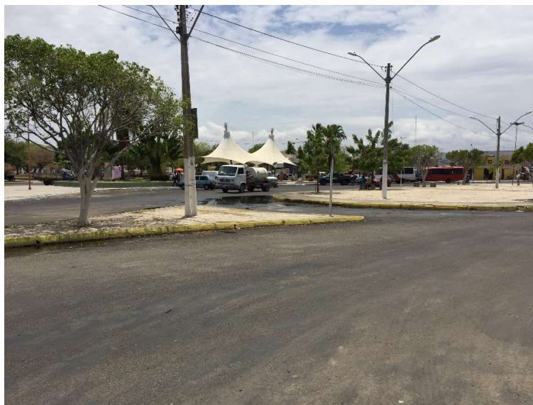
Figura 4-155 - Pavimentação asfáltica no município de Remanso
