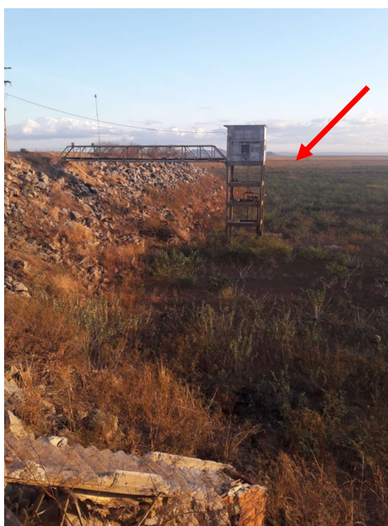
Figura 4-9 - Vista atual do ponto de captação do cais
