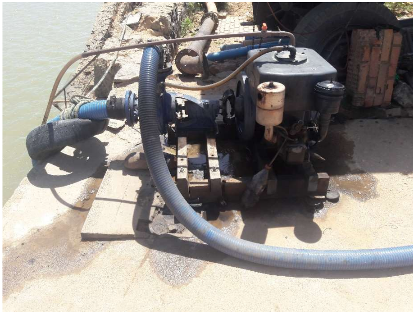
Figura 4-59 - Captação de água para abastecimento dos caminhões pipa Fonte: Projeta Engenharia (2017)
