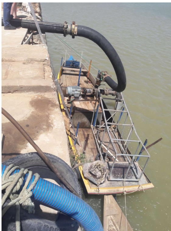
Figura 4-10 - Captação atual na Represa de Sobradinho Fonte: Projeta Engenharia (2017)
