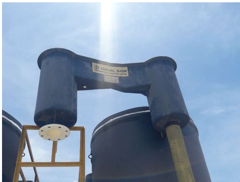
Figura 4-69 - Calha Parshal Fonte: Projeta Engenharia (2017)
