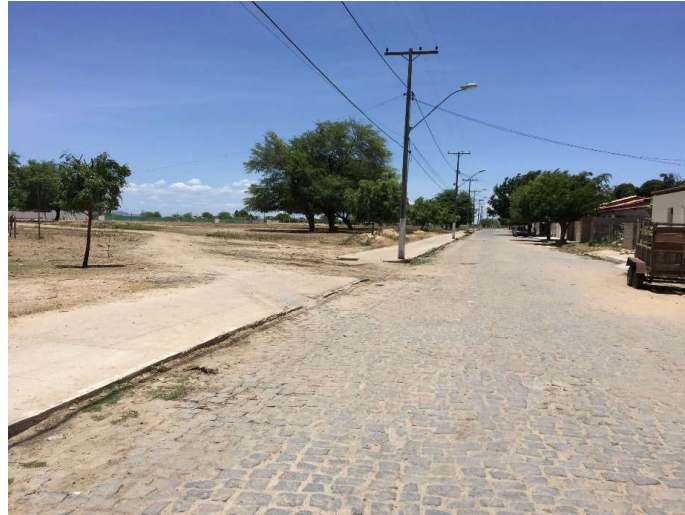
Figura 4-182 - Ponto de alagamento na Avenida Beira Lago
