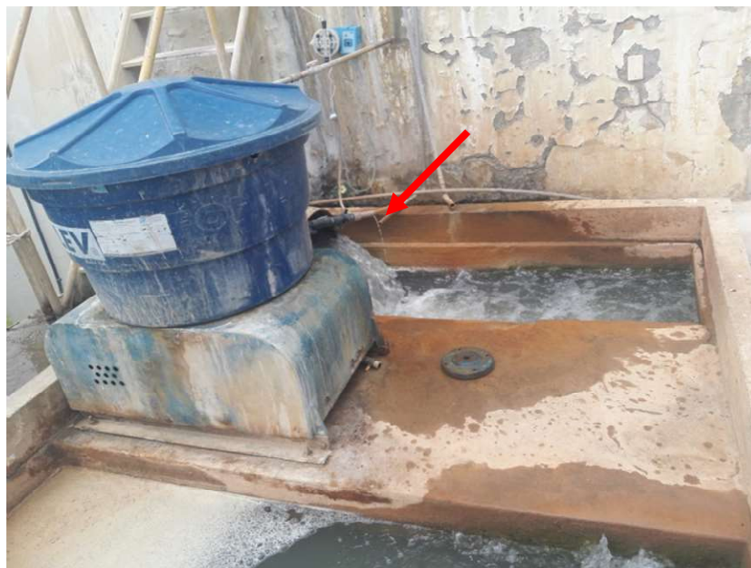
Figura 4-14 - Reservatório de sulfato de alumínio, com destaque para o dosador
