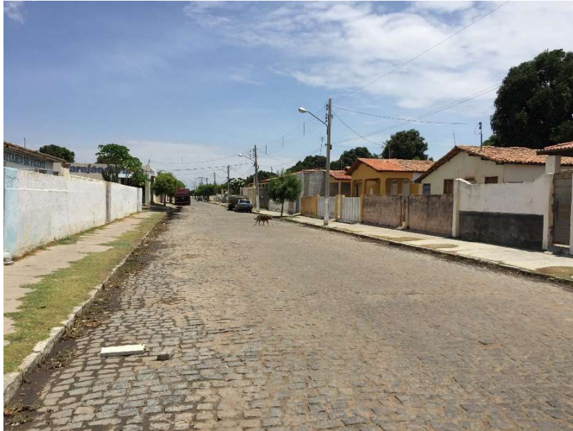
Figura 4-167 - Inexistência de sistema de microdrenagem na rua Coronel Francisco Leobas
