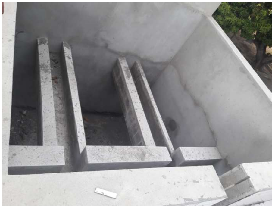
Figura 4-22 - Filtro em construção
