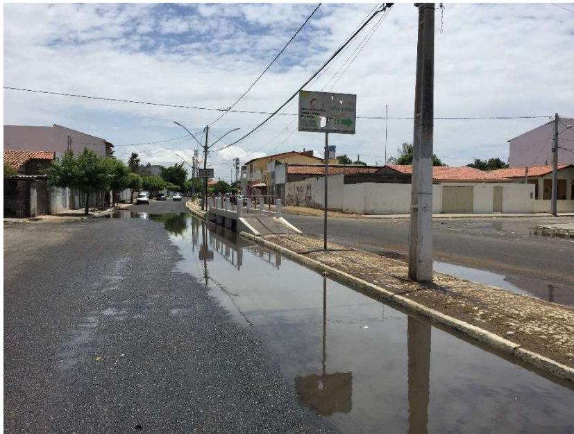
Figura 4-171 - Ponto de alagamento na Avenida Eunápio P. de Queiroz, alagamento em todo perímetro da via.
