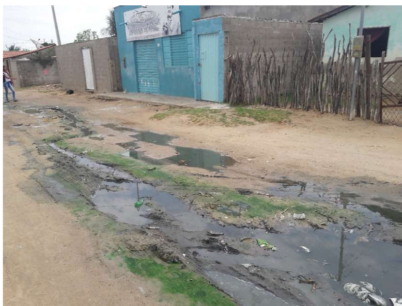
Figura 4-84 - Esgoto a céu aberto em Vila Matilde Fonte: Projeta Engenharia (2017)
