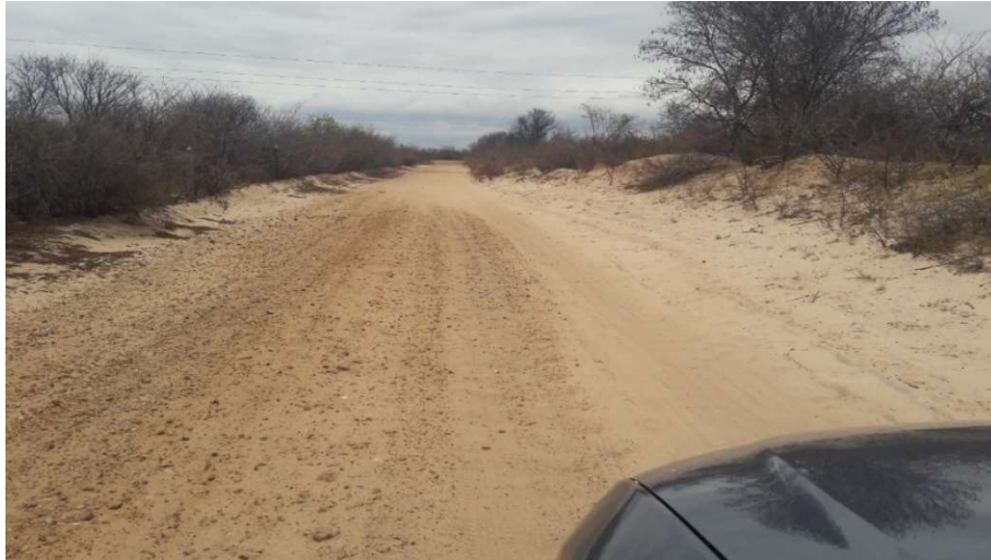
Figura 4-190 - Ponto de alagamento na estrada de acesso a localidade de Lagoinha
