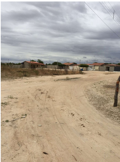
Figura 4-192 - Ponto de alagamento na estrada de acesso ao cemitério de Novo Marcos
