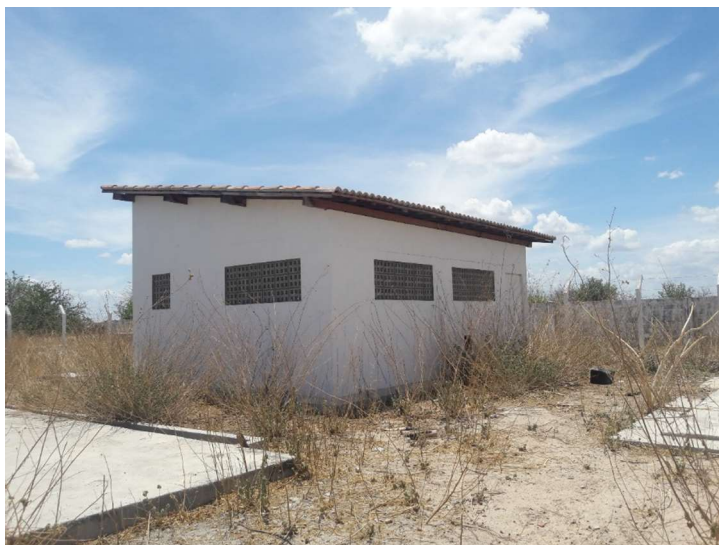
Figura 4-73- Casa de bomba
