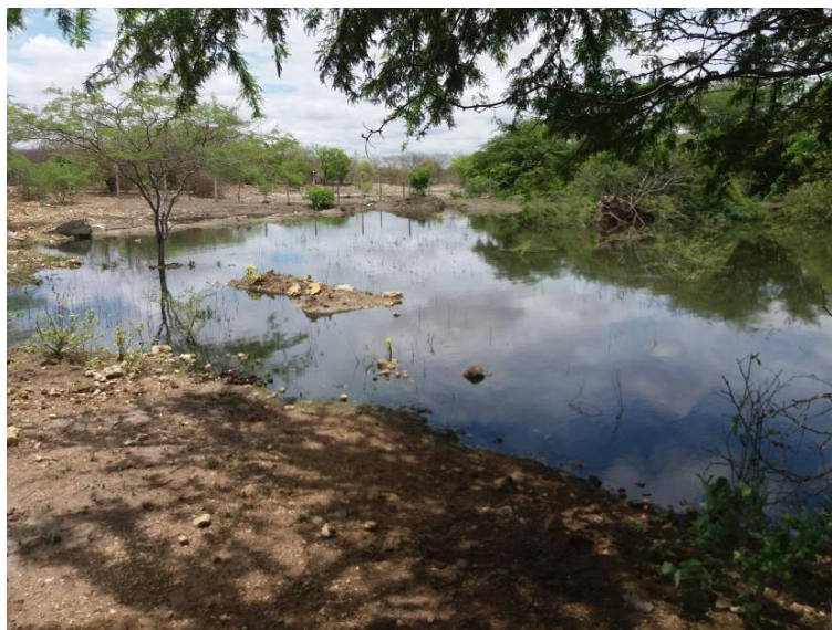
Figura 102 – Lagoa formada por vazamento dos efluentes, na ETE da sede de Lapão
