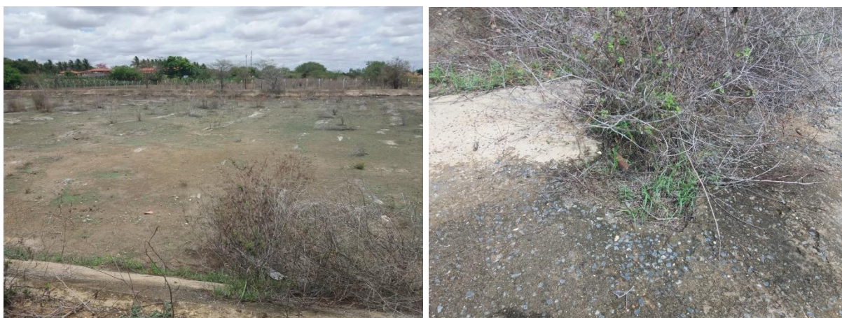
Figura 108 – Lagoa de Maturação 2 e canal de passagem, na ETE da sede de Lapão
