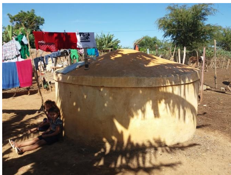
Figura 83 – Cisterna construída pela Prefeitura de Lapão em Aroeira
