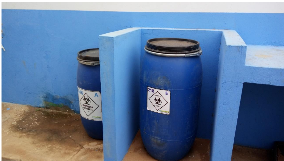
Figura 148 – Armazenamento de RSS na UBSF Ana Matos, no Distrito de Aguada Nova
