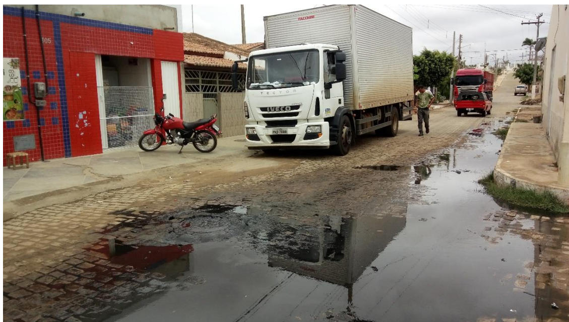
Figura 119 – Esgoto a céu aberto na sede do município de Lapão
