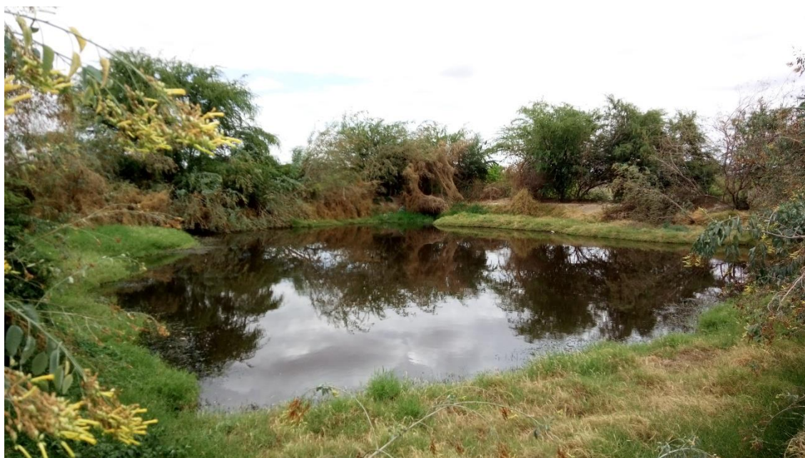
Figura 117 – Lagoa anaeróbia da ETE do município de Lapão
