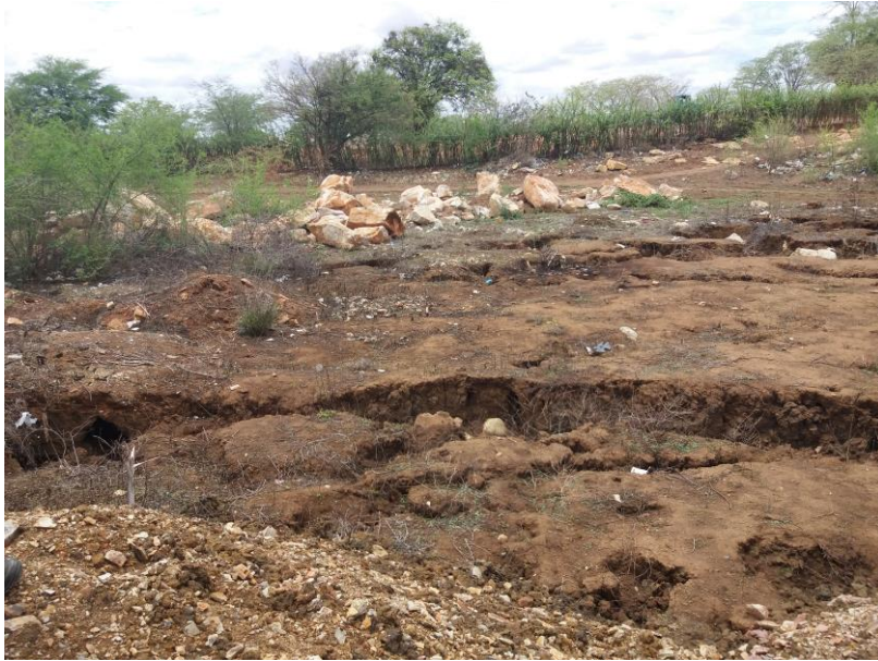
Figura 199 – Área identificada com processo erosivo (sede)
