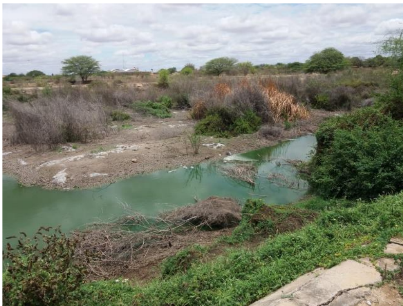
Figura 103 – Lagoa Facultativa 1, na ETE da sede de Lapão
