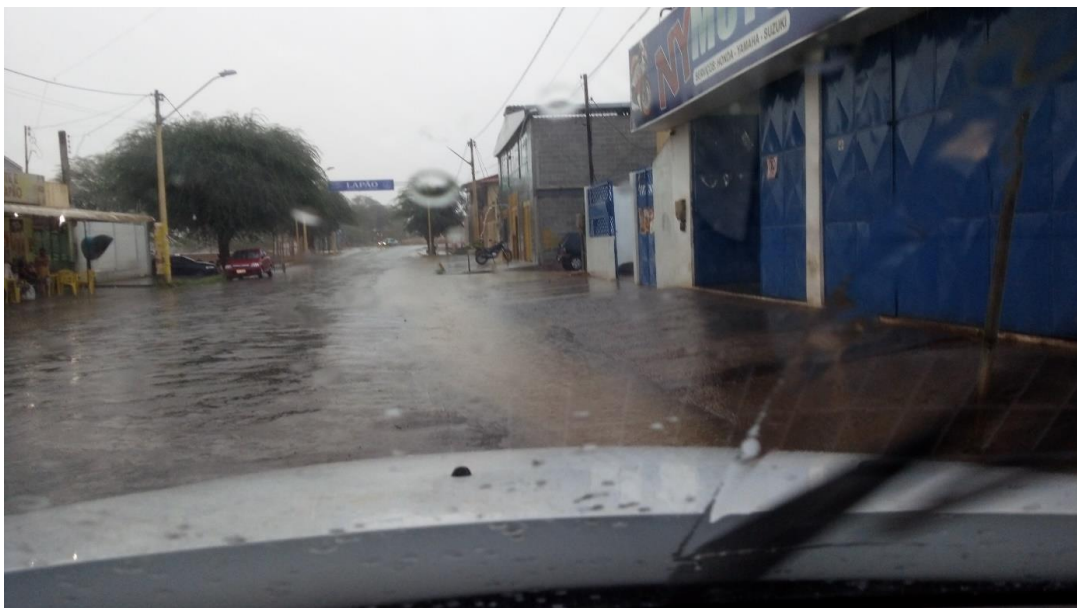
Figura 189 – Ponto 10 - Rua Antônio Carlos Magalhães
