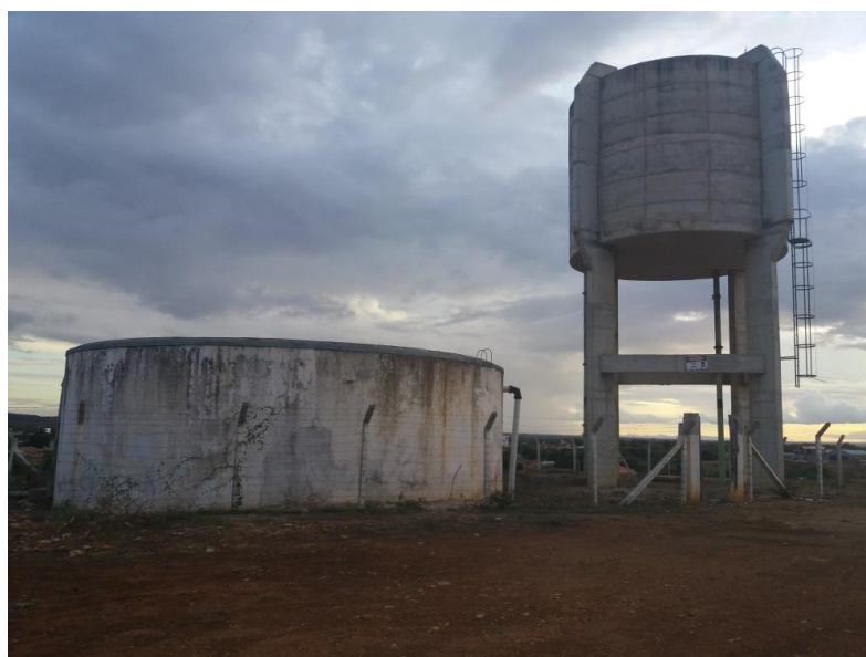
Figura 66 – Reservatórios na sede de Lapão
