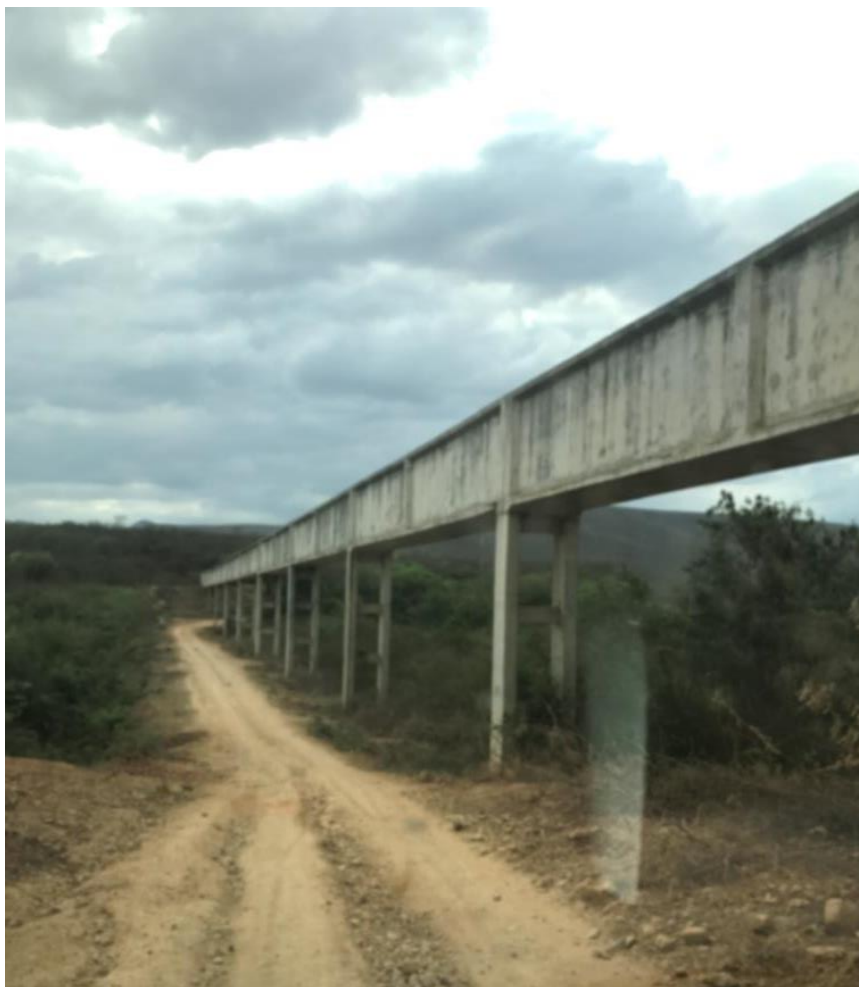
Figura 56 – Estrutura de tomada d'água na Barragem Mirorós
