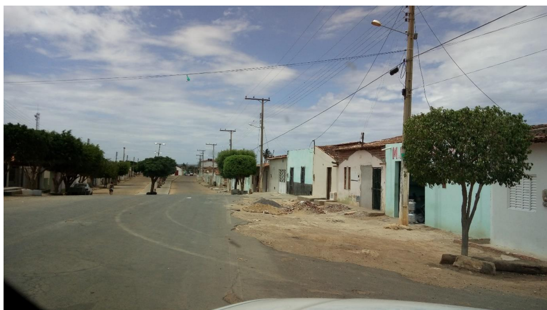
Figura 171 – Tipo de pavimentação no município de Lapão - Asfalto
