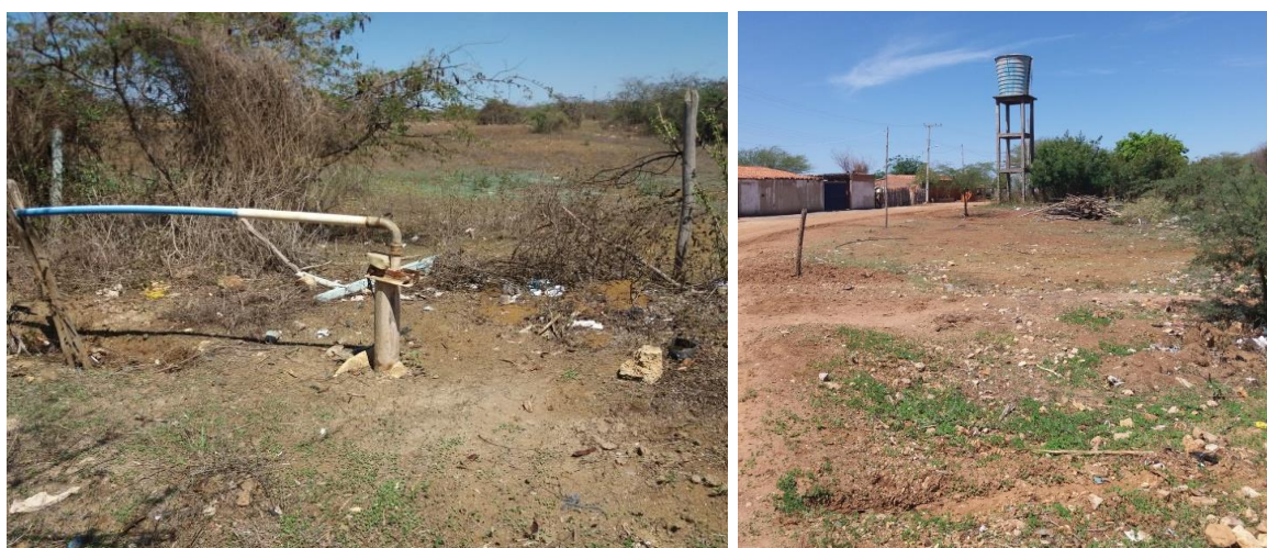
Figura 79 – Poço e reservatório no povoado de Lagoa Bonita
