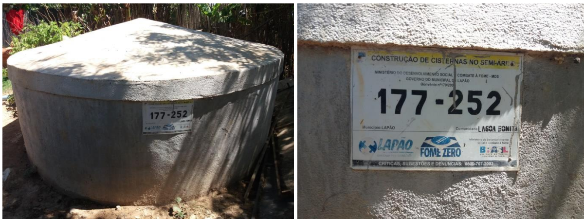
Figura 87 – Cisterna construída pelo Programa Cisternas e placa de identificação, em Lagoa Bonita
