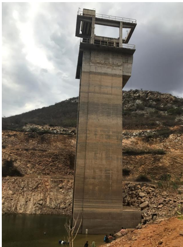
Figura 55 – Torre de tomada d'água na Barragem Mirorós
