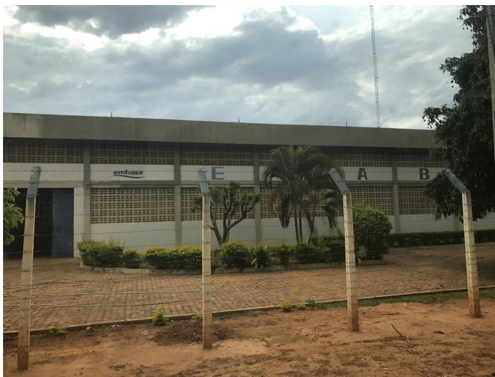
Figura 59 – Estação Elevatória de Água Bruta I
