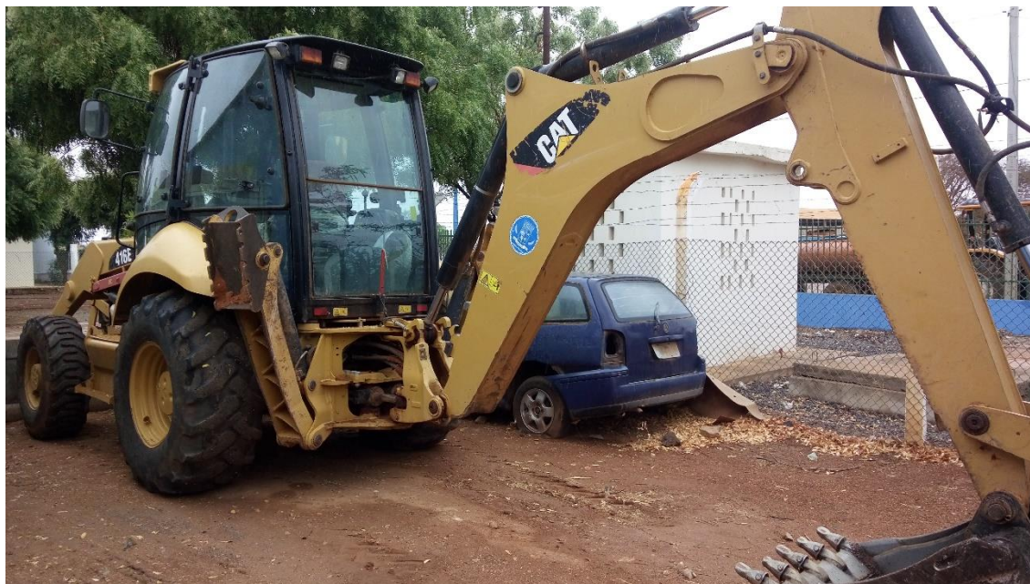
Figura 142 – Retroescavadeira da Prefeitura Municipal de Lapão
