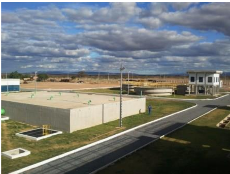
Figura 60 – Estação de Tratamento de Água Ibititá
