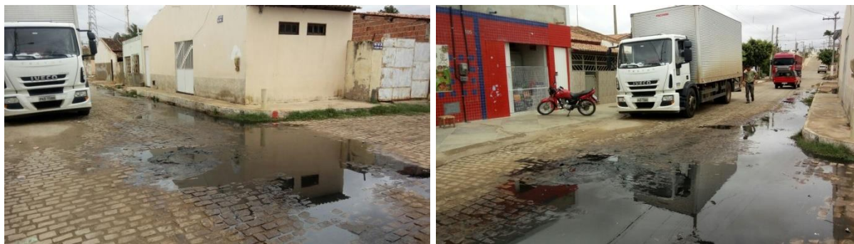
Figura 93 – Vazamentos de esgoto sanitário na Rua José Vilela, na sede de Lapão
