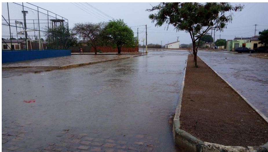
Figura 180 – Ponto 1 - Rua Castro Alves
