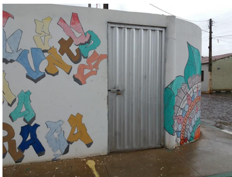
Figura 98 – Estação Elevatória de Esgoto na Rua José Augusto, na sede de Lapão
