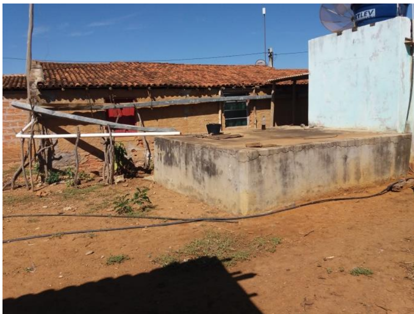
Figura 84 – Cisterna de 20 m 3 construída pelo morador da casa em Aroeira
