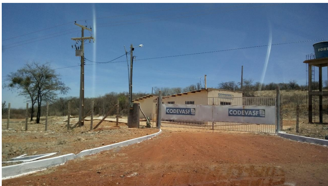
Figura 168 – Entrada principal do aterro sanitário no município de Irecê/BA
