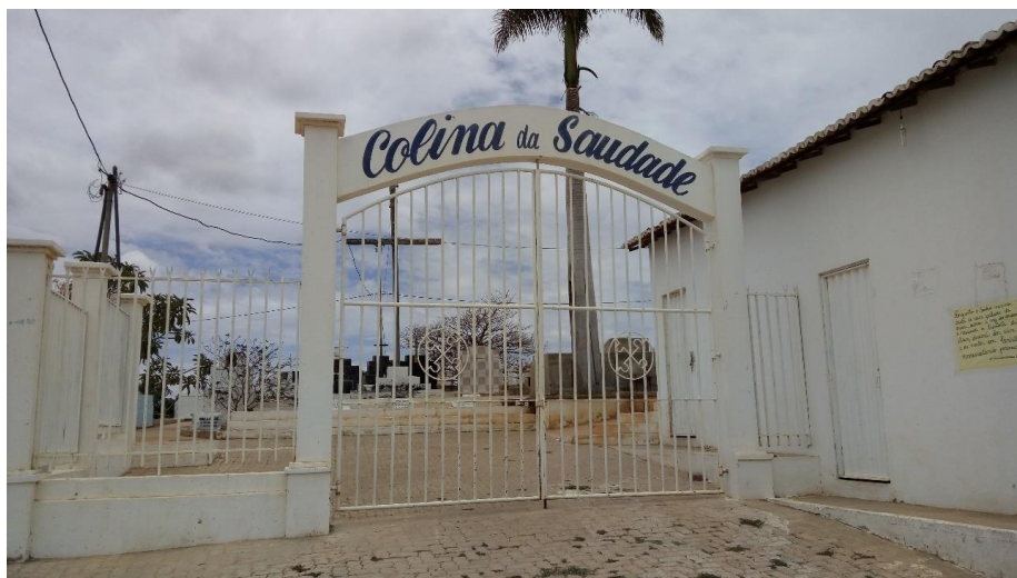
Figura 151 – Entrada do Cemitério Colina da Saudade, na sede no município de Lapão
