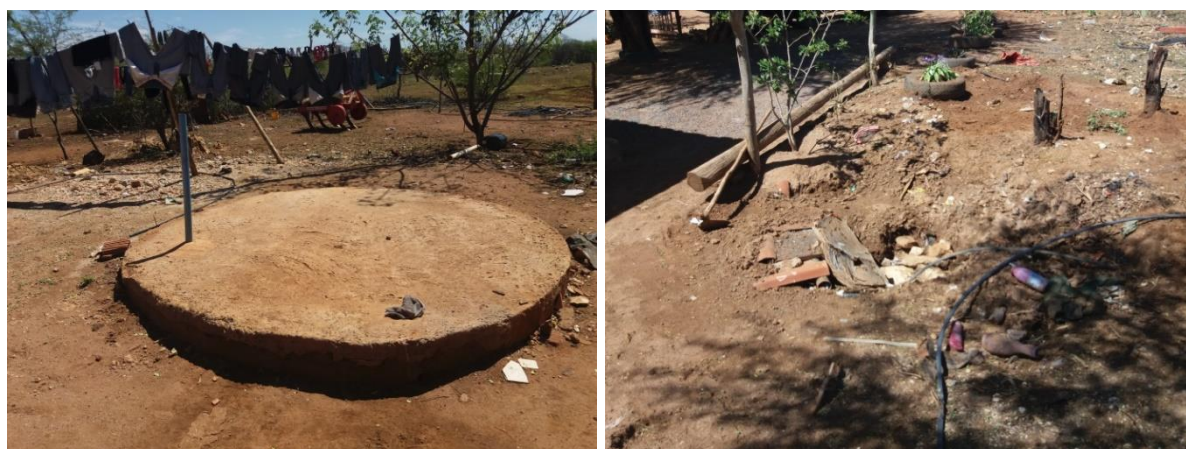
Figura 112 – Fossa rudimentar (à esquerda) e sumidouro (à direita) em domicílio de Lagedinho
