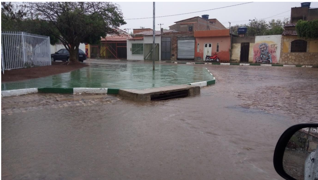
Figura 187 – Ponto 8 - Rua Projetada
