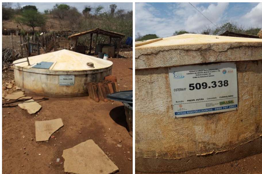
Figura 4-55 – Cisterna construída pelo P1MC e placa de identificação em Cerralinho.
