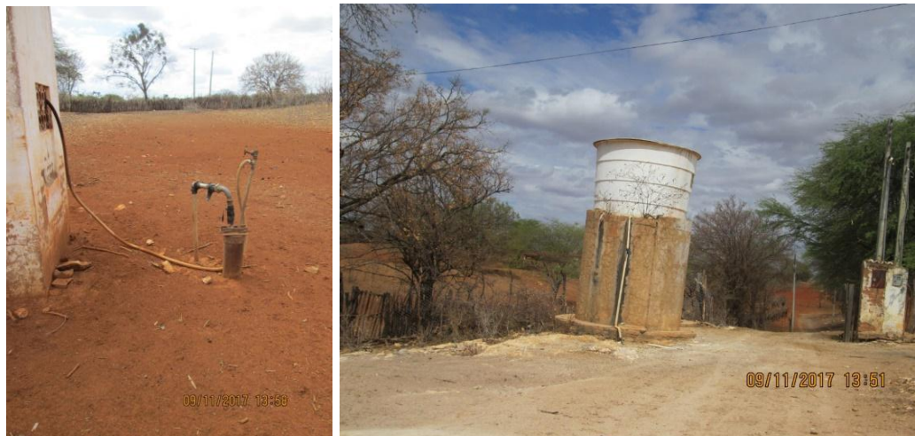
Figura 4-49 – Poço artesiano e reservatório da Prefeitura em Sapecado.
