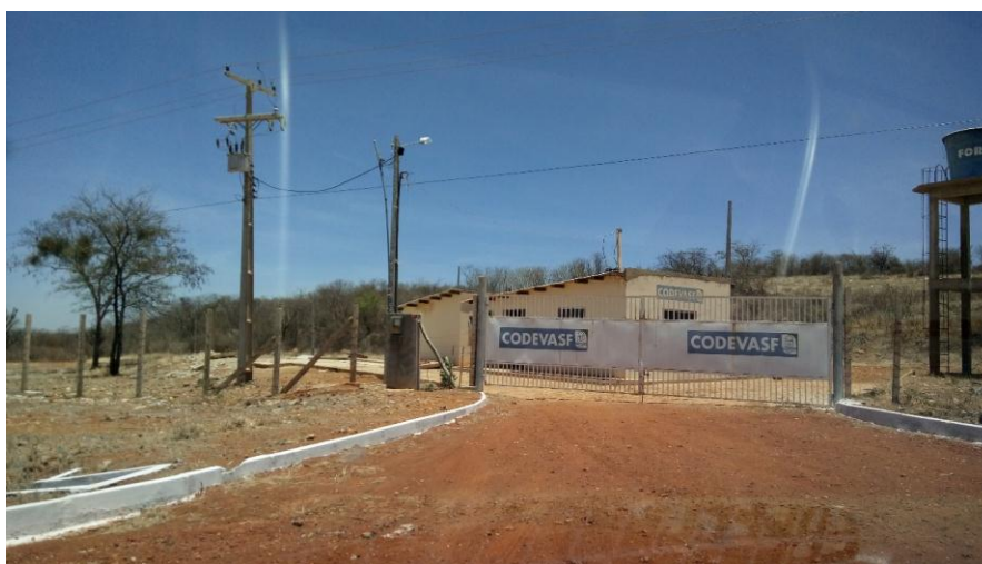
Figura 4-118 – Entrada principal do aterro sanitário no município de Irecê/BA
