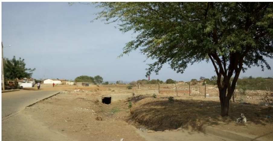
Figura 4-129 - Final de estrutura sarjetão em contato com canal de direcionamento das águas para galeria de acesso a Lagoa Grande.
