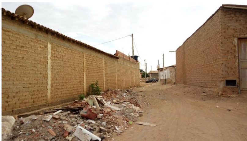
Figura 4-92 – RCC descartado em via pública na sede do município de Presidente Dutra
