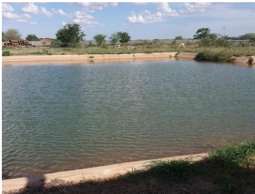
Figura 4-29 – Lagoa de descarga dos decantadores da ETA Rio Verde
