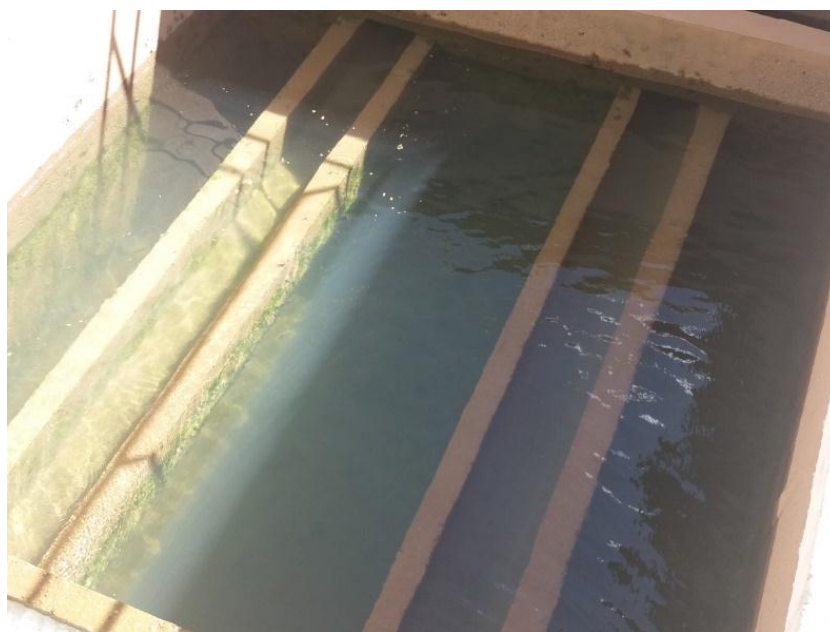
Figura 4-24 – Filtro na ETA Rio Verde
