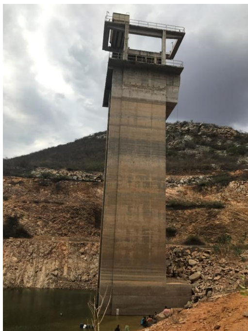
Figura 4-8 – Torre de tomada d'água na Barragem Mirorós.
