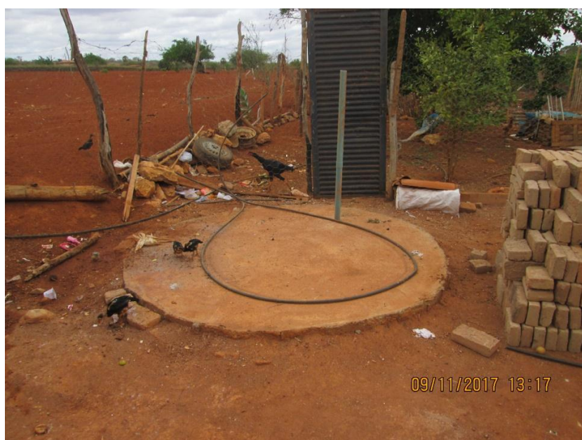
Figura 4-62 – Fossa rudimentar em domicílio na localidade de Bernardes.
