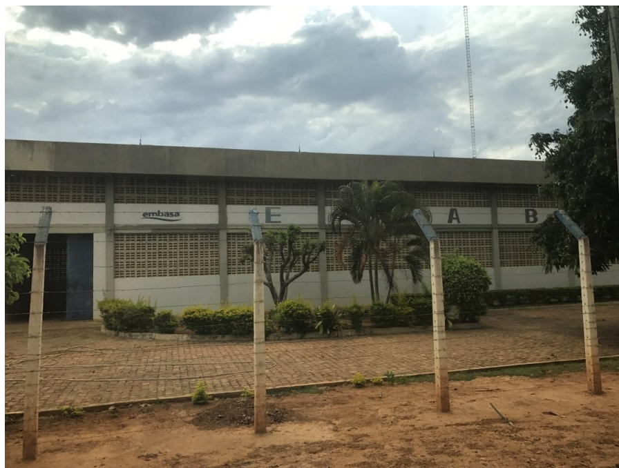
Figura 4-12 – Estação Elevatória de Água Bruta I.
