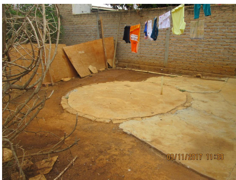
Figura 4-60 – Fossa rudimentar em domicílio na Rua Claudiomiro Machado, na sede de Presidente Dutra.
