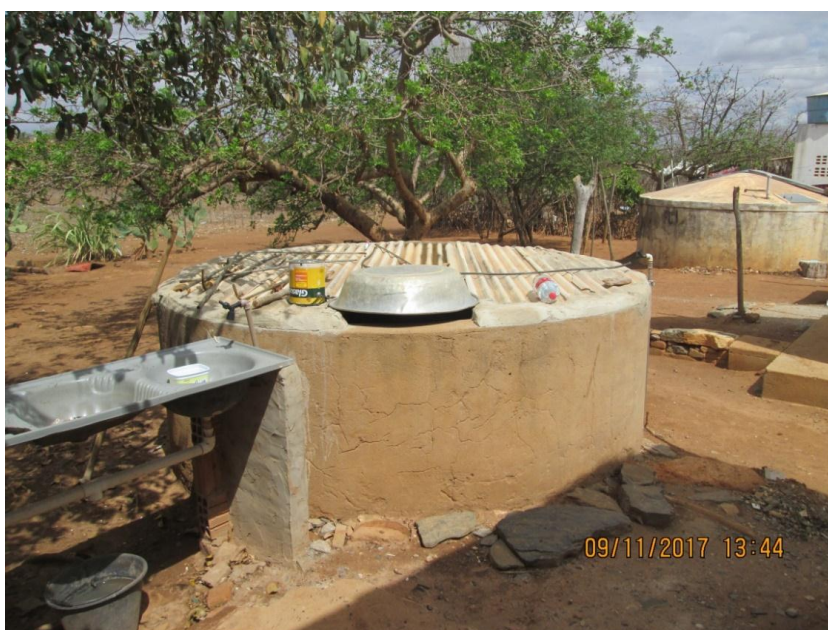
Figura 4-52 – Cisterna construída por antigo morador em Sapecado.
