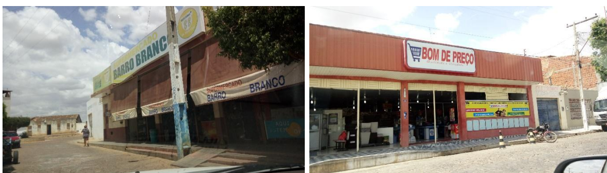
Figura 4-106 – Grandes geradores de resíduos na sede do município de Presidente Dutra
