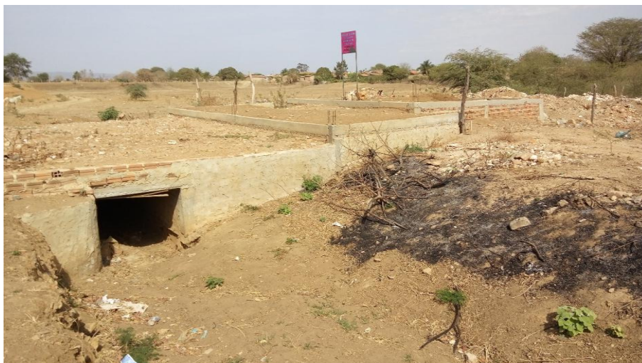
Figura 4-128 - Início da galeria, próxima da Rua José Francisco, que drena suas águas para a Lagoa Grande
