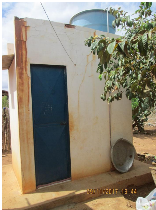
Figura 4-68 – Banheiro construído pela Associação de Moradores de Queimada e Sapecado, em Sapecado.
