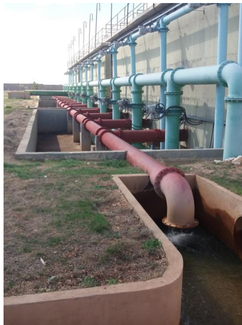
Figura 4-27 – Tubulação de recirculação da água dos filtros da ETA Rio Verde Fonte: Projeta Engenharia (2017)
