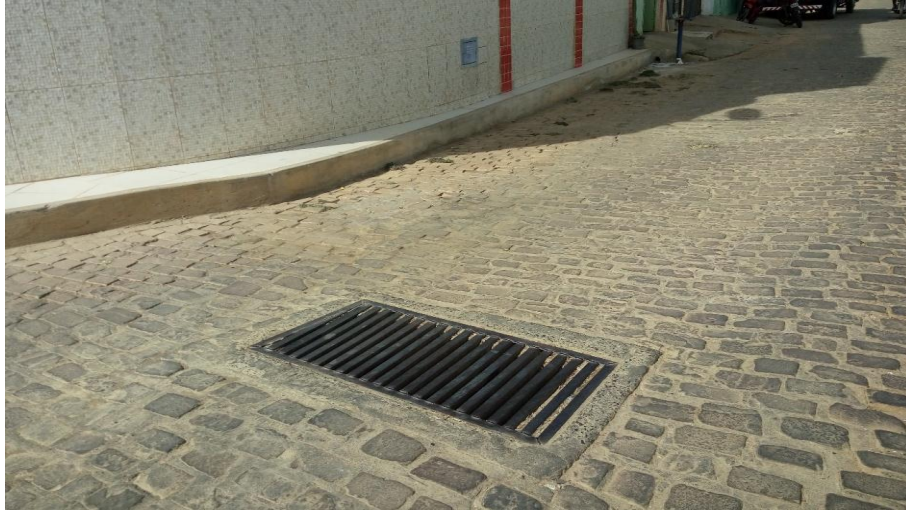
Figura 4-133 - Bueiro de captação de águas pluviais localizado a jusante do Açude
