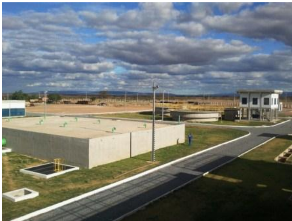
Figura 4-13 – Estação de Tratamento de Água Ibititá.
