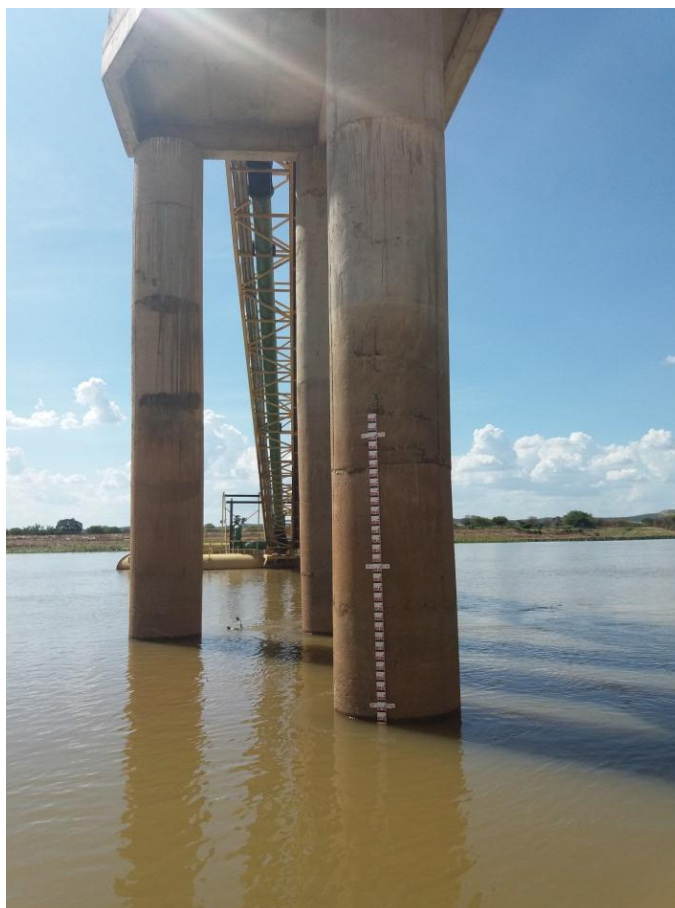
Figura 4-19 – Régua de medição do nível do Rio São Francisco.
