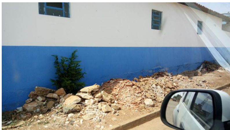
Figura 4-93 – RCC descartado atrás de escola em Campo Formoso
