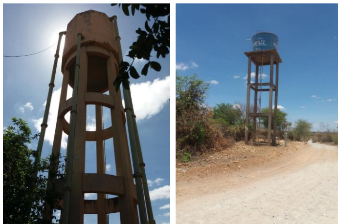
Figura 4-39 – Reservatório de Campo Formoso (à esquerda) e reservatório de Riachinho (à direita).
