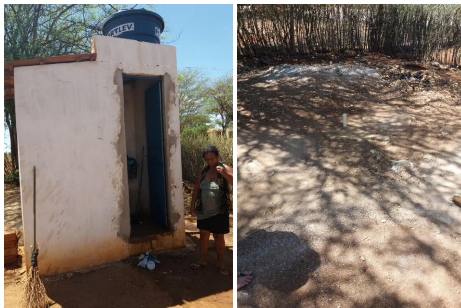
Figura 4-66 – Banheiro e tanque séptico instalados pela CODEVASF, em Matinha de Brito.
