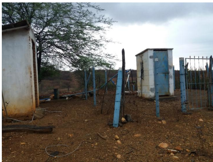
Figura 4-57 – Poço da CERB em Baixa da Saudade.
