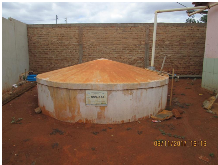
Figura 4-53 – Cisterna construída pelo P1MC em Bernardes.
