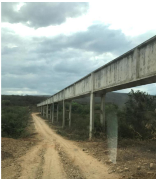
Figura 4-9 – Estrutura de tomada d’água na Barragem Mirorós.
