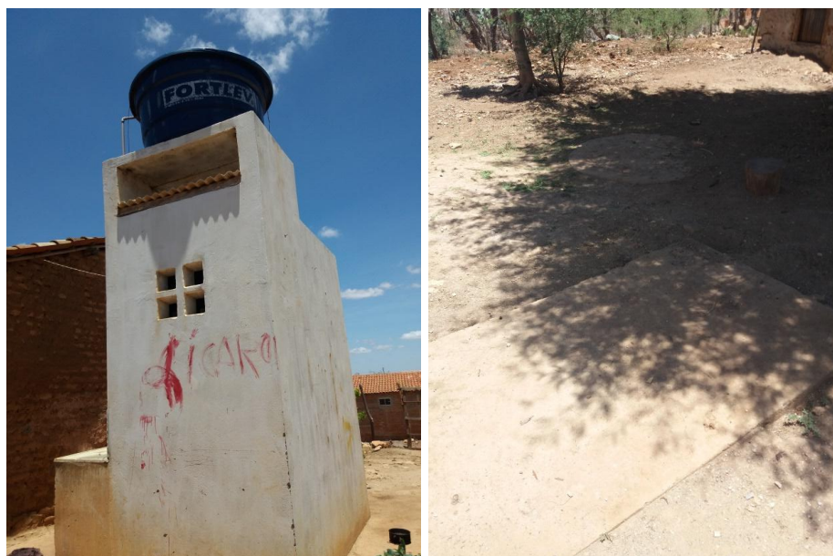
Figura 4-67 – Banheiro, tanque séptico e sumidouro instalados pela CODEVASF, em Riachinho.
