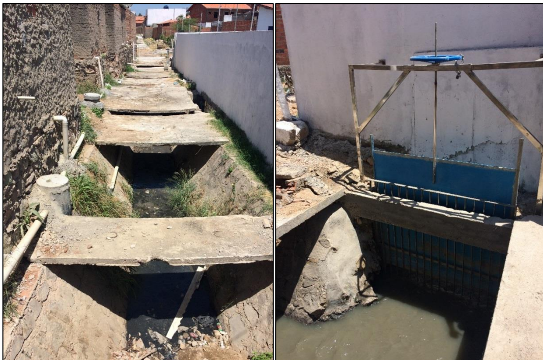
Figura 44 – Rede de drenagem que encaminha o efluente de esgoto doméstico à EEE III e comporta da EEE III.
