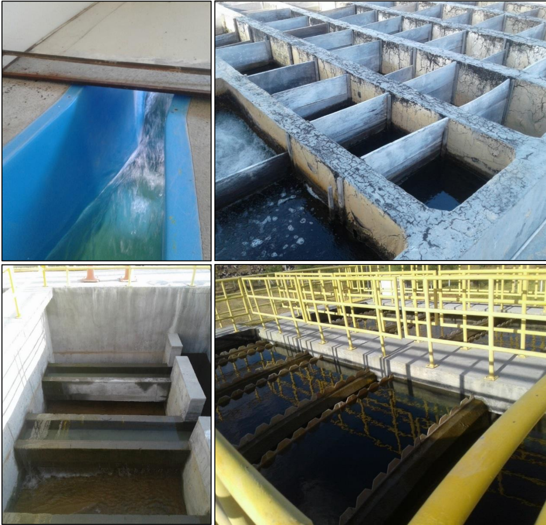
Figura 21 – Estruturas da ETA do BTN.
