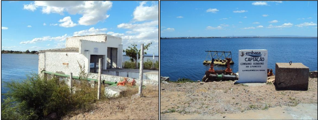
Figura 16 – Captação superficial no rio São Francisco, captação Centro (à esquerda) e captação (à direita) BTN.
