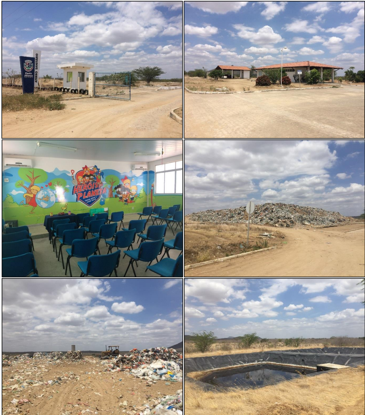
Figura 64 – Infraestrutura do aterro sanitário de Paulo Afonso.
