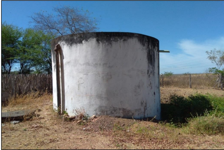
Figura 32 – RAP de 50 m 3 da comunidade de Riacho. Fonte: DRZ – Geotecnologia e Consultoria, 2017.
