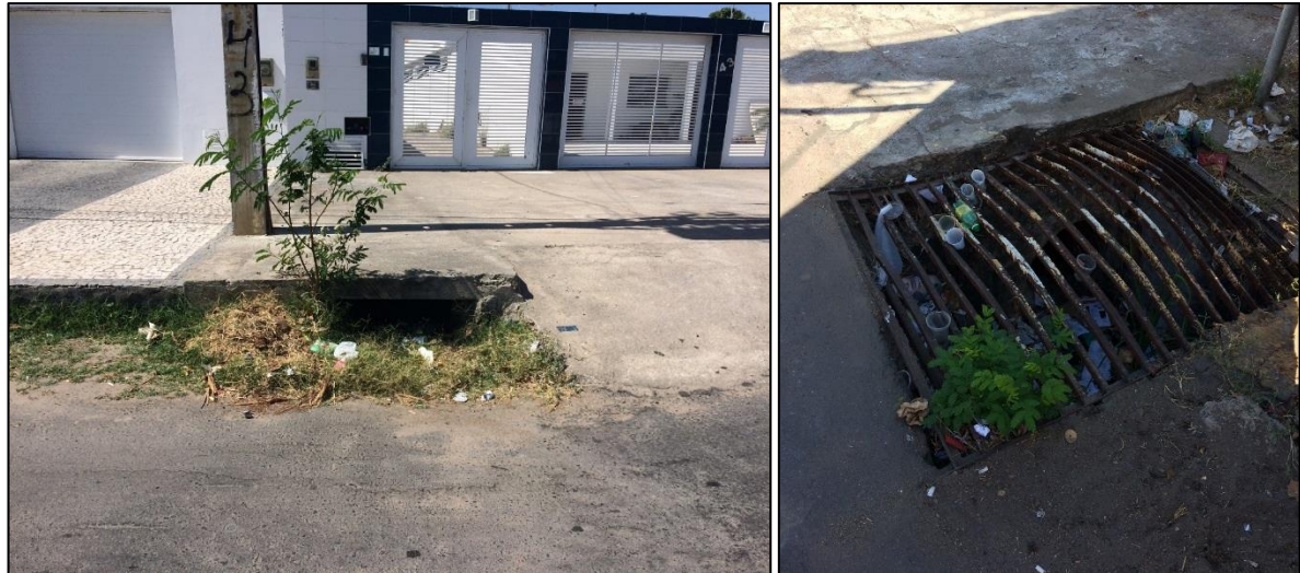
Figura 73 – Estrutura de captação lateral e grelha.
