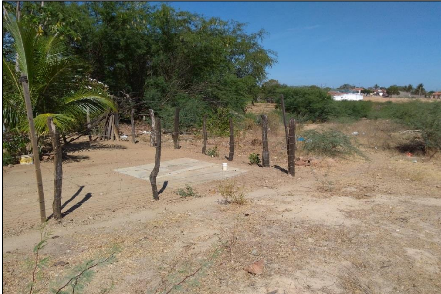
Figura 56 – Fossa séptica da Comunidade Rural de Riacho.
