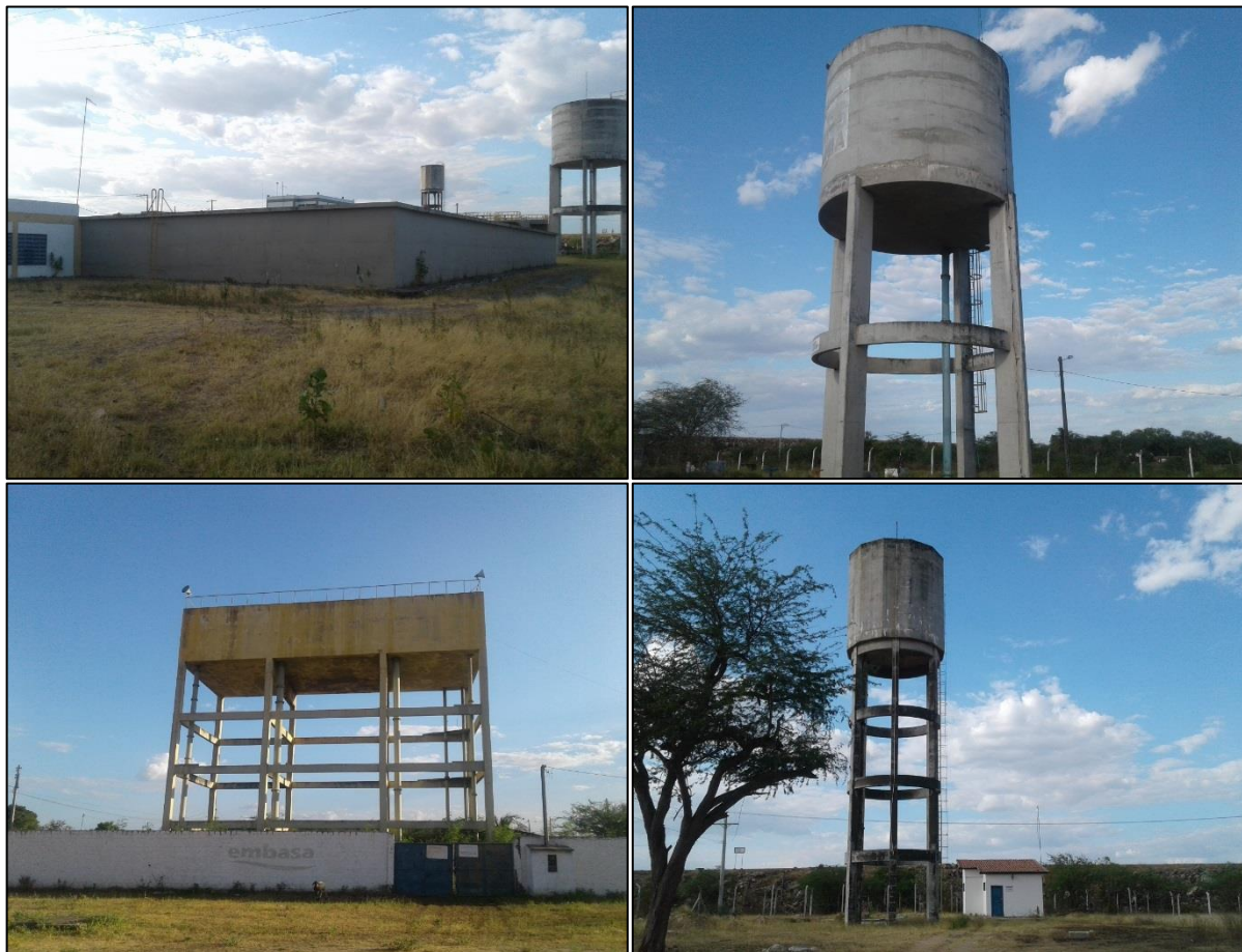
Figura 26 – Reservatórios do BTN. Fonte: DRZ – Geotecnologia e Consultoria, 2017.
