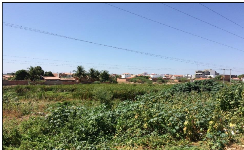
Figura 75 – Reservatório de detenção do tipo a céu aberto e não estruturado com fundo impermeabilizado - Bairro Sal Torrado.
