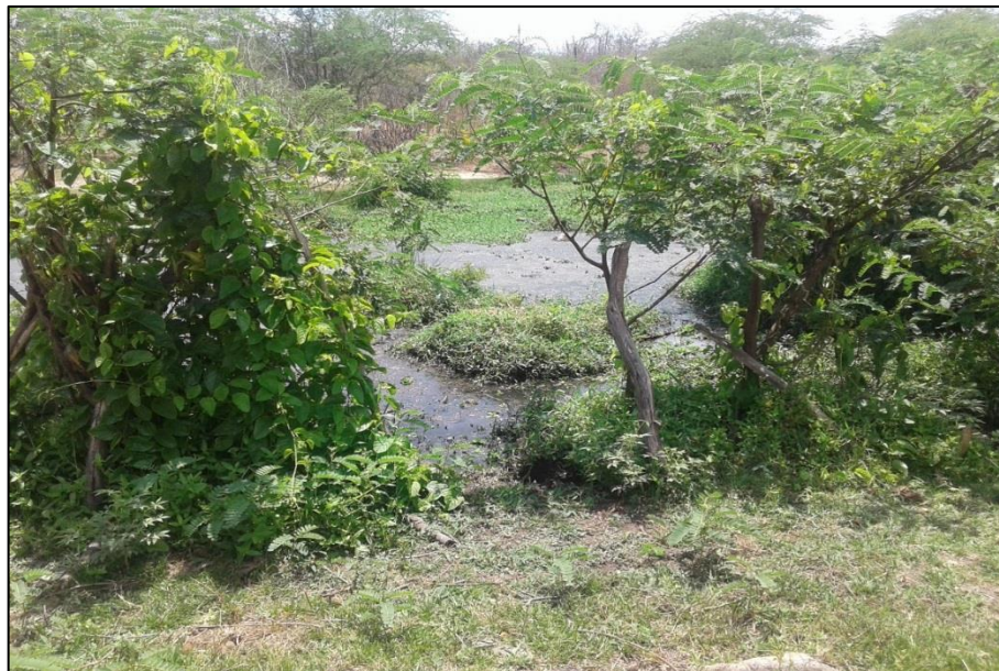
Figura 73 – Rede de drenagem utilizada irregularmente para lançamento de esgoto doméstico. Fonte: DRZ – Geotecnologia e Consultoria, 2017.
