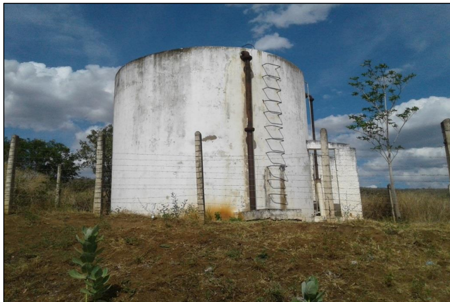
Figura 33 – Reservatório do distrito Entremontes. Fonte: DRZ – Geotecnologia e Consultoria, 2017.
