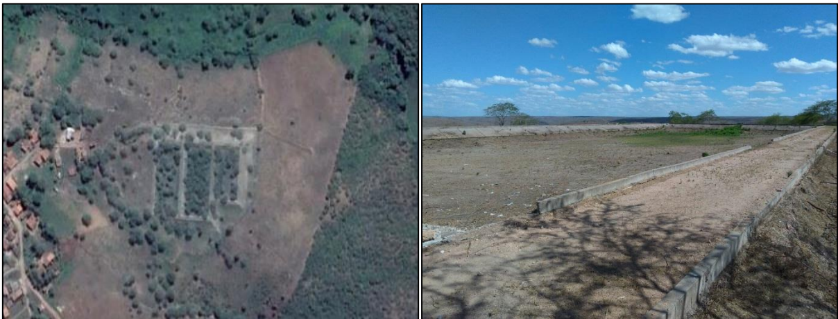
Figura 54 – Vista aérea da ETE e situação atual das lagoas de tratamento.
