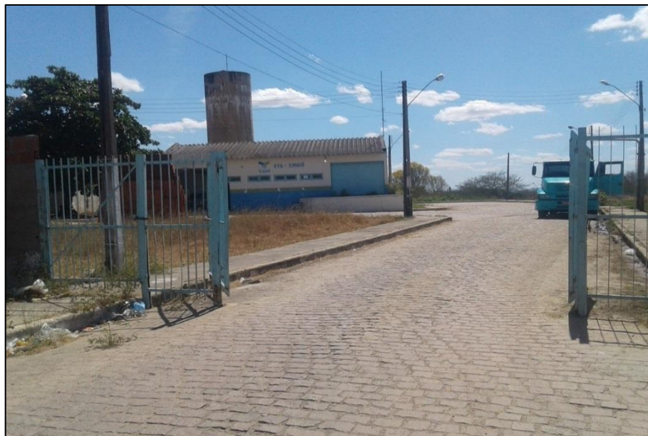
Figura 22 – Vista frontal do prédio da ETA. Fonte: DRZ – Geotecnologia e Consultoria, 2017.
