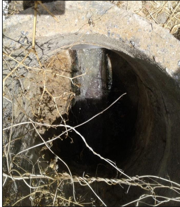
Figura 75 – Lançamento de esgoto na rede de drenagem. Fonte: DRZ – Geotecnologia e Consultoria, 2017.
