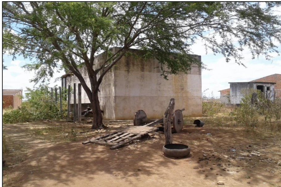
Figura 35 – RAP de concreto de 40 m 3 do distrito de Piau.
