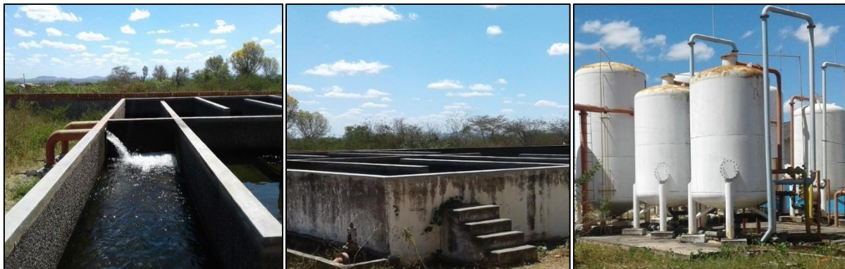
Figura 23 – Estruturas da ETA do distrito Sede. Fonte: DRZ – Geotecnologia e Consultoria, 2017.
