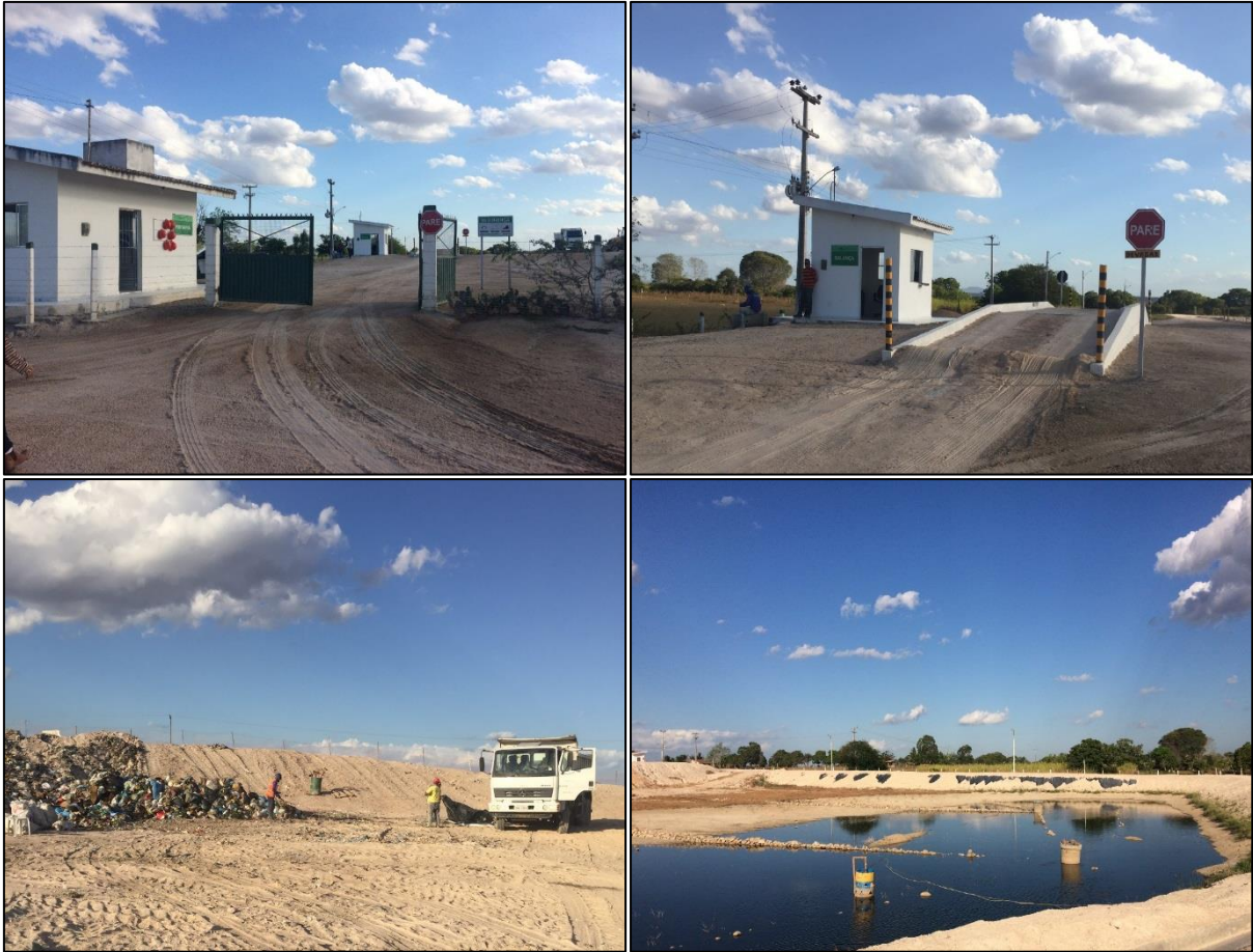
Figura 64 – Acesso à área, balança rodoviária, área de disposição e lagoa do Aterro Sanitário de Olivença.
