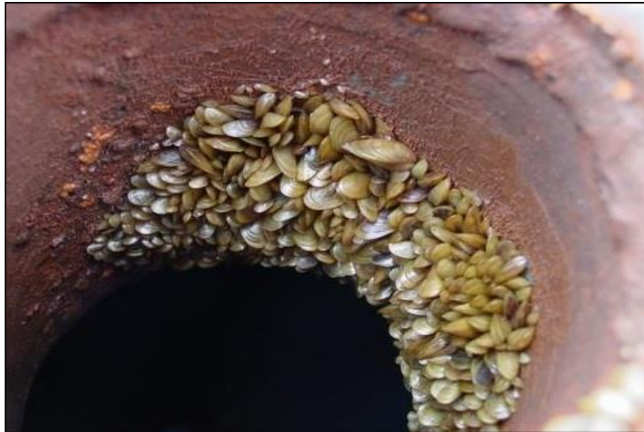
Figura 20 – Exemplo de mexilhões dourados presentes em tubulações. Fonte: http://www.ebanataw.com.br/mexilhaodourado/mexilhaodourado.php , 2006.
