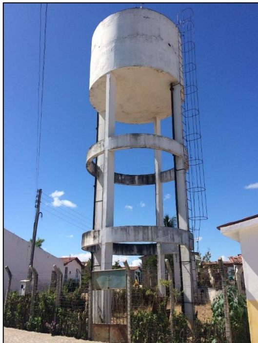
Figura 44 – Reservatório elevado da comunidade Cedro. Fonte: DRZ – Geotecnologia e Consultoria, 2017.
