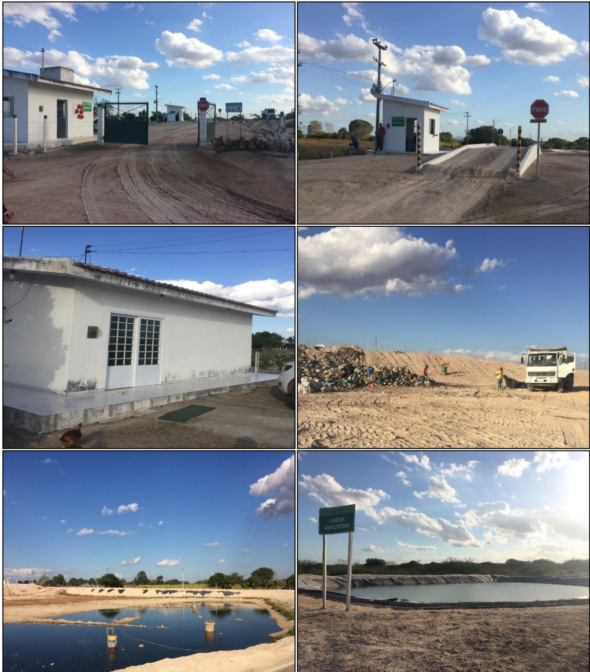
Figura 58 – Aterro sanitário de Olivença. Fonte: DRZ – Geotecnologia e Consultoria, 2017.
