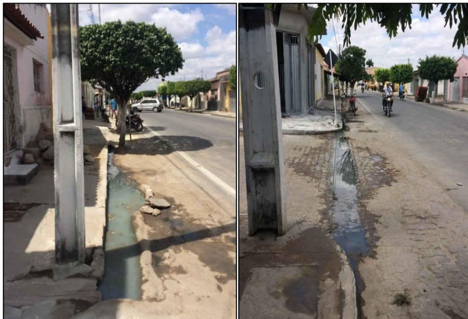
Figura 49 – Lançamento irregular de esgoto nas vias públicas do distrito Sede.
