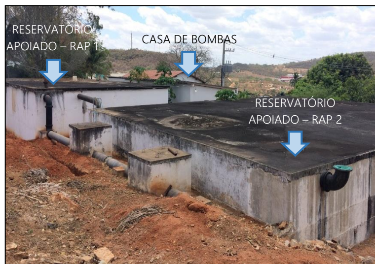
Figura 29 – Reservatórios do sistema de Santana do Ipanema. Fonte: DRZ – Geotecnologia e Consultoria, 2017.
