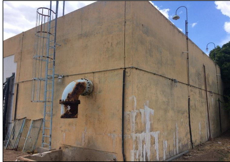
Figura 25 – Reservatório da EEA-I. Fonte: DRZ – Geotecnologia e Consultoria, 2017.
