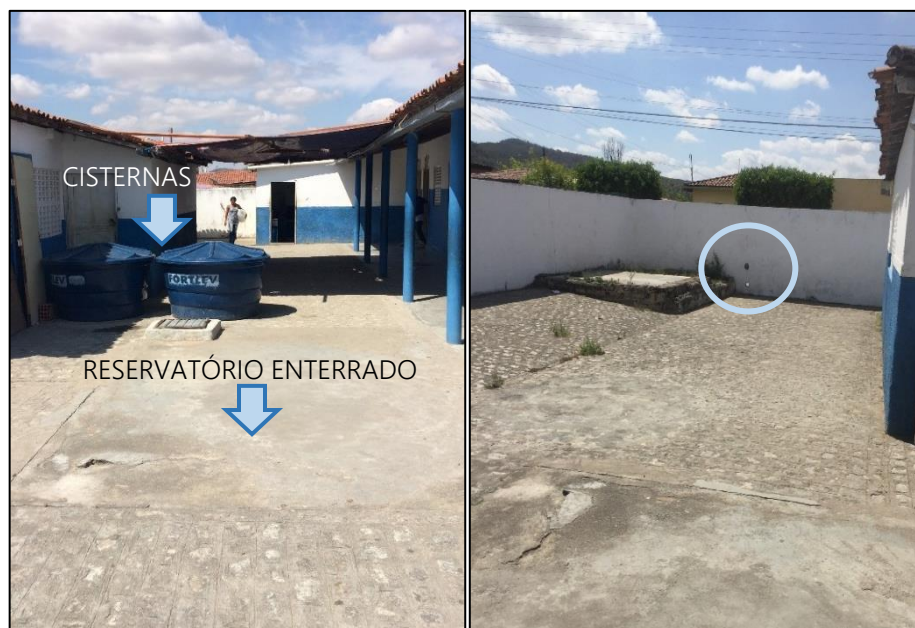
Figura 46 – Reservatório enterrado e cisternas para abastecimento com caminhão pipa.
