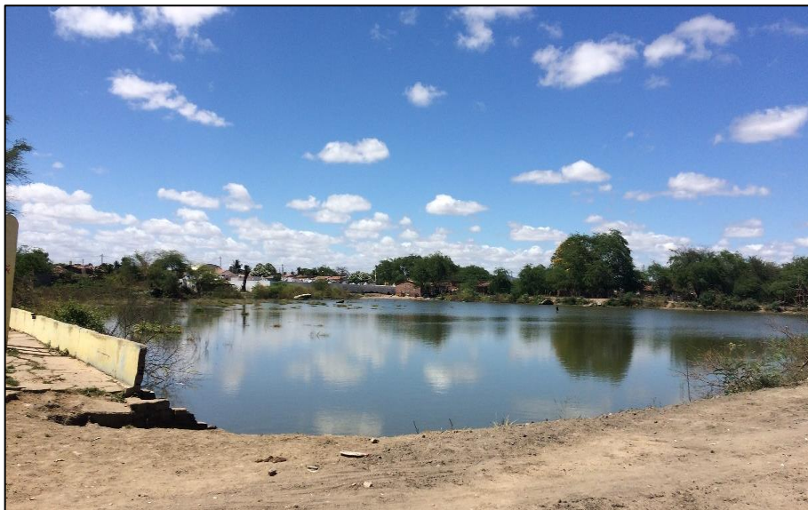
Figura 50 – Lagoa que recebe lançamento de esgoto e de água pluvial no distrito Sede. Fonte: DRZ – Geotecnologia e Consultoria, 2017.
