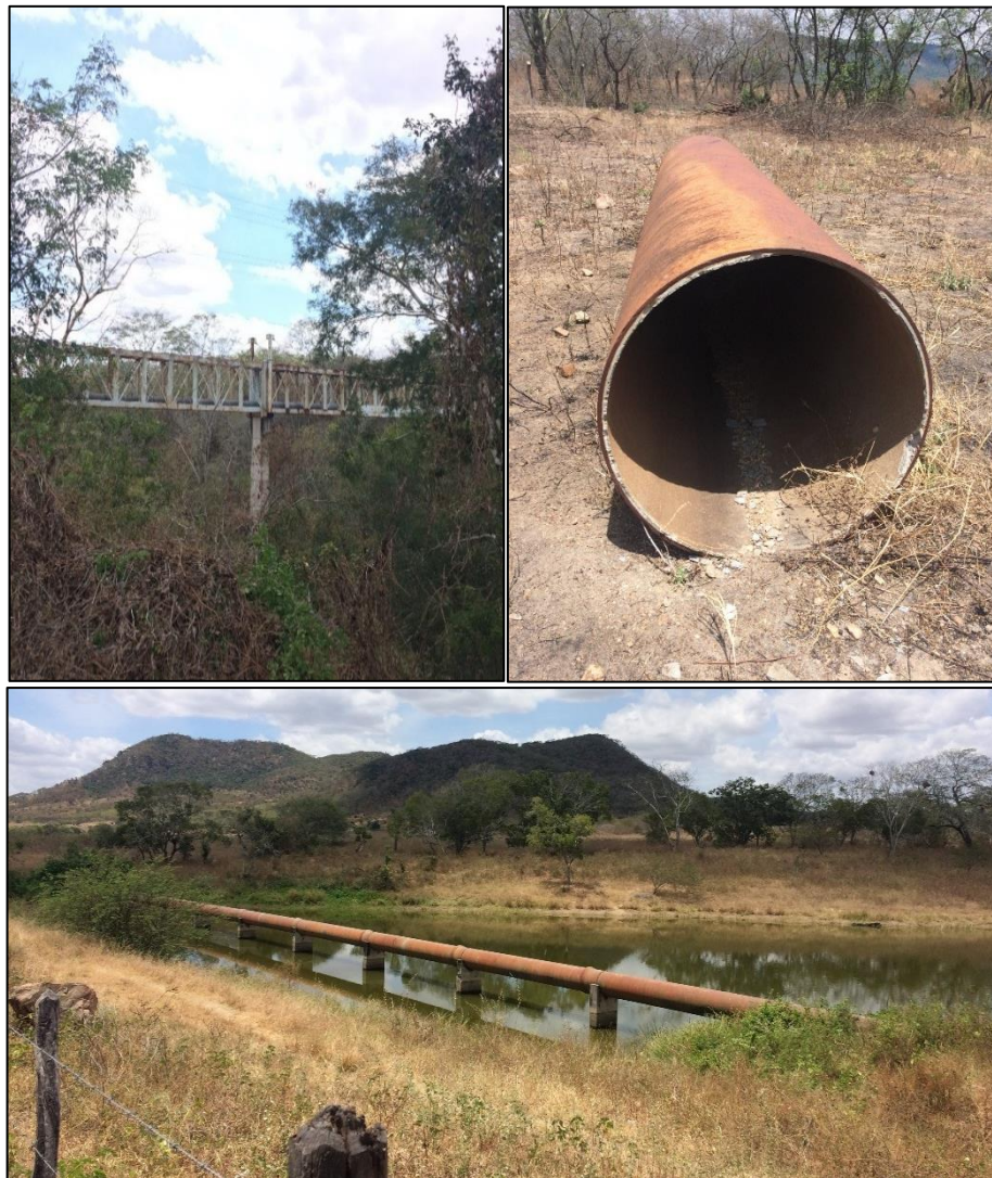
Figura 22 – Adutora de água e tubulação utilizada. Fonte: DRZ – Geotecnologia e Consultoria, 2017.
