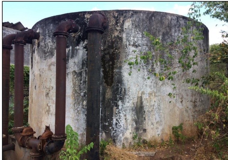
Figura 37 – Reservatório apoiado do distrito Sede.
