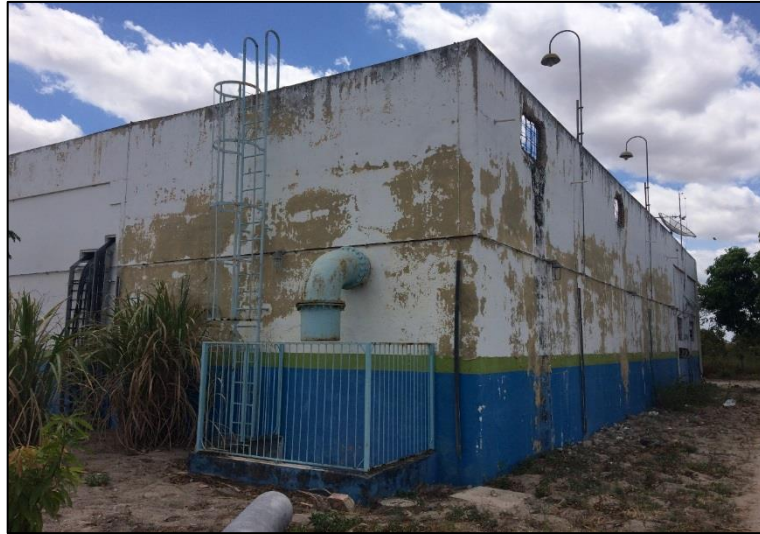
Figura 27 – Reservatório da EEAT II. Fonte: DRZ – Geotecnologia e Consultoria, 2017.
