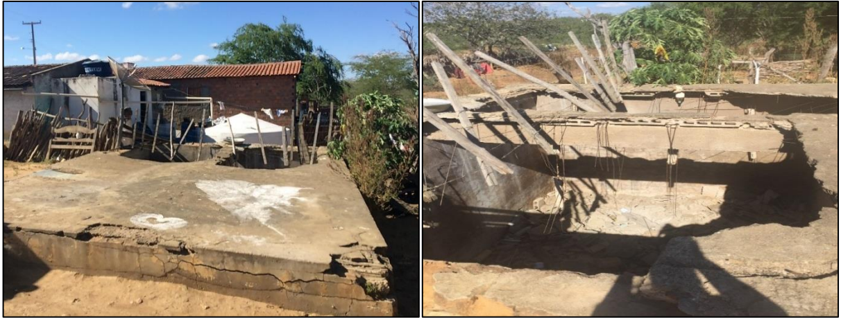
Figura 41 – Cisterna pública da comunidade Capiá Novo.
