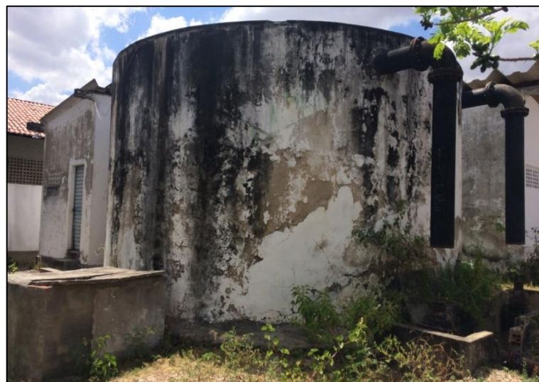
Figura 31 – Reservatório da EEAT IV. Fonte: DRZ – Geotecnologia e Consultoria, 2017.
