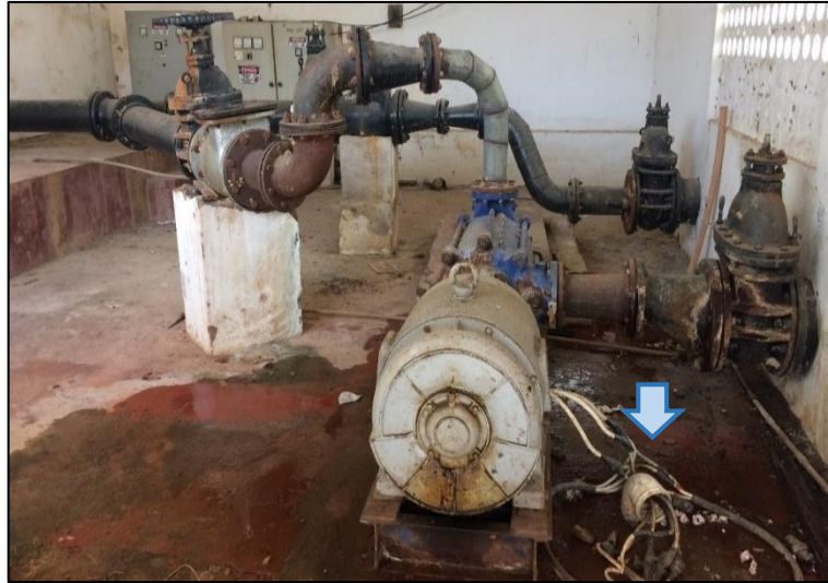
Figura 33 – Casa de bombas da EEAT IV. Fonte: DRZ – Geotecnologia e Consultoria, 2017.
