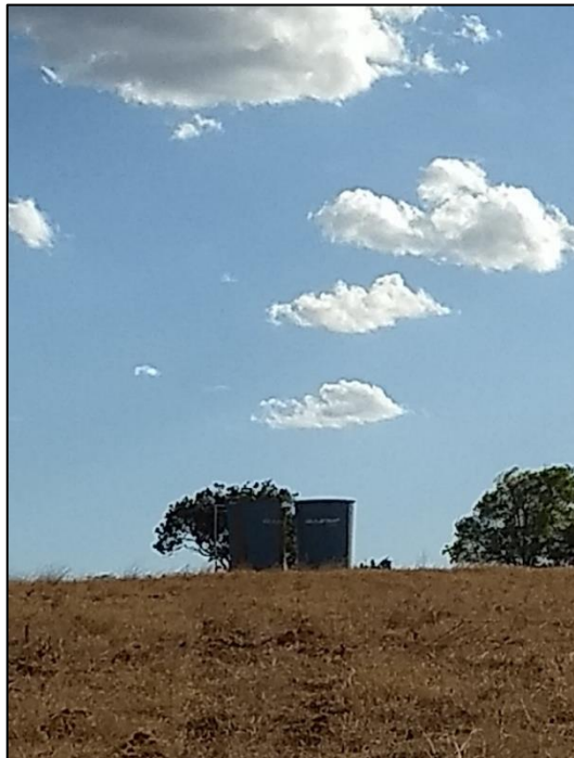
Figura 66 – Reservatórios da comunidade Riacho São José. Fonte: DRZ – Geotecnologia e Consultoria, 2017.
