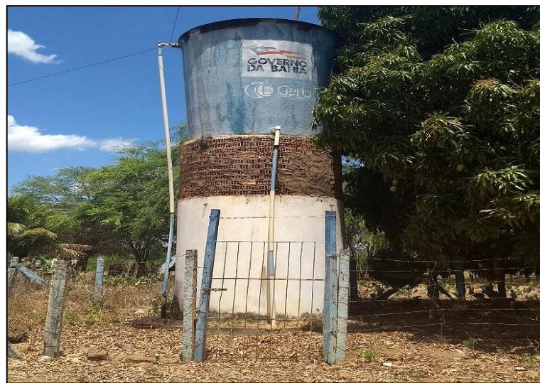
Figura 57 – Reservatório antigo da comunidade Brancos.
