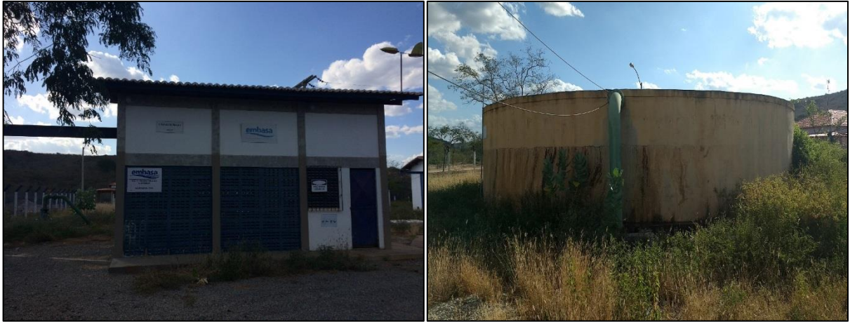
Figura 26 – Casa de cloração e caixa de reunião (RAP de 300 m 3 ) existente na área do Poço 01. Fonte: DRZ – Geotecnologia e Consultoria, 2017.
