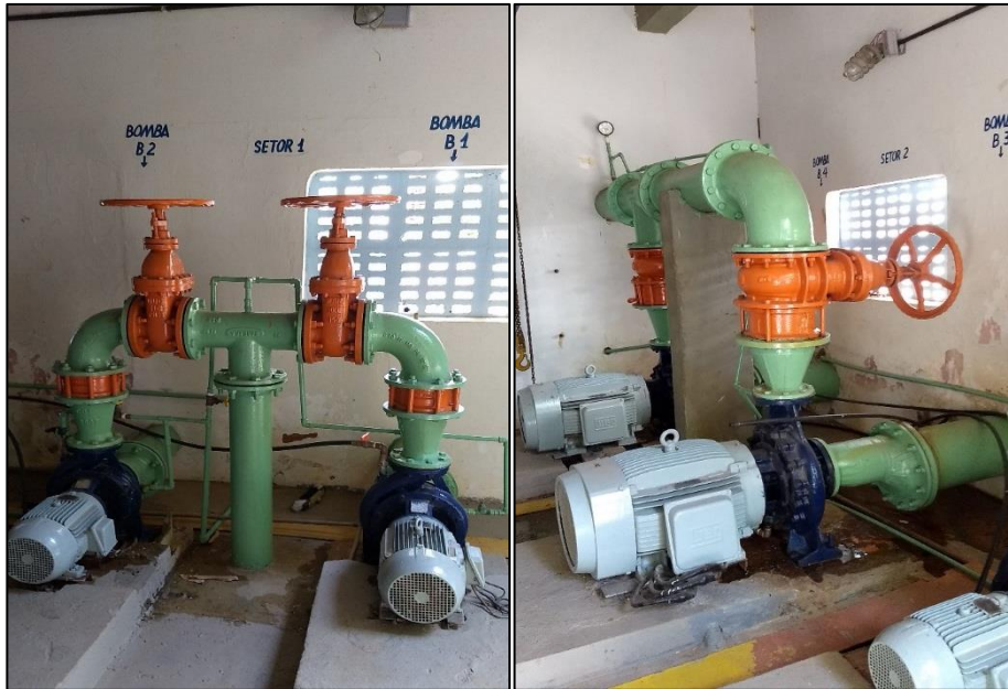
Figura 37 – Bombas principais e reservas da EEAT 1 e da EEAT 2. Fonte: DRZ – Geotecnologia e Consultoria, 2017.
