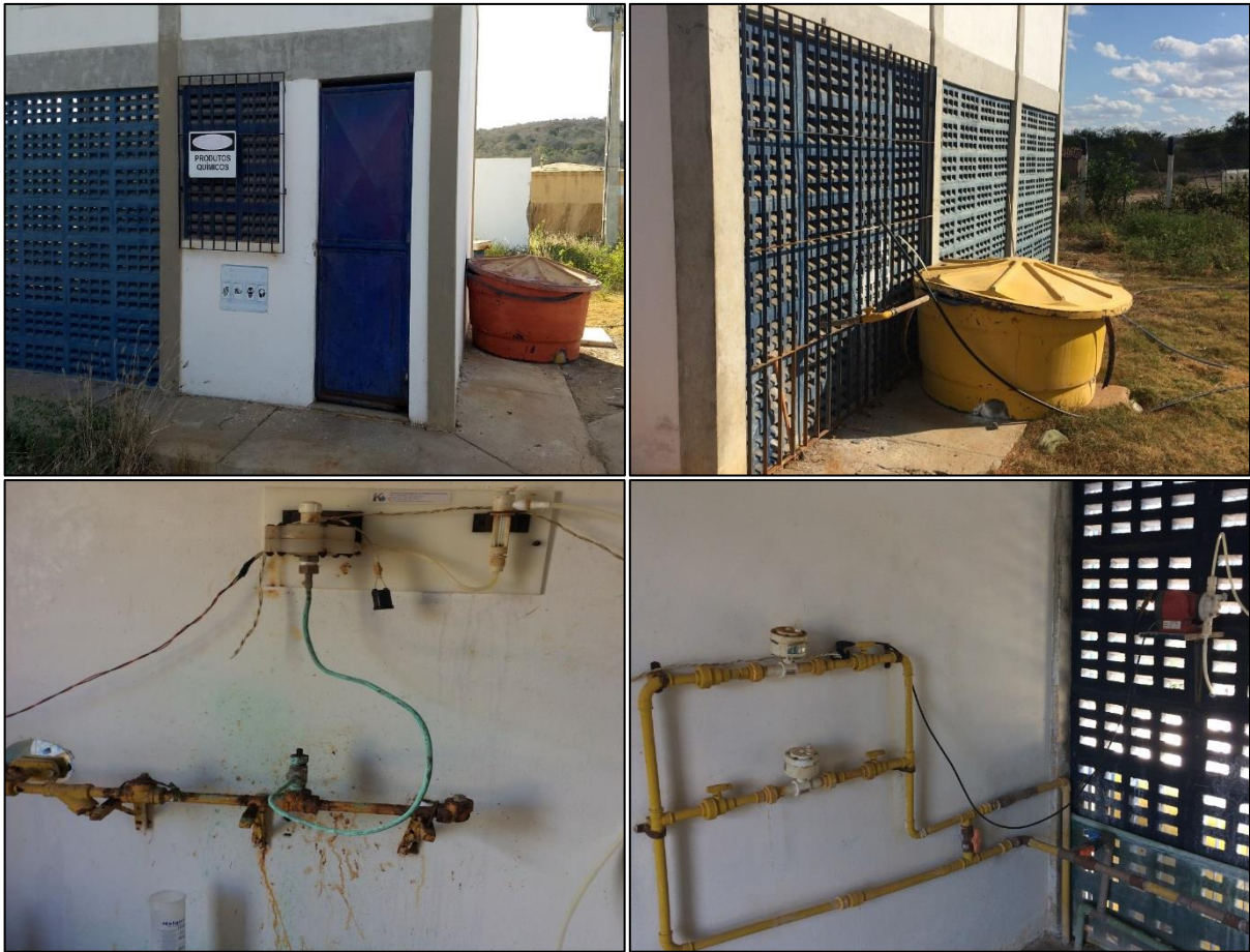
Figura 27 – Aplicação de produtos químicos na água subterrânea. Fonte: DRZ – Geotecnologia e Consultoria, 2017.
