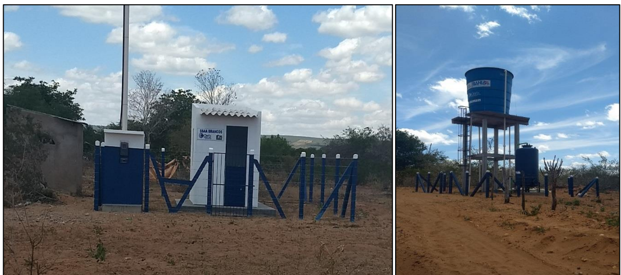
Figura 58 – Área do novo poço e novo reservatório da comunidade Brancos.
