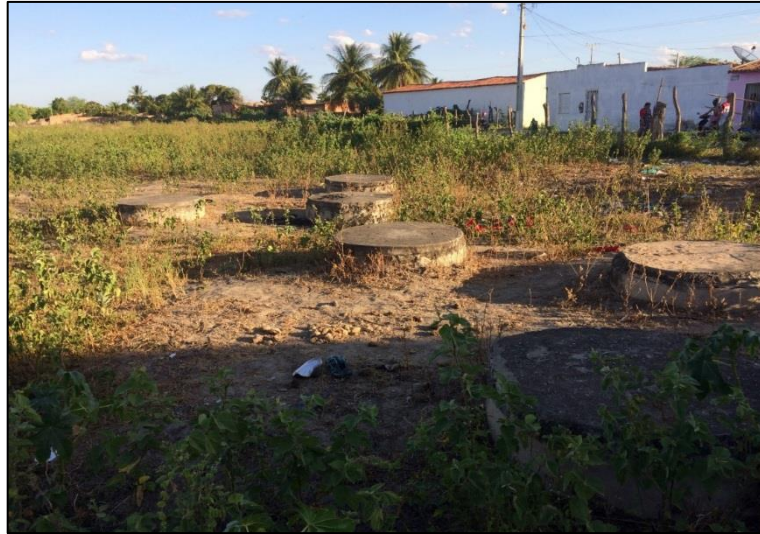
Figura 67 – Antigo sistema de tratamento de esgoto, conjunto de fossas. Fonte: DRZ – Geotecnologia e Consultoria, 2017.
