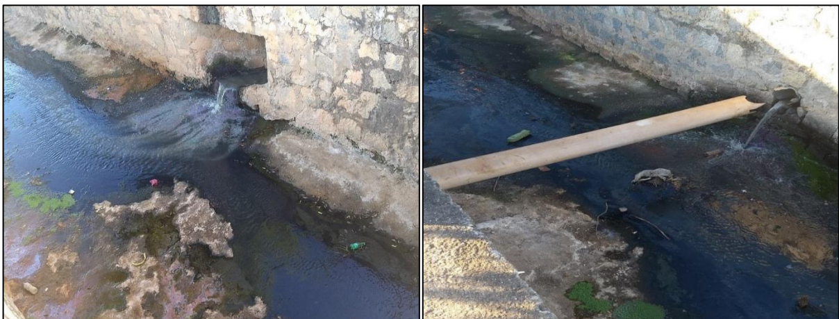
Figura 72 – Lançamento irregular de esgoto nos canais de drenagem pluvial. Fonte: DRZ – Geotecnologia e Consultoria, 2017.
