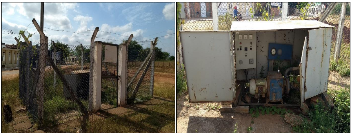
Figura 38 – Estação elevatória de água tratada, booster Romão. Fonte: DRZ – Geotecnologia e Consultoria, 2017.
