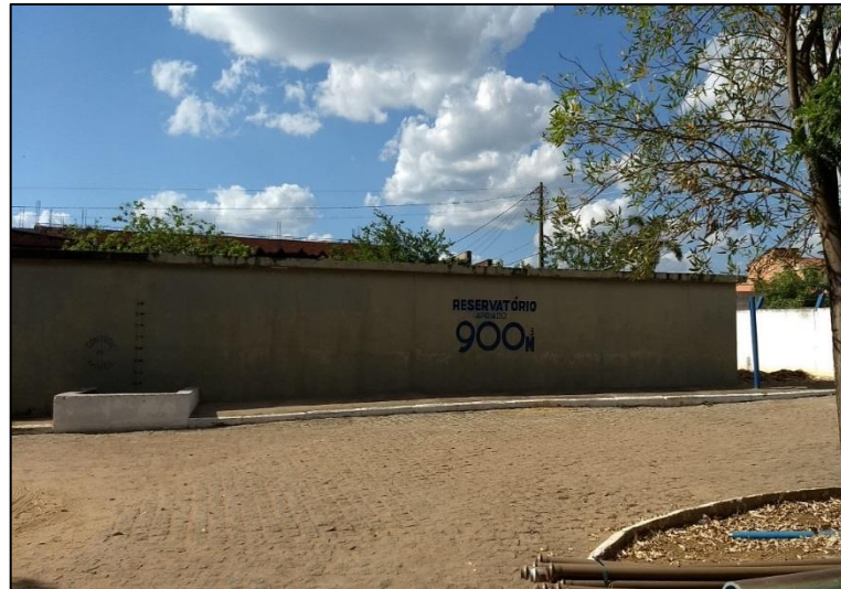
Figura 31 – Reservatório Apoiado (RAP) de 900 m 3 . Fonte: DRZ – Geotecnologia e Consultoria, 2017.
