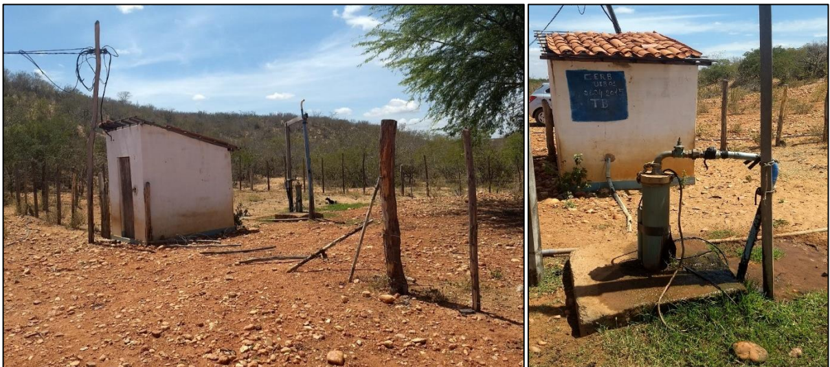
Figura 47 – Poço do distrito Canché. Fonte: DRZ – Geotecnologia e Consultoria, 2017.
