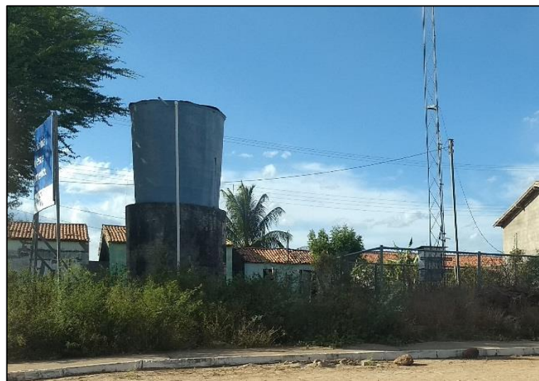
Figura 62 – Reservatório da comunidade Cordão.
