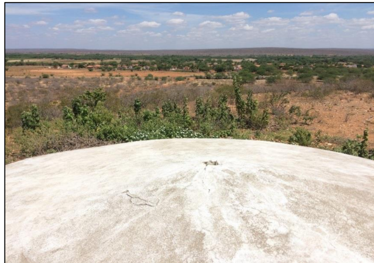
Figura 49 – Vista do distrito do alto do reservatório.
