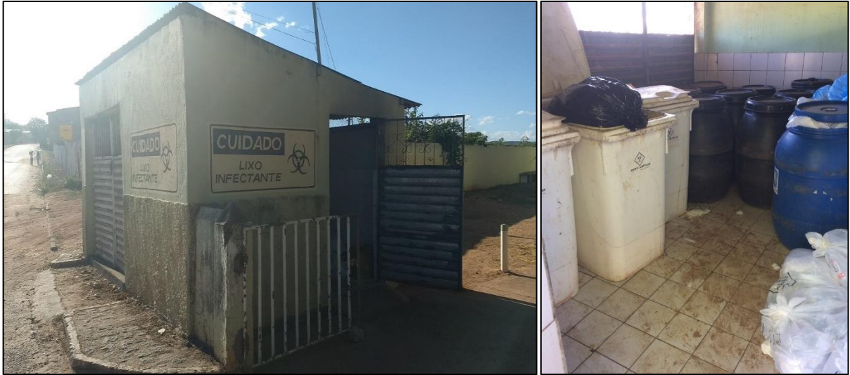
Figura 126 – Local de acondicionamento temporário dos resíduos de serviços de saúde no hospital municipal.
