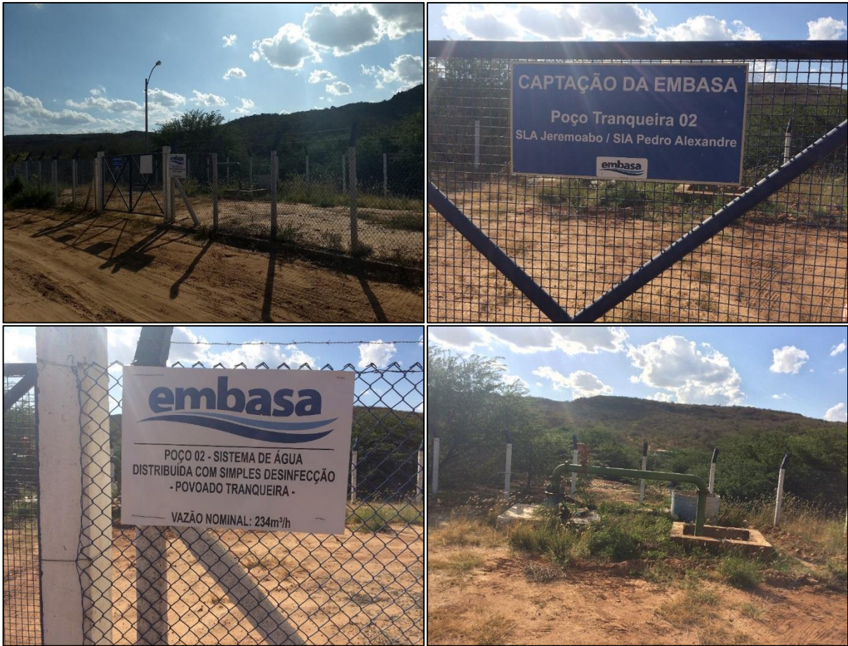
Figura 23 – Poço Tranqueira 02. Fonte: DRZ – Geotecnologia e Consultoria, 2017.
