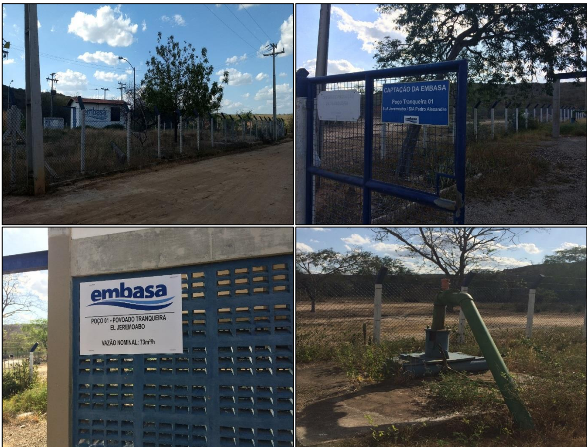
Figura 22 – Poço Tranqueira 01. Fonte: DRZ – Geotecnologia e Consultoria, 2017.
