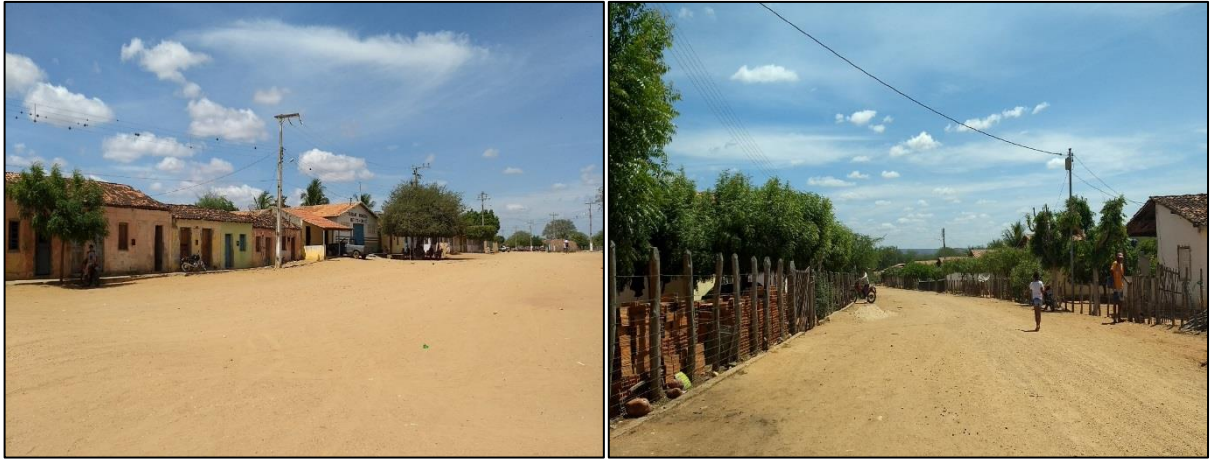
Figura 134 – Ausência de pavimentação no distrito Canché. Fonte: DRZ – Geotecnologia e Consultoria, 2017.
