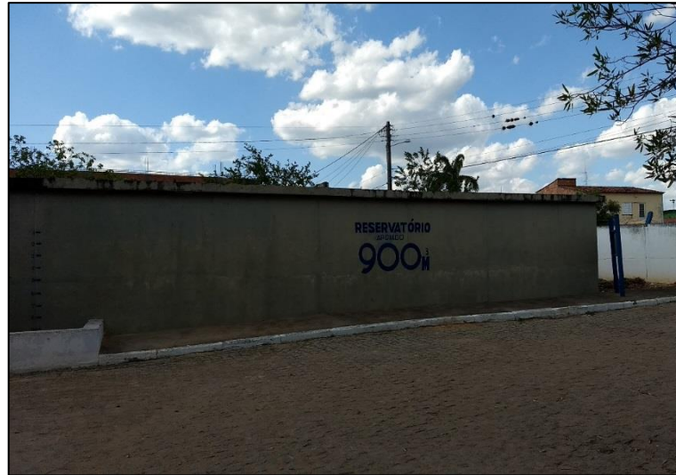
Figura 41 – Reservatório apoiado (RAP), 900 m 3 . Fonte: DRZ – Geotecnologia e Consultoria, 2017.
