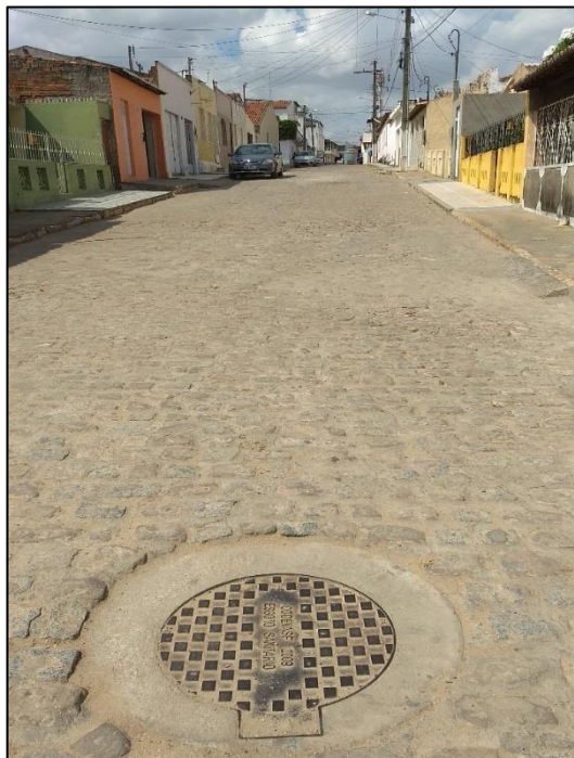
Figura 70 – PV da rede coletora de esgoto sanitário não finalizada no distrito Sede.
