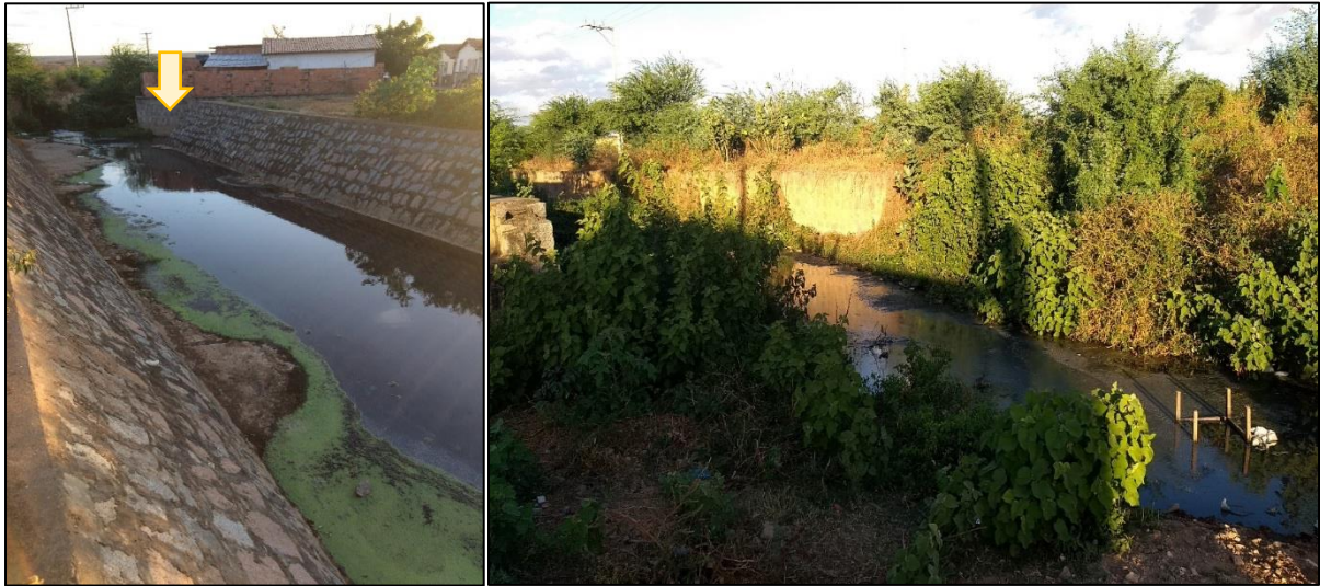
Figura 141 – Encontro dos dois canais e ponto final da obra dos canais de drenagem.
