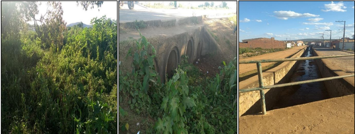
Figura 138 – Trecho inicial do canal de drenagem do Rio Vermelho.
