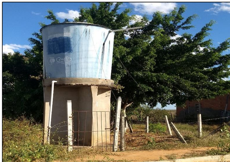
Figura 65 – Reservatório da comunidade Residência. Fonte: DRZ – Geotecnologia e Consultoria, 2017.
