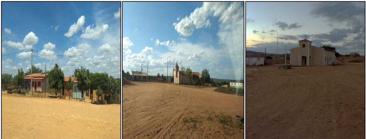
Figura 135 – Ausência de pavimentação nas comunidades rurais: Brejo Grande, Caritá e Monte Alegre. Fonte: DRZ – Geotecnologia e Consultoria, 2017.
