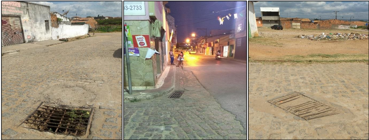
Figura 132 – Exemplos de estrutura de captação de água pluvial (bocas de lobo) nas ruas de Jeremoabo.
