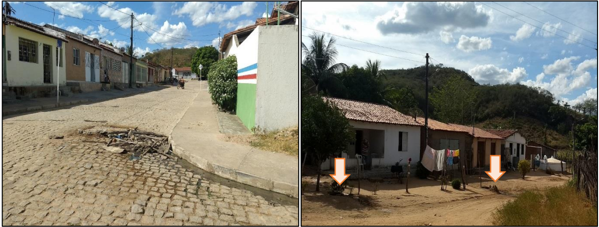
Figura 81 – Lançamento de esgoto em via pública na comunidade Lagoa do Inácio.
