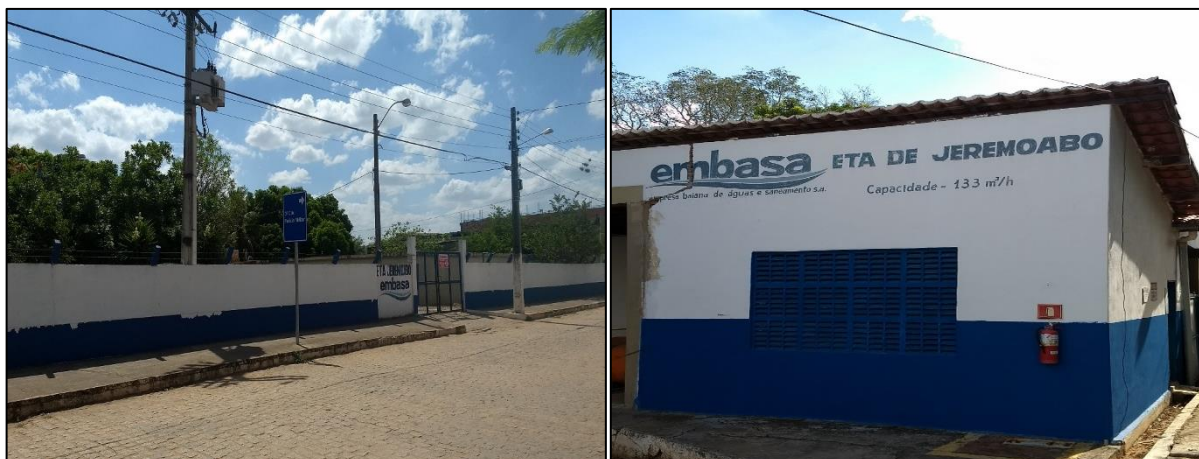
Figura 28 – Estação de tratamento de água de Jeremoabo.
