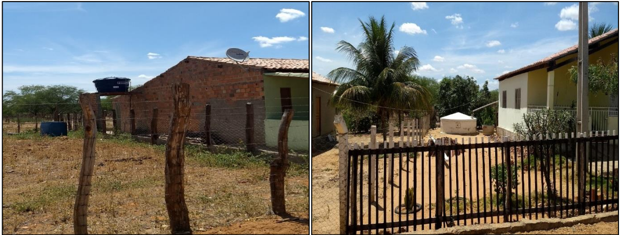
Figura 50 – Exemplo de reservação individual e cisterna no distrito Canché.
