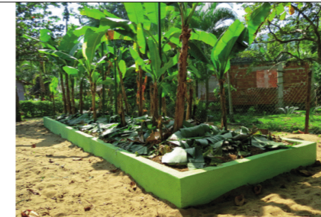
FIGURA 2. Fossa verde ou BET instalada na Praia do Sono, Paraty/RJ. Fonte: otss.org.br/saneamento-ecologico.
