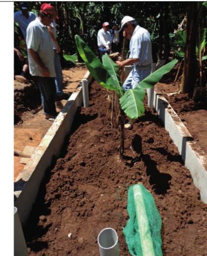
FIGURA 4. Preenchimento da camada de terra e plantio das bananeiras. Abaixo é possível ver o "ladrão" de tubo PVC perfurado e envolto por tela de mosquiteiro (Foto: Luana Cruz).
