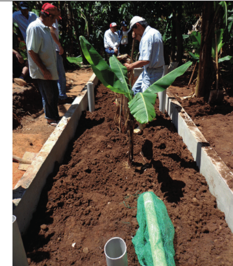
FIGURA 4. Preenchimento da camada de terra e plantio das bananeiras. Abaixo é possível ver o "ladrão" de tubo PVC perfurado e envolto por tela de mosquito (Foto: Luana Cruz).
