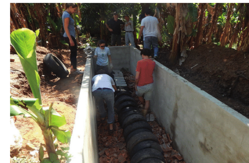
FIGURA 3. Construção da câmara de pneus e da camada de entulho (Foto: Bárbara Silva).
