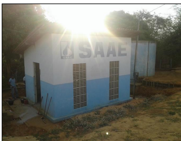
Figura 47 – Casa da bomba de recalque do povoado Cuscuzeiro. Fonte: DRZ – Geotecnologia e Consultoria, 2017.
