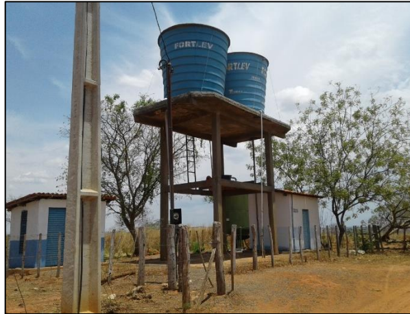
Figura 44 – ETA com REL 1, REL 2 e filtro russo do povoado Caniveta. Fonte: DRZ – Geotecnologia e Consultoria, 2017.
