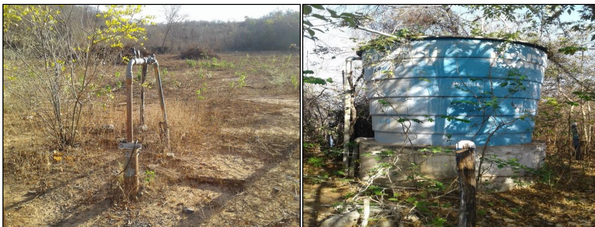
Figura 39 – Captação (2) de poço e REL 2 do povoado Água Quente. Fonte: DRZ – Geotecnologia e Consultoria, 2017.
