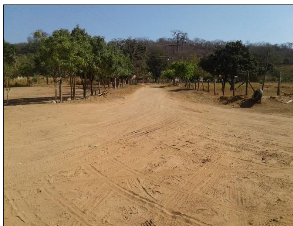
Figura 103 - Local na Comunidade Rural de Água Quente com histórico de alagamento. Fonte: DRZ – Geotecnologia e Consultoria, 2017.
