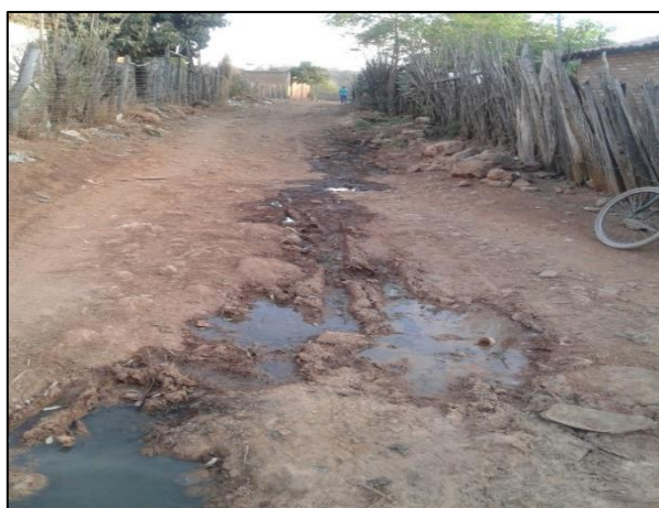
Figura 73 – Lançamento de esgoto em via pública. Fonte: DRZ Geotecnologia e Consultoria, 2017.
