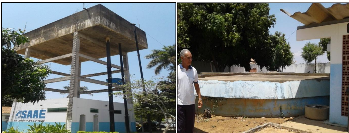
Figura 26 – R1 – Reservatório Elevado e Reservatório Enterrado. Fonte: DRZ – Geotecnologia e Consultoria, 2017.
