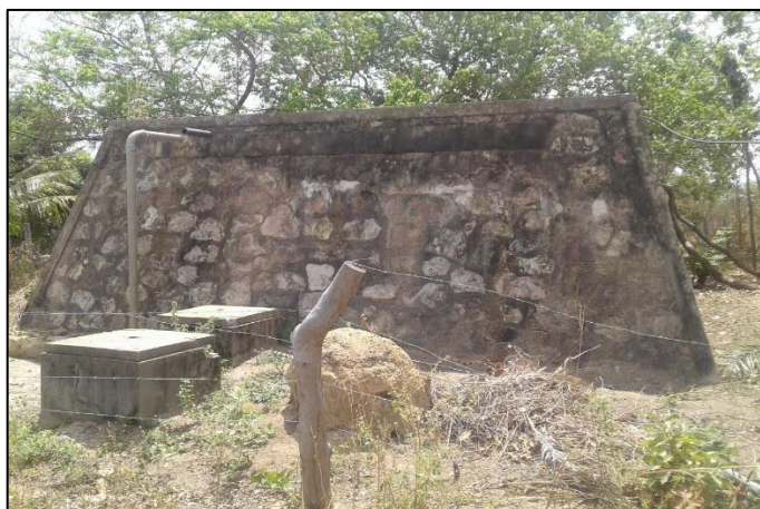
Figura 35 – RAP de pedra do distrito de Inhaúmas. Fonte: DRZ – Geotecnologia e Consultoria, 2017.
