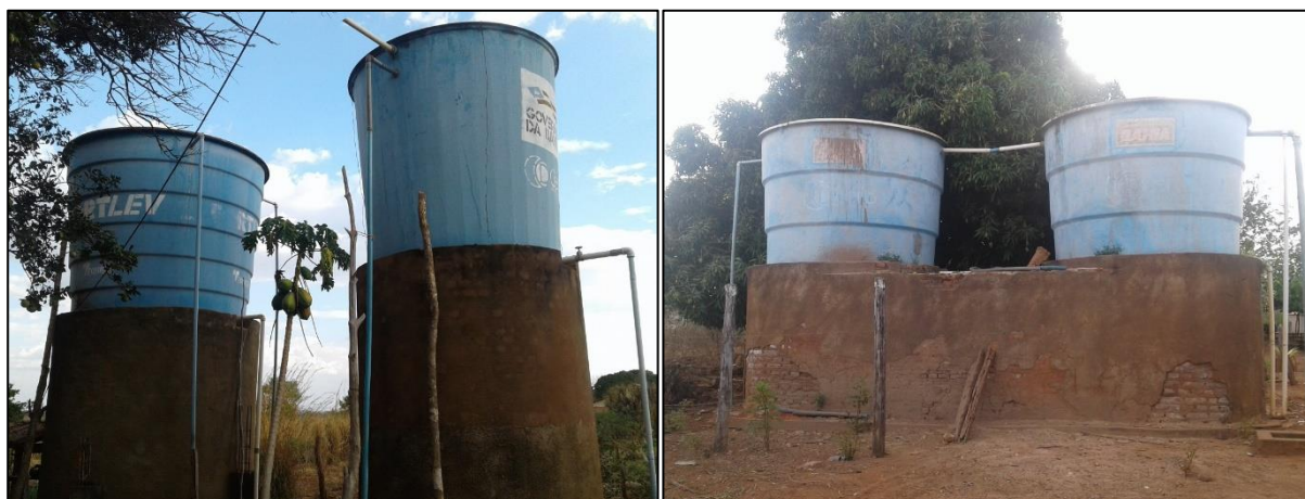
Figura 59 – REL 1, 2, 3 e 4 de fibra de vidro do povoado de Ponte Velha. Fonte: DRZ – Geotecnologia e Consultoria, 2017.
