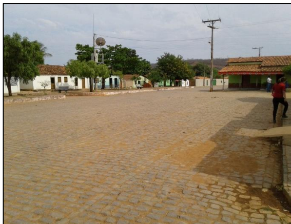
Figura 102 - Local na Comunidade Rural de Nova Franca com histórico de alagamento. Fonte: DRZ – Geotecnologia e Consultoria, 2017.
