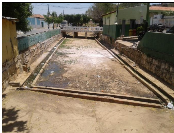
Figura 97 - Canal de macrodrenagem do Distrito Sede. Fonte: DRZ – Geotecnologia e Consultoria, 2017.
