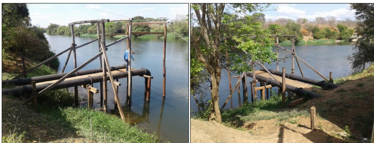
Figura 18 – Captação superficial e sua área entorno, no Rio Corrente - Distrito Sede. Fonte: DRZ – Geotecnologia e Consultoria, 2017.
