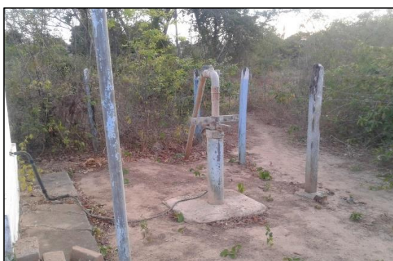
Figura 28 – Captação de poço do distrito de Açudina.
