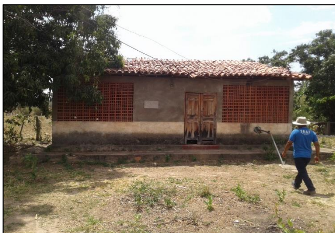
Figura 34 – Estação elevatória (EEA) do distrito de Inhaúmas. Fonte: DRZ – Geotecnia e Consultoria, 2017.
