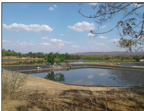
Figura 67 - Lagoas de Tratamento – ETE Fonte: DRZ Geotecnologia e Consultoria, 2017.
