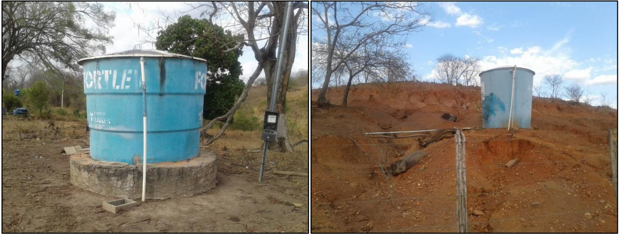
Figura 60 – RAP 1 e 2 de fibra de vidro do povoado Ponte Velha. Fonte: DRZ – Geotecnologia e Consultoria, 2017.
