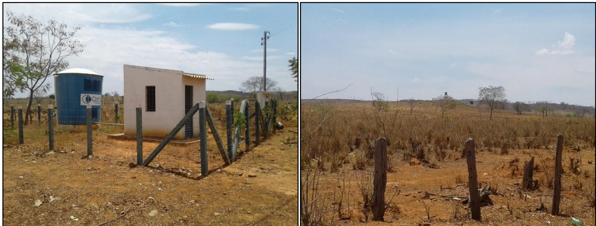
Figura 45 – RAP de fibra de vidro de 10 m 3 e REL de fibra de vidro de 20 m 3 do povoado de Caniveta. Fonte: DRZ – Geotecnologia e Consultoria, 2017.
