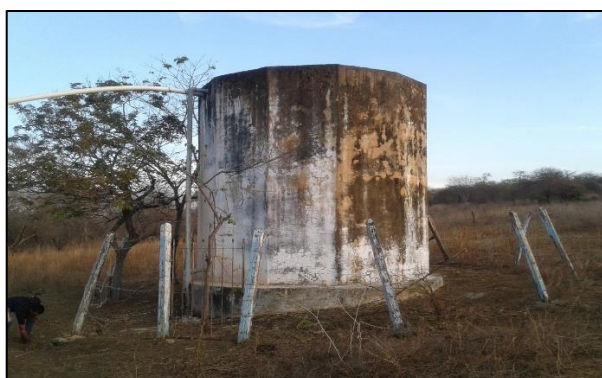
Figura 29 – RAP de concreto do distrito de Açudina.
