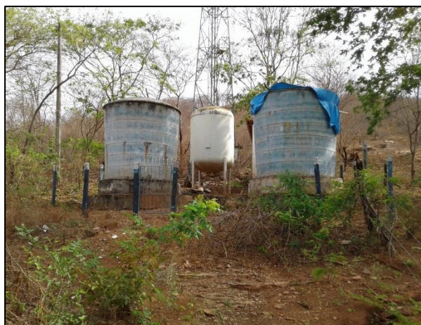
Figura 56 – RAP 1 e RAP 2 de fibra de vidro do povoado de Nova Franca. Fonte: DRZ – Geotecnologia e Consultoria, 2017.
