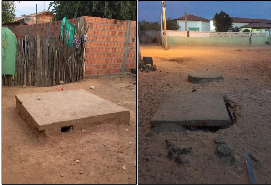
Figura 98 – Exemplos de fossas rudimentares na comunidade Marreca Velha. Fonte: DRZ – Geotecnologia e Consultoria, 2017.
