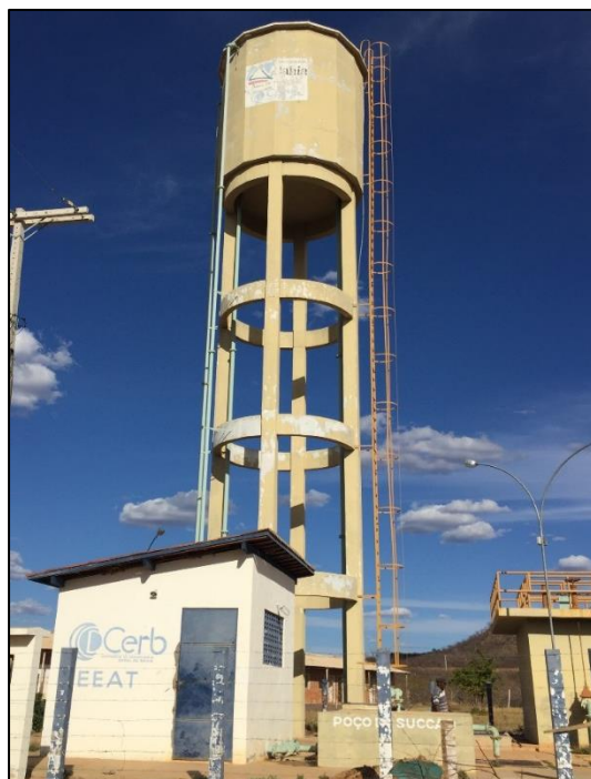
Figura 49 – Reservatório da comunidade Boa Vista. Fonte: DRZ – Geotecnologia e Consultoria, 2017.
