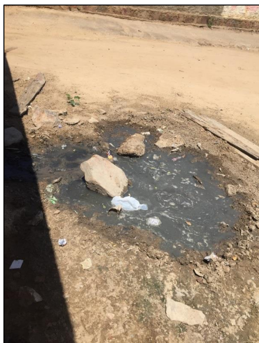
Figura 101 – Acúmulo de esgoto em via pública na comunidade Utinga.
