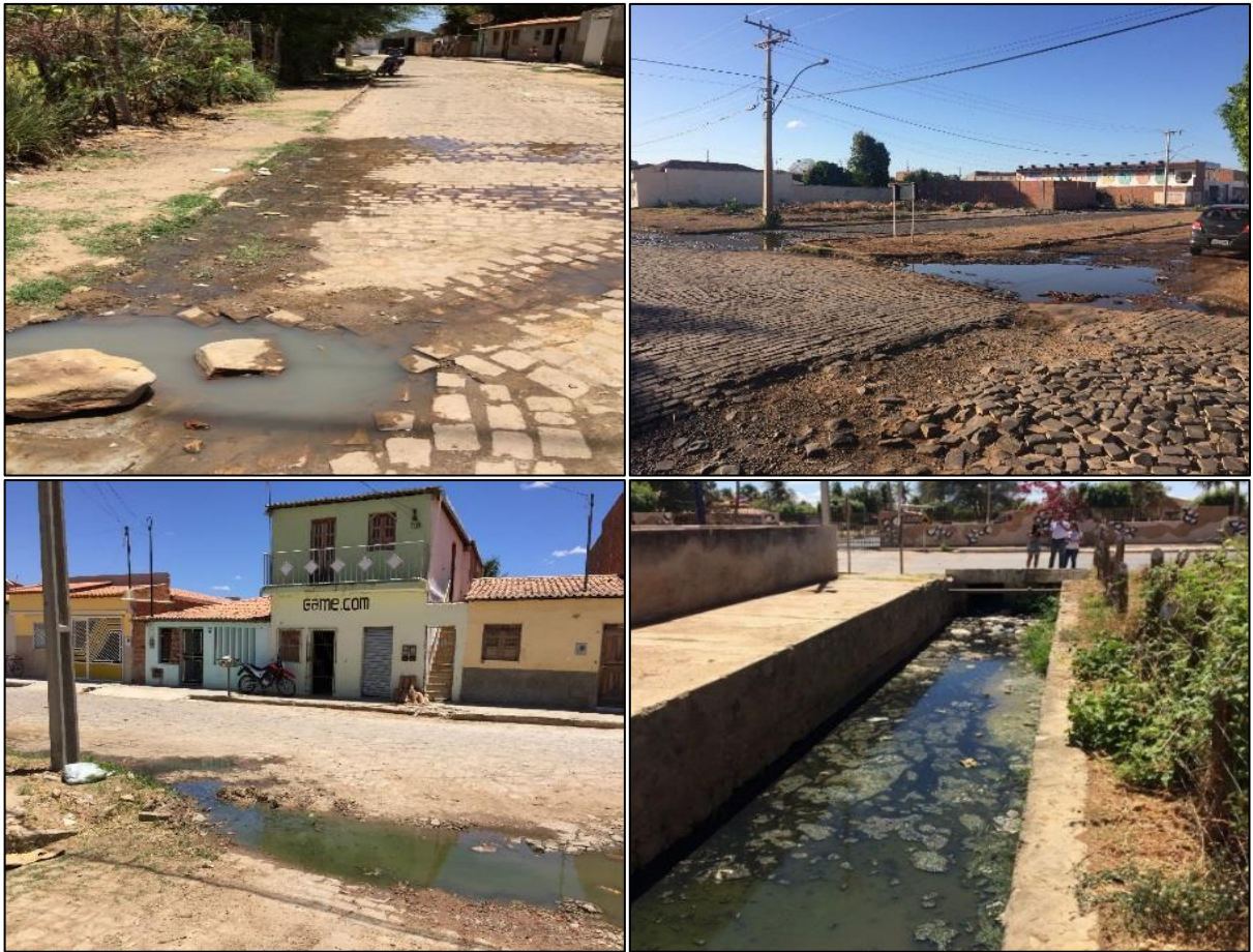
Figura 89 – Lançamento irregular de esgoto nas vias públicas do distrito Sede.
