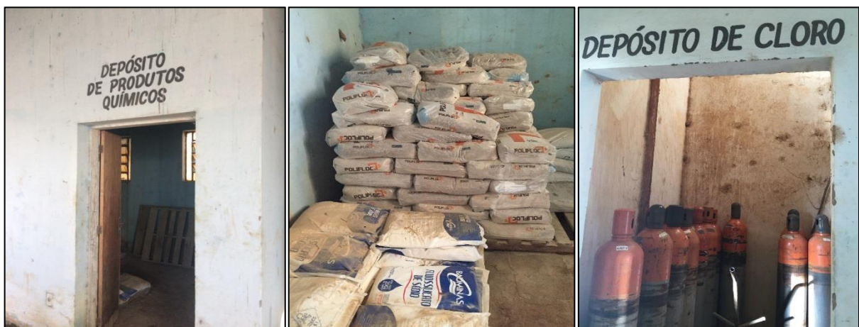
Figura 26 – Depósitos de produtos químicos da ETA do distrito Sede. Fonte: DRZ – Geotecnologia e Consultoria, 2017.
