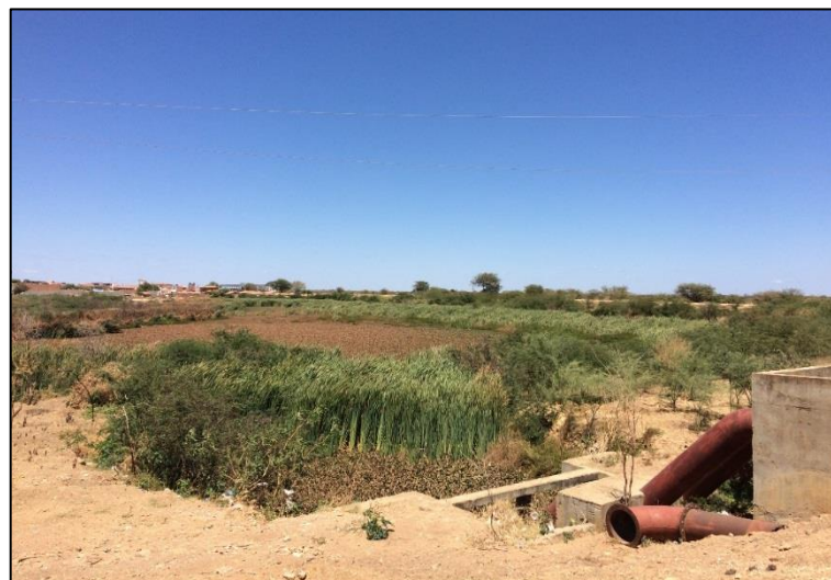
Figura 126 – Lagoa de contenção de águas pluviais.
