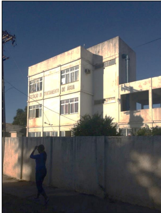
Figura 23 – Vista frontal do prédio da ETA. Fonte: DRZ – Geotecnologia e Consultoria, 2017.
