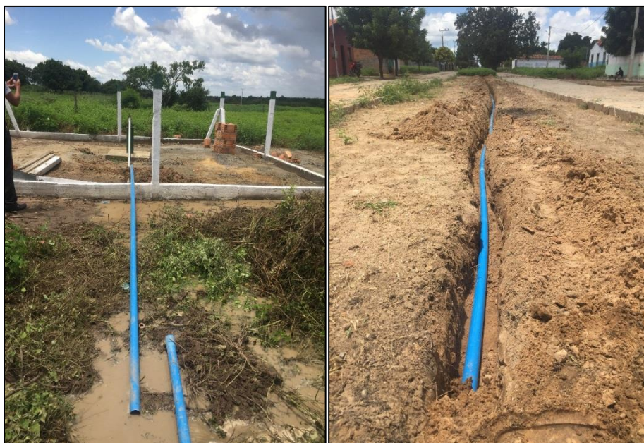
Figura 63 – Adutora de água bruta do novo poço, em fase de implantação.
