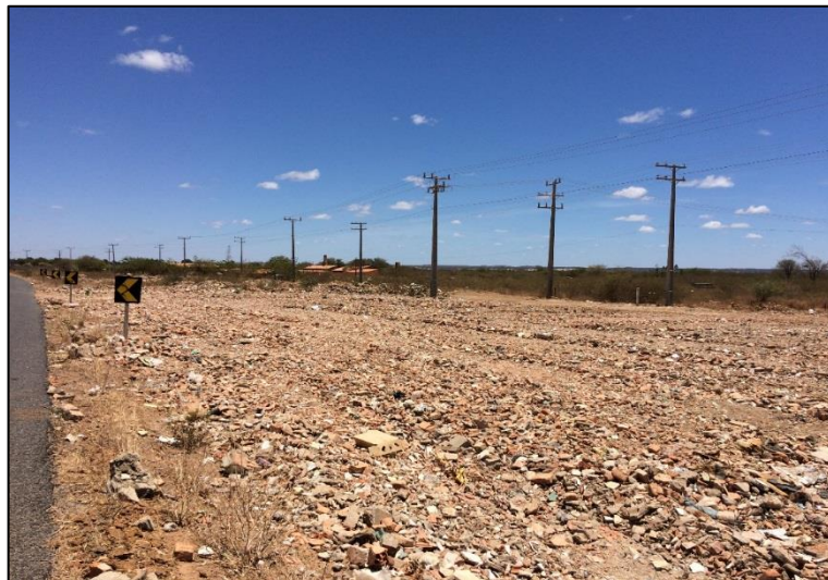
Figura 115 – Resíduos de construção civil utilizados para a manutenção do acostamento. Fonte: DRZ – Geotecnologia e Consultoria, 2017.
