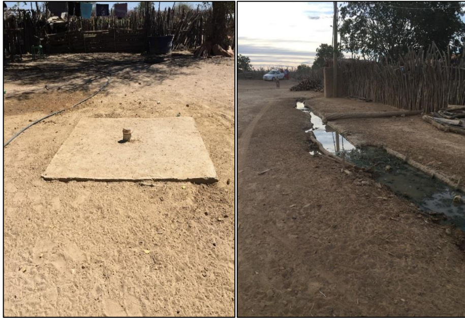
Figura 102 – Fossa rudimentar na comunidade Paulista e lançamento de esgoto em via pública na comunidade Vicentes.
