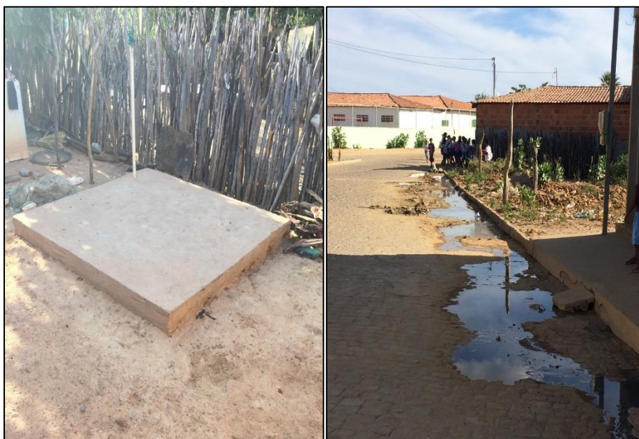
Figura 97 – Exemplo de fossa rudimentar e lançamento de esgoto em via pública na comunidade Boa Vista.
