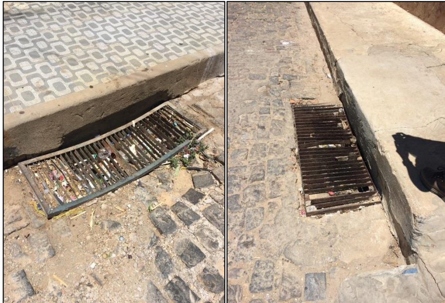
Figura 122 – Exemplos de bocas de lobo utilizadas em Xique-Xique.
