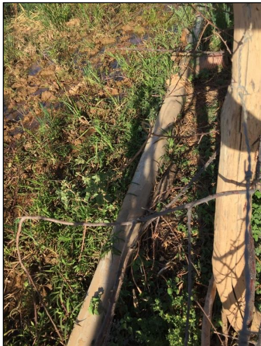
Figura 46 – Adutora de água bruta da comunidade Boa Vista.
