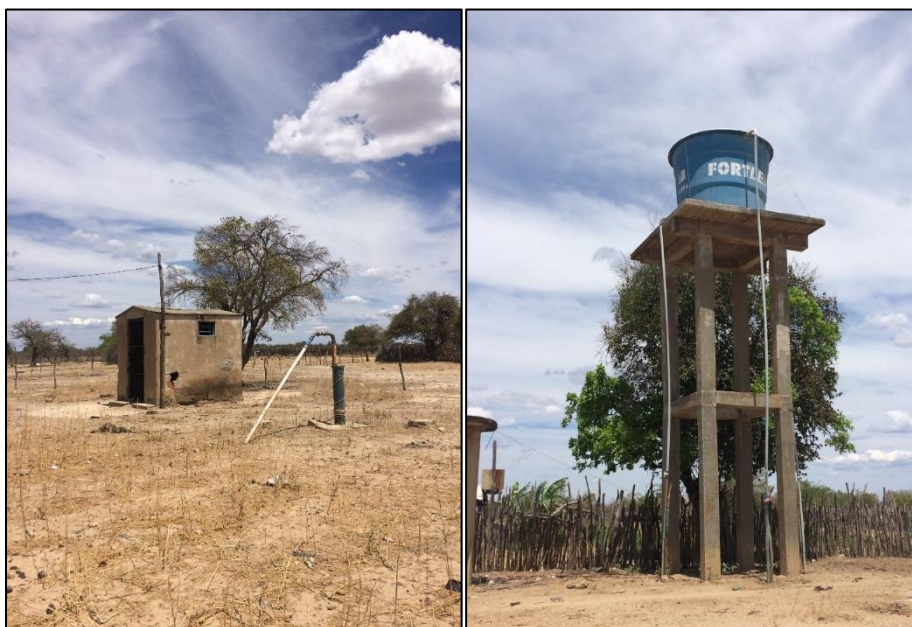
Figura 74 – Poço e reservatório da comunidade Pesqueiro.
