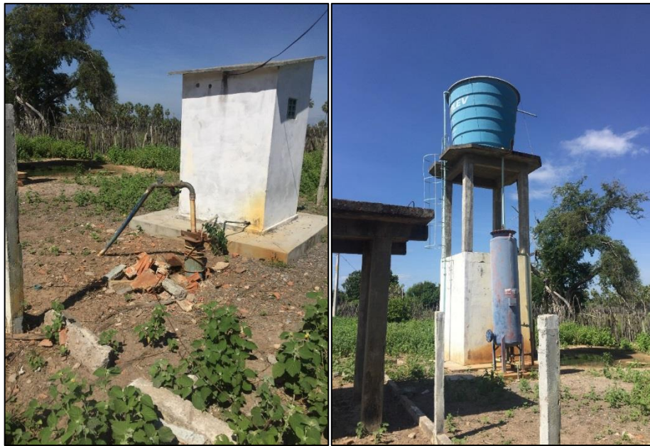
Figura 54 – Poço e reservatório da comunidade Capão do Saco.
