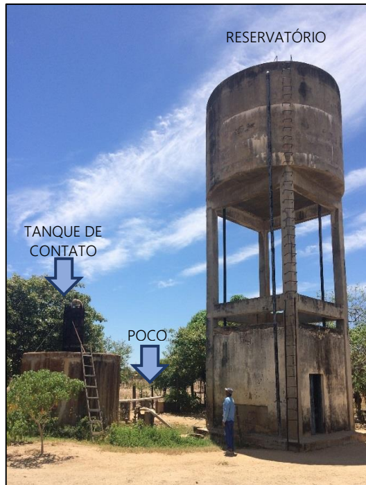
Figura 35 – Reservatório do distrito Copixaba. Fonte: DRZ – Geotecnologia e Consultoria, 2017.
