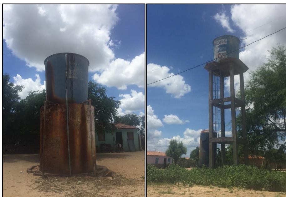
Figura 52 – Reservatórios da comunidade Capão do Martinho.
