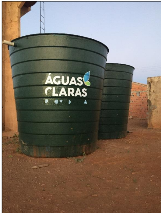
Figura 39 – ETA compacta não instalada, distrito Nova Iguira. Fonte: DRZ – Geotecnologia e Consultoria, 2017.
