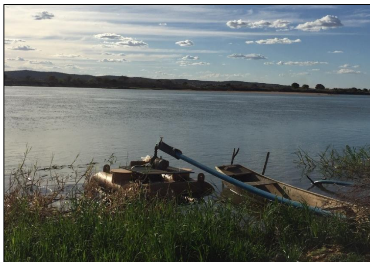
Figura 45 – Captação superficial da comunidade Boa Vista. Fonte: DRZ – Geotecnologia e Consultoria, 2017.
