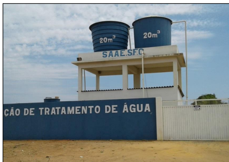
Figura 37 – Reservatório elevado - REL – ETA Entroncamento. Fonte: DRZ - Geotecnologia e Consultoria, 2017.
