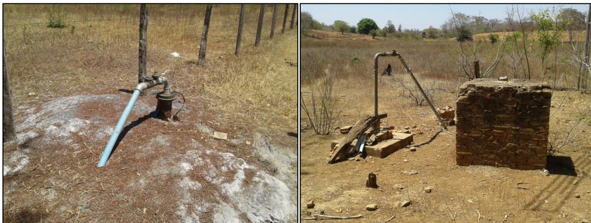
Figura 38 – Poço 1 e Poço 2, respectivamente.
