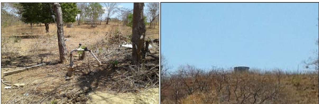
Figura 57 – Captação por poço e reservatório na comunidade Vera Cruz.
