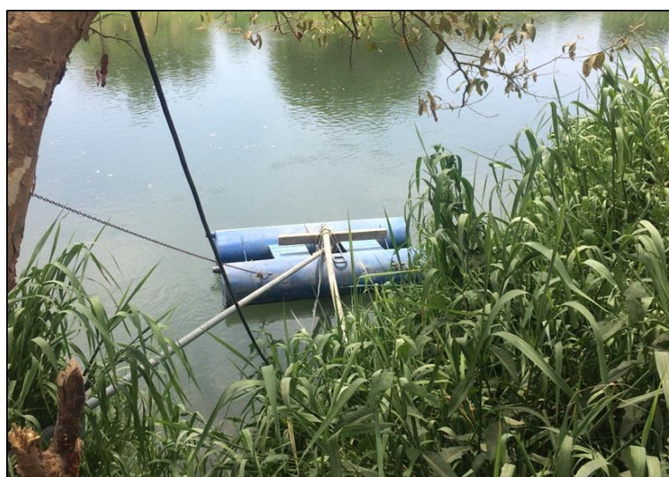
Figura 33 – Captação superficial da comunidade de Entroncamento. Fonte: DRZ – Geotecnologia e Consultoria, 2017.
