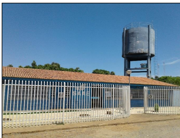
Figura 20 – Vista frontal do prédio do SAAE, onde está localizada a ETA. Fonte: DRZ – Geotecnologia e Consultoria, 2017.
