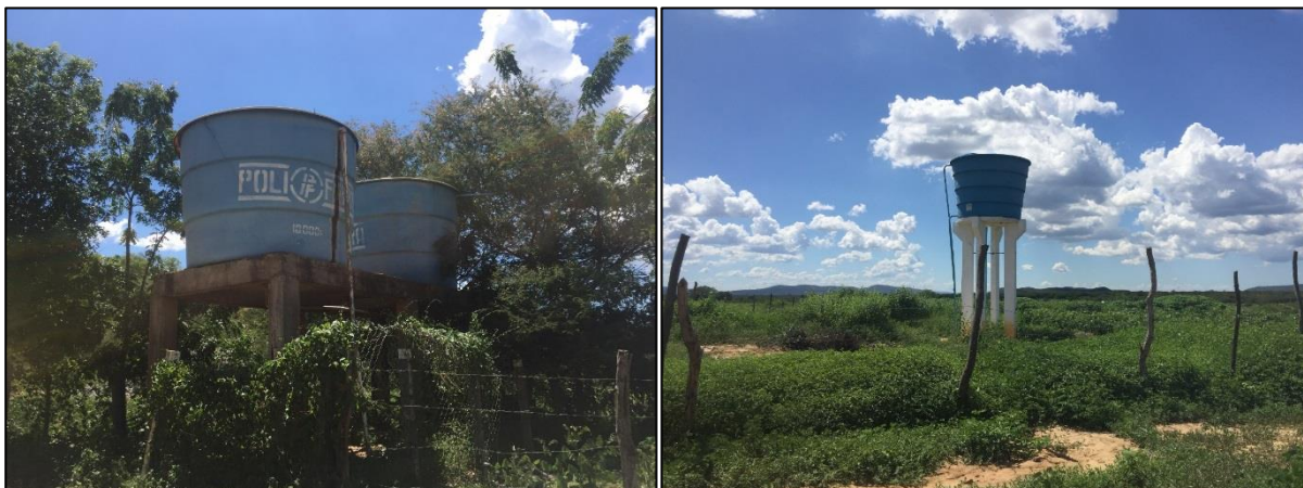
Figura 44 - R1 - Comunidade Olho D'água dos Tanques.
