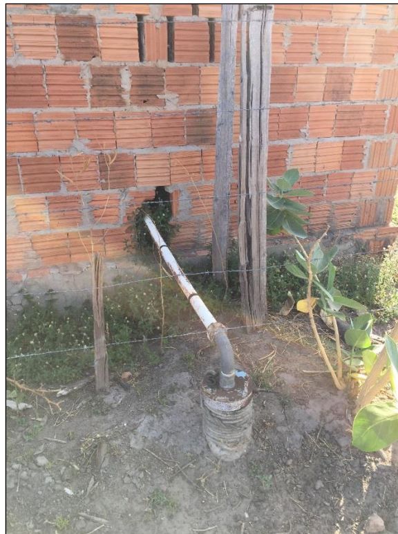
Figura 34 – Captação superficial – Comunidade Canabrava. Fonte: DRZ – Geotecnologia e Consultoria, 2017.
