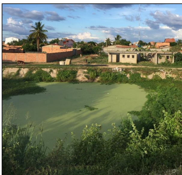
Figura 69 - Reservatório de retenção com acúmulo de efluente de esgoto doméstico.
