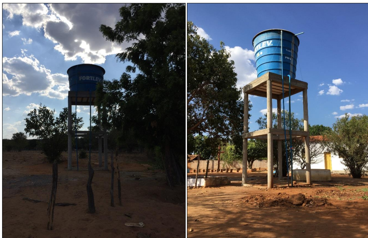
Figura 32 – REL 1 de 10 m 3 – Comunidade Boqueirão.
