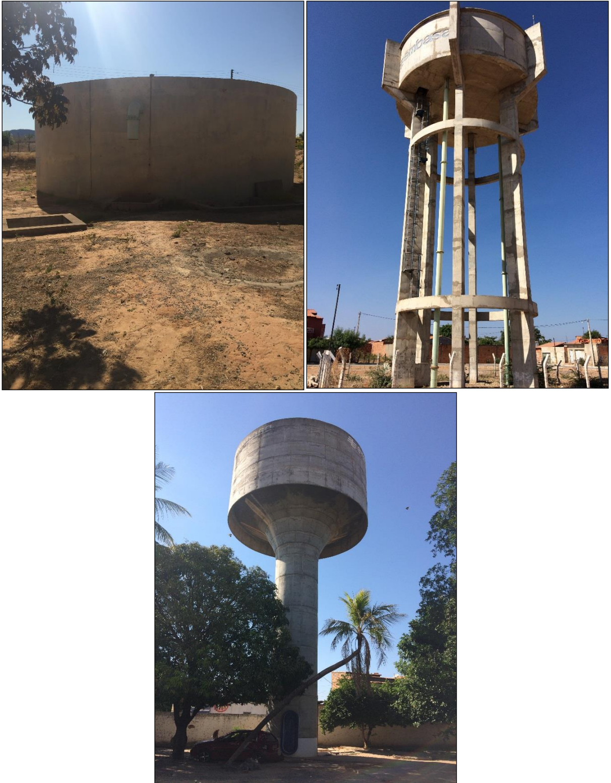
Figura 20 – RAP 500 m 3 – Reservatório ETA. Fonte: DRZ – Geotecnologia e Consultoria, 2017.
