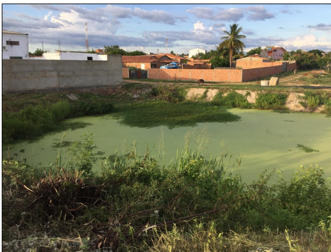
Figura 53 - Reservatório de retenção com acúmulo de efluente de esgoto doméstico.
