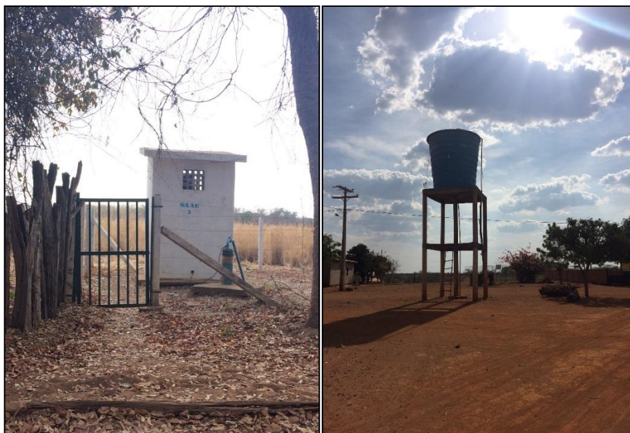
Figura 50 – Poço e reservatório da comunidade Mossorongo. Fonte: DRZ – Geotecnologia e Consultoria, 2017.
