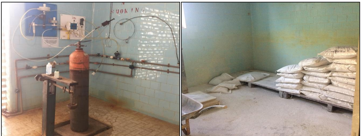
Figura 24 – Produtos químicos utilizados no tratamento da água. Fonte: DRZ – Geotecnologia e Consultoria, 2017.
