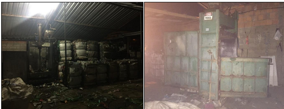
Figura 99 – Galpão de triagem da Associação Oeste Ecologia.
