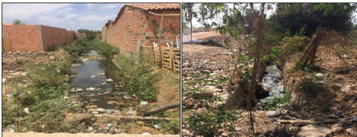
Figura 87 – Lançamentos irregulares de esgoto bruto em canaletas de drenagem e à céu aberto. Fonte: DRZ – Geotecnologia e Consultoria, 2017.
