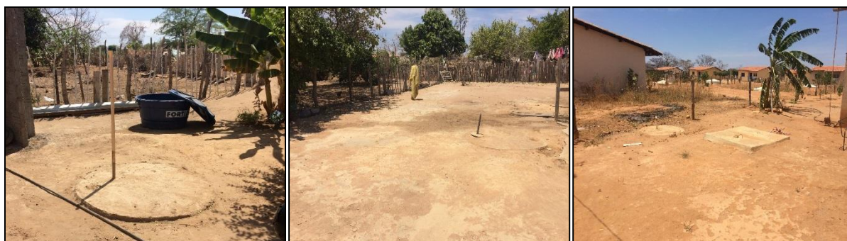
Figura 90 – Fossas construídas nas comunidades quilombolas Batalha Sede, Ribeirinho e Rio das Rãs, respectivamente.
