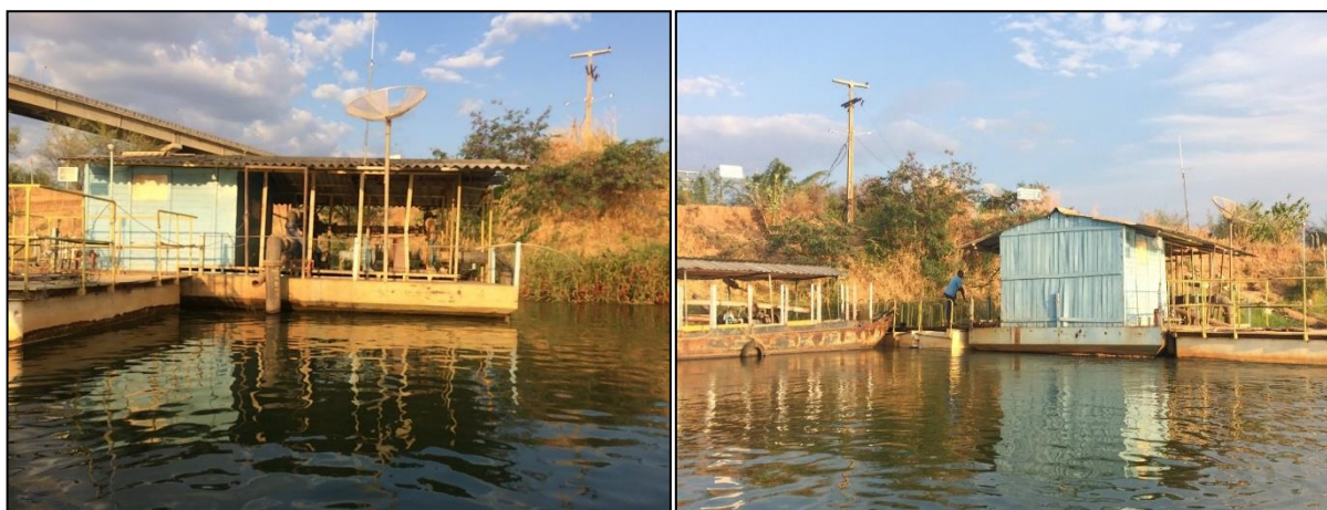
Figura 19 – Captação superficial no rio São Francisco, Distrito Sede.
