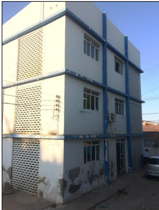
Figura 21 – Vista frontal do prédio da ETA. Fonte: DRZ – Geotecnologia e Consultoria, 2017.
