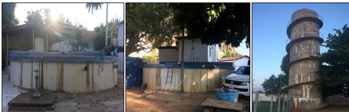
Figura 34 – Reservatórios do distrito Sede em operação: R1, R2 e R6, respectivamente.
