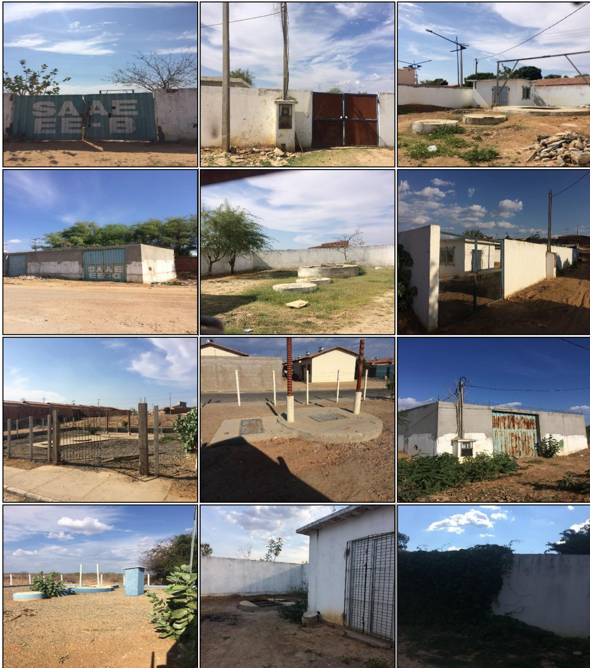
Figura 81 – Estações elevatórias de esgoto do distrito Sede. Fonte: DRZ – Geotecnologia e Consultoria, 2017.
