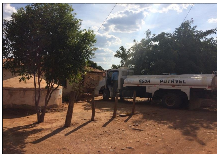
Figura 49 – Abastecimento da cisterna pelo caminhão pipa na comunidade Mossorongo.
