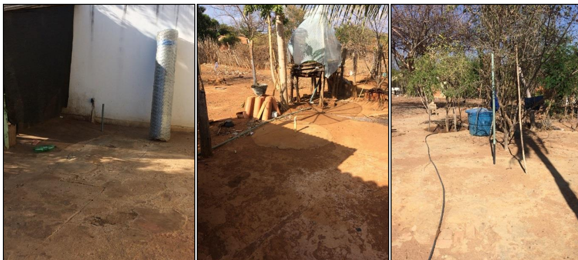
Figura 89 – Fossas construídas nas comunidades Chapada Grande, Mossorongo e Tanque Novo, respectivamente.
