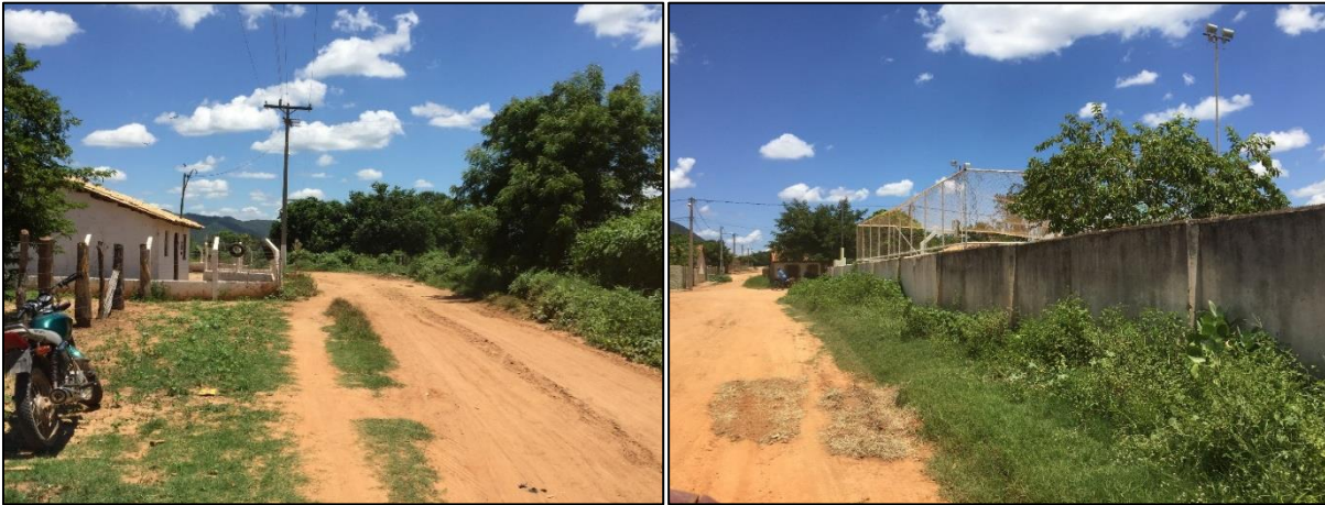
Figura 110 – Pontos de alagamentos no distrito Favelândia. Fonte: DRZ – Geotecnologia e Consultoria, 2018.
