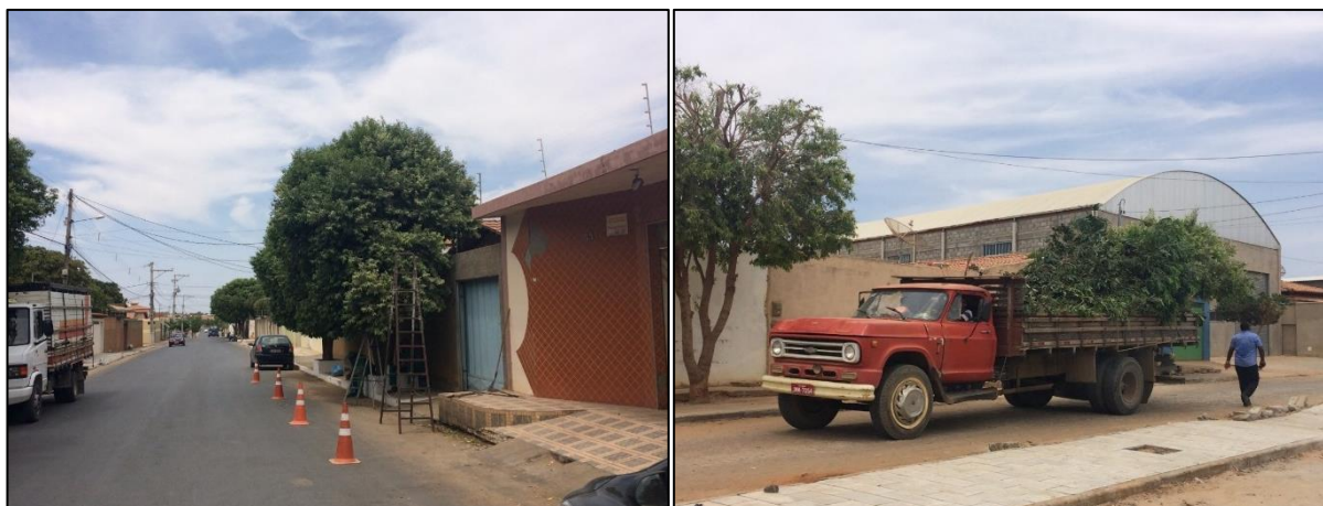
Figura 94 – Realização do serviço de poda de árvores no distrito Sede. Fonte: DRZ – Geotecnologia e Consultoria, 2017.
