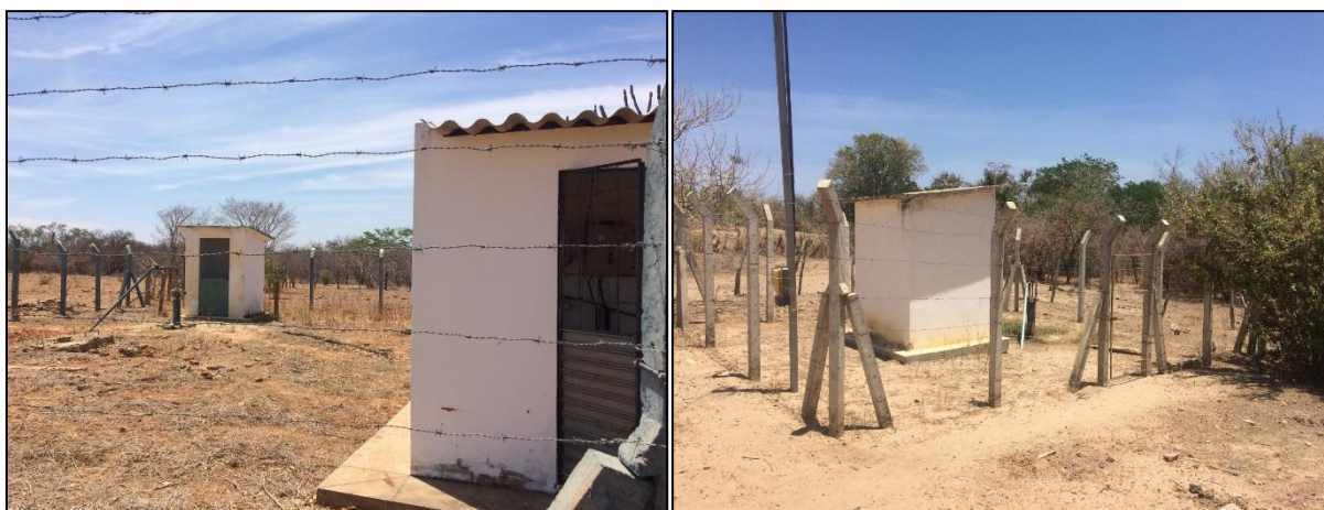
Figura 72 – Poço 1 e Poço 2 da comunidade Nova Batalhinha.
