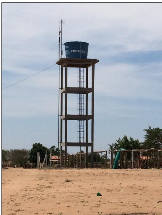
Figura 79 – Reservatório da comunidade Ribeirinho. Fonte: DRZ – Geotecnologia e Consultoria, 2017.
