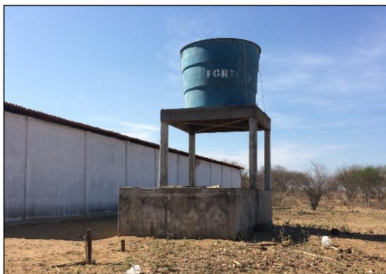
Figura 61 – Reservatório da comunidade Araça-Cariacá abastecido pelo caminhão pipa. Fonte: DRZ – Geotecnologia e Consultoria, 2017.
