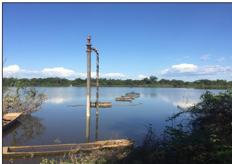
Figura 56 – Captação superficial da comunidade Piranhas. Fonte: DRZ – Geotecnologia e Consultoria, 2017.
