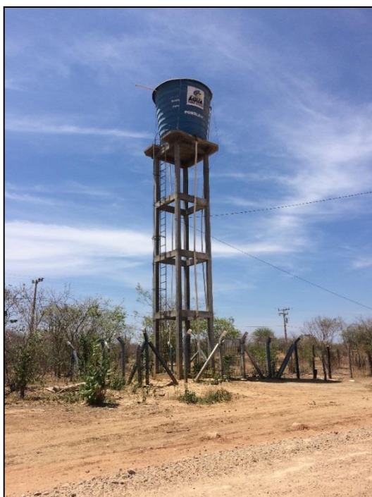
Figura 73 – Reservatório da comunidade Nova Batalhinha. Fonte: DRZ – Geotecnologia e Consultoria, 2017.
