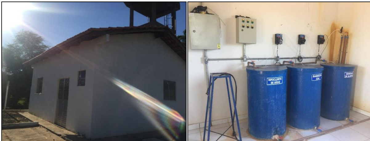
Figura 58 – Casa de química da ETA.
