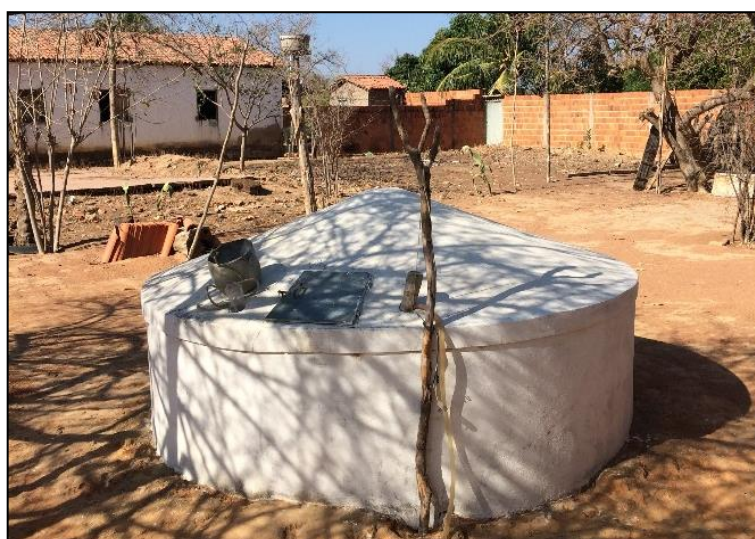
Figura 54 – Cisterna do controlador da comunidade Tanque Novo.
