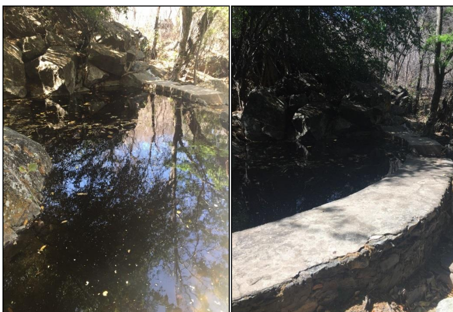
Figura 37 – Captação superficial (barragem) do distrito Favelândia.
