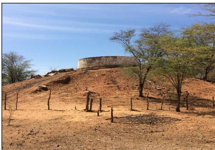
Figura 67 – Reservatório do sistema comunitário, assentamento Batalha Sede.
