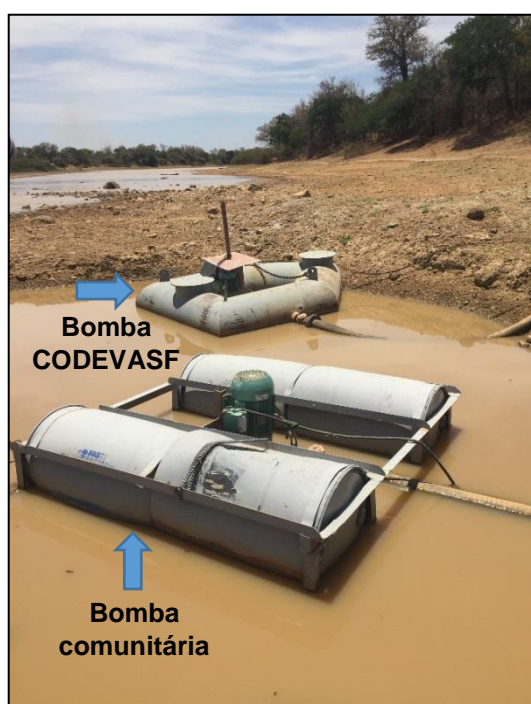
Figura 65 – Captação superficial do assentamento Batalha Sede. Fonte: DRZ – Geotecnologia e Consultoria, 2017.
