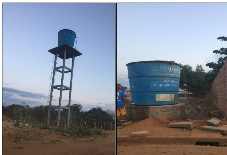
Figura 43 – Reservatórios (REL e RAP) do Setor 04, distrito Formoso. Fonte: DRZ – Geotecnologia e Consultoria, 2017.
