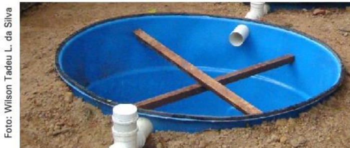
Figura 8. Cruz de madeira para evitar deformação da caixa de fibra de vidro.
