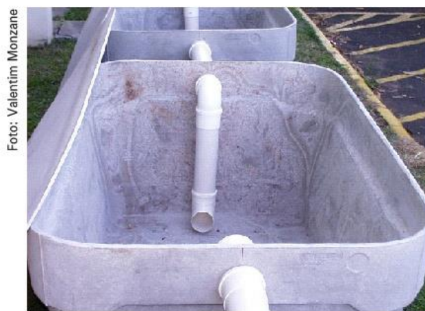
Figura 3. Detalhe de como colocar a tubulação nas caixas da Fossa Séptica Biodigestora.
