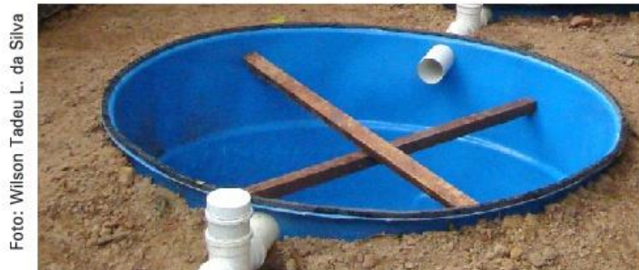
Figura 8. Cruz de madeira para evitar deformação da caixa de fibra de vidro.
