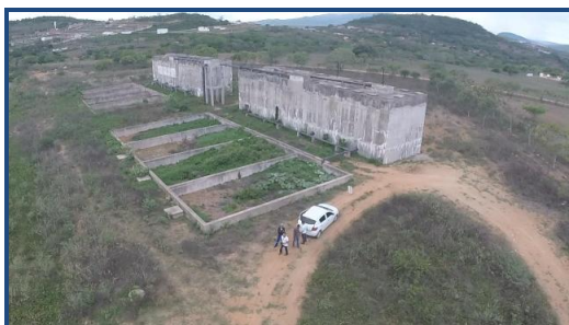
Figura 5 - Estação de Tratamento de Esgoto - ETE
