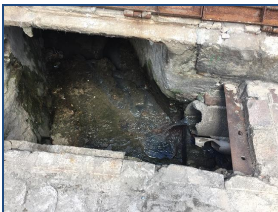
Figura 11 - Dispositivo de captação de água pluvial sem qualquer proteção Fonte: Premier Engenharia, 2018.
