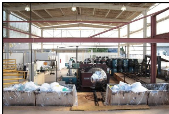
Figura 13 - Local de tratamento dos RSS na sede da Empresa SERQUIP Fonte: SERQUIP, 2017.
