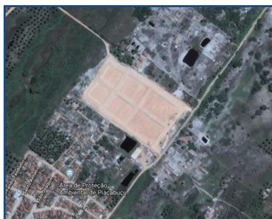
Figura 7 - Estação de Tratamento de Esgoto (ETE) Fonte - Google Maps, 2018.
