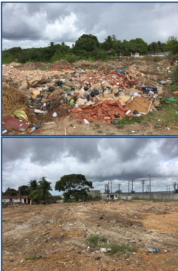
Figura 12 - Locais de disposição de resíduos de construção civil Fonte: Premier Engenharia, 2018.
