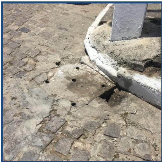
Figura 12 - Dispositivo de captação de água pluvial
