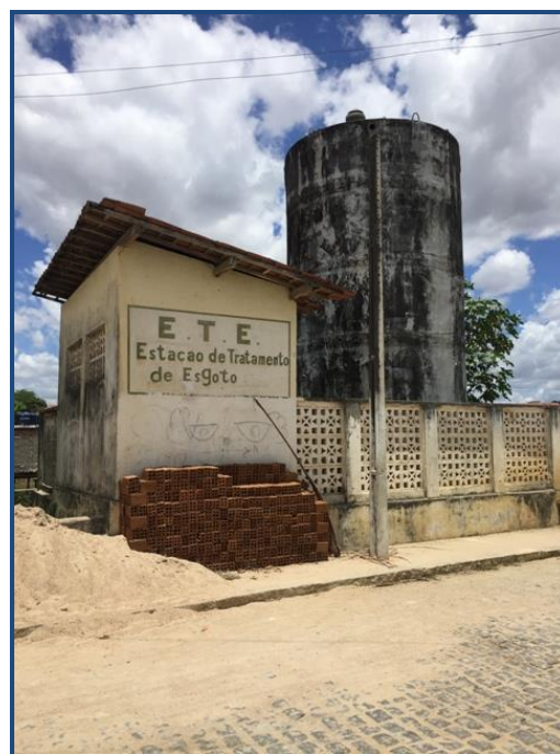
Figura 5 - Estação de Tratamento de Esgoto (ETE)
