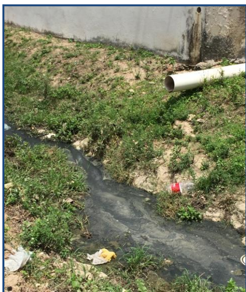
Figura 6 - Ponto de lançamento de esgoto a céu aberto.
