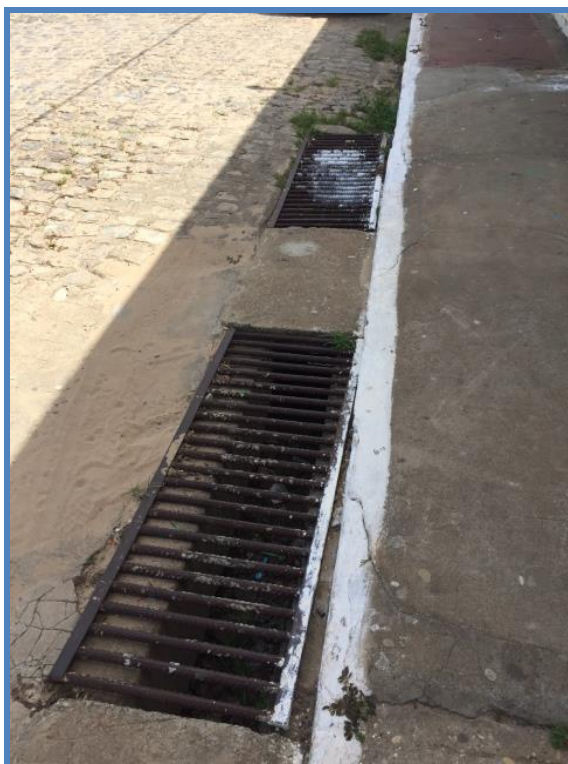
Figura 12 - Boca-de-lobo da Praça Domingos Mendes Fonte: Premier Engenharia, 2018.
