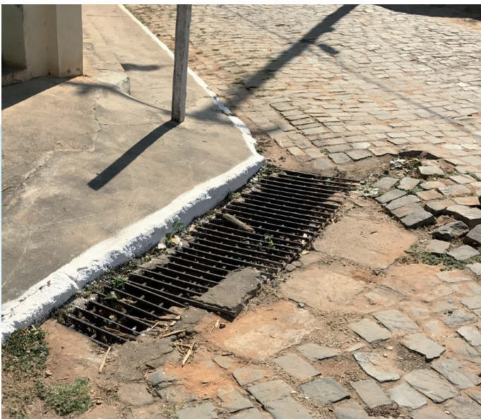
Figura 60 – Bocas de Lobo Inadequadas Fonte: GESOIS, 2017
