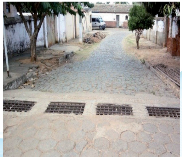
Figura 60 – Bocas de Lobo Inadequadas Fonte: GESOIS, 2017
