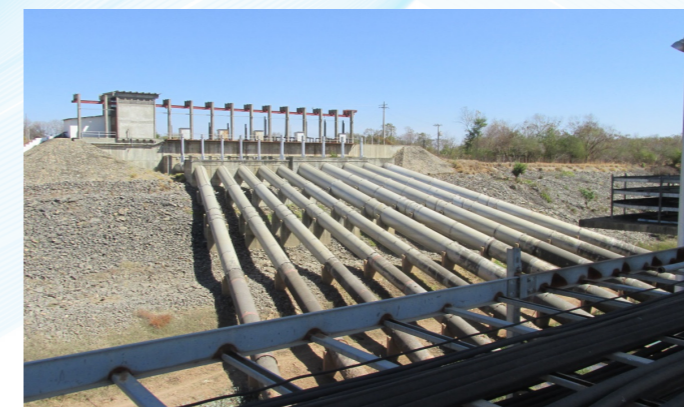
Figura 46 – Tubulação de Recalque e Rip Rap em Perímetro de Irrigação Jaíba Fonte: GESOIS, 2017
