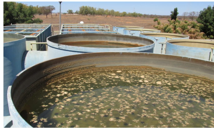
Figura 34 – Flocculadores em Jaíba Fonte: GESOIS, 2017
