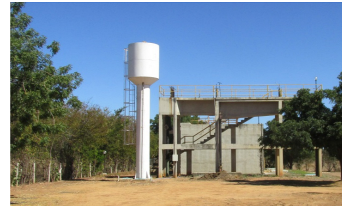
Figura 61 – Estrutura de Chegada em Jaíba Fonte: GESOIS, 2017
