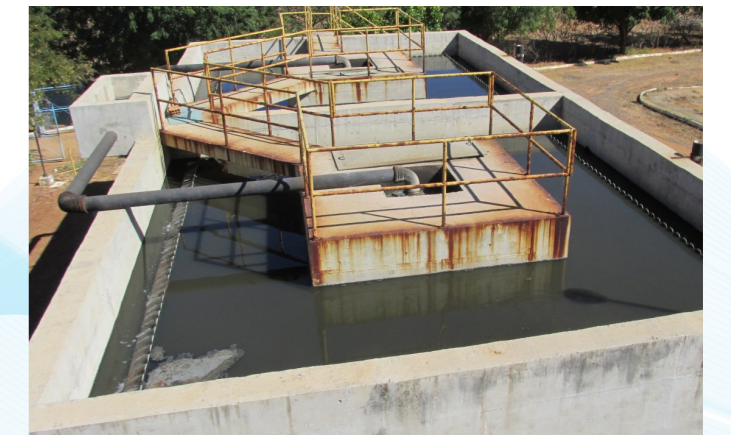
Figura 64 – Reator Anaeróbio em Jaíba Fonte: GESOIS, 2017
