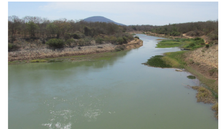
Figura 43 – Canal de Chegada, junto à Estação de Bombeamento – EB 1 em Perímetro de Irrigação Jaíba Fonte: GESOIS, 2017
