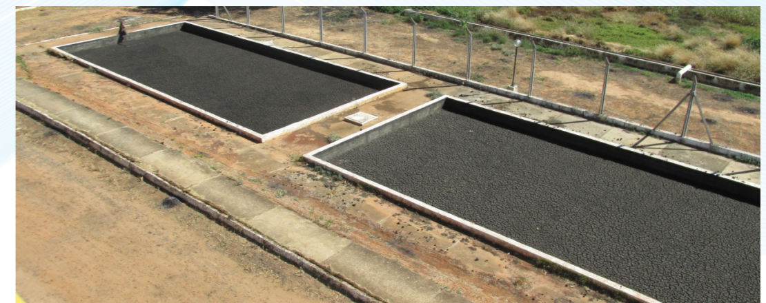
Figura 65 – Leitos de Secagem em Jaíba Fonte: GESOIS, 2017
