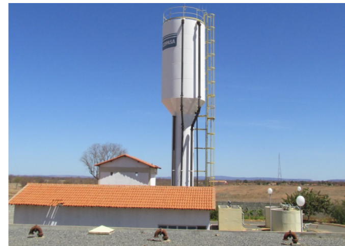
Figura 39 – Estação de Tratamento de Água na sede em Jaíba Fonte: GESOIS, 2017
