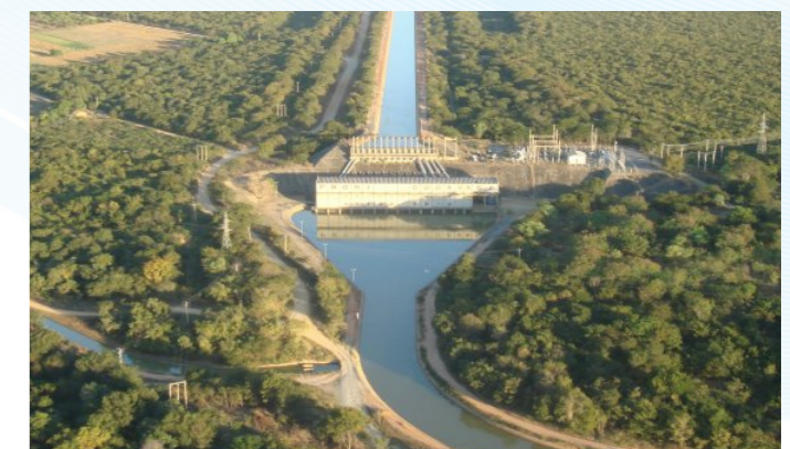
Figura 47 – Estação de Bombeamento - EB 2 em Perímetro de Irrigação Jaíba Fonte: GESOIS, 2017
