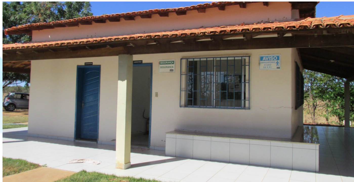
Figura 68 – Laboratório e Estrutura de Apoio em Jaíba Fonte: GESOIS, 2017
