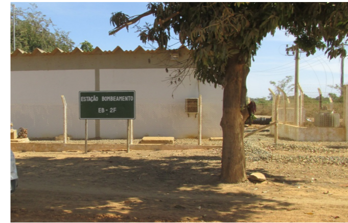
Figura 54 – Estação de Bombeamento – EB 2F em Perímetro de Irrigação Jaíba Fonte: GESOIS, 2017
