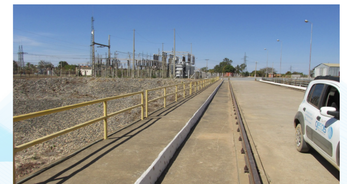
Figura 45 – Estrutura de Chegada da EB 1 em Perímetro de Irrigação Jaíba Fonte: GESOIS, 2017
