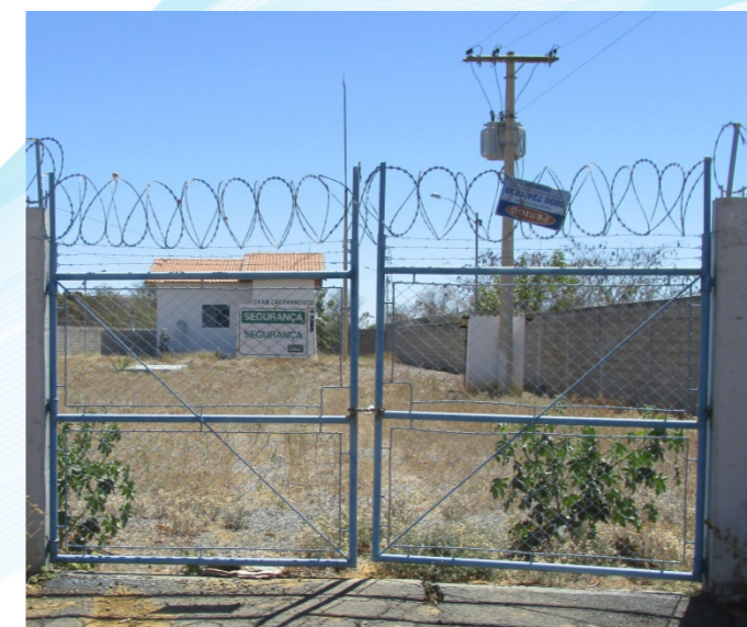
Figura 32 – Estação Elevatória de Água Bruta Portão de Acesso (EEAB) em Jaíba Fonte: GESOIS, 2017
